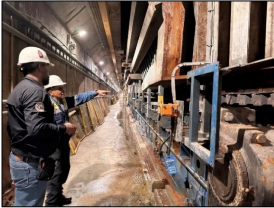
Fotografía 52. Túnel de bandas alimentadoras de Planta de Procesos.
