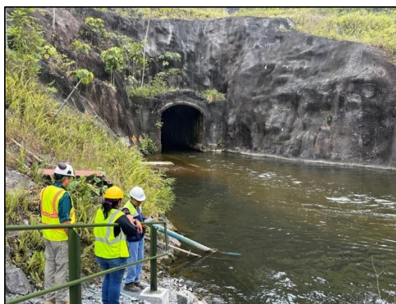
Fotografía 27. Salida del túnel de descarga
