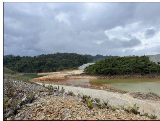
Fotografía 36. Vistas de la Poza E
