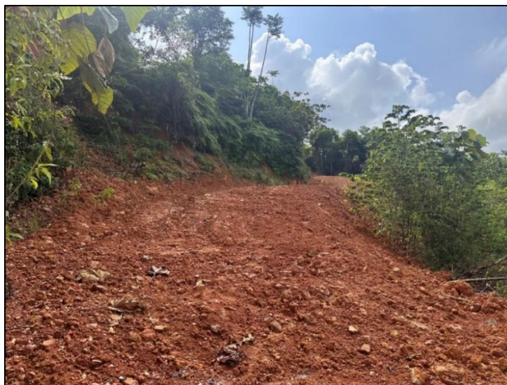
Fotografía 48. Material de préstamo saprolita en zona del Botadero Sur.
