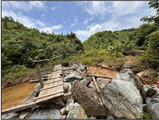
Fotografía 40. Barreras de sedimentación en Quebrada Colorada.
