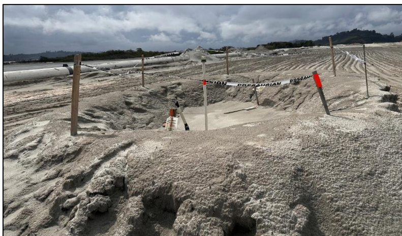
Fotografía 47. Instrumentación monitoreo geotécnico en dique de la IMR.
