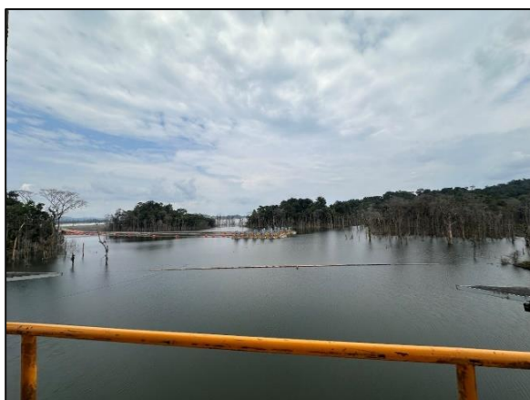
Fotografía 26. Vista de la laguna desde la Torre de Decantación
