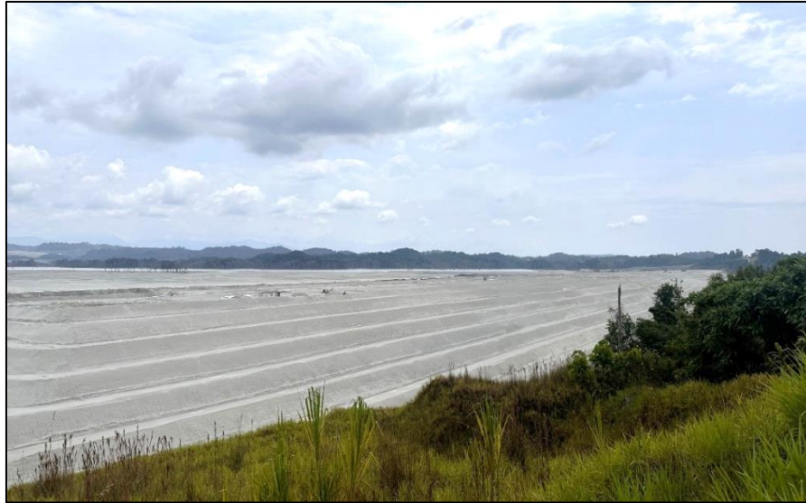
Fotografía 23. Vista de la Presa Norte (IMR)
