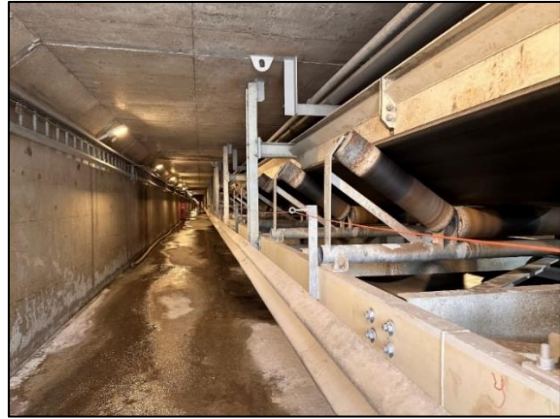
Fotografía 53. Túnel de bandas alimentadoras de Planta de Procesos.
