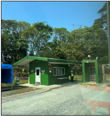
Fotografía 8. Garita de seguridad en el punto final del transporte comunitario – Caimito.
