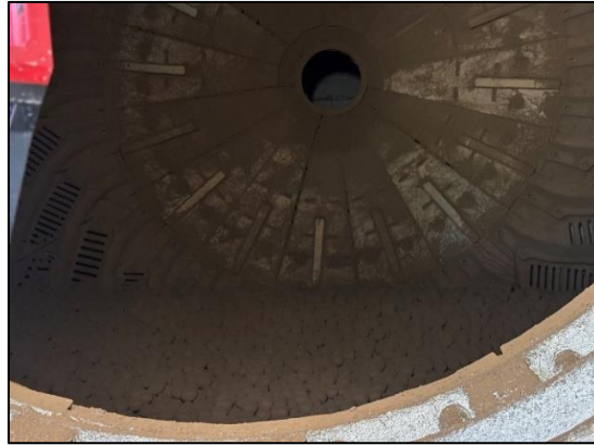
Fotografía 12. Bolas de acero (remanentes del último procesamiento) en el interior del molino SAG.
