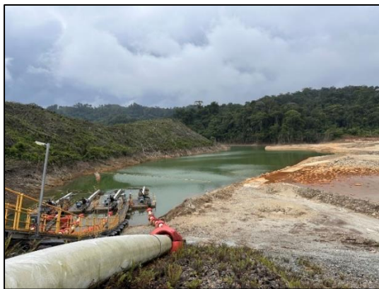
Fotografía 35. Vistas de la Poza E
