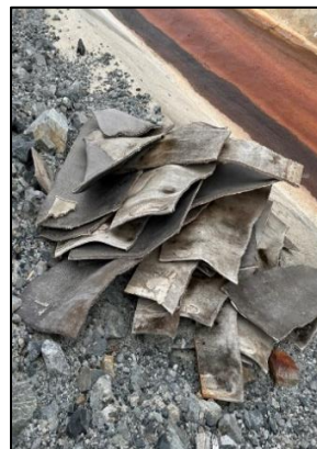
Fotografía 30. Geotextil Concrete Canvas
