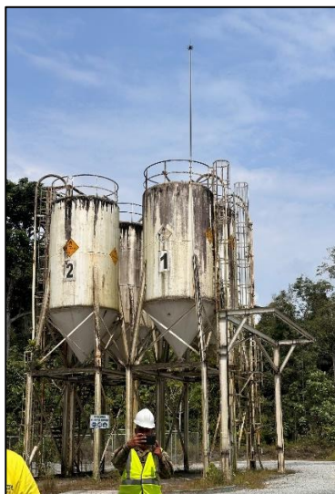
Fotografía 14. Silos de emulsión.
