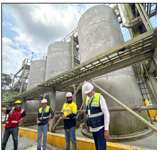
Fotografía 21. Silos contenedores de emulsión (vacíos).
