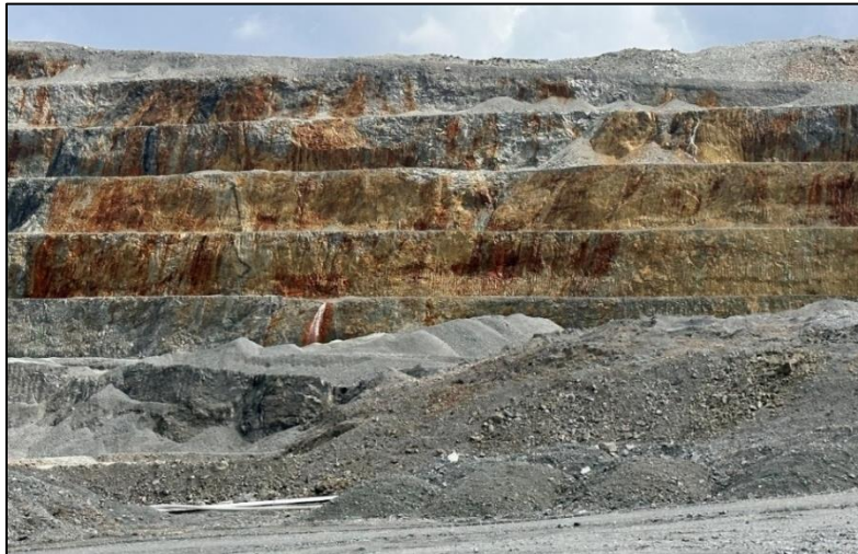
Fotografía 50. Evidencia de oxidación en paredes del tajo Botija.
