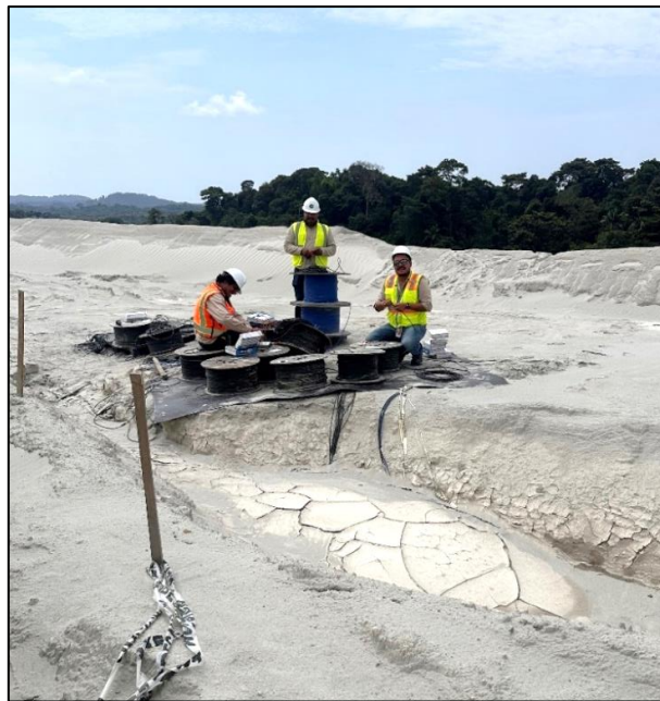
Fotografía 24. Calicata para instalación de instrumentación geotécnica.
