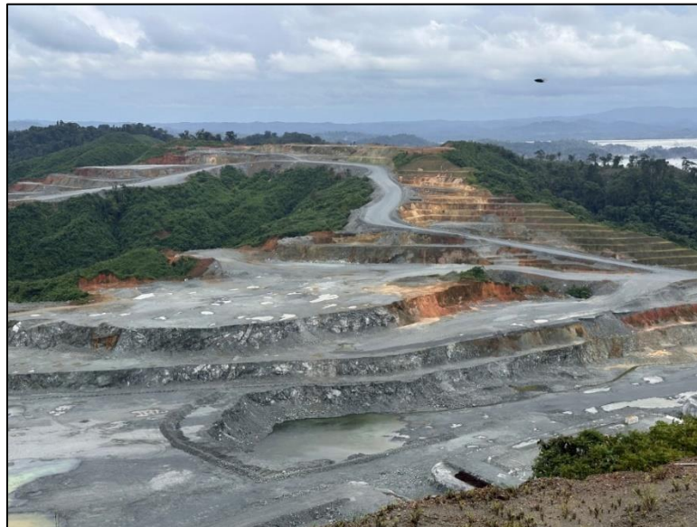
Fotografía 39. Trabajos de desbroce en la zona Colina.
