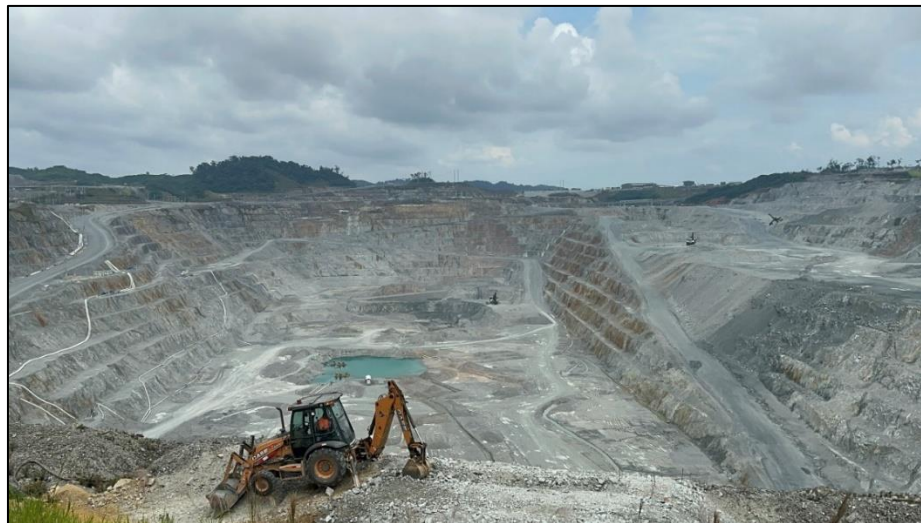
Fotografía 28. Vista del Tajo Botija desde el mirador.
