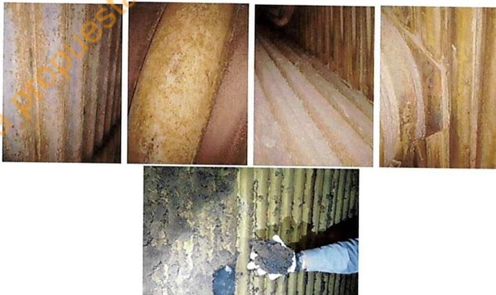
Fotos de la parada de mantenimiento de la Unidad 1 – año 2019
