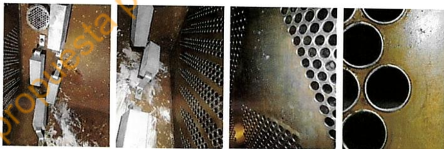
Fotos de la parada de mantenimiento de la Unidad 1 – año 2019
