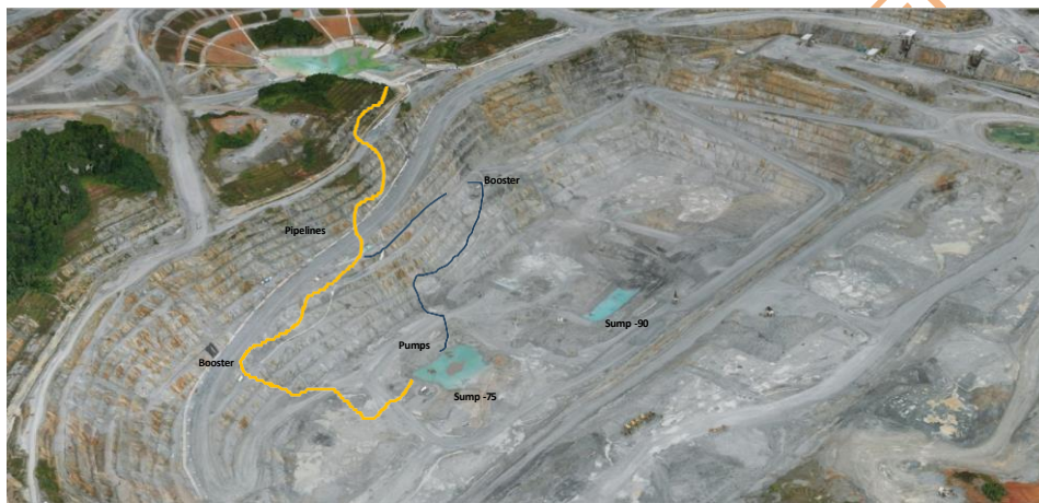
Figura No.9 sistema de desaguado de mina
