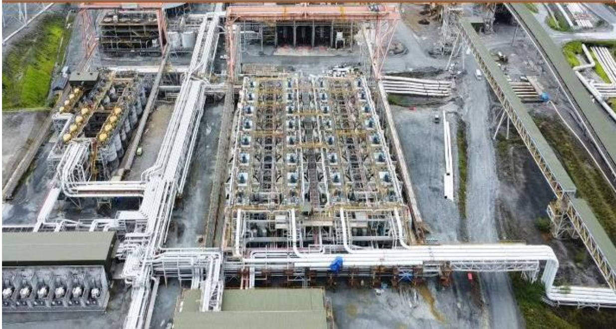
Figura No. 17 Circuito De Flotación
