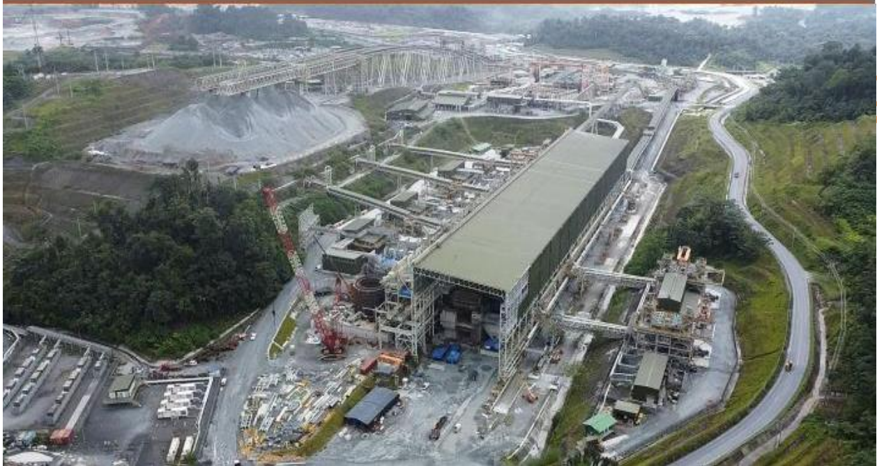
Figura No. 16 Edificio de molienda pila de acopio del mineral triturado
