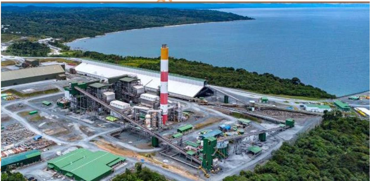
Figura No.23 Central Eléctrica
