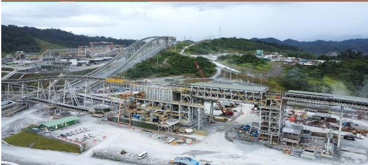
Figura No.14 Bandas transportadoras y trituración secundaria y de pebbles
