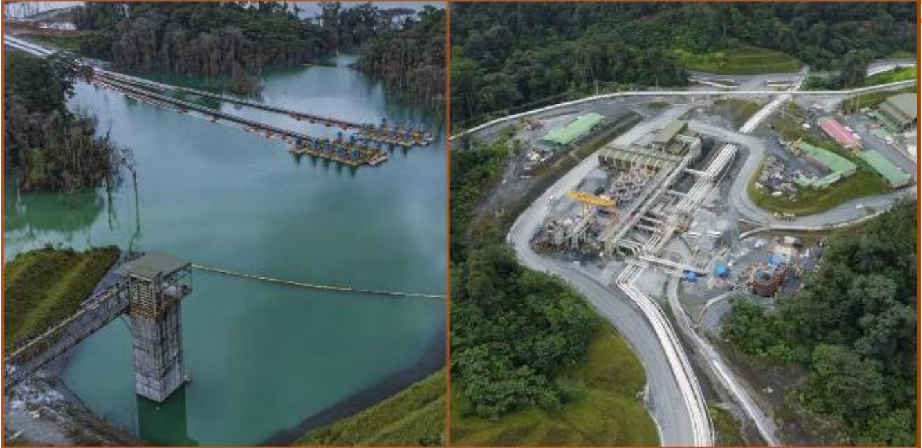
Figura No.21 torre del aliviadero de la IMR (izq) y planta de ciclonado (der)
