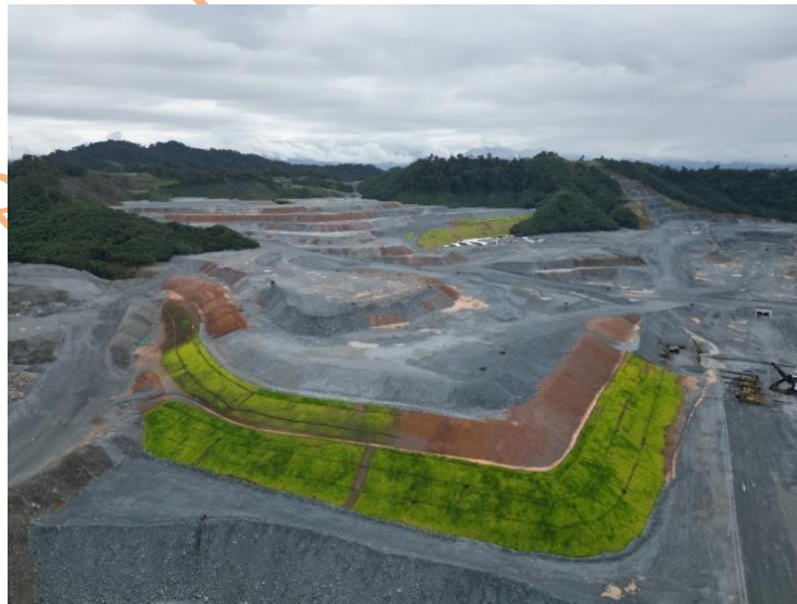
Figura No.8 Rehabilitación del Depósito de material estéril
