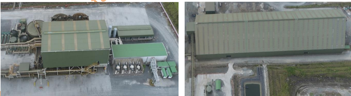
Figura No.25 Planta de filtrado (izq) y almacén (der)
