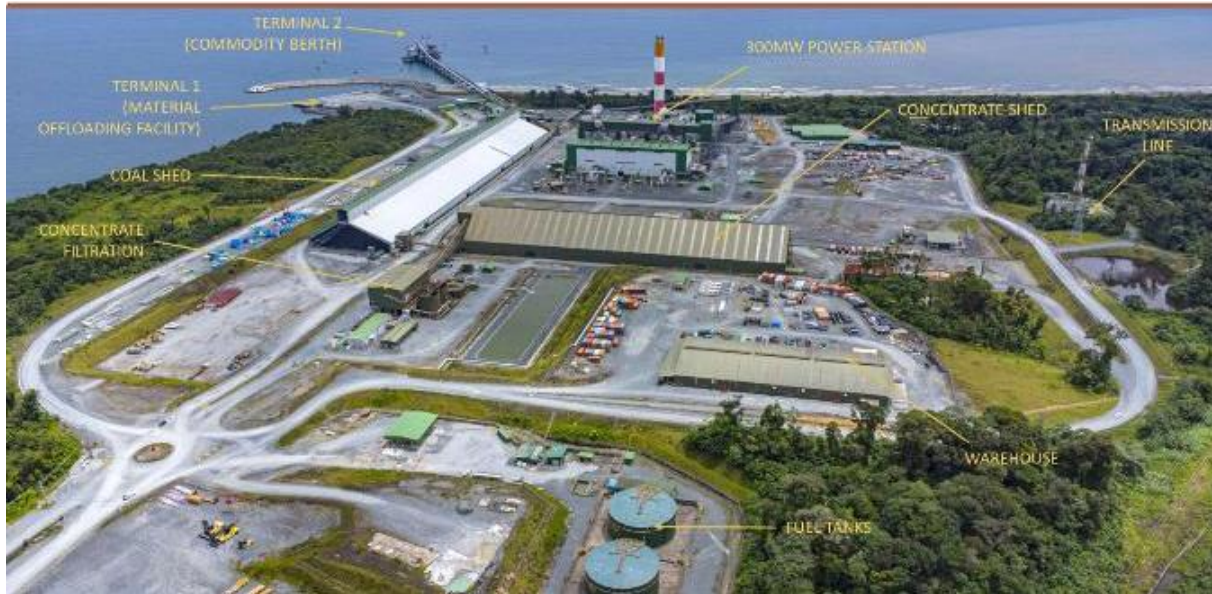
Figura No. 22 instalaciones portuarias y central eléctrica
