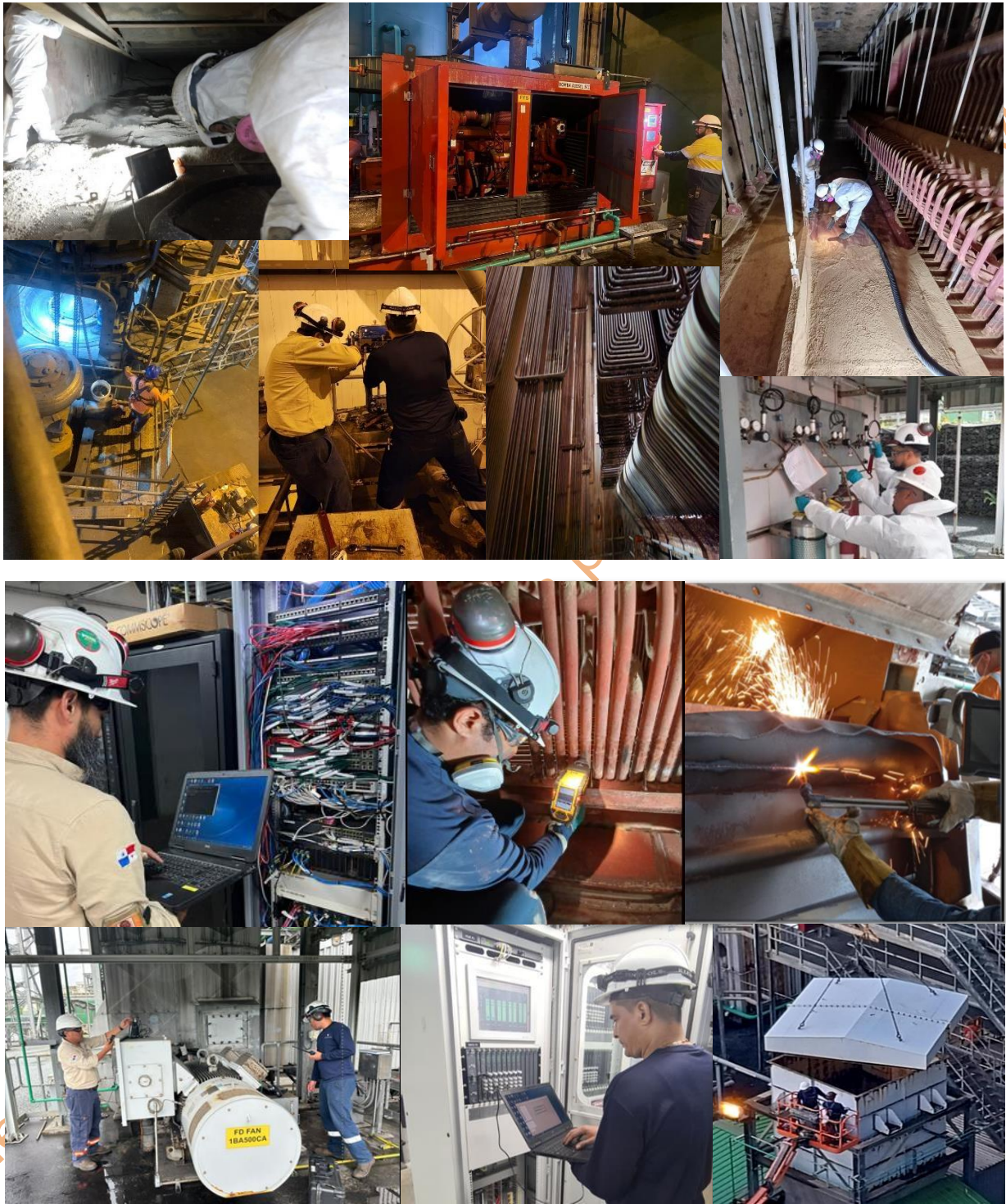
Figura No. 24 Imágenes de las actividades actuales de PGS en la Central Eléctrica
