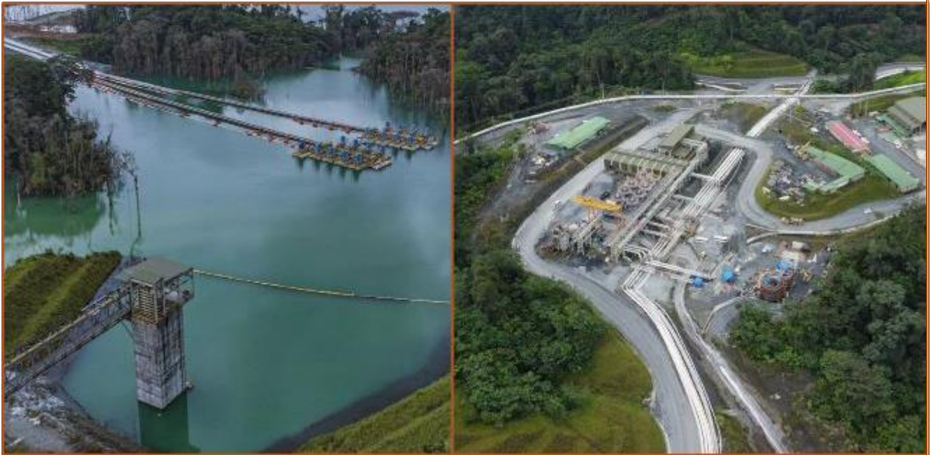
Figura No.18 torre del aliviadero de la IMR (izq) y planta de ciclonado (der)
