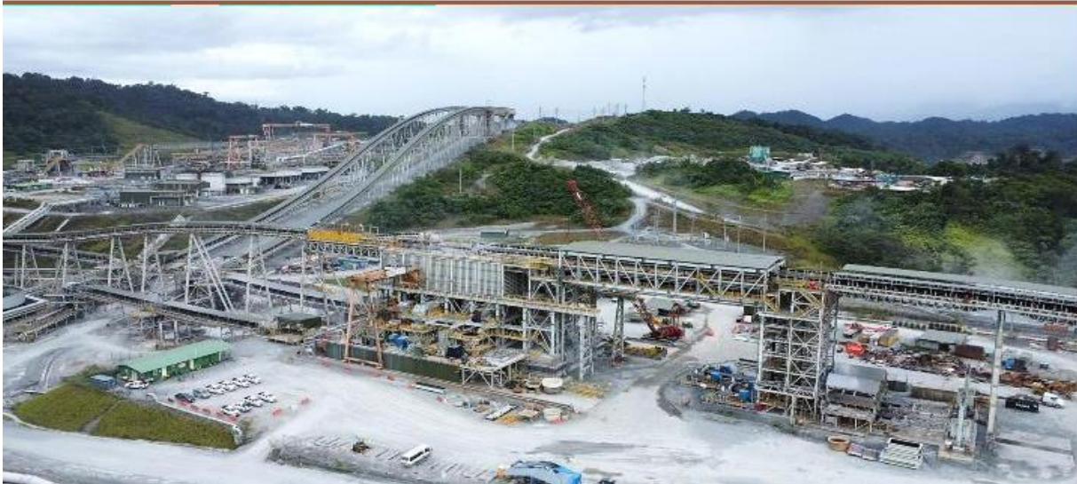
Figura No.11 Bandas transportadoras y trituración secundaria y de pebbles
