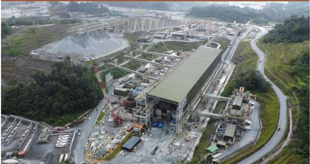
Figura No. 13 Edificio de molienda pila de acopio del mineral triturado
