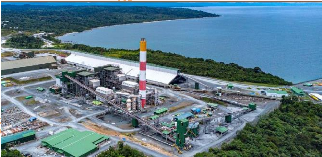
Figura No.20 Central Eléctrica
