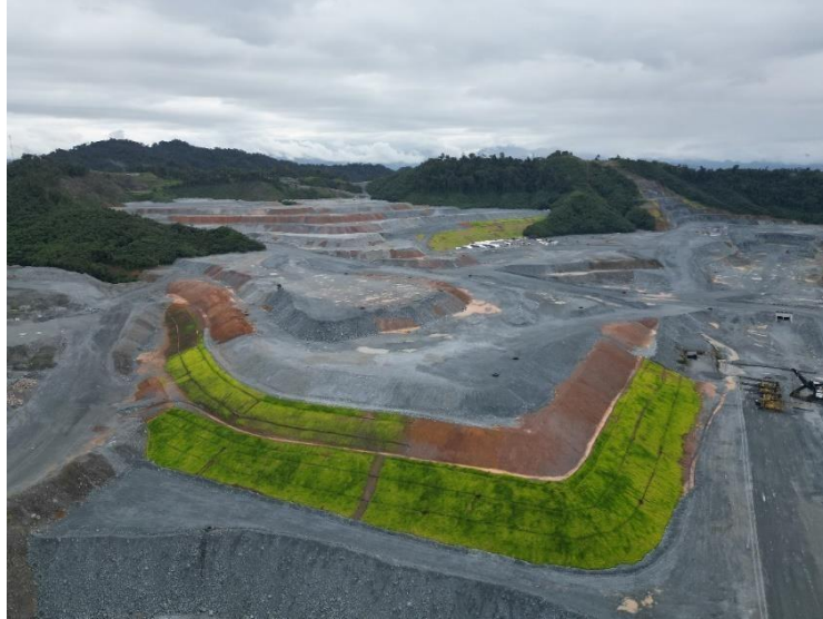
Figura No.5 Rehabilitación del Depósito de material estéril
