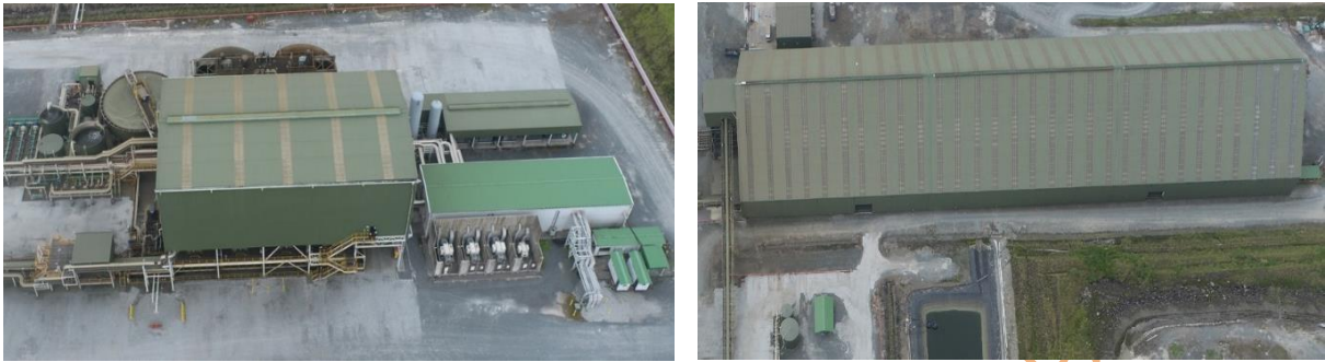
Figura No.22 Planta de filtrado (izq) y almacén (der)
