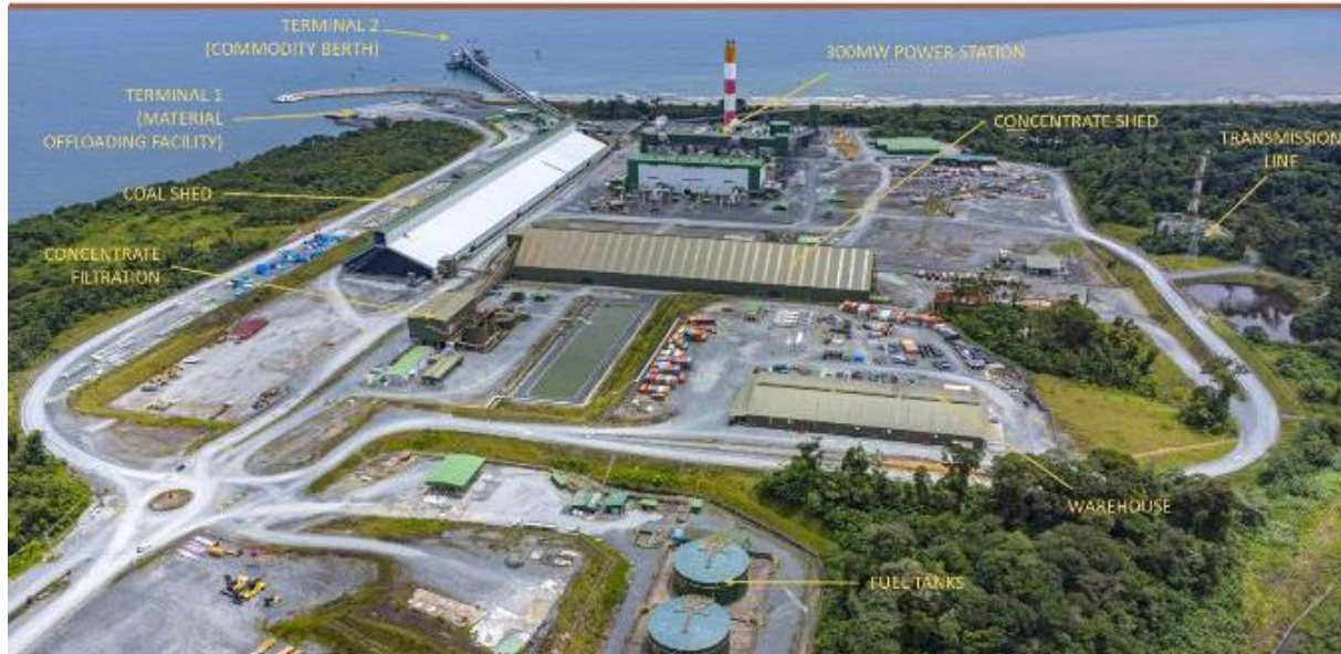
Figura No. 19 instalaciones portuarias y central eléctrica
