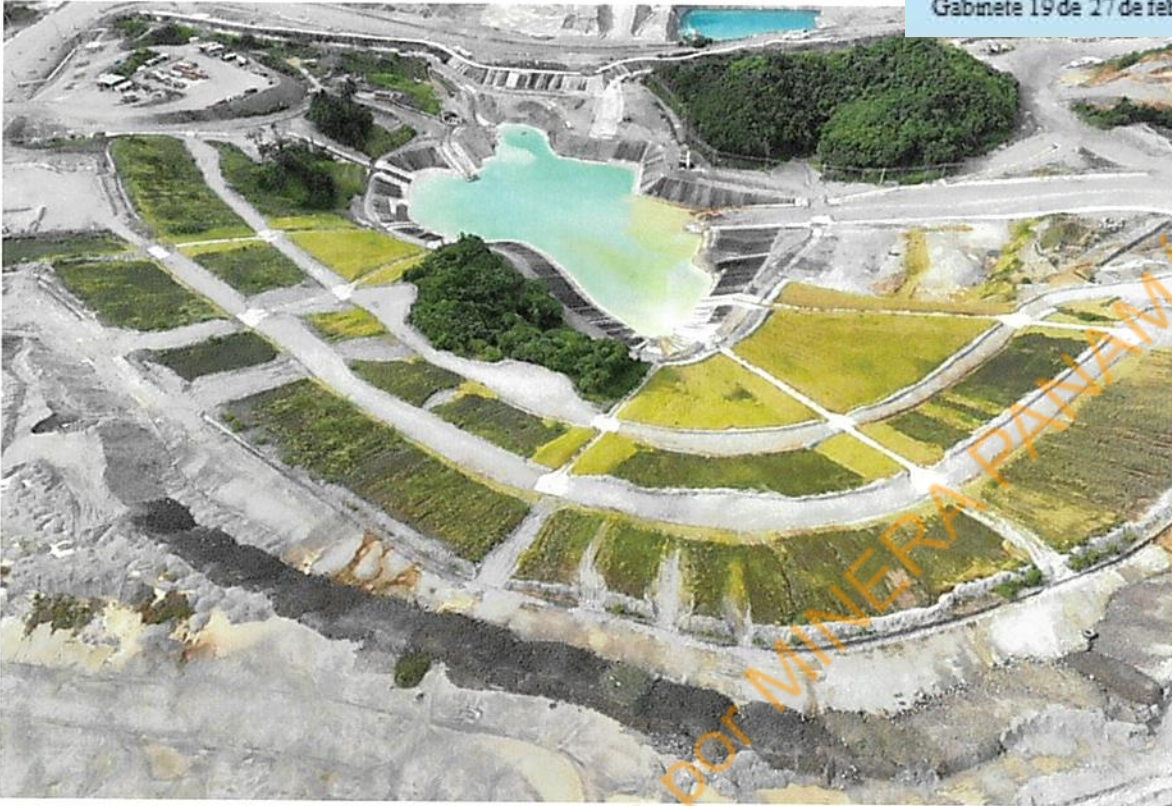
Fig.2 Poza 2 y canales de concreto en funcionamiento.
