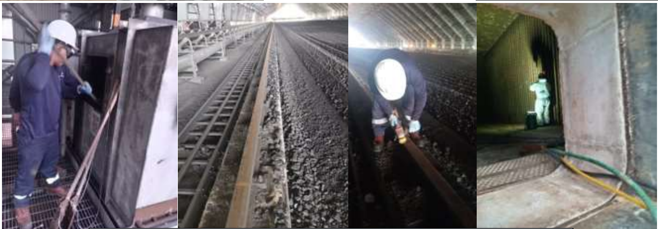
Limpieza de Ignitores y quemadores – Pulverizadores
