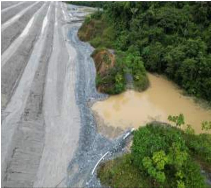
Figura 26 - canal de manejo de escorrentías en el pie del sector 1, Muro Norte
