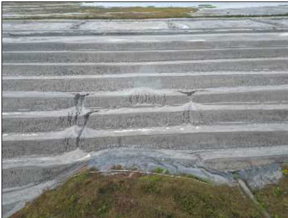
Figura 93 - Erosión en banquetas Muro Norte, Celda 15
