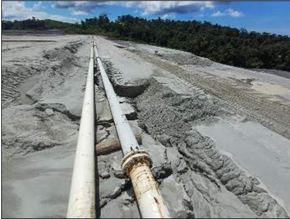
Figura 86 - Erosión área de la cresta, Celda 21 Aguas Abajo
