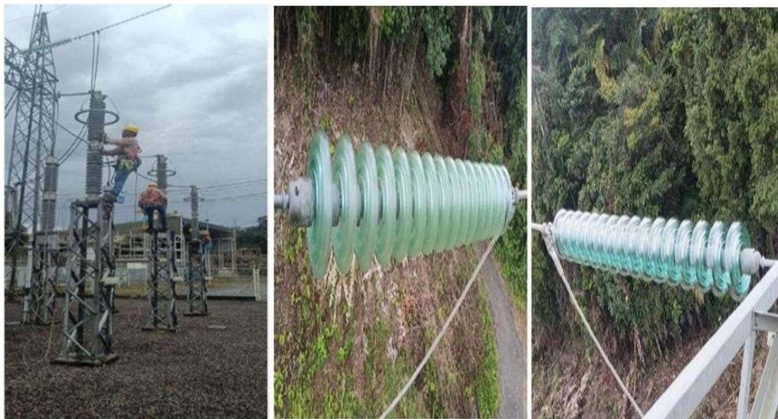
Ilustración 41 Limpieza de aisladores
