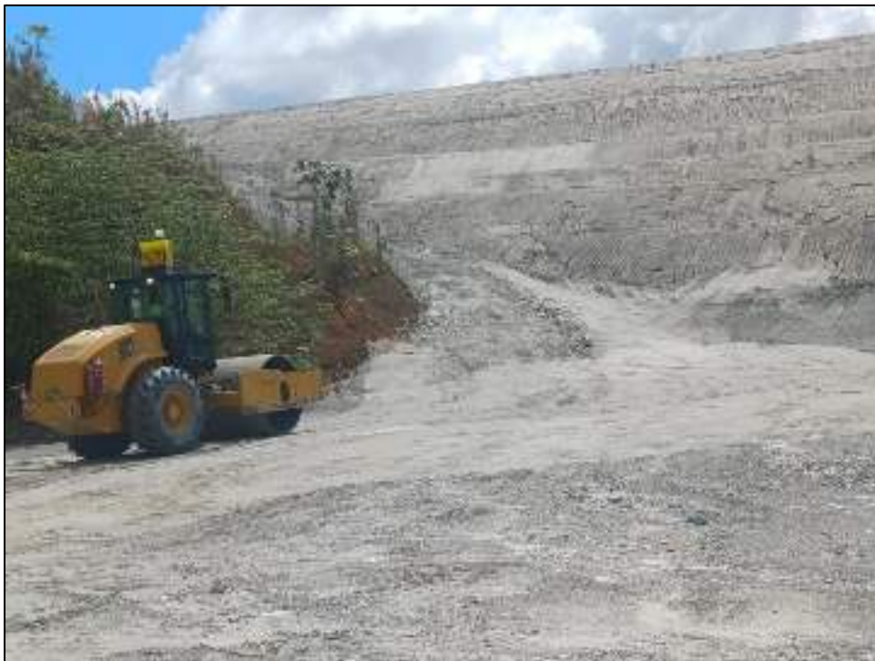
Figura 91 - Reparación de contacto con terreno natural Muro Este, Celda 39 Aguas Abajo
