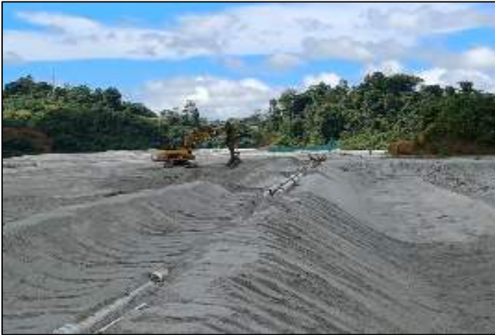
Figura 37 - Reparación de erosión área de tuberías de descarga de arena celda 34-35, Muro Este
