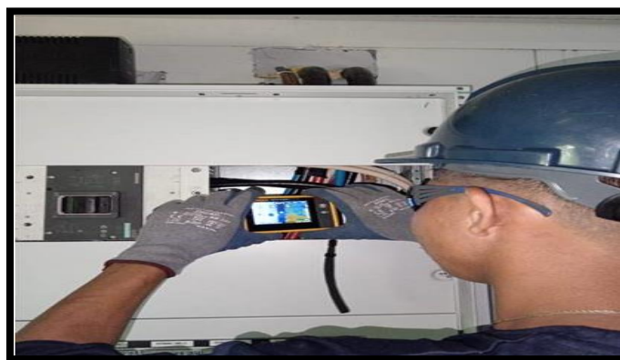
Inspección de Termografía de Panel Principal Modulo Habitacional
