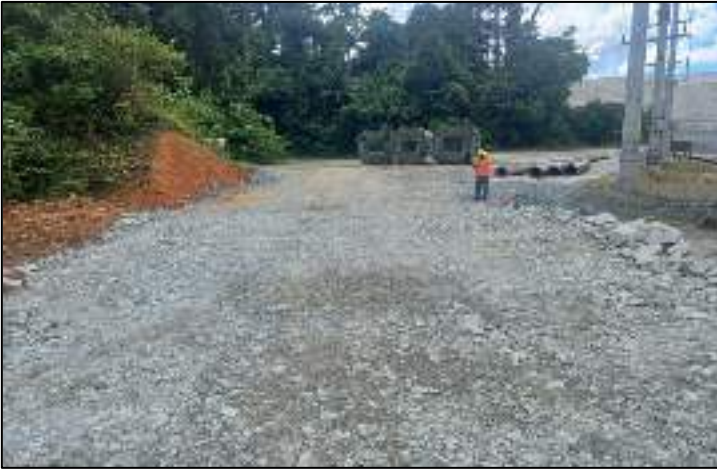
Figura 34 - Conformación acceso y plataforma de grúa Seepage well 1A, Muro Este
