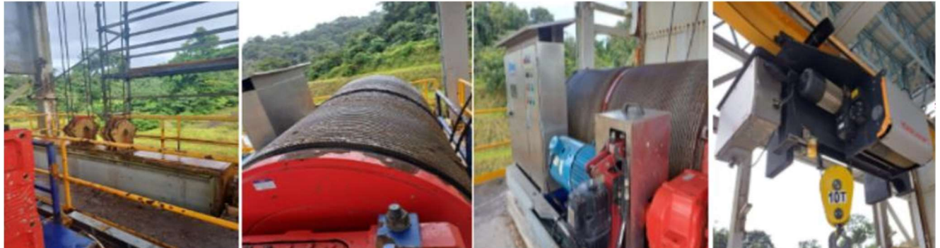
Ilustración 38 Inspección Mensual de compuerta de aliviadero y pruebas funcionales de 364-cn-9002
