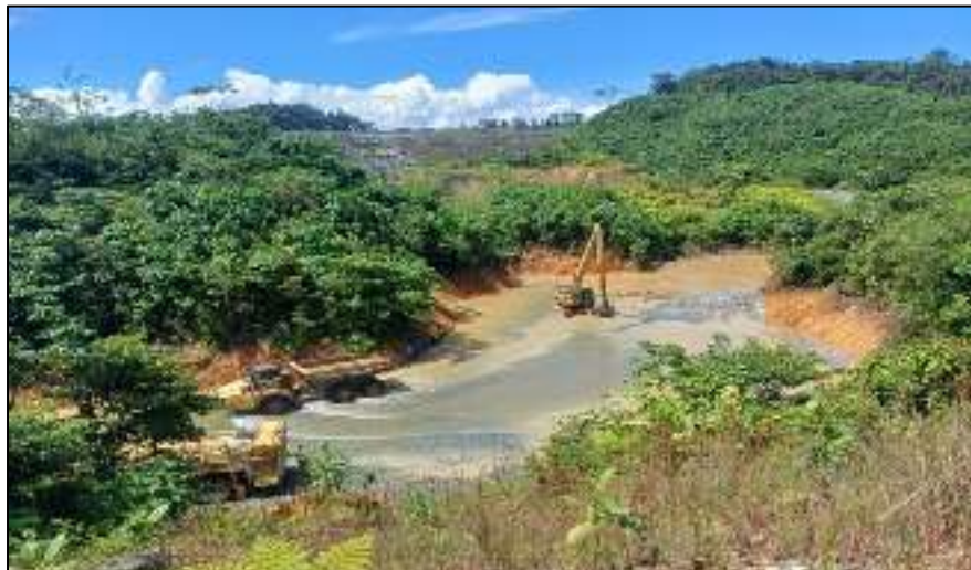
Figura 38 - Limpieza y colocación de roca WRP06, Muro Este
