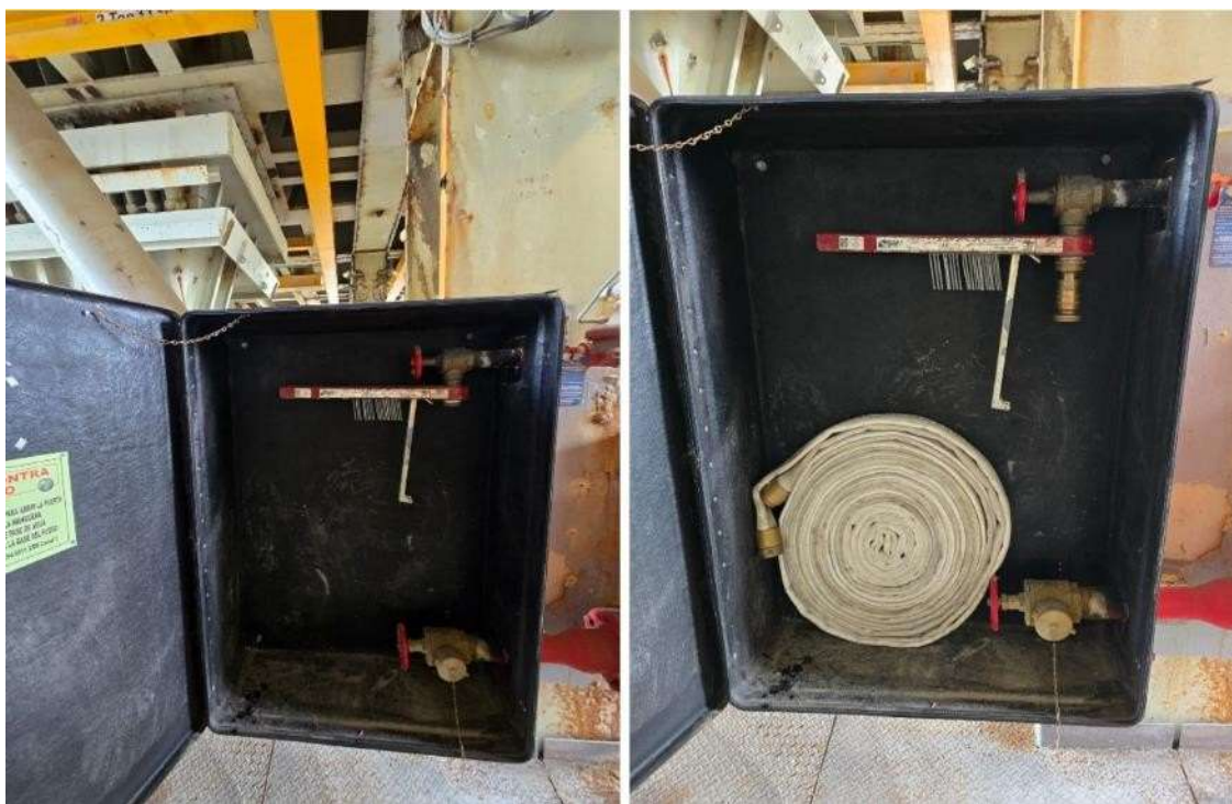
Ilustración 7 Inspección de gabinetes ANTES Y DESPUES
