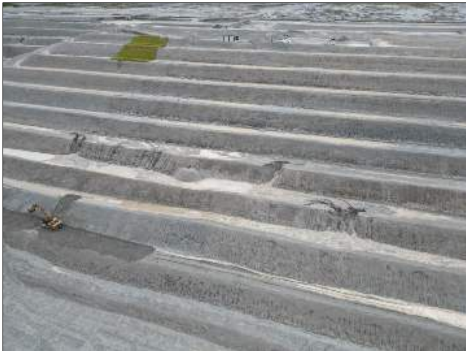
Figura 84 - Erosión en el Muro Norte, Celda 6 Aguas Abajo
