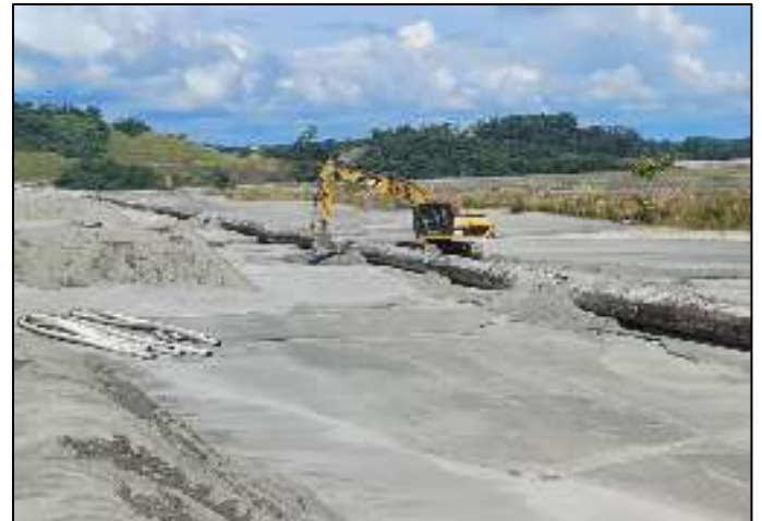
Figura 36 - Reparación de erosión área de línea rougher Sector 2-3, Muro Norte
