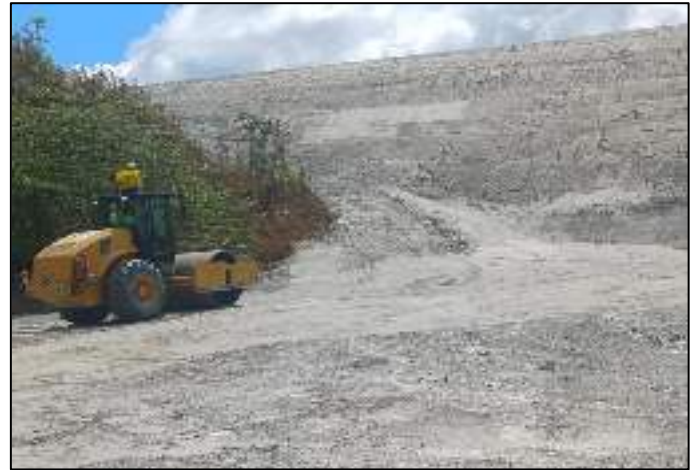
Figura 35 - Reparación de erosión contorno Celda 39, Muro Este
