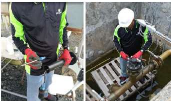
MANTENIMIENTO ELECTRODOS DESCARGA DE AGUA A MAR
