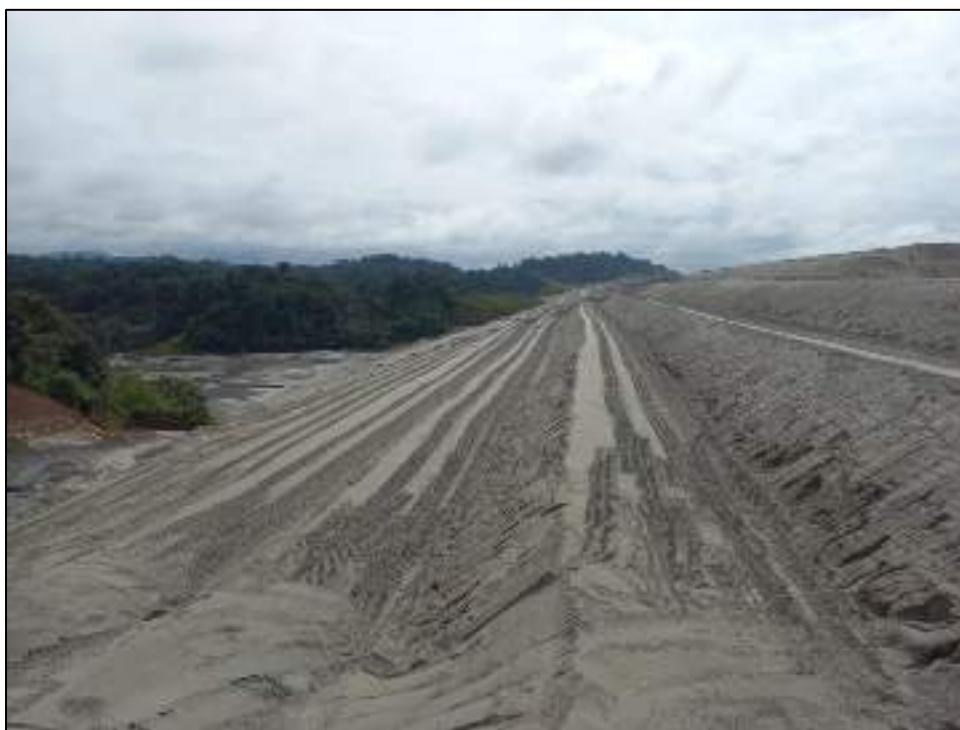
Figura 89 - Mantenimiento de banquetas Sector 3, Muro Norte Aguas Abajo
