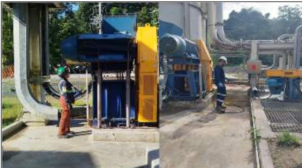
Figura 4 - Monitoreo de condiciones de bombas de las estaciones de recolección de filtraciones
