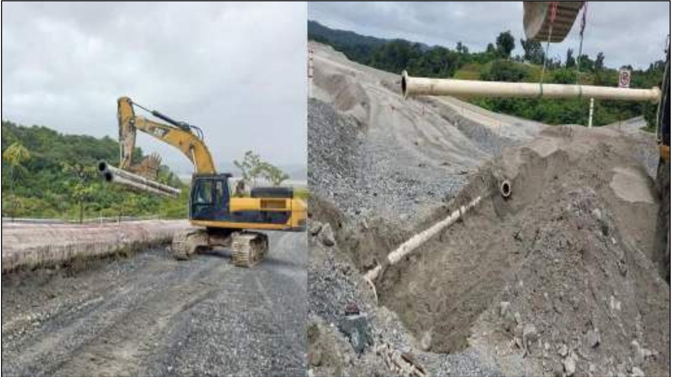
Figura 8 - Reubicación de tuberías de descarga de arena y tuberías de relaves para reparación de erosiones.
