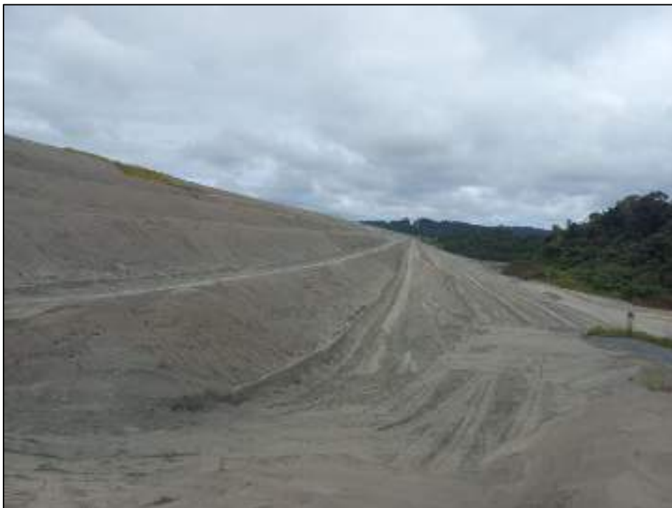
Figura 85 - Reparación completada de erosión en Muro Norte, Celda 06 Aguas Abajo
