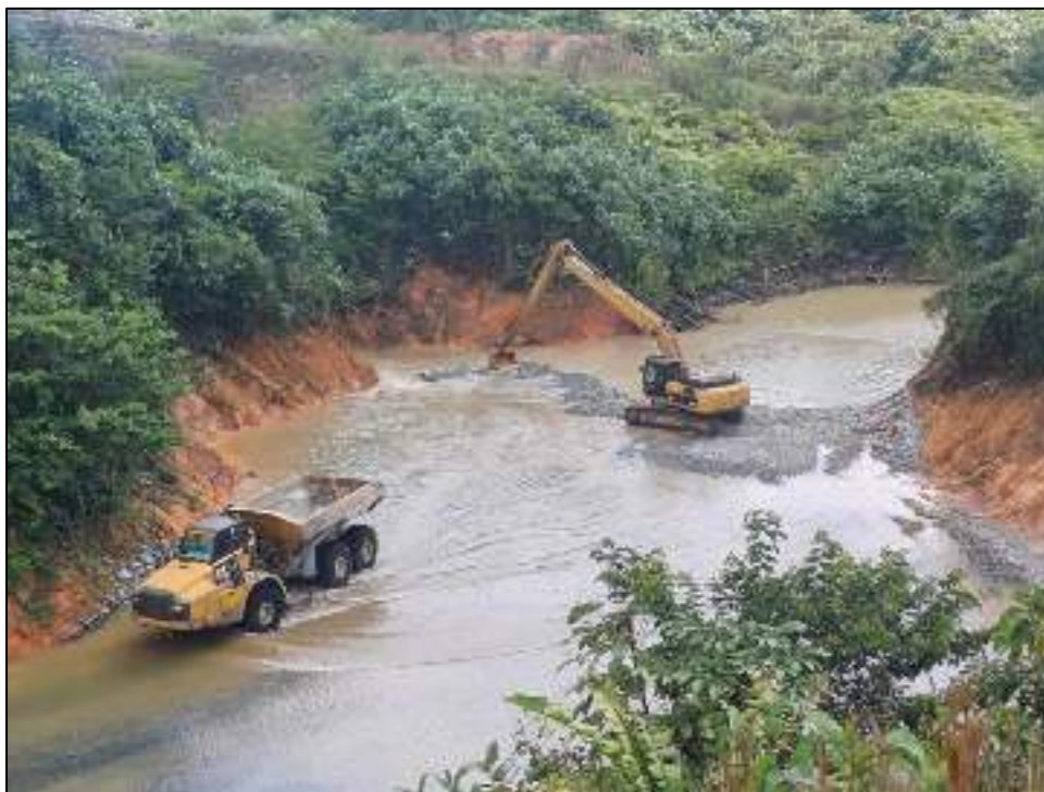
Figura 95 - Trabajo de limpieza en fundación sumergida (Muro Este, WRP#6)
