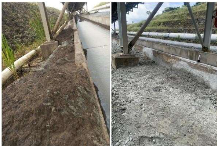
Ilustración 21 Limpieza de bases de Estructuras de la faja transportadora
