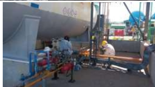
Limpieza de tanques químicos- BOP
