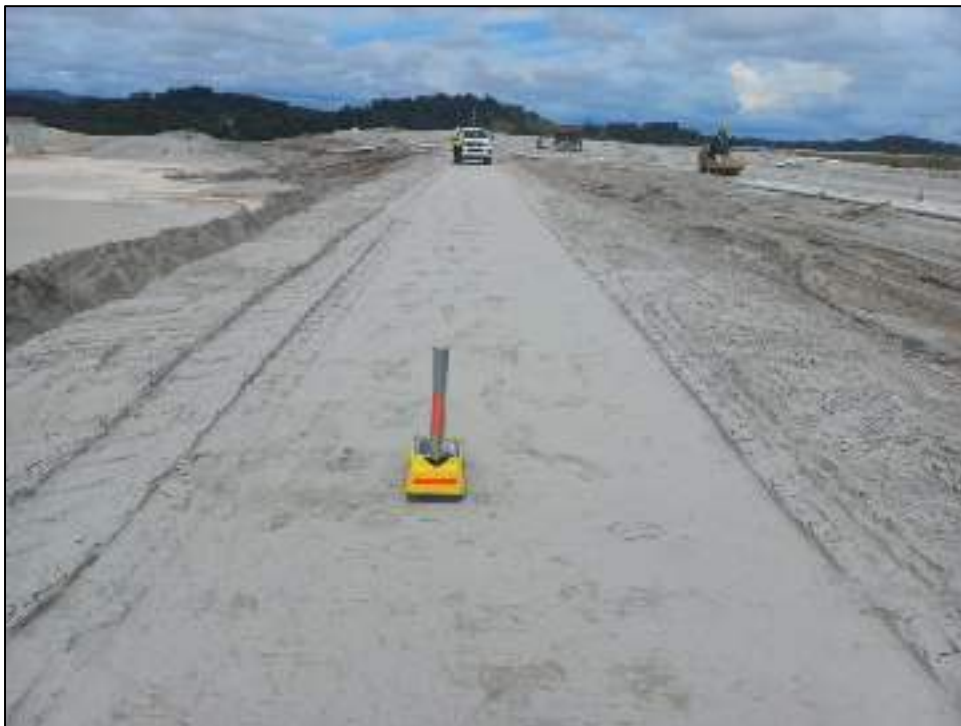
Figura 87 - Control de compactación en Muro Norte, Celda 21 Aguas Abajo
