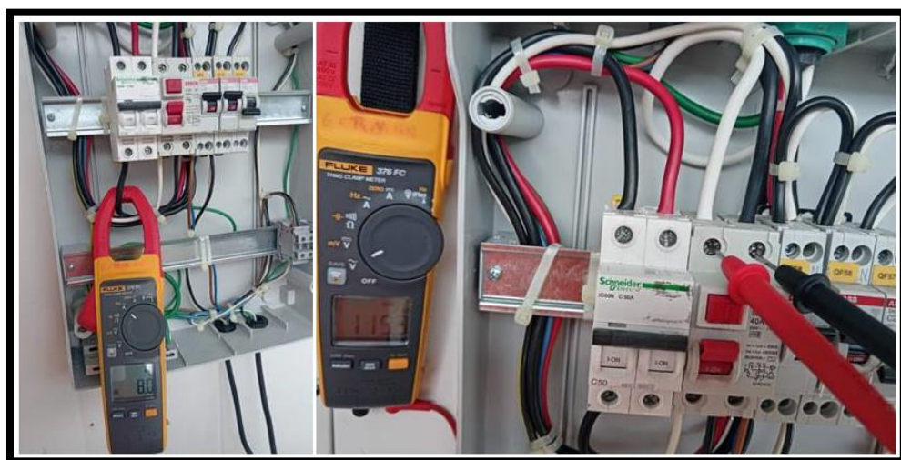
Inspección General Eléctrica en Panel de Distribución secundario
