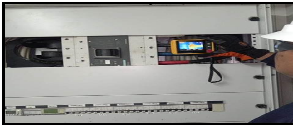
Inspección de Termografía Panel distribución de Módulo Habitacional
