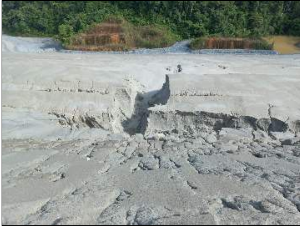
Figura 92 - Erosión en banqueta Muro Norte, Celda 09
