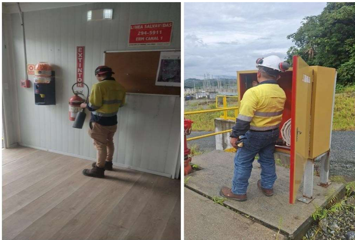
Ilustración 8 Inspección de Extintores y Gabinetes
