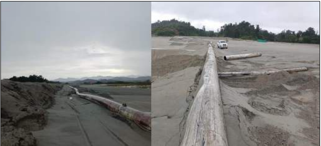
Figura 9 - Inspección de líneas de Relaves HDPE, durante simulacro operativo en estaciones de válvulas, ruta costera y muros de la IMR.
