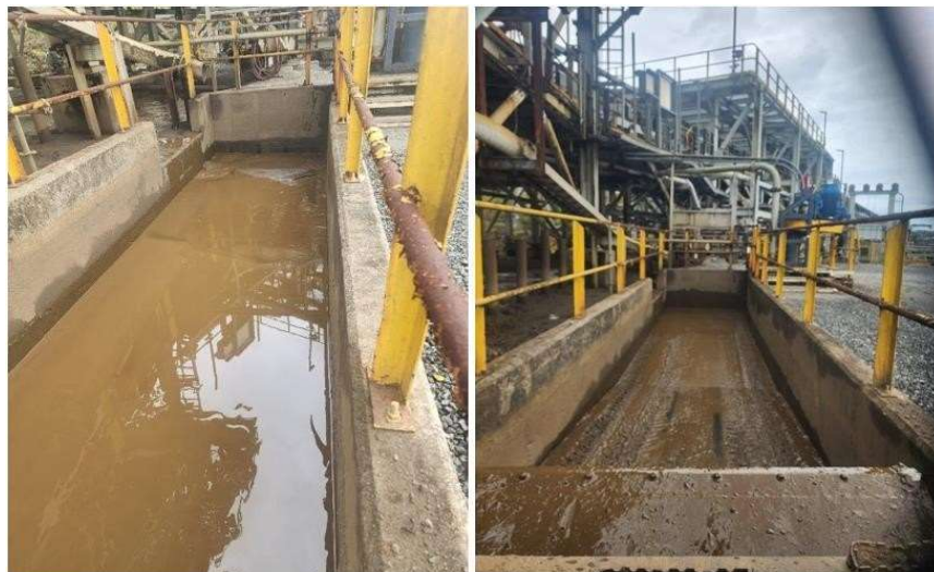
Ilustración 20 Limpieza de Sumideros de las fajas transportadoras.
