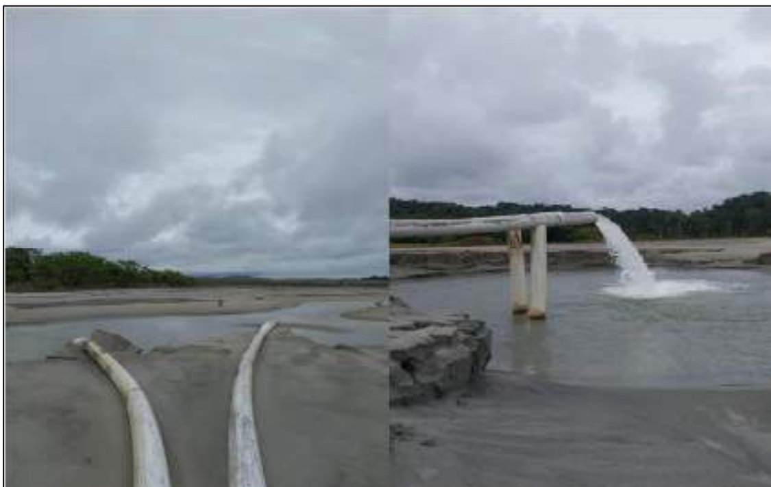
Figura 7 - Inspección, reubicación y corte de líneas de retorno de SCF4 y SCF6
