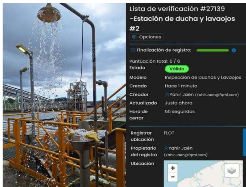
Ilustración 9 Inspección de Lavajos y duchas
