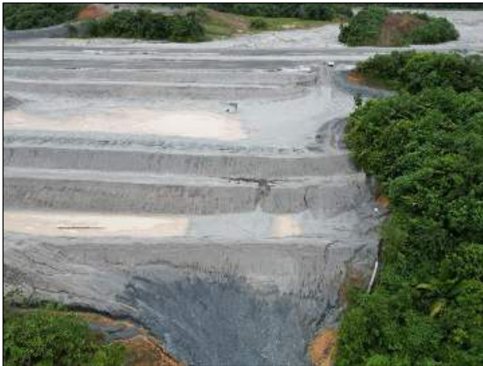
Figura 94 - Erosión en banqueta Muro Este, Celda 14
