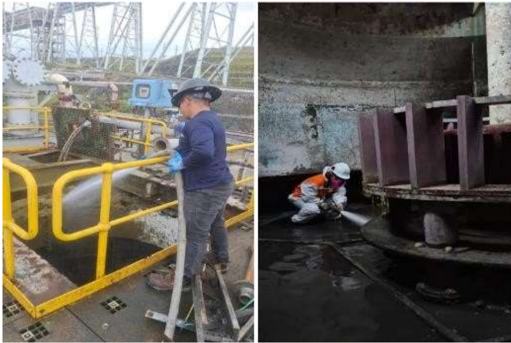
Ilustración 31 Limpieza de celdas de flotación segundo cleaner, Parte externa e interna
