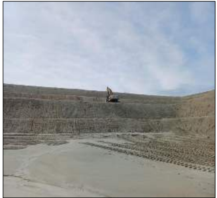
Figura 33 - Reparación de erosión Celda 4 D/S Banquetas, Muro Norte
