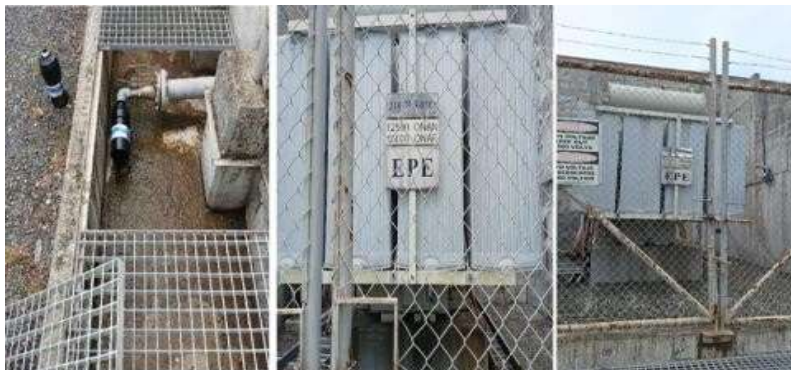
Ilustración 42 Reemplazo de filtros en tina de contención
