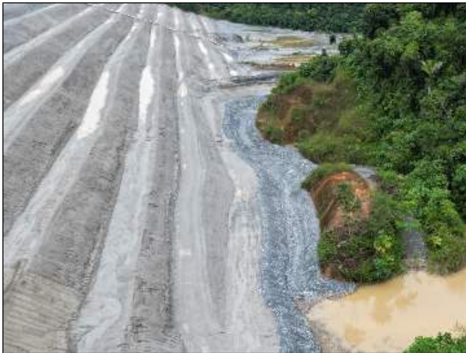
Figura 88 - Canal para manejo de escorrentías Sector 1, Muro Norte Aguas Abajo
