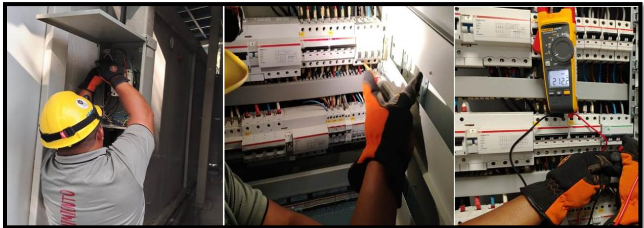
Inspección Panel de Distribución Principal
