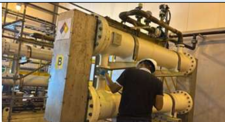
Boroskopia de electrolizador B y C
