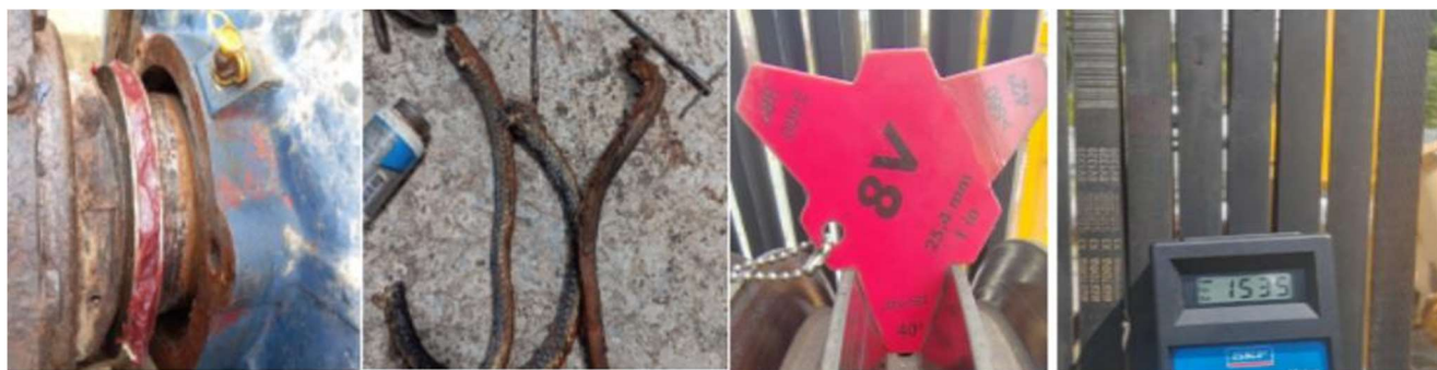
Ilustración 35 Evidencias de cambio de estopas e intervención de la bomba 363-PP-9305 de la poza colectora del IMR número 3.
