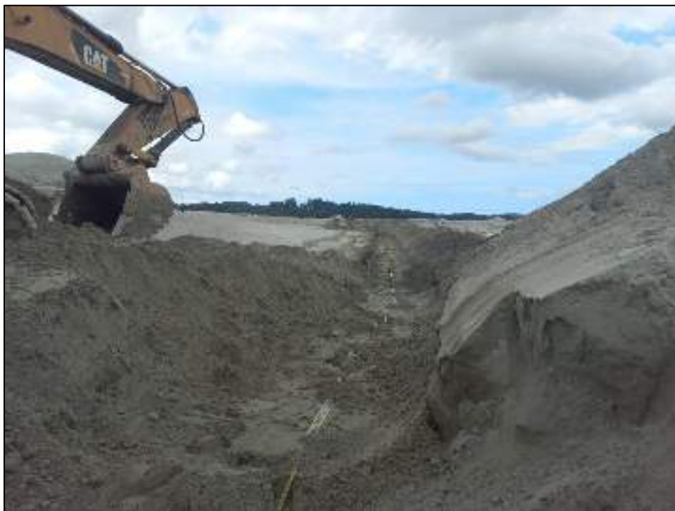
Figura 97 - Trincheras para interconexión de la instrumentación geotécnica por telemetría, Muro Norte Sector 2
