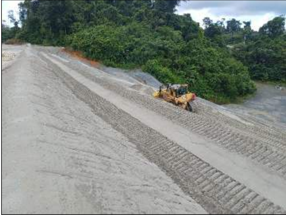
Figura 90 - Mantenimiento de banquetas muro Este, Celda 40 Aguas Abajo
