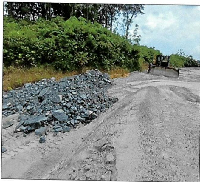
Figura 25 - Reparación de erosión ED Celda 22 D/S Contorno, Muro Este.
