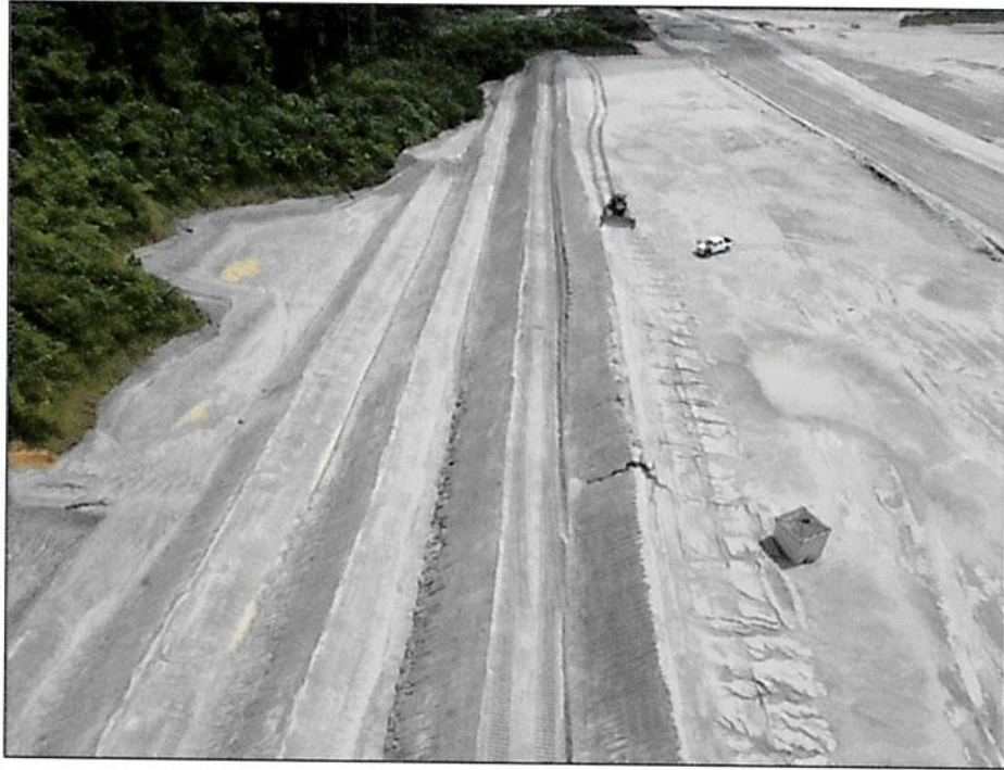
Figura 77 - Reparación de erosión en Muro Este, Celda 38 Aguas Abajo
