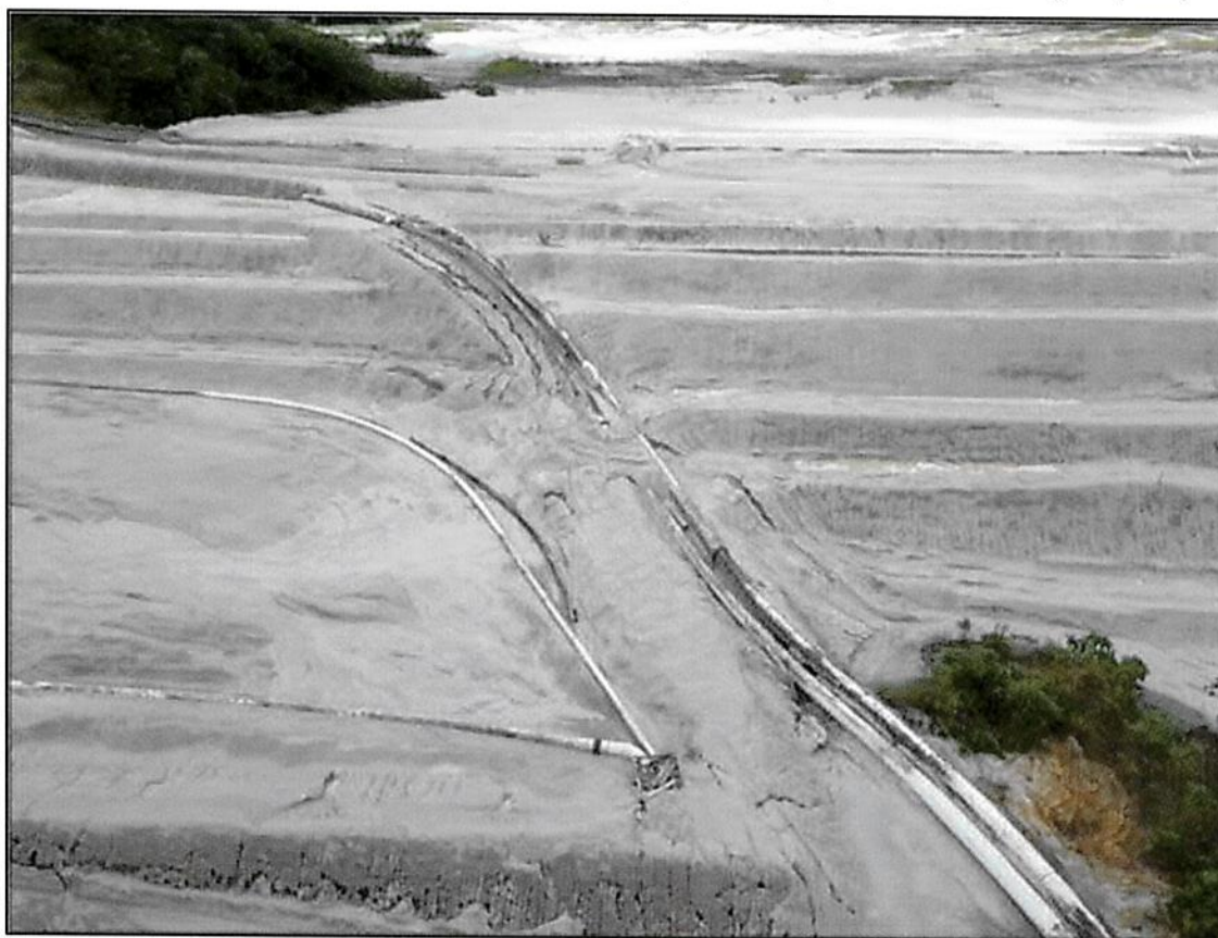
Figura 84 - Erosión en banquetas de Celda 03 Muro Norte, Aguas Abajo
