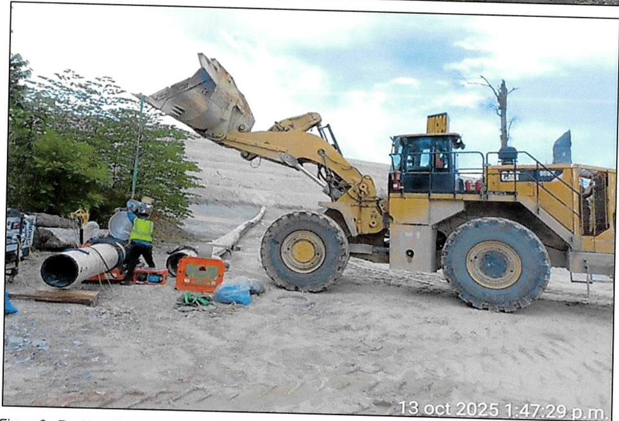
Figura 8 - Reubicación de tuberías de descarga de arena y tuberías de relaves para reparación de erosiones.
