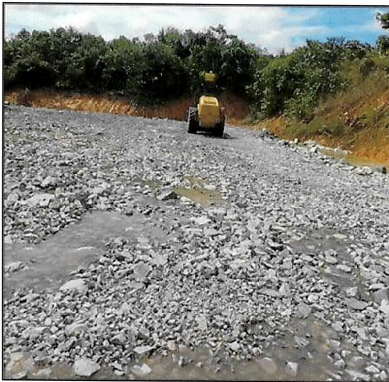
Figura 88 - Compactación de Zona 7 en Muro Este, WRP06
