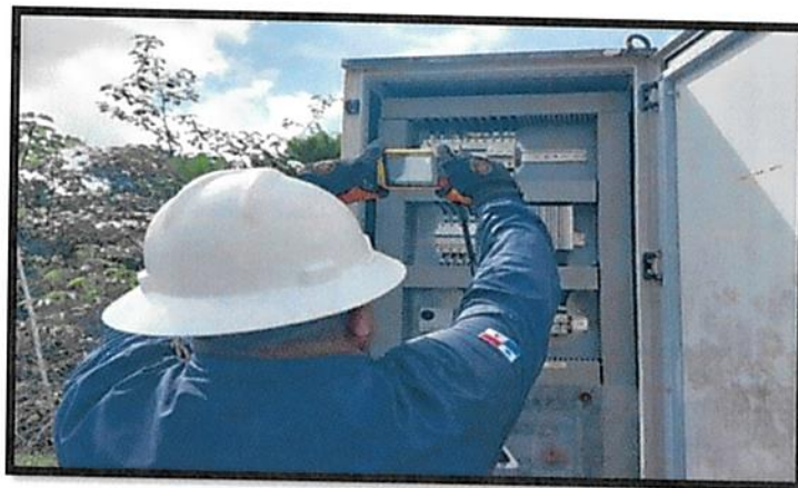
Inspección de Termografía de Panel Principal Villas Tucán
