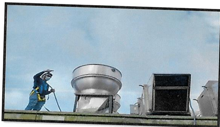
Mantenimiento y Limpieza de Sistema de Extracción de Cocina
