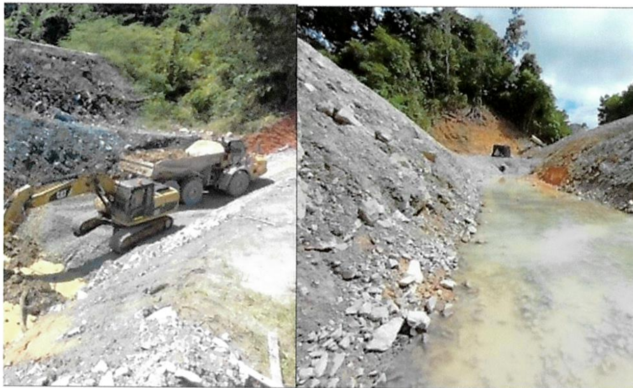
Figura 81 - Excavación y limpieza previas a la instalación de la tubería colectora
