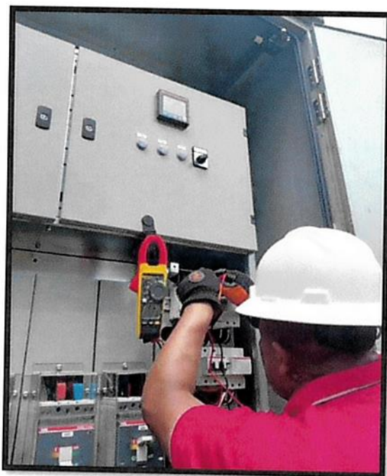
Inspección Panel de Distribución Principal - Inspección eléctrica de Contenedores Refrigerados
