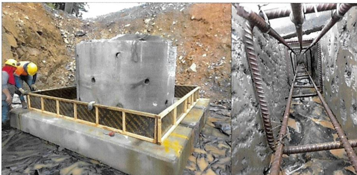
Figura 79 - Instalación de la base de concreto armado del pozo colector de aguas (PCA) y colocación del primer anillo prefabricado de concreto
