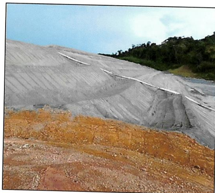
Figura 30 - Reparación de erosión ND Celda 25-24 D/S Banqueta, Muro Norte.
