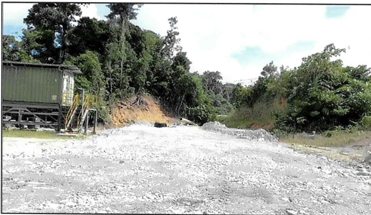
Figura 83 - Colocación del material Zona 7 como capa final del pozo colector de aguas (PCA)
