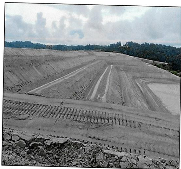
Figura 31 - Reparación de erosión ND Celda 20-21 D/S Banqueta, Muro Norte.
