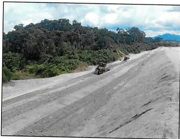
Figura 33 - Reparación de erosión ED Celda 35-36 D/S Banqueta, Muro Este.
