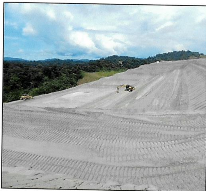
Figura 26 - Reparación de erosión ED Celda 20 D/S Banqueta, Muro Este.
