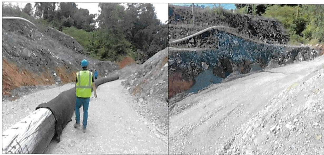
Figura 82 - Colocación de tubería en el pozo colector de aguas (PCA), WRP01, Muro Este
