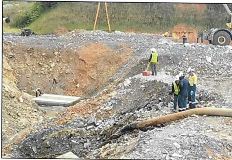
Figura 78 - Excavación y preparación de la zona para la construcción del pozo colector de aguas (PCA) del WRP01 - Presa Este
