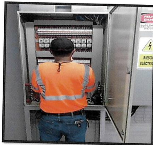
Inspección Eléctrica Panel de Cocina
