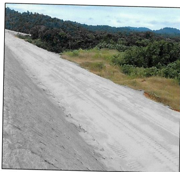
Figura 32 - Reparación de erosión ND Celda 16-17 D/S Banqueta, Muro Norte.
