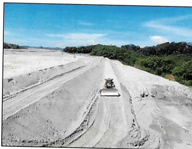
Figura 35 - Reparación de erosión ED Celda 13 D/S Banqueta, Muro Este.
