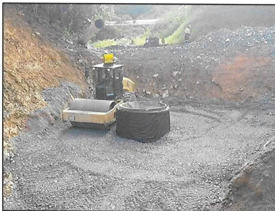
Figura 80 - Compactación del material filtrante alrededor del pozo colector de aguas (PCA), siguiendo las especificaciones de diseño
