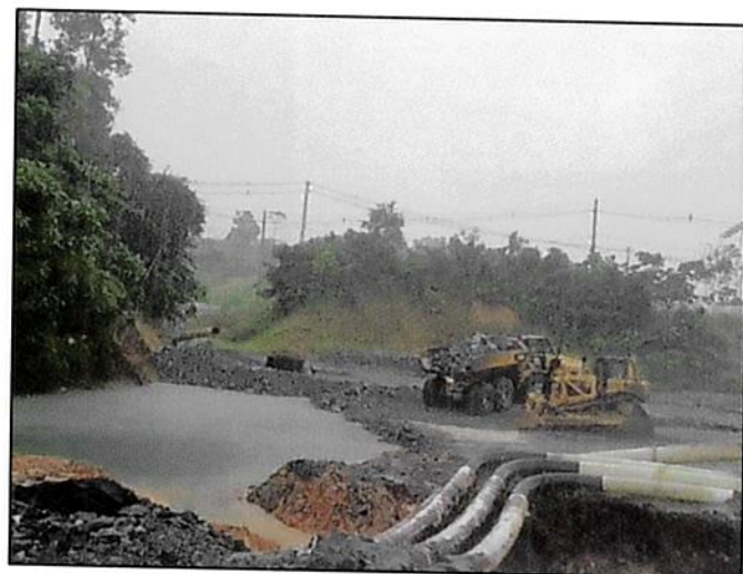
Figura 38 - Relleno de cárcamo de bomba en SPW1A WRP01 (Z7 NAG).
