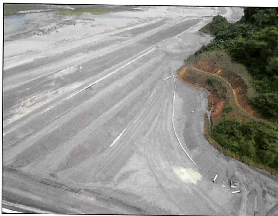
Figura 77 - Trabajo completo en reparación de erosión en celda 35 Muro Este, WRP2
