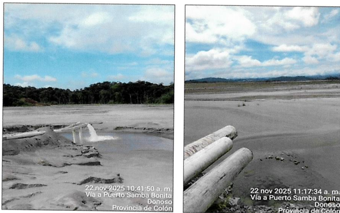
Figura 7 - Inspección de líneas de retorno de SCF4 y SCF6
