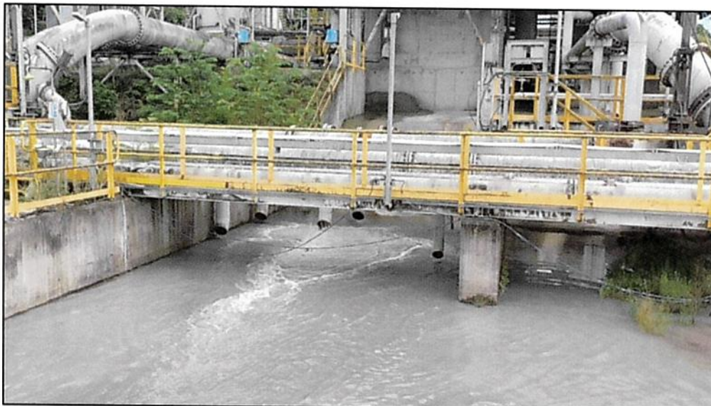
Figura 6 - Lavado de tuberías de Relaves desde Flotación hacia el Muro Norte
