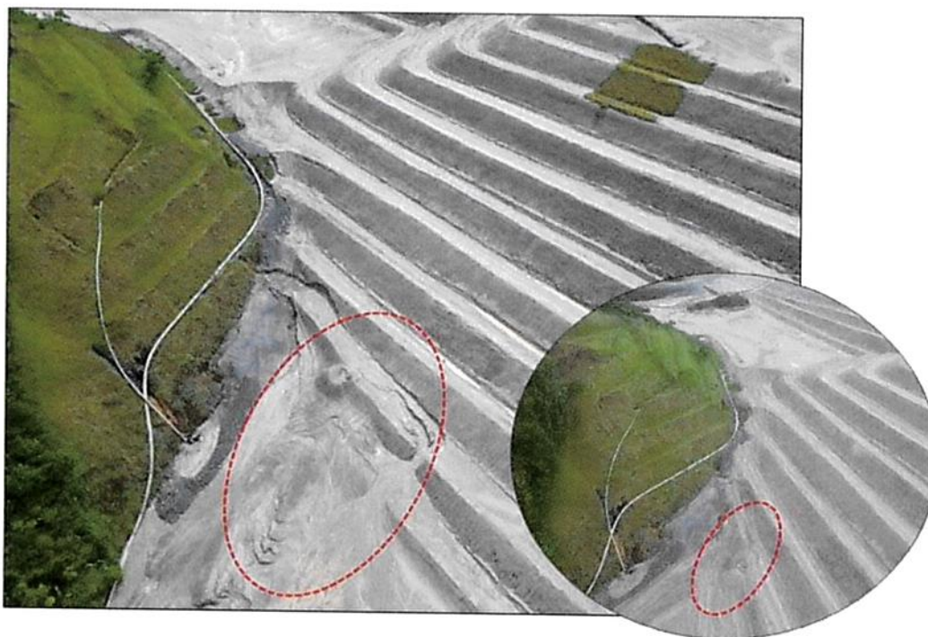
Figura 82 - Sector rehabilitado luego de presentar erosión, con mejoramiento de la superficie del talud en el Muro Norte, celda 06.
