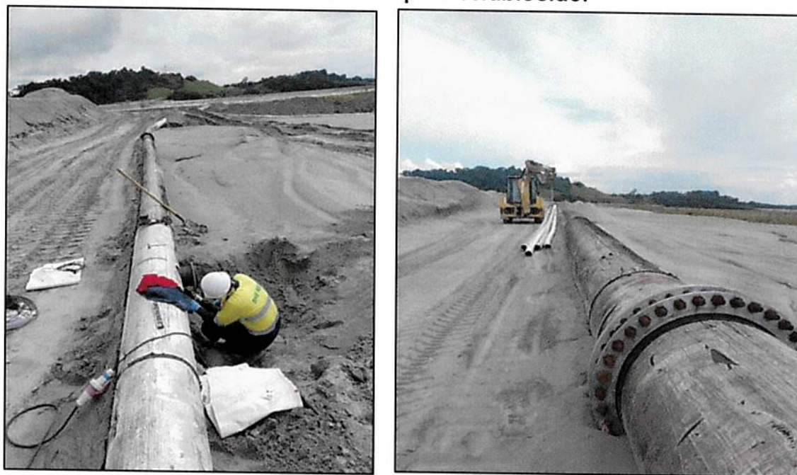
Figura 8 - Reubicación de tuberías de descarga de arena y tuberías de relaves para reparación de erosiones.
