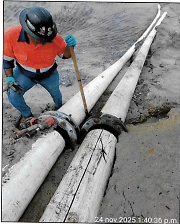
Figura 9 - Inspección de líneas de Relaves HDPE, durante simulacro operativo en estaciones de válvulas, ruta costera y muros de la IMR.
