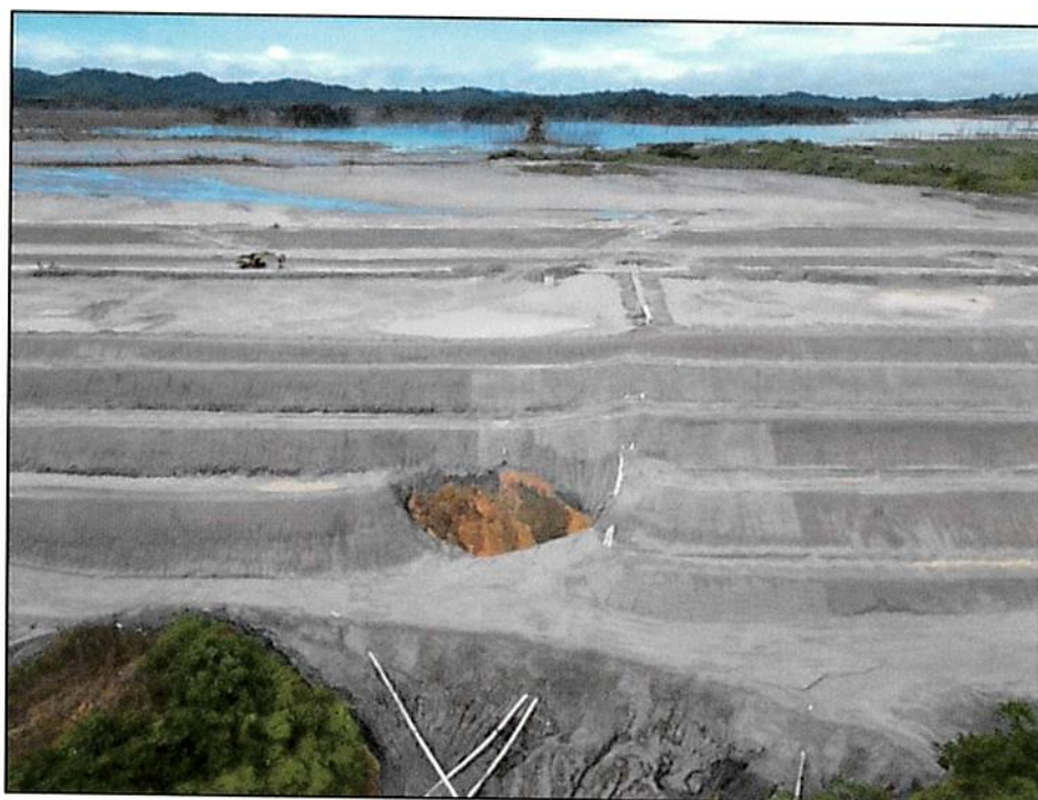
Figura 79 - Reparación concluida en el tramo afectado por erosión en Celda 31, Muro Este
