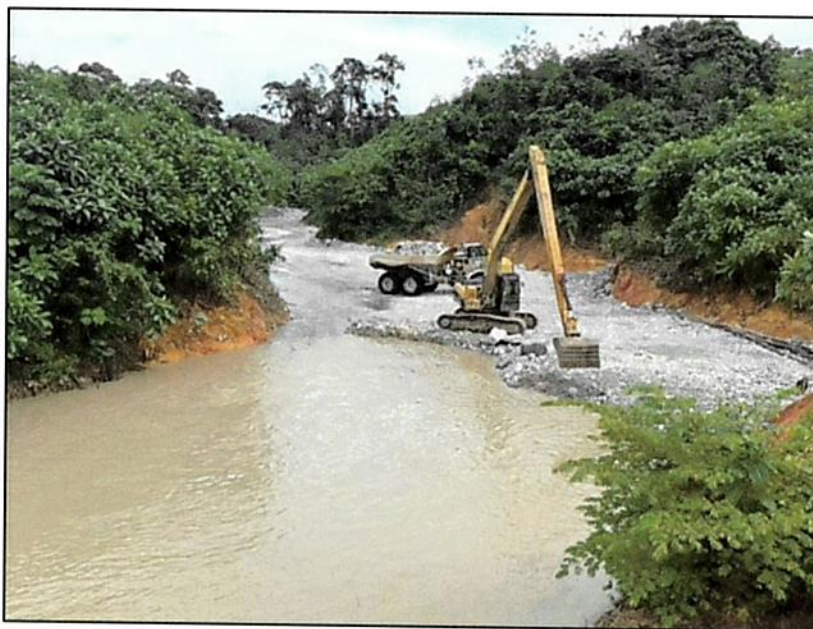
Figura 84 - Trabajos de limpieza y colocación de Zona 7 en la fundación del Muro Este (WRP#6)
