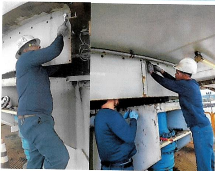
Remplazo de los tornillos de la guarda del tornamesa
