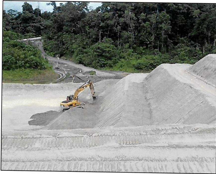
Figura 29 - Reparación de erosión Celda 18 y 19 en EDWRP05
