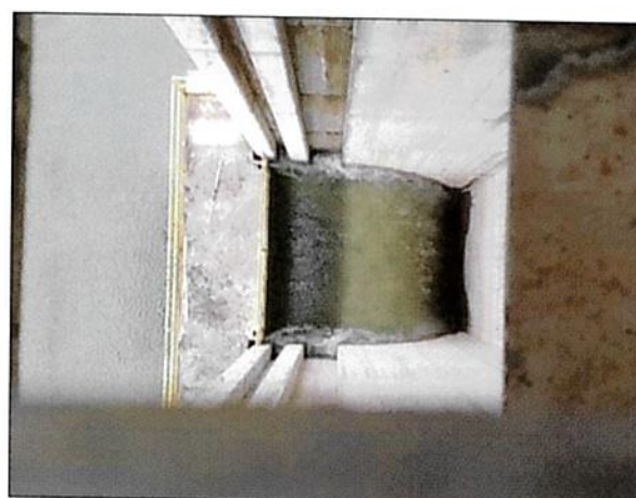
Figura 72 -No se observan obstrucciones en la entrada de la torre de aliviadero
