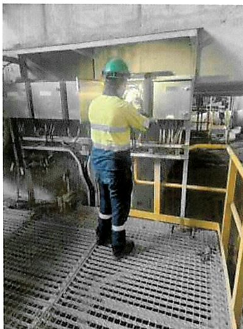
Ilustración 3 Revisión de instrumentos asociados a válvulas
