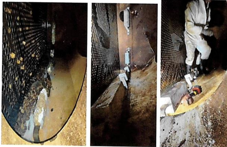
Limpieza de las cajas de agua de mar del condensador U2
