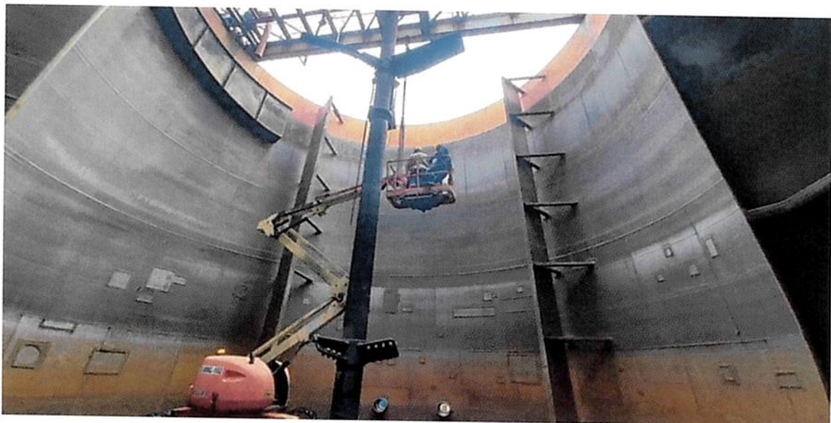
Instalación de eje en Agitador 712AG9002
