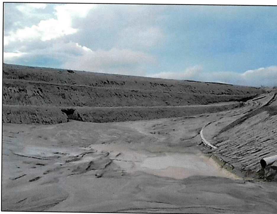
Figura 76 - Erosión causada por las lluvias en la celda 35 Muro Este, WRP2
