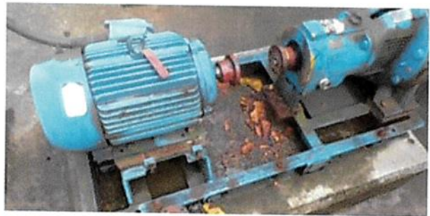
Verificación de acople y fabricación de guarda
