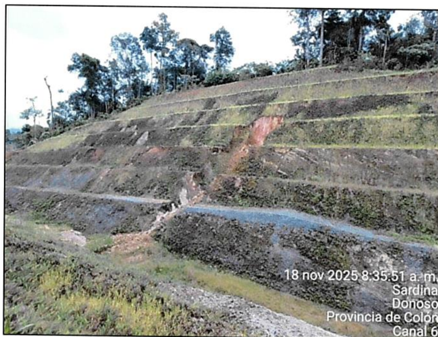
Figura 86 -Erosión en banquetas de canal 6 Muro Este, WRP6
