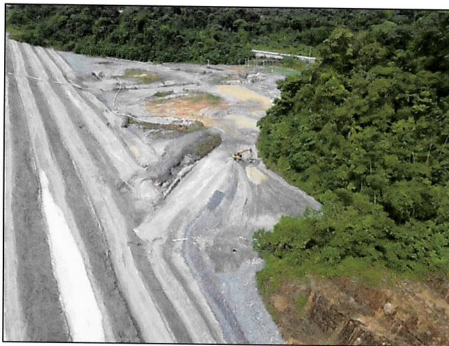
Figura 81 - Trabajos de reparación completados en la berma de contención del Canal B, dejando el tramo estabilizado.
