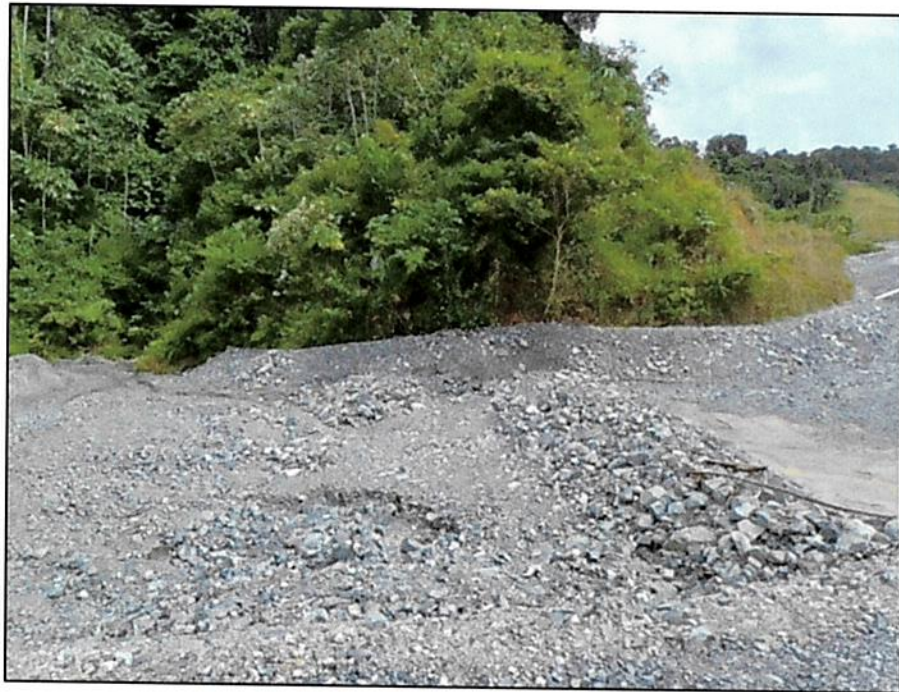
Figura 80 - Berma de contención afectada en el Muro Norte-Canal B, con ruptura generada por escorrentía durante eventos de lluvia
