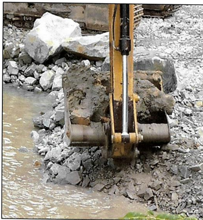
Figura 85 - Material encontrado en limpieza de fundación sumergida, aprobado por el equipo de QAQC
