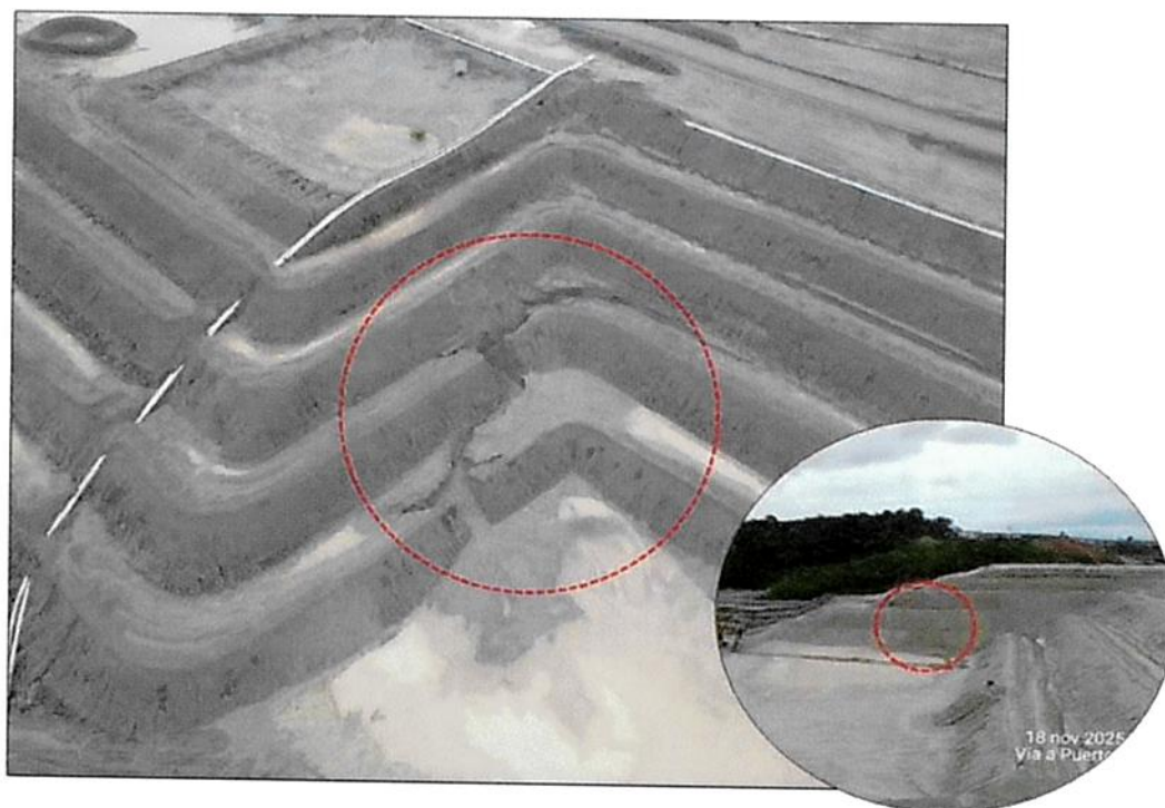
Figura 74 - Erosión Reparada en el Muro Este, Celda 18 Aguas Abajo
