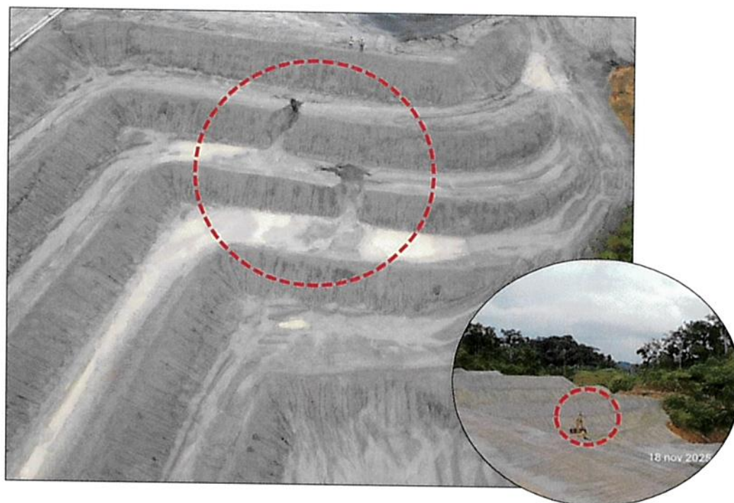
Figura 75 - Reparación de erosión en Muro Este, Celda 19 Aguas Abajo
