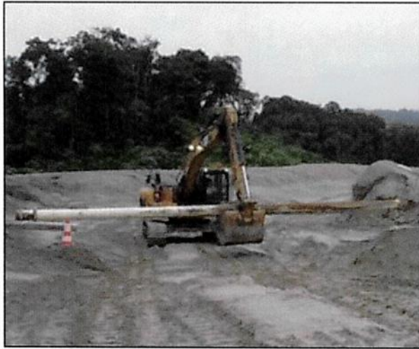
Figura 9 - Reemplazo de tuberías de acero carbón de trenes en Presa Este afectadas por desgaste.
