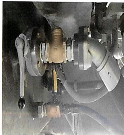
DTU0 4 - Cambio de Válvula de Tanque Diésel
