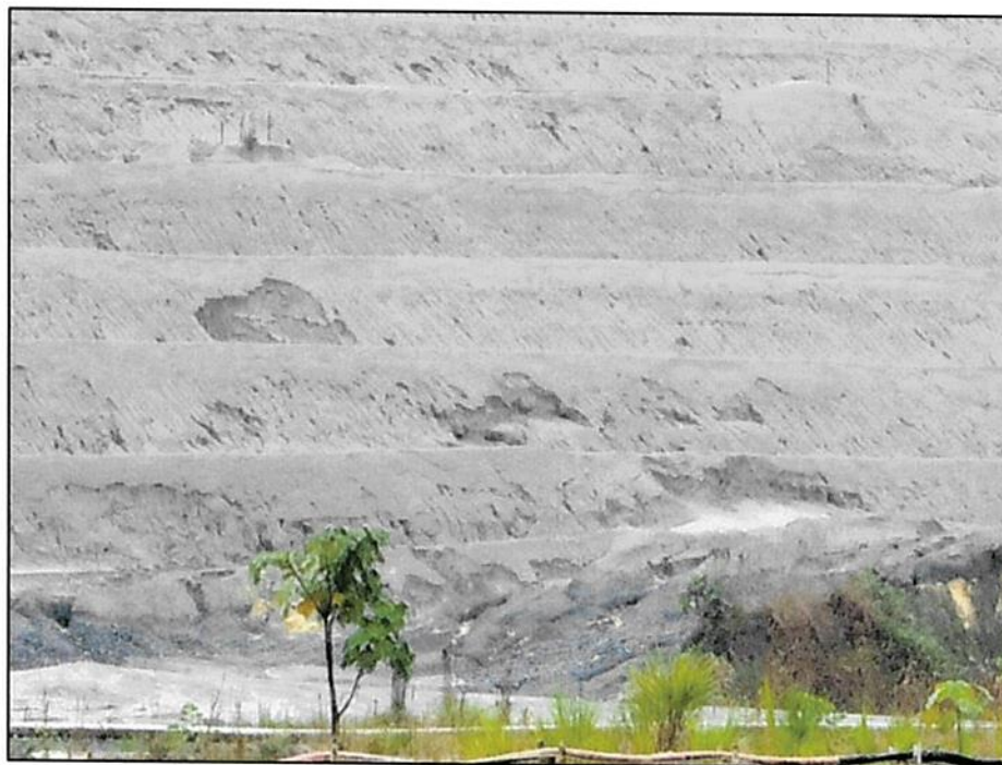
Figura 68 - Erosión Reparada en el Muro norte, Celda 40 Aguas Abajo
