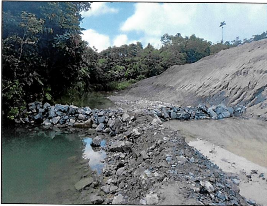
Figura 29 - Berma para control de sedimentos en WRP02, Muro Este
