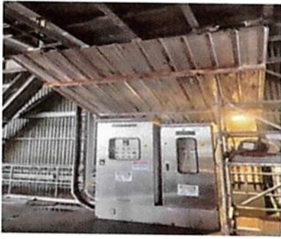
Instalación de techos en variadores
