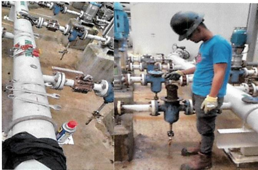
Ilustración 24 Limpieza de filtros de agua de sello.
