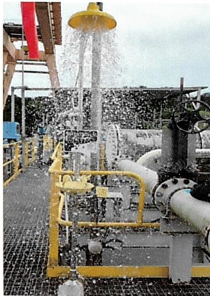
Ilustración 9 Inspección de ducha y lava ojos
