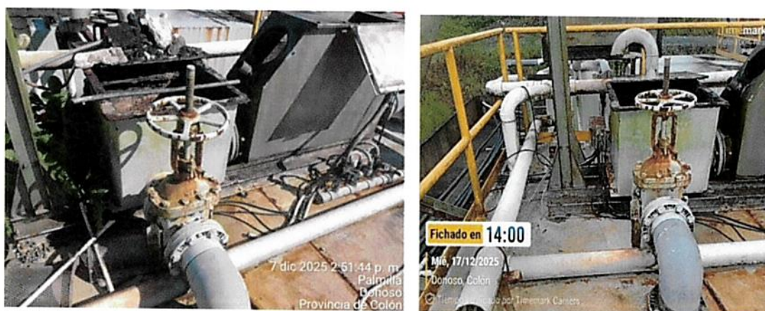
Limpieza de cajilla distribución de agua cruda ecualizadores 1-2
