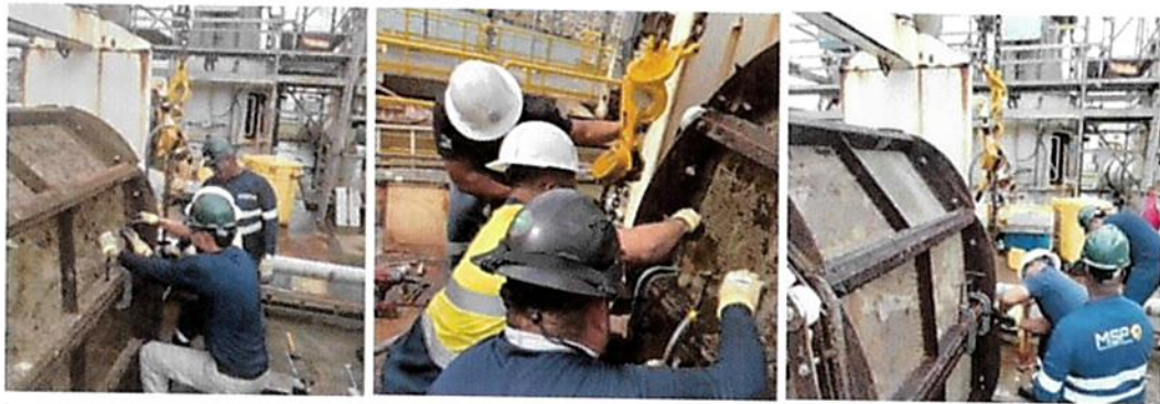
Mantenimiento de mallas rotativas
