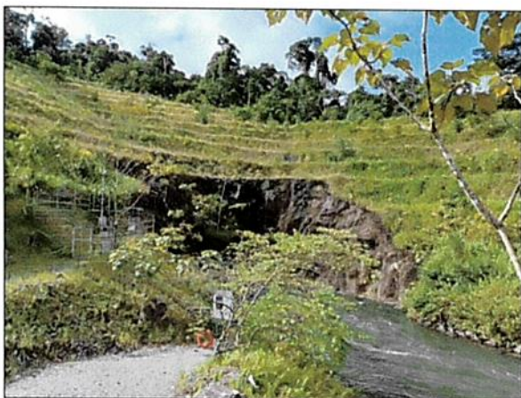
Figura 67 - Los taludes de la salida de descarga (túnel) se encuentra en buen estado
