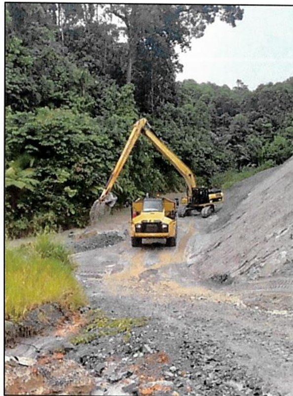
Figura 30 - Limpieza de sedimentos en poza en WRP02, Muro Este
