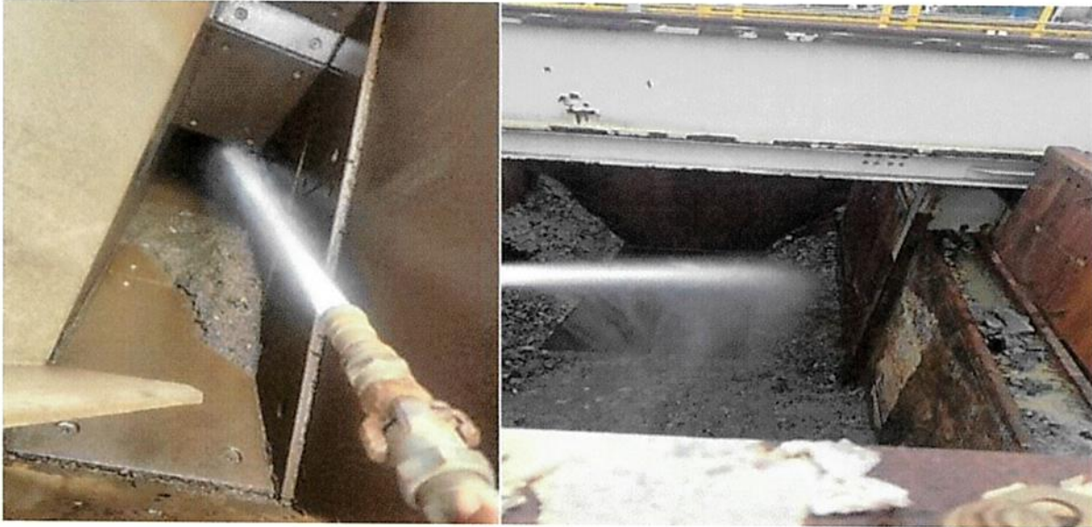
Ilustración 16 Limpieza de estructuras y cajones de circuito de clasificación
