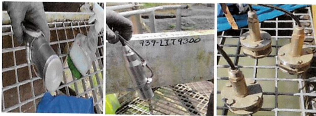
Mantenimiento a sensores de nivel
