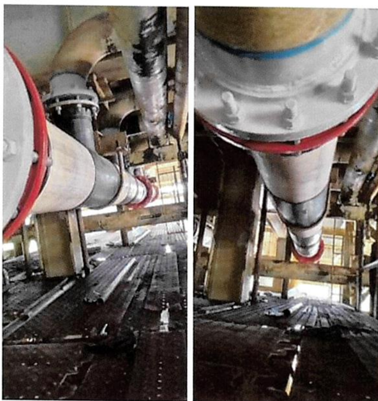
Confección de drenajes y tuberías
