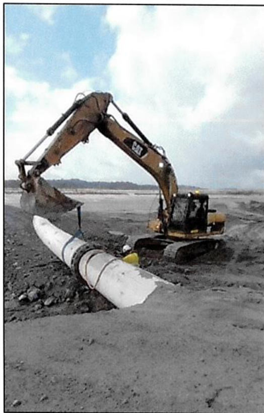
Figura 8 - Reubicación de tuberías de descarga de arena y tuberías de relaves para mejoras de corredor.
