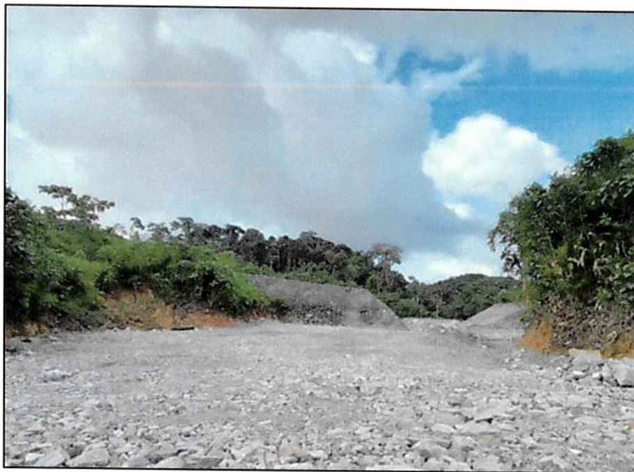
Figura 73 - Trabajos de limpieza y colocación de Zona 7 en la fundación del Muro Este (WRP#6)
