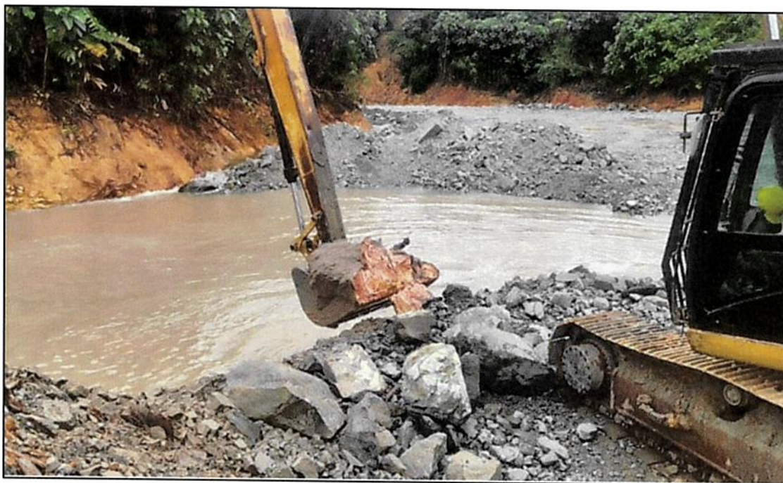
Figura 74 - Material encontrado en limpieza de fundación sumergida, aprobado por el equipo de QAQC
