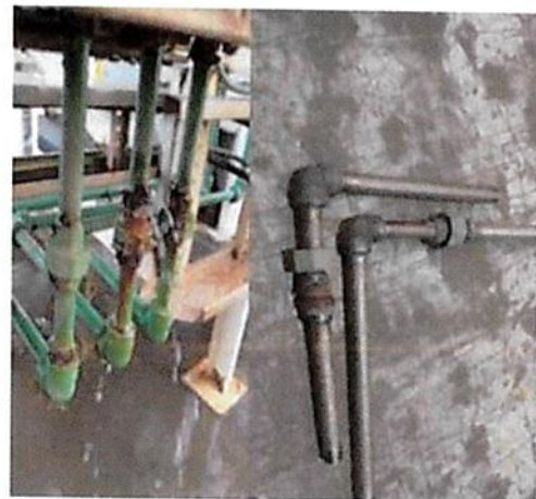
Reparación de tuberías de agua de servicio
