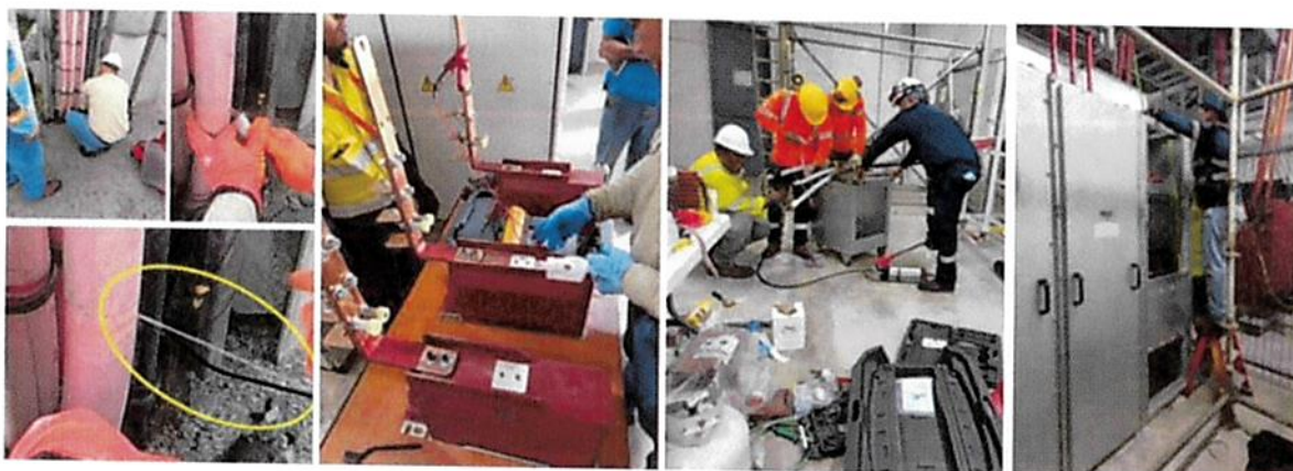
Reparación por falla a tierra de cubículo de 740-RMU-9001 en Port Facilities
