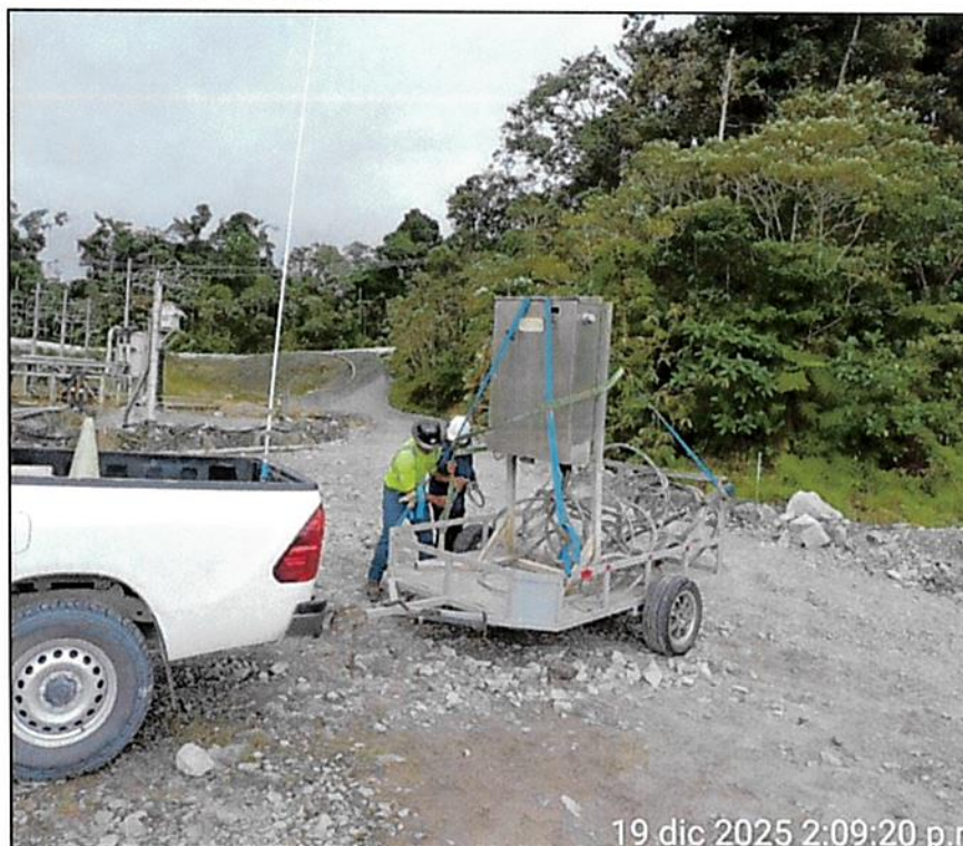
Figura 6 - Retiro de paneles y cableado que no se encuentra en uso en SCF7 presa Este para reubicarlo en taller para su inspección
