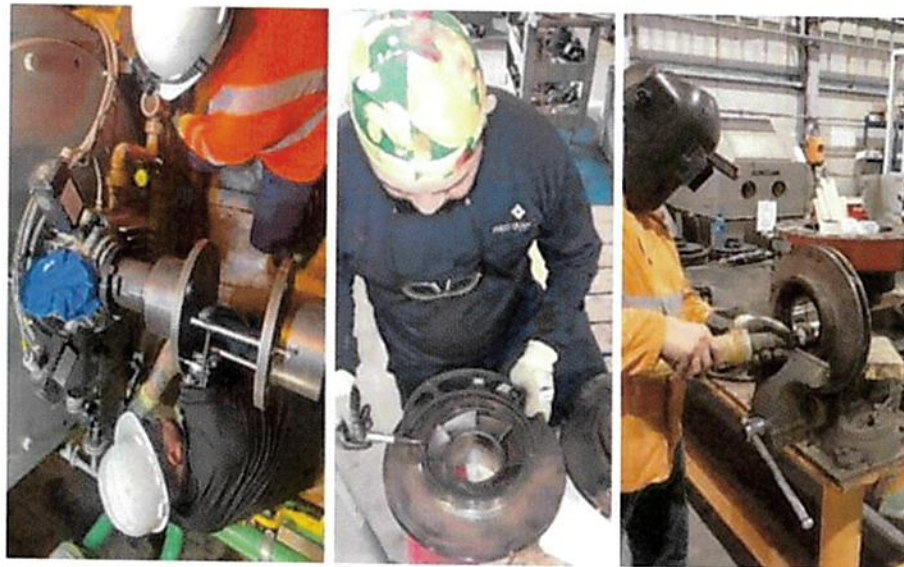
Re- comisionamiento de las bombas de alimento y condensado U1 – Personal de Torishima y MPSA
