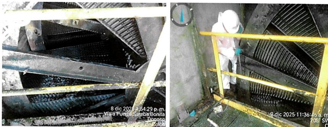
Limpieza de cajilla distribución de agua cruda ecualizadores 1-2
