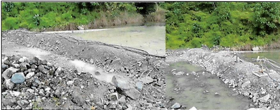
Figura 3 - Confección de berma e instalación de soportes para elevar cableado y evitar contacto con agua de poza
