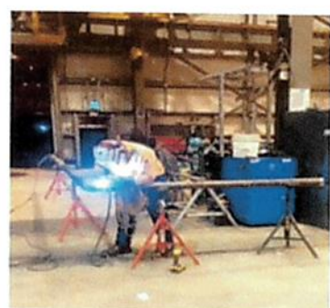
Fabricación e instalación de tubería para el SCI
