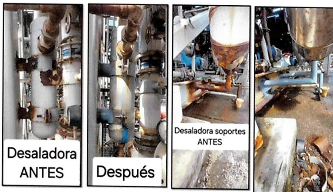
Reparación de soportes en la planta desaladora
