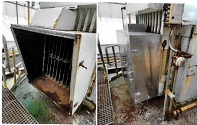
Restauración de estructura de fluidizing blower
