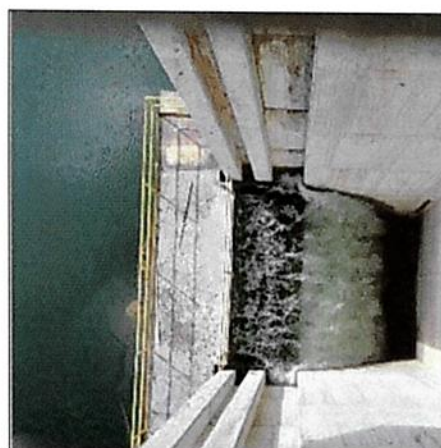
Figura 66 -No se observan obstrucciones en la entrada de la torre de aliviadero
