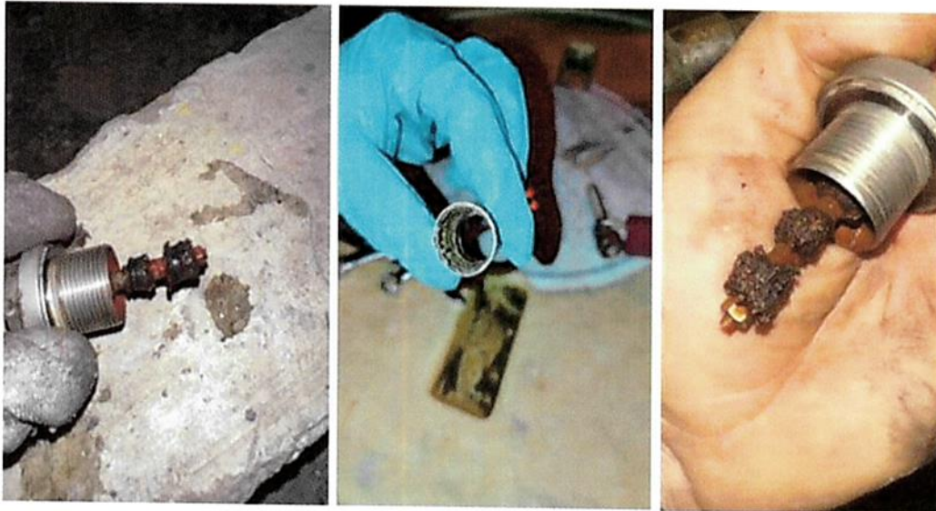
Limpieza de filtro de agua de sello de las CEP 1A y 1B
