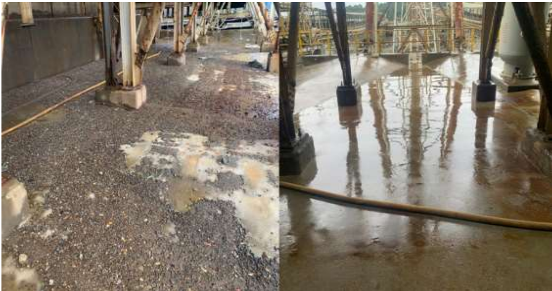
Ilustración 20 Limpieza de sedimentos en losa de los diferentes edificios.
