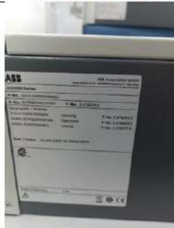
6. Instalación de nuevo analizador CO/CO2.
