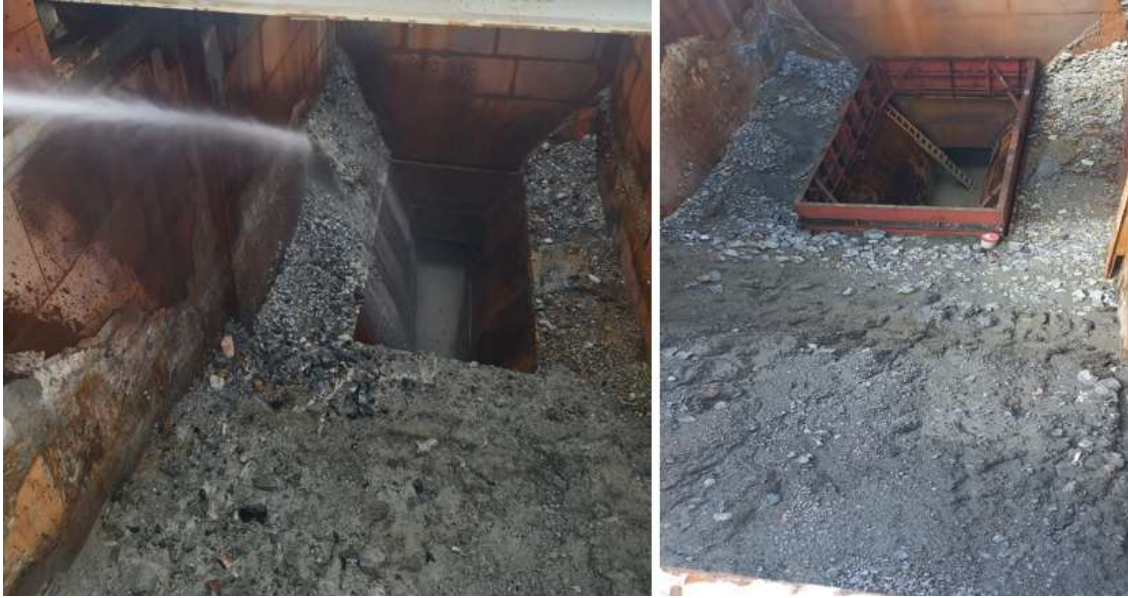
Ilustración 19 Limpieza de cajones con sedimento para trabajos de mantenimiento.
