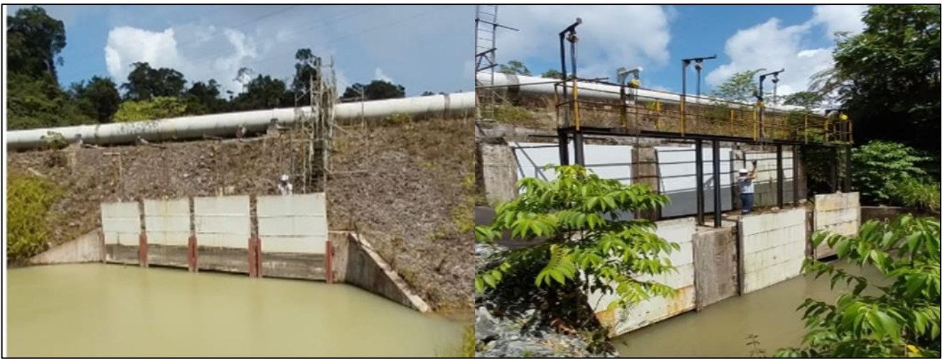
Figura 3 - Inspección de funcionalidad de Compuerta PB05/09
