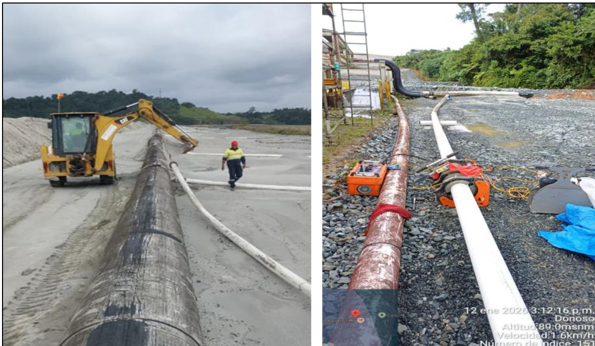
Figura 8 - Reubicación de tuberías de descarga de arena y tuberías de relaves para reparación de erosiones.
