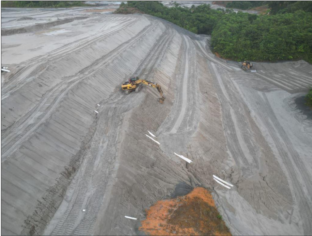
Figura 25 - Mantenimiento de banquetas en WRP03, Muro Este
