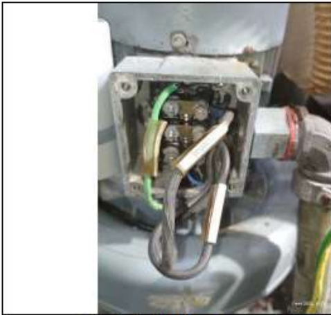
1. Instalación de capacitor de 25 uF.
