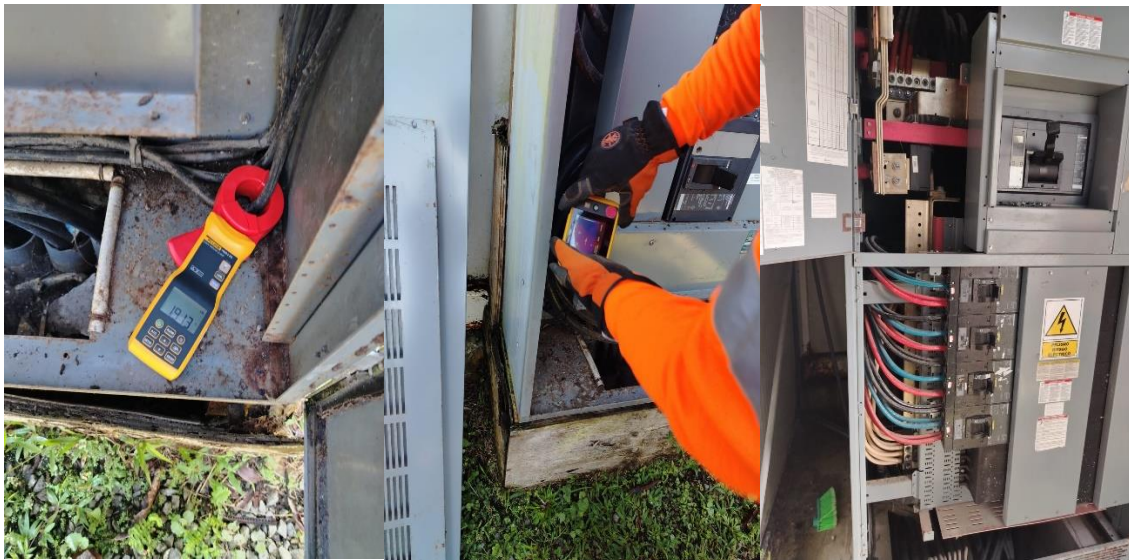
Inspección en Paneles de Distribución Principal del Campento
