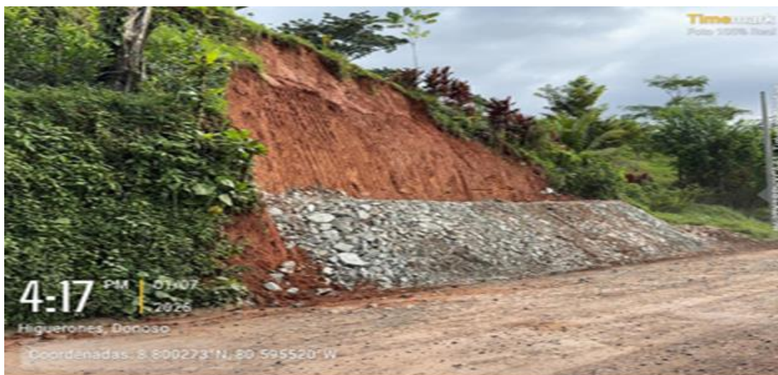
Talud estabilizado
