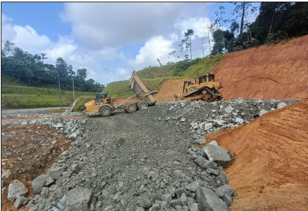
Figura 28 - Enrocamiento con Z7 NAG en Planta de Emulsión
