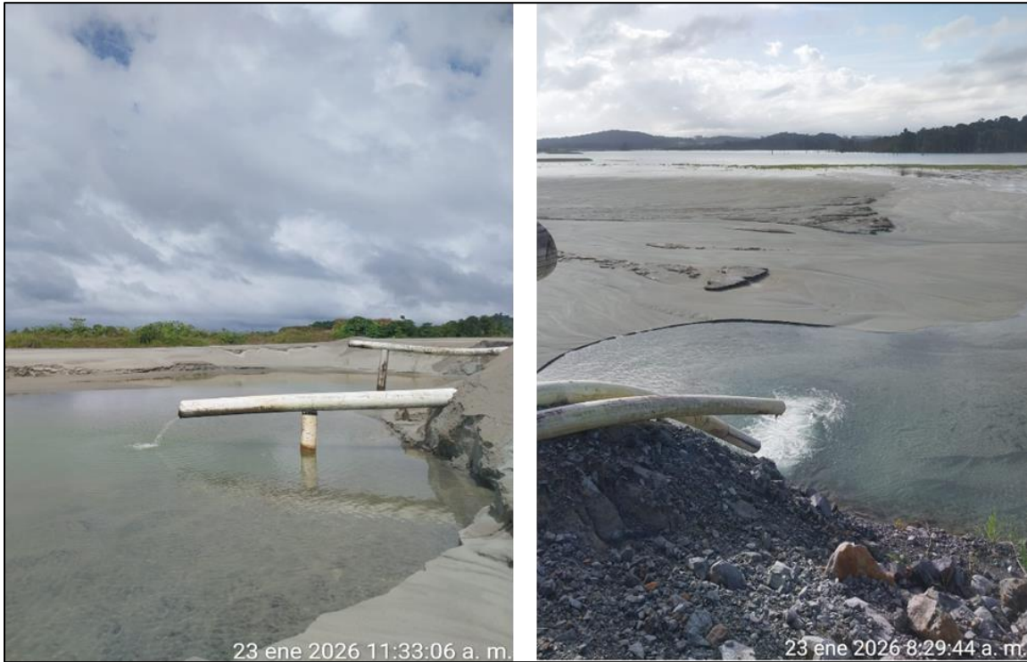
Figura 7 - Inspección de líneas de retorno de SCF04 y SCF06
