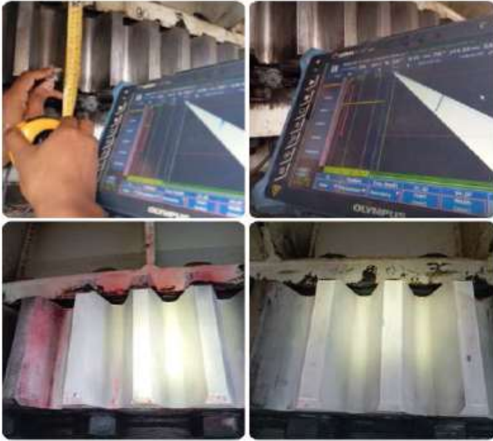
Foto N° 6 – Inspeccion Tornameza Shiploader
