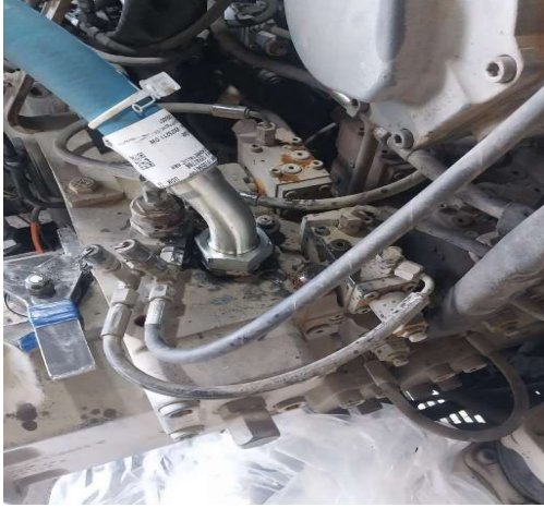
EXL002 – Instalación de líneas hidráulicas Bomba #4
