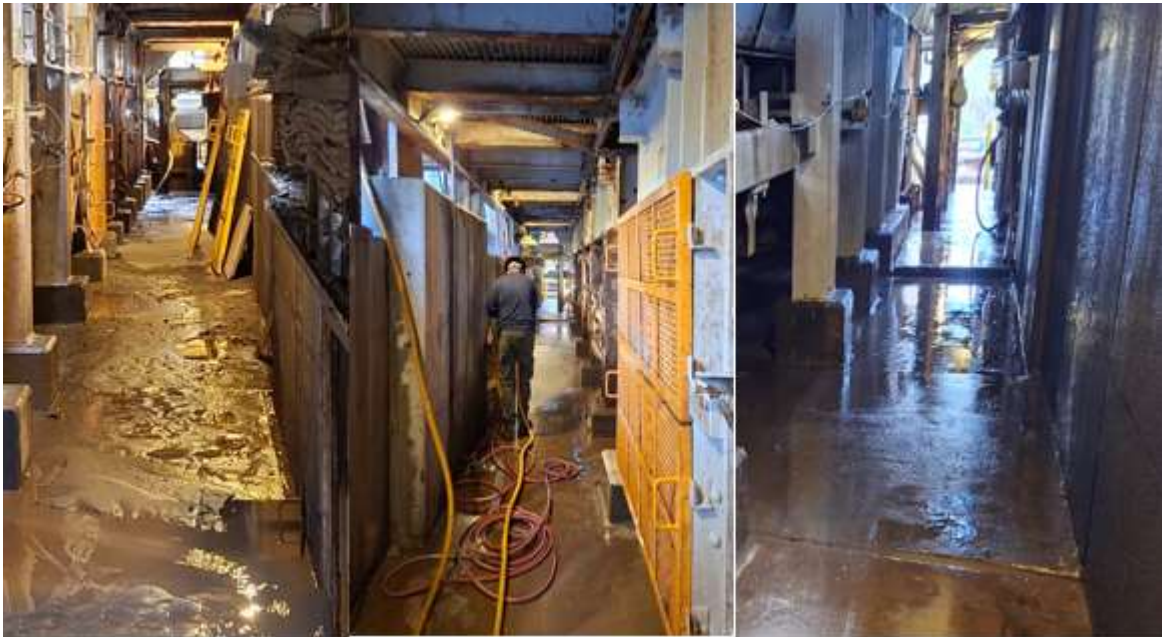
Ilustración 17 Limpieza de piso en edificio de trituración secundaria.
