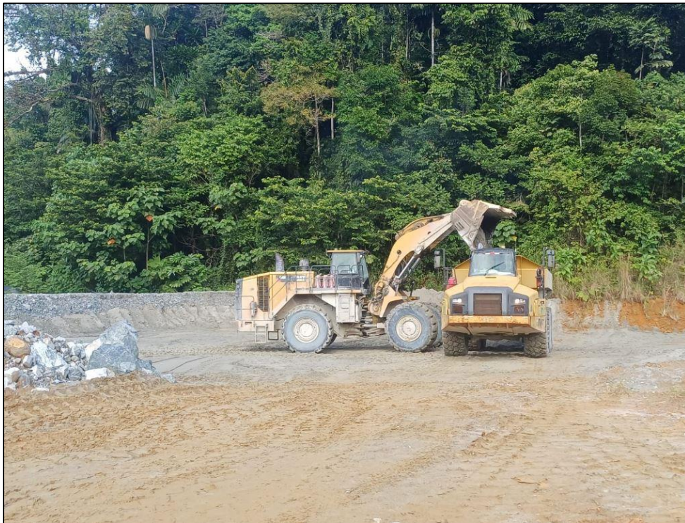
Figura 30 - Limpieza de sedimentos en NDS1, Muro Norte
