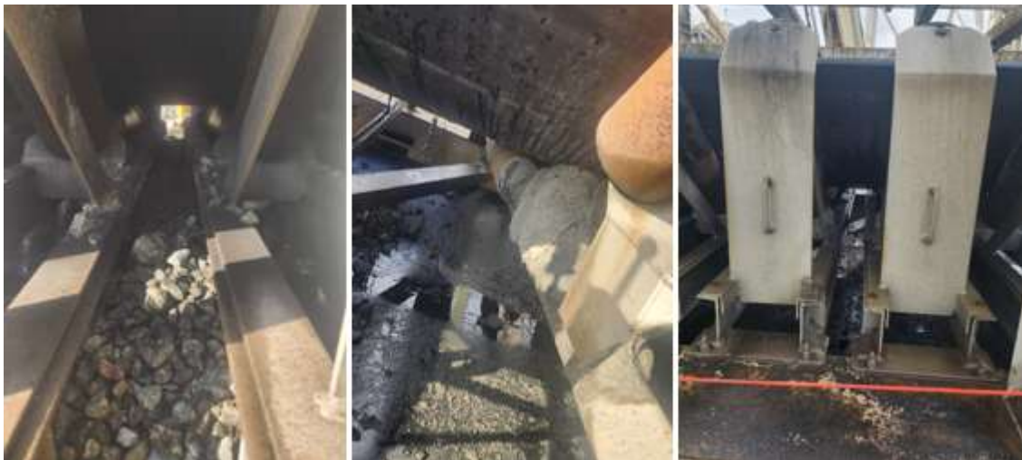
Ilustración 18 Remoción de escombros en estructura de fajas transportadoras (Antes y después).
