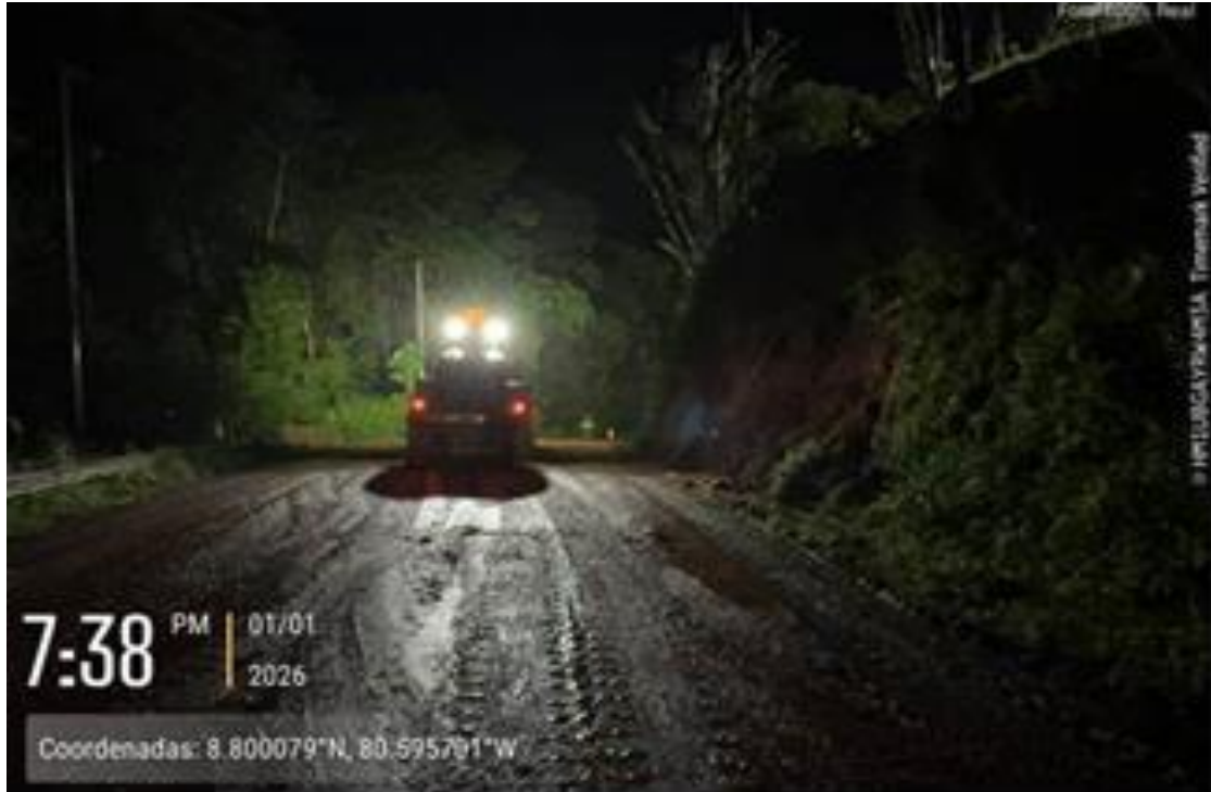
Remocion de material en la via
