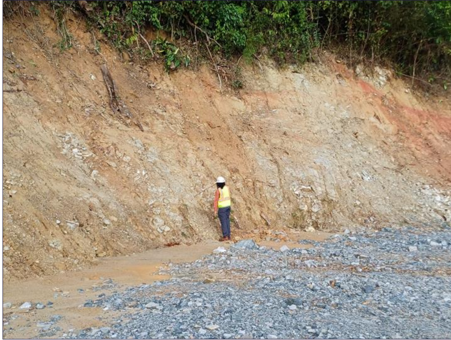
Figura 74 - Material encontrado en limpieza de fundación en taludes, aprobado por el equipo de QAQC
