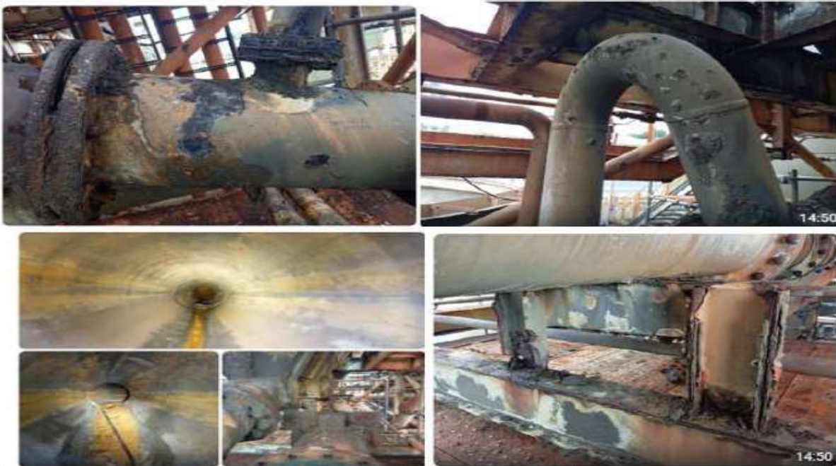
Foto N° 5 – Inspeccion Spool de Espesador
