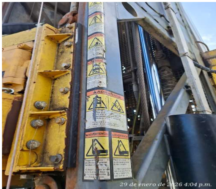
DRE107 – Reemplazo Deslizaderas de Rotaria
