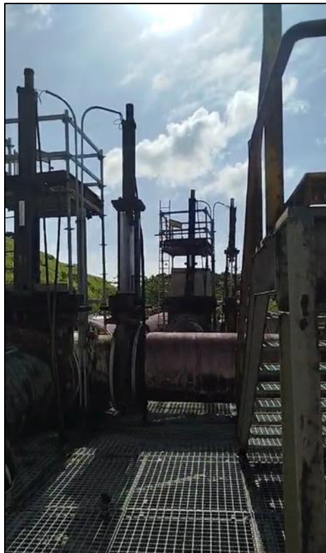
Figura 9 - Inspección de líneas de Relaves HDPE, durante simulacro operativo en estaciones de válvulas, ruta costera y muros de la IMR.
