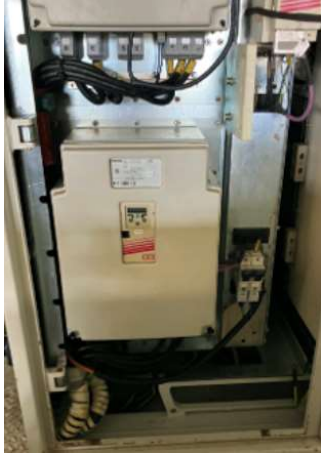
DTU04 – Cambio Variador de Main Blower
