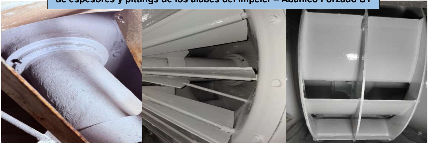
Remoción de corrosión en impeler, eje y dámper de succión, Inspección de espesores y pittings de los alabes del impeler – Abanico Forzado U1
