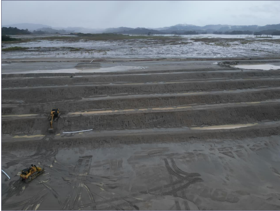
Figura 68 - Erosión Reparada en el Muro norte, Celda 04 Aguas Abajo
