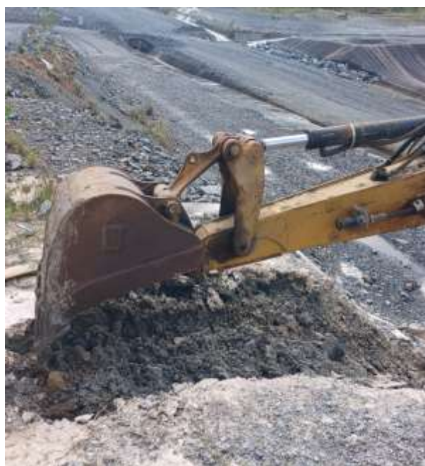
Ilustración 35 Limpieza y adecuación de canaletas de desagüe.
