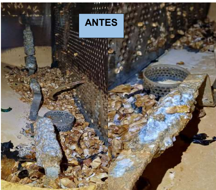
Limpieza Interna – Condesador U1 – Remplazo de los anodos de sacrificio
