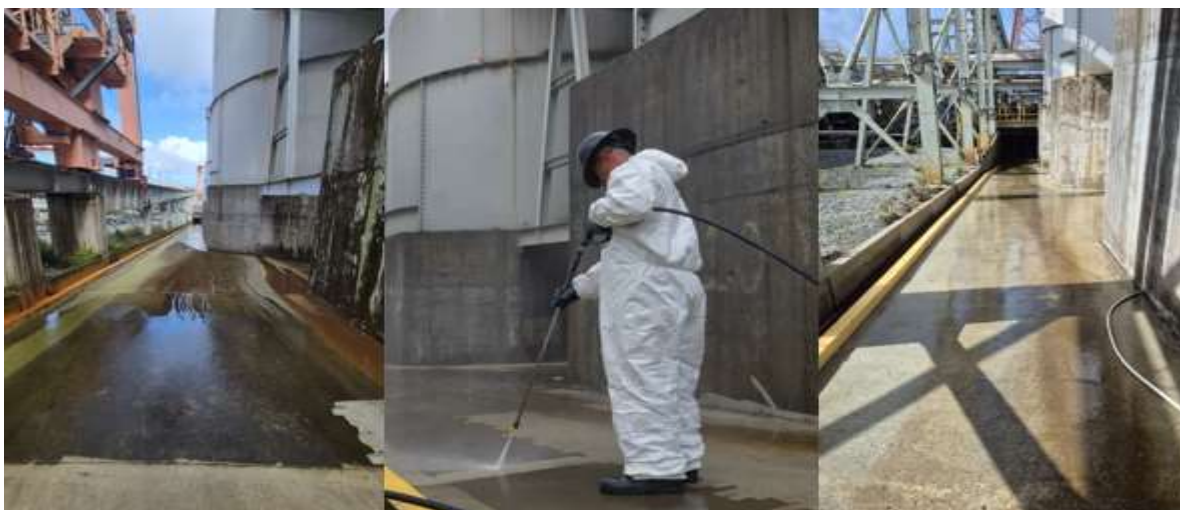
Ilustración 29 Proceso de limpieza de piso (Antes y después).
