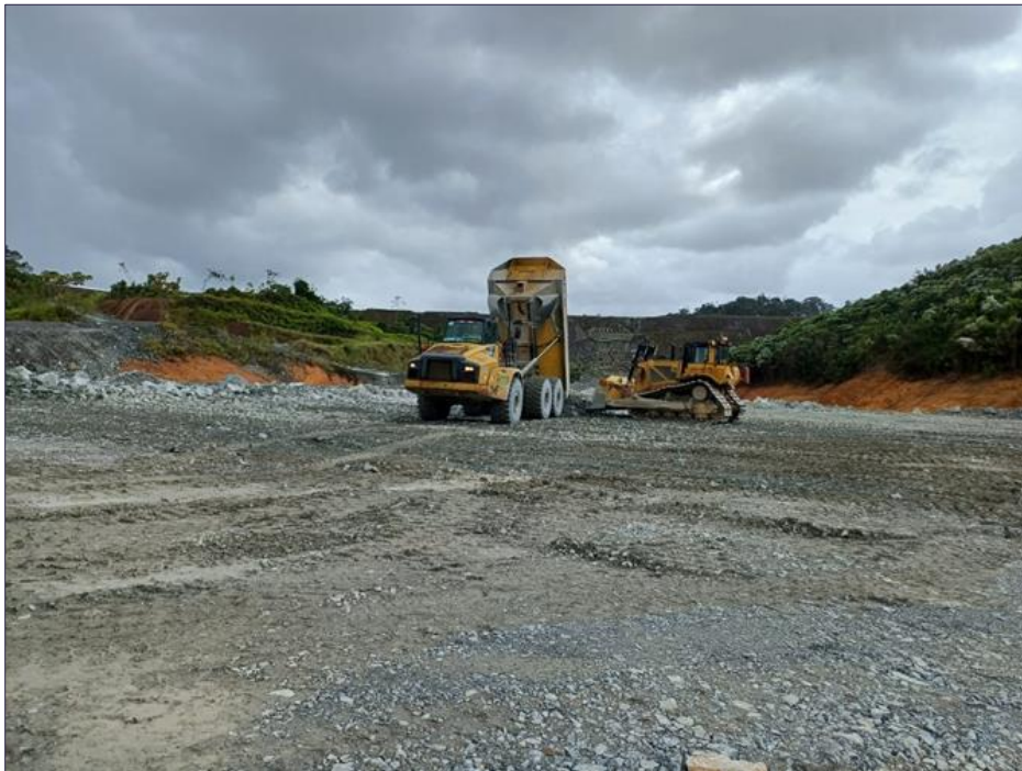
Figura 73 - Trabajos de colocación de Zona 7 en Muro Este (WRP#6)
