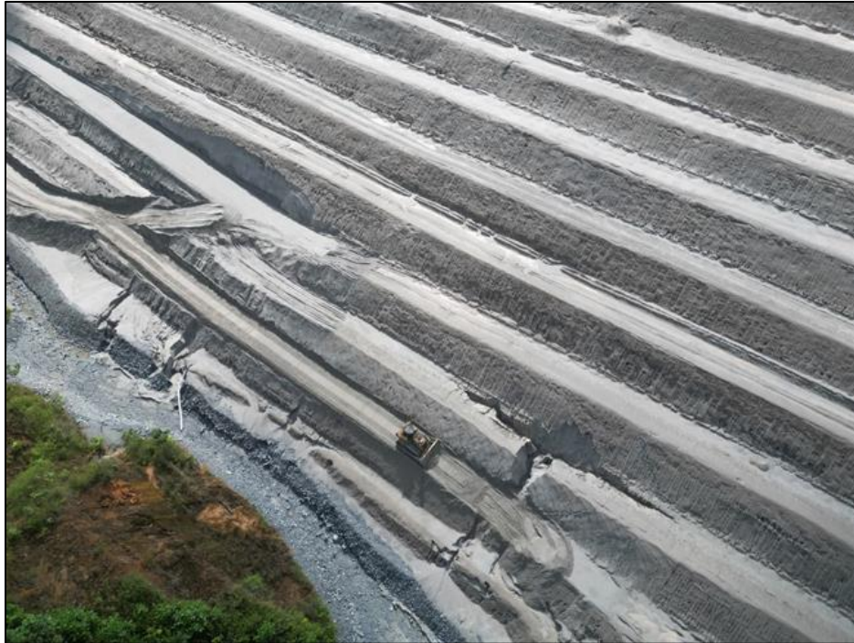
Figura 70 - Erosión reparada Muro Norte, Celda 11
