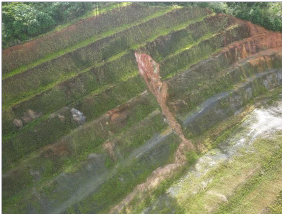
Figura 75 - Erosión en banquetas de canal 6 Muro Este, WRP6
