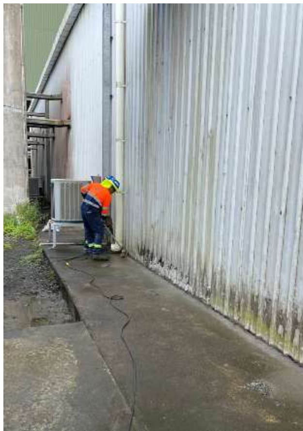
Reparación por filtraciones de agua en la sala eléctrica
