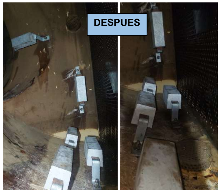
Limpieza Interna – Condesador U1 – Remplazo de los anodos de sacrificio
