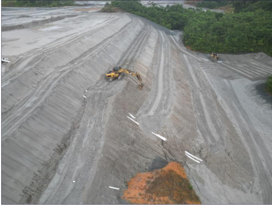
Figura 72 - Reparación de erosiones en banquetas de las celdas 27 a 31 en Muro Este
