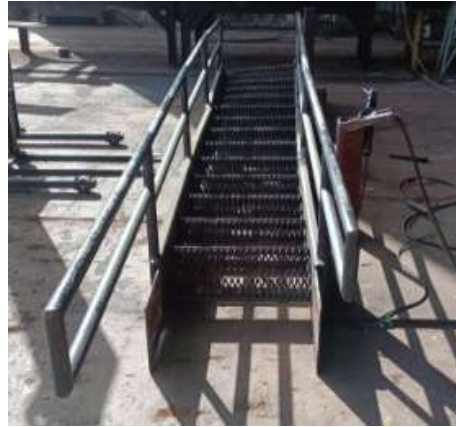
SHE01 – reparación de Escalera Principal
