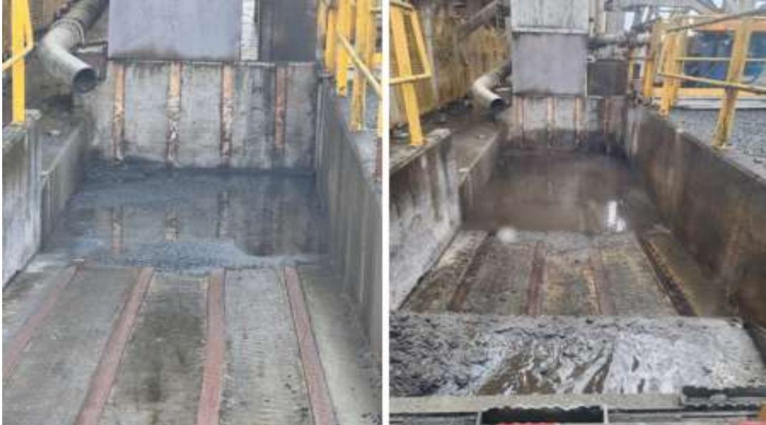
Ilustración 21 Limpieza de zona de sumidero (Antes y después).
