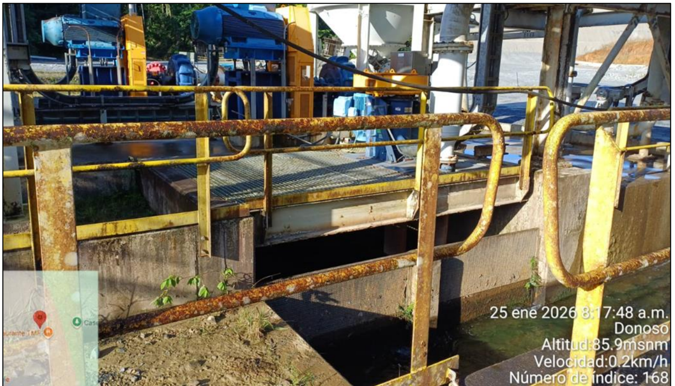
Figura 5 - Inspección de canchales de Estaciones Recolectoras de Filtraciones
