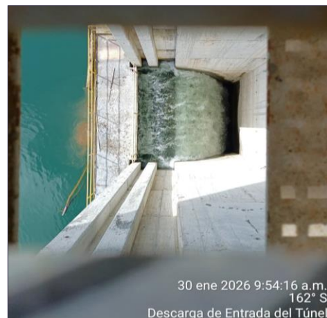
Figura 67 - No se observan obstrucciones en la entrada de la torre de aliviadero
