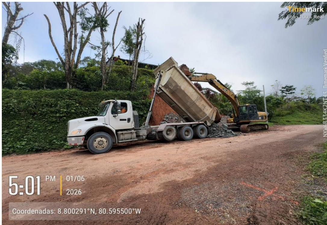
Inicio de los trabajos
