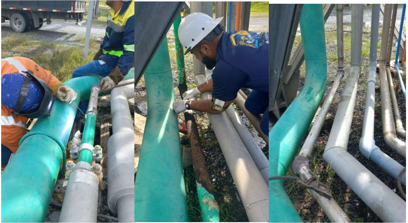
Reparacion linea de Descarga BOP
