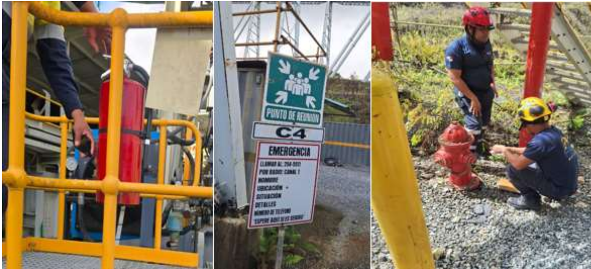
Ilustración 8 Inspección extintor, hidrante y punto de encuentro.
