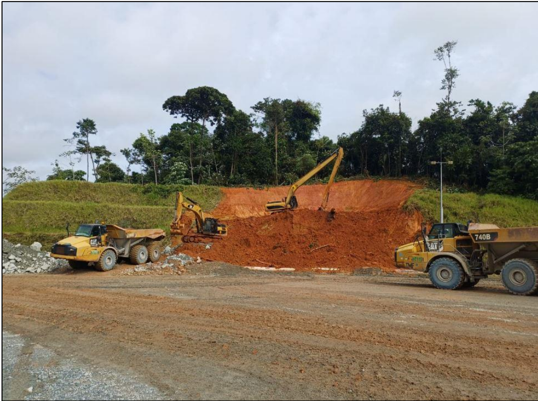
Figura 27 - Limpieza de sedimentos en Planta de Emulsión
