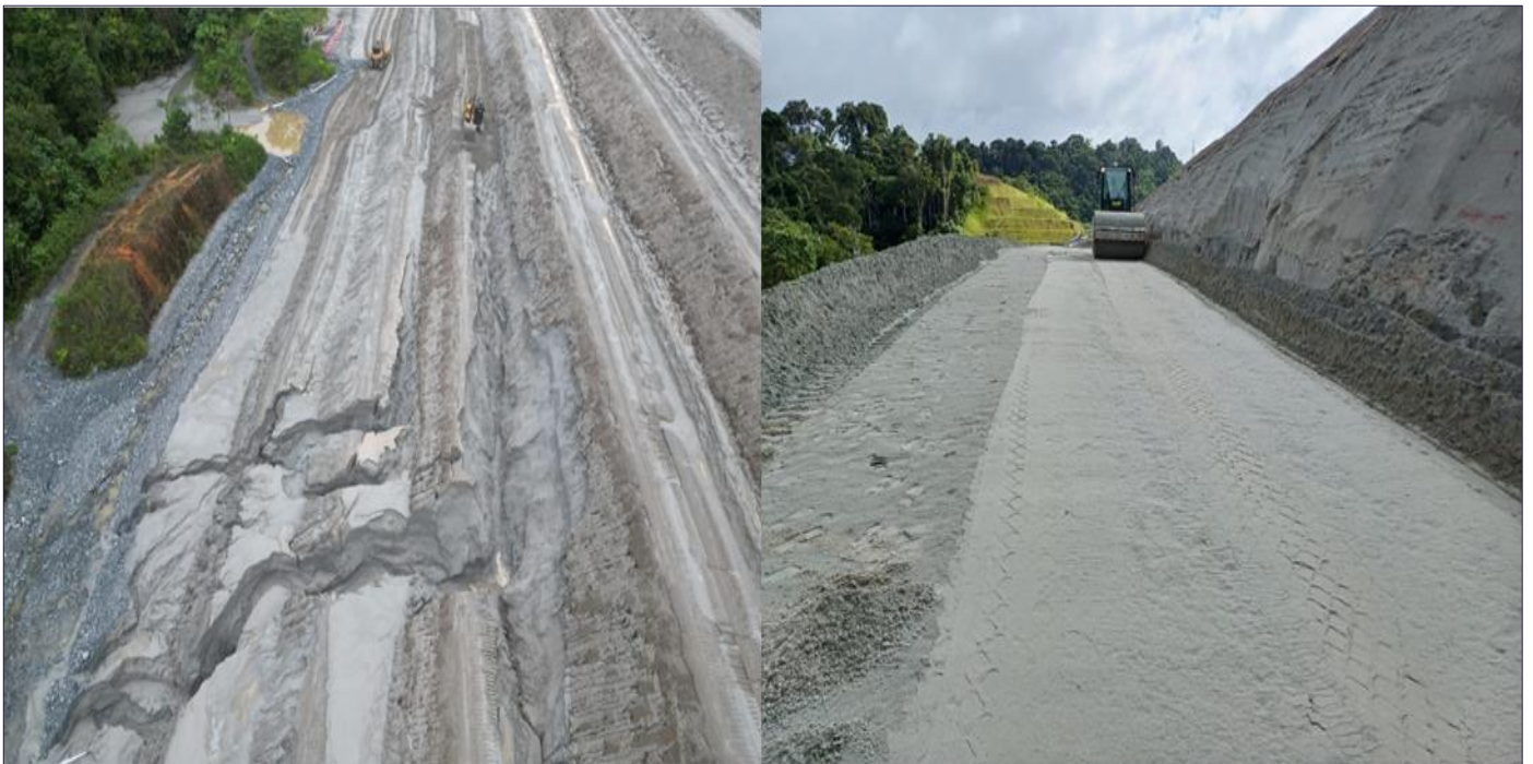
Figura 69 - Reparación de erosión en Muro Norte, Celda 09/10 Aguas Abajo
