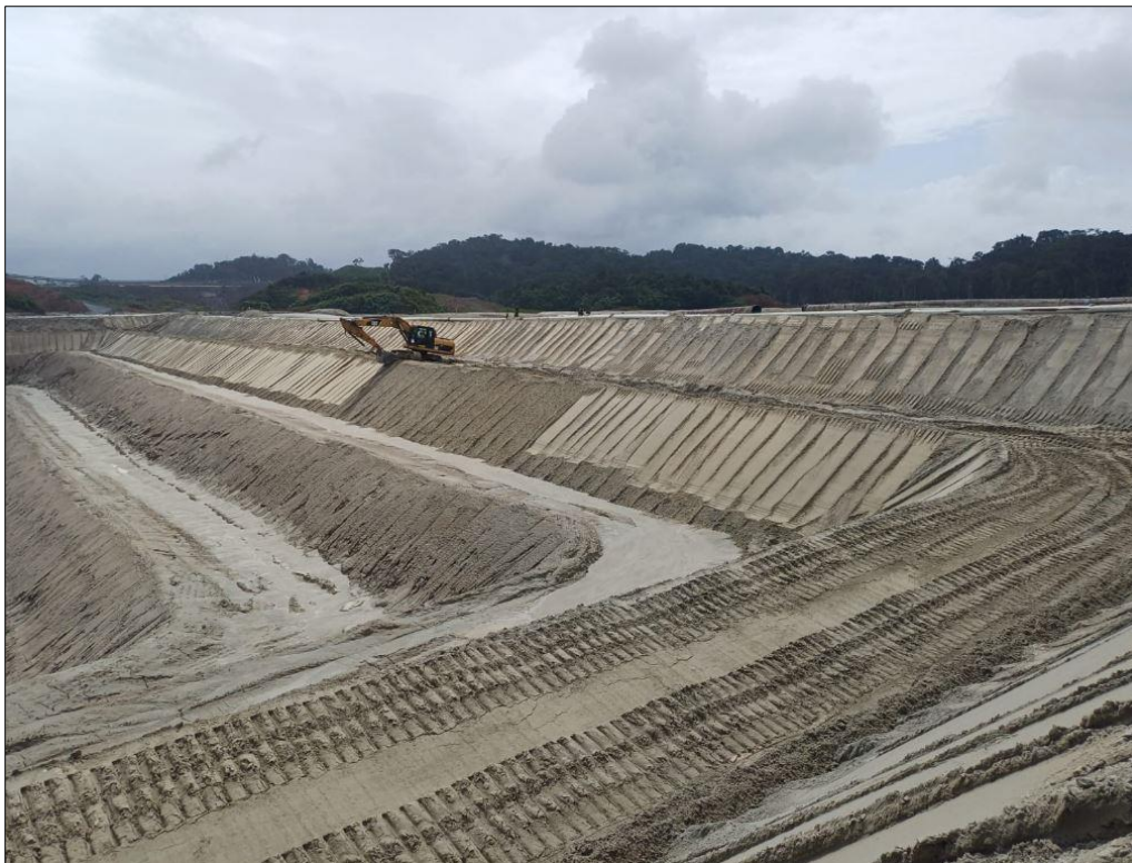
Figura 26 - Mantenimiento de banquetas en WRP05, Muro Este
