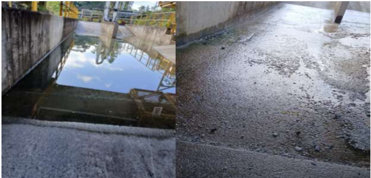
Ilustración 26 Limpieza de canaletas y área gris (Antes y después).
