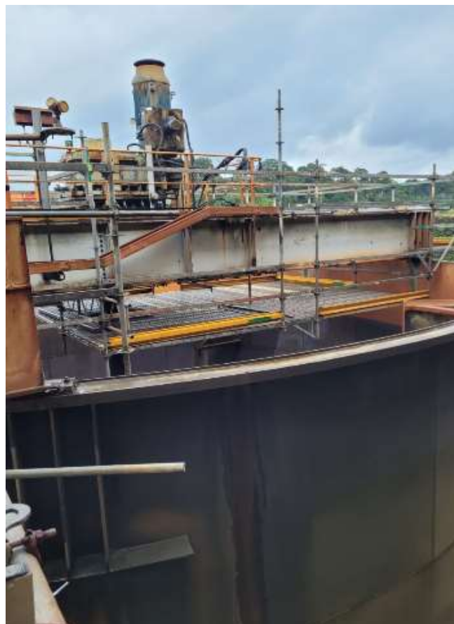
Colocación de andamios para cambios de tuberías y reparaciones tanque de Alimentación
