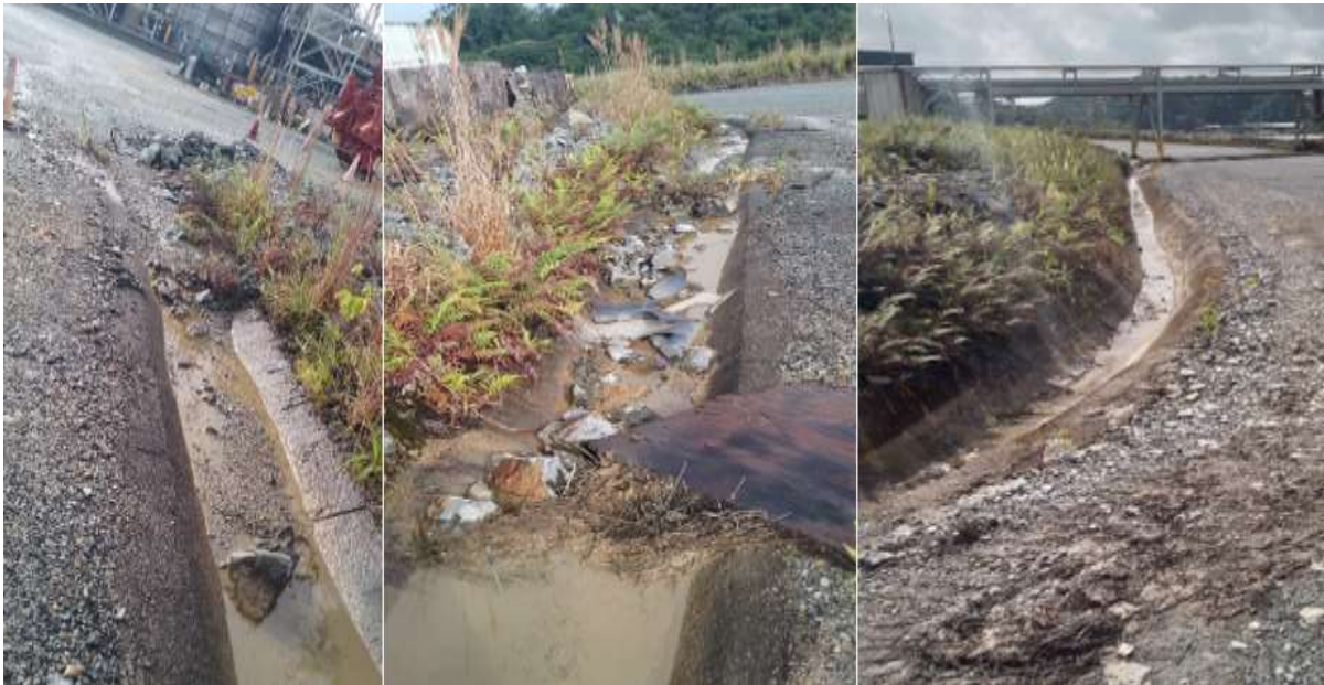
Ilustración 33 Limpieza de sedimentos en canaletas (Antes y después).
