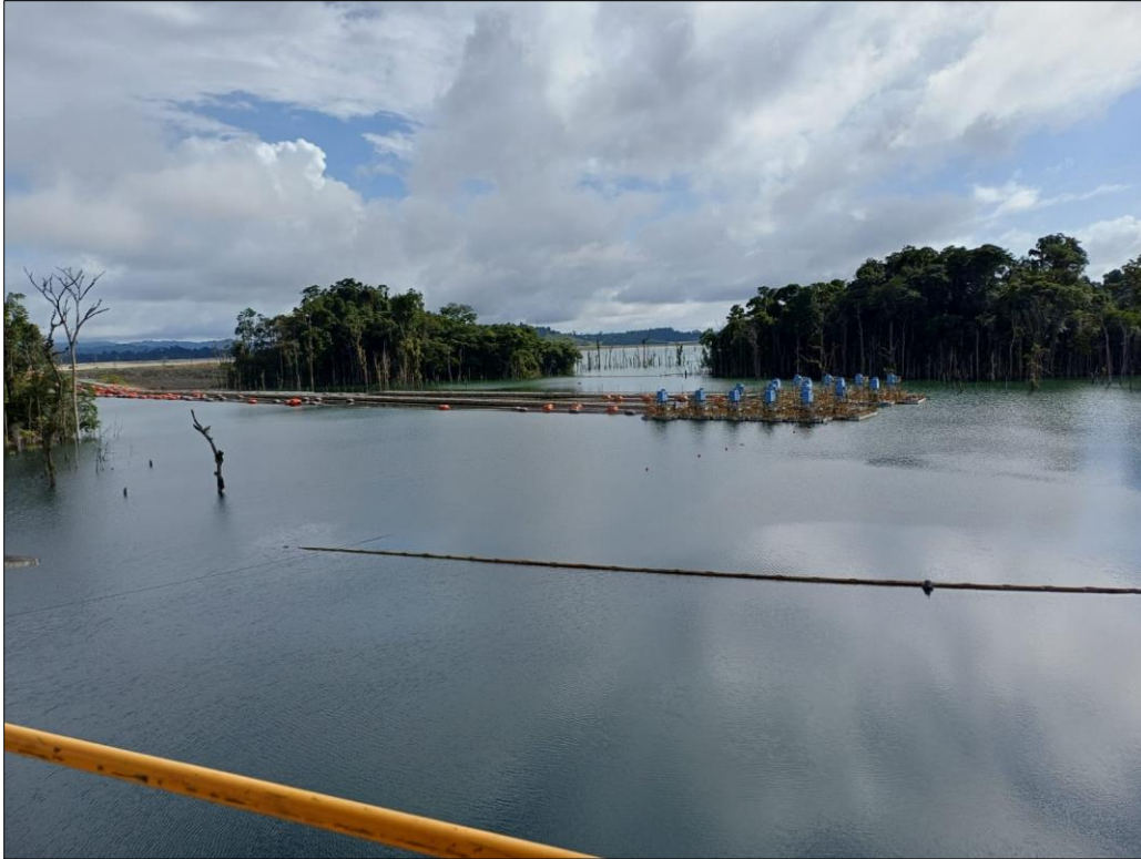
Figura 64 -Vista general. No se observan cambios en el estanque con respecto al último informe
