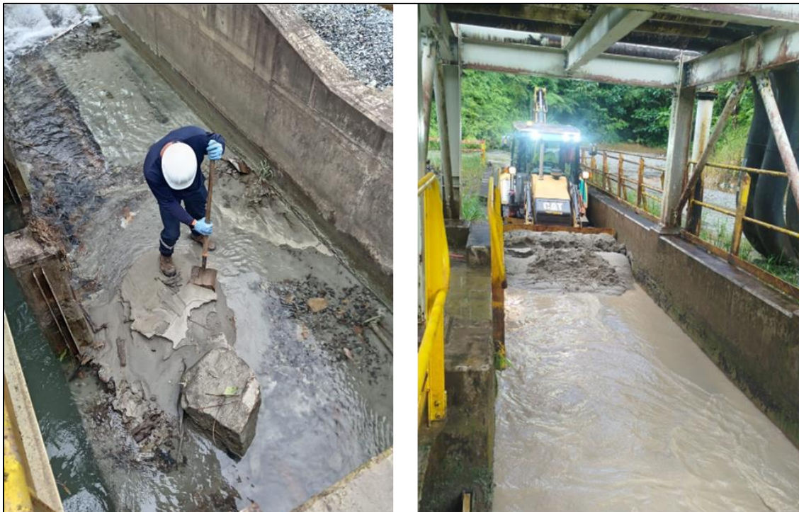
Figura 5 - Inspección de canaletas de Estaciones Recolectoras de Filtraciones
