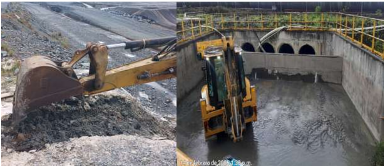
Ilustración 39 Limpieza y adecuación de canaletas de desagüe.
