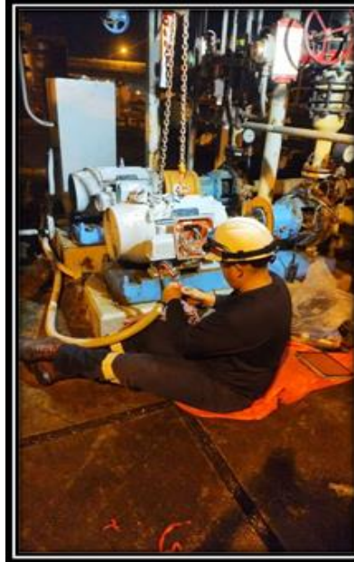
Bomba de alimentación del sistema de filtrado – Cambio de Rodamiento
