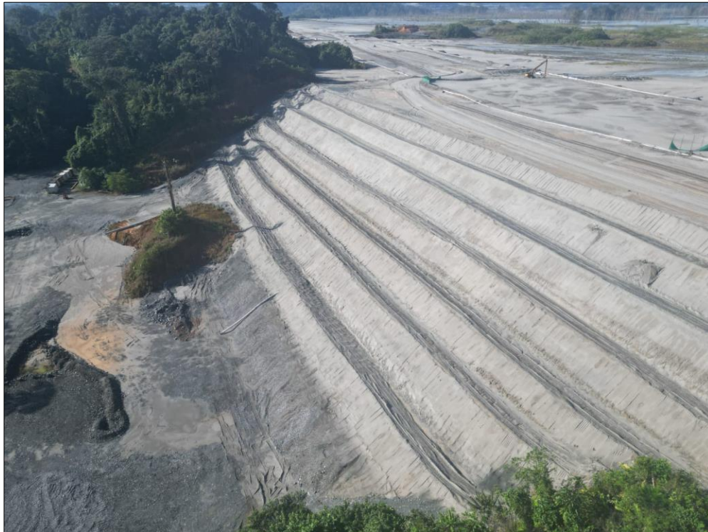
Figura 71 - Reparación de erosiones Muro Este, Celda 39/40
