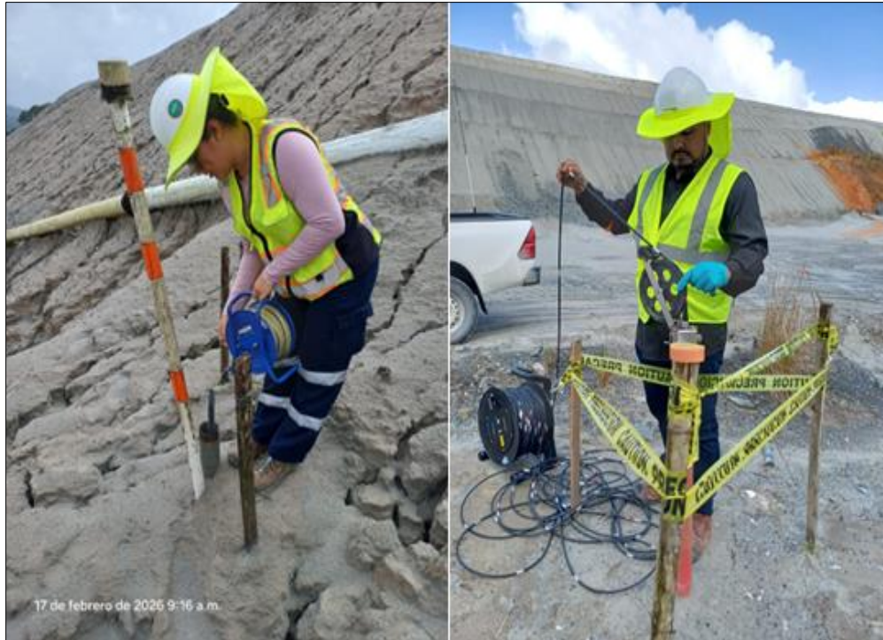
Figura 76 - Lectura de instrumentación geotécnica (Casagrande e inclinómetro)
