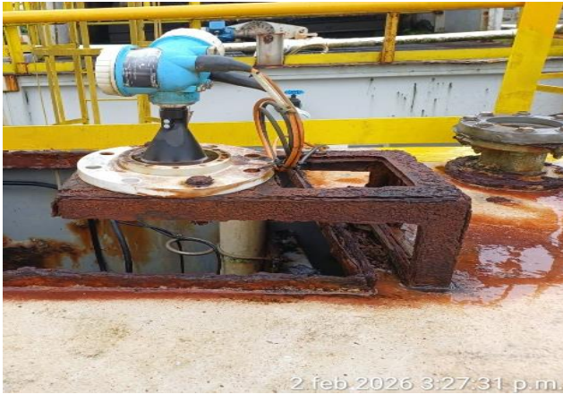
Cambio de soportería de bandejas eléctricas/ corrosión
