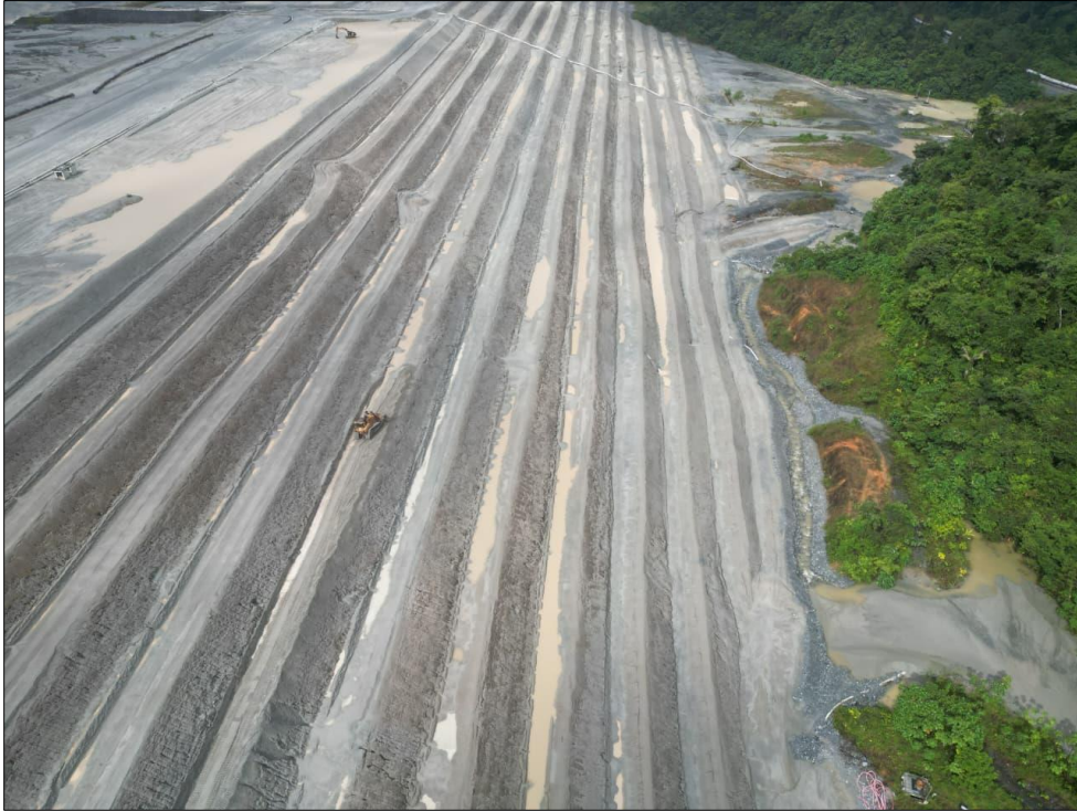
Figura 70 - Erosión reparada Muro Norte, Celda 15
