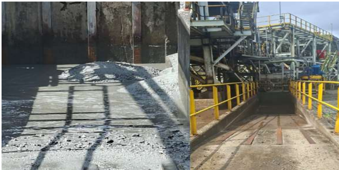
Ilustración 23 Limpieza de zona de sumidero (antes y después).
