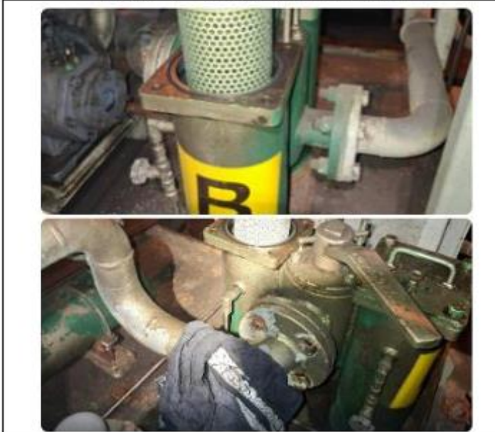
Foto N° 5 – Reemplazo Filtro Aceite Pulverizador 2C
