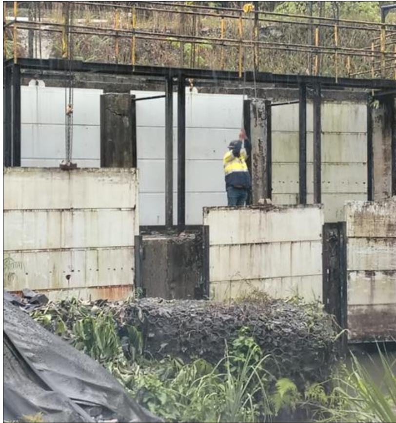
Figura 3 - Inspección de funcionalidad de Compuerta PB05/09
