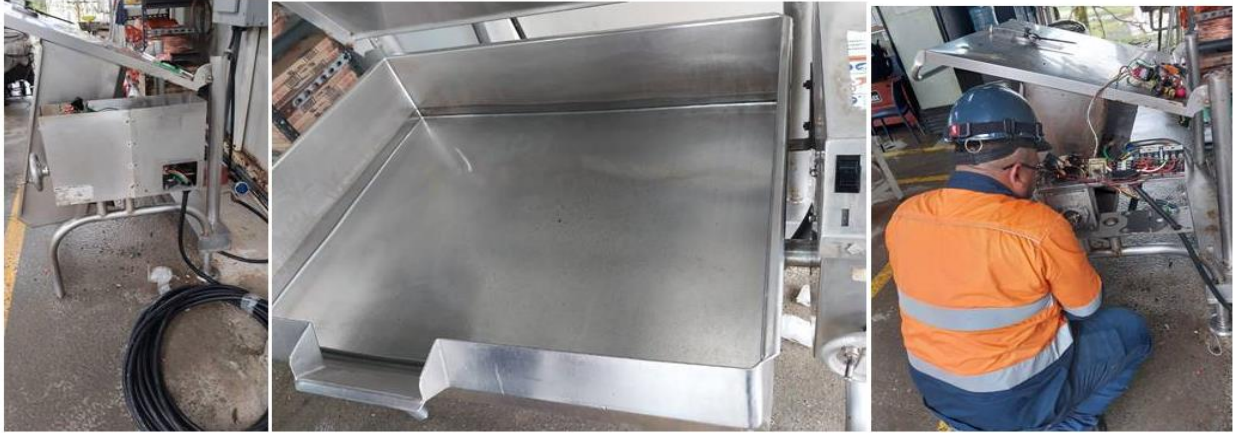
Revisión y reparación de basculantes
