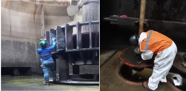
Reparación de estator.
