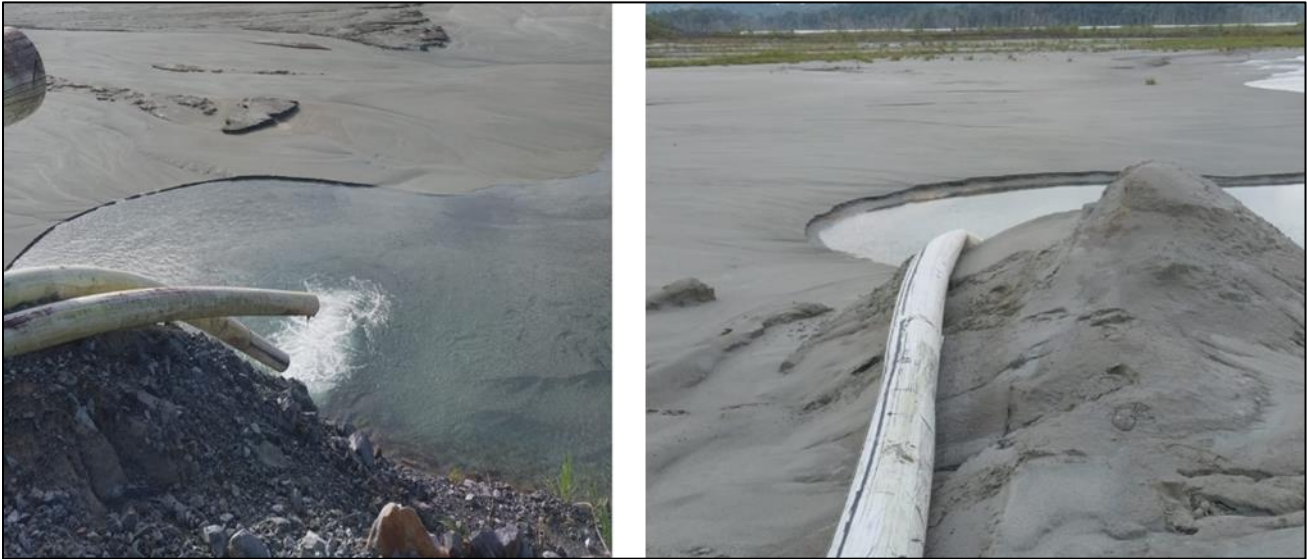
Figura 6 - Inspección de líneas de retorno de SCF02 y SCF03
