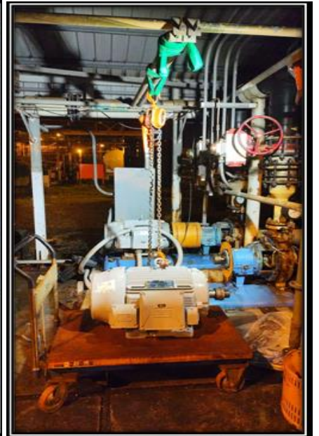
Bomba de alimentación del sistema de filtrado – Cambio de Rodamiento
