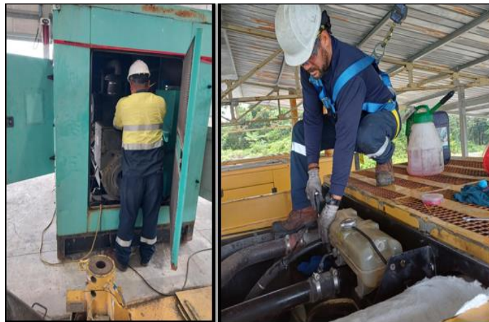
Mantenimiento preventivo flota generadores
