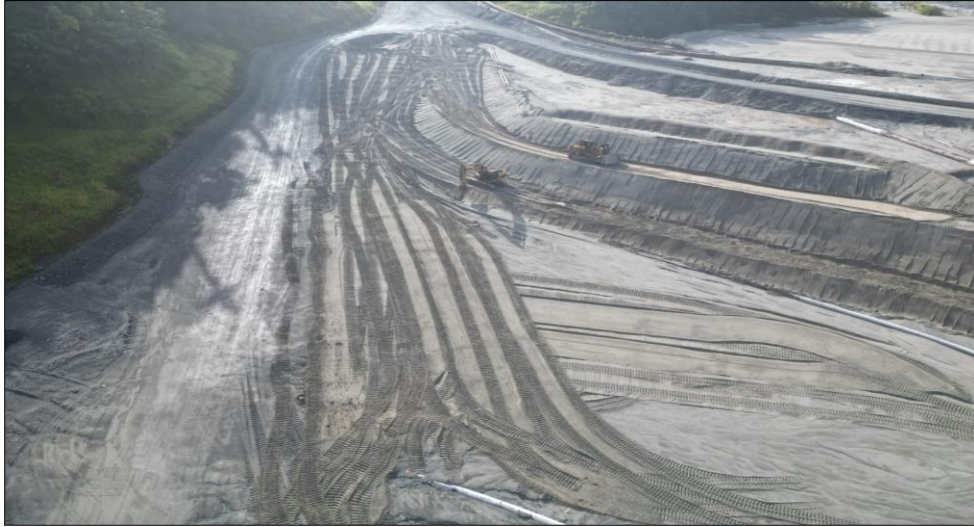
Figura 67 - Erosión Reparada en el Muro norte, Celda 03 Aguas Abajo
