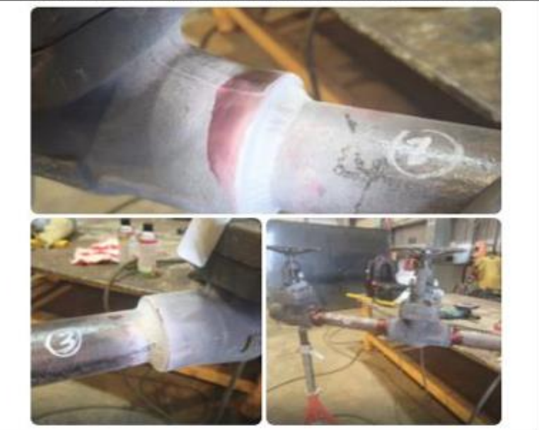
Foto N° 6 – Inspeccion visual y Tintes penetrantes en soldadura de valvulas
