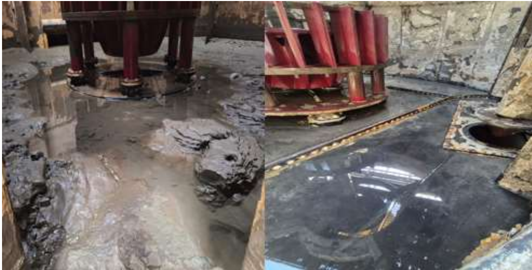
Ilustración 32 Limpieza interna de celdas (antes y después).
