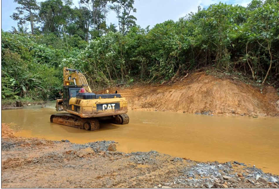
Figura 72 - Trabajos de limpieza de fundación sumergida en Muro Este (WRP#6)
