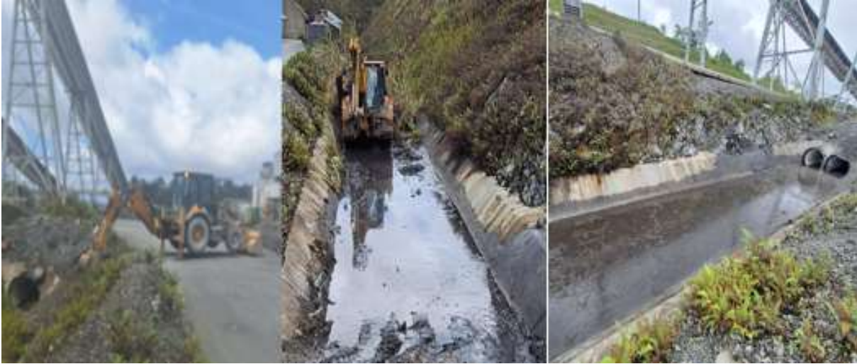
Ilustración 36 Limpieza de canaletas de desagüe.
