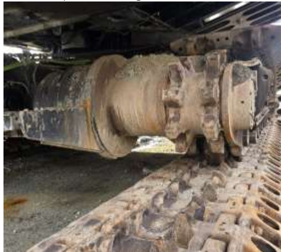
SHE01. Reparación de grieta en bastidor
