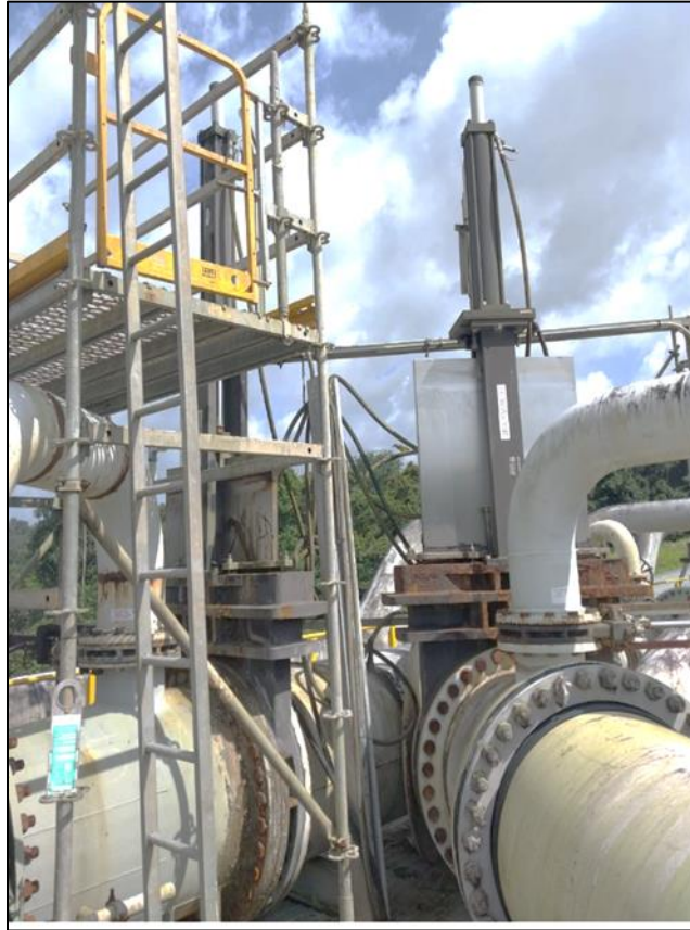
Figura 8 - Inspección de líneas de Relaves HDPE, en estaciones de válvulas, ruta costera y muros de la IMR.
