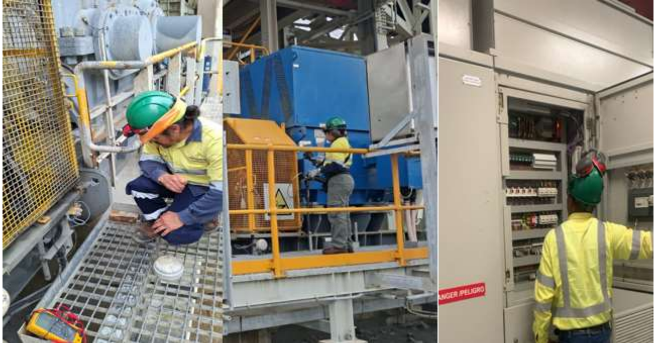
Ilustración 1 Monitoreo de equipos durante simulacro operacional en trituración.
