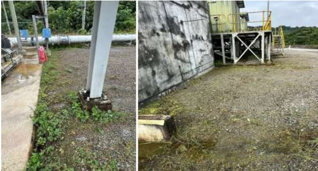
Ilustración 41 Limpieza de área verdes.
