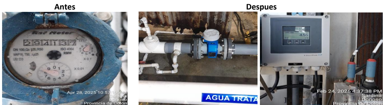
Flushing de línea de At de ingreso a módulos de campamento
