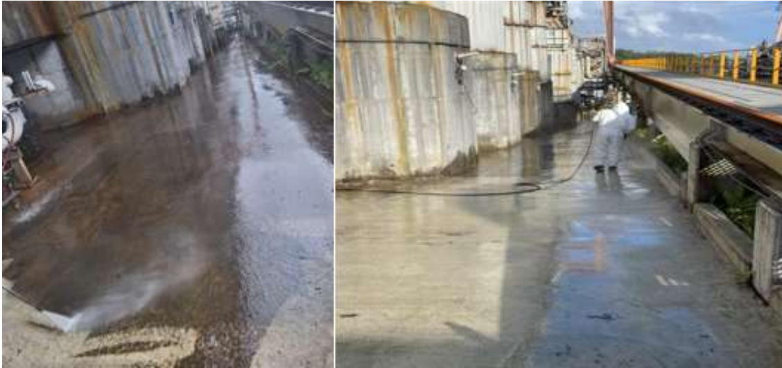
Ilustración 34 Proceso de limpieza de piso (antes y después).
