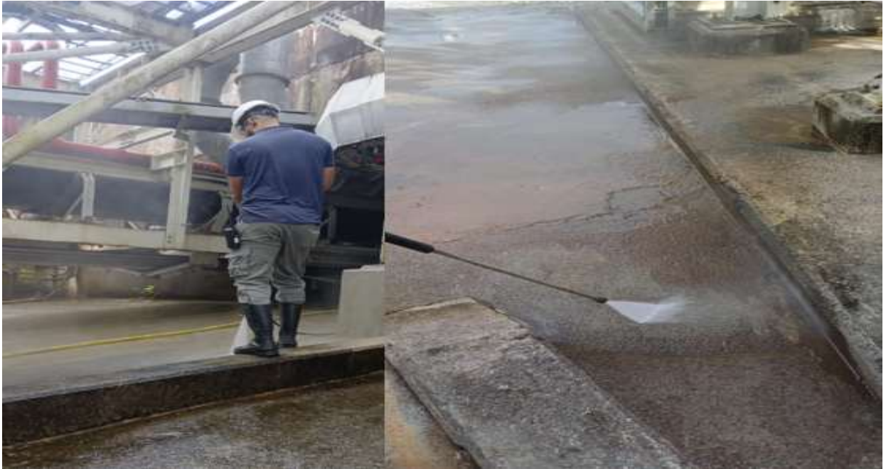
Ilustración 28 Limpieza de pisos con limos en área de túneles.
