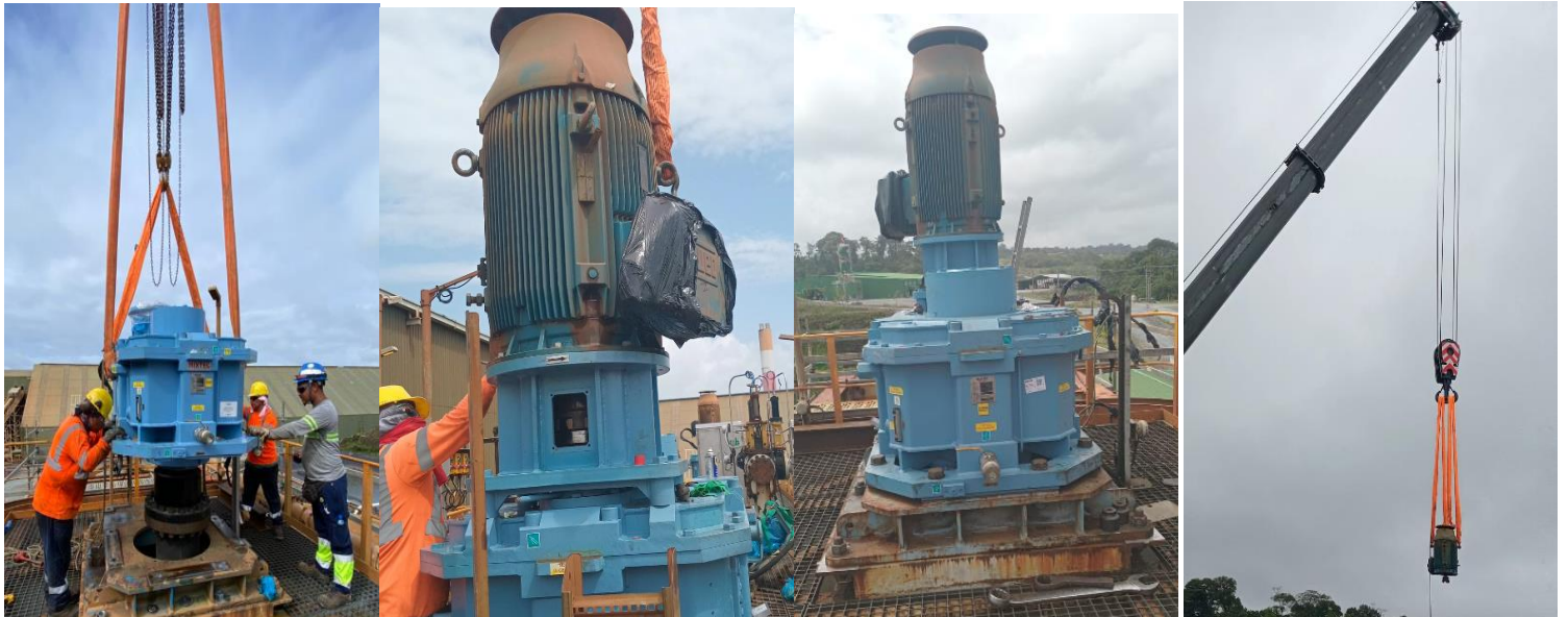
Trabajos en Agitador del tanque de Filtración 712-AG-9001
