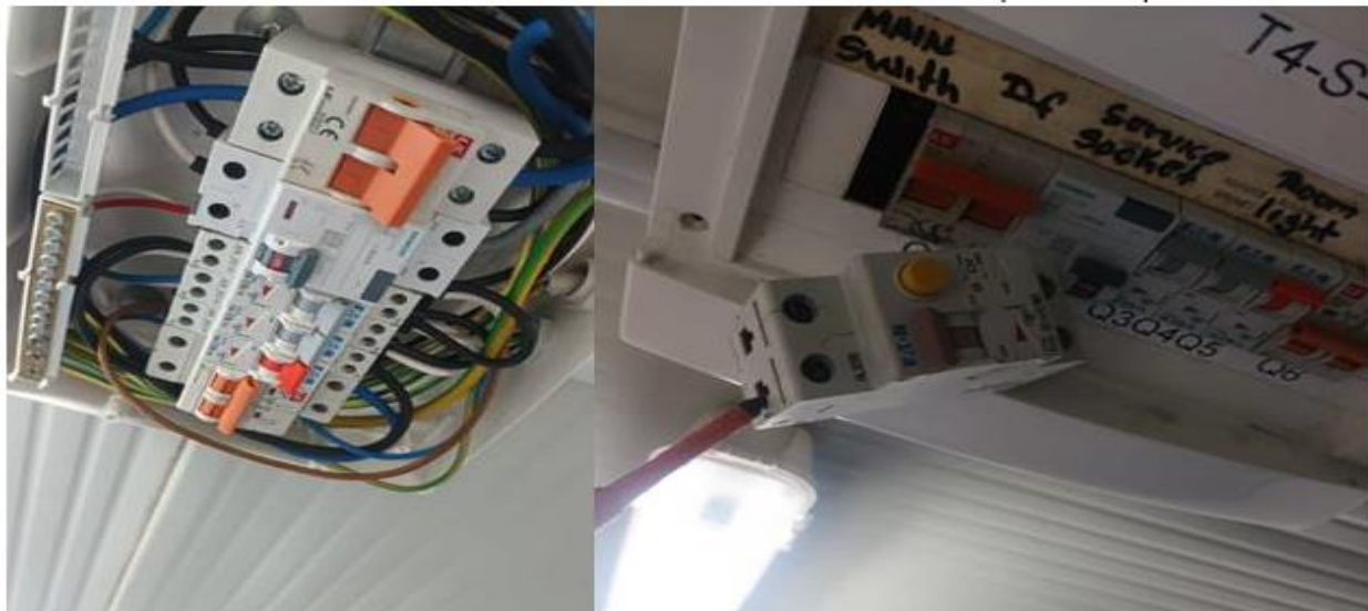
Reemplazo de Breaker diferencial en tablero eléctrico de habitación de T4-S
