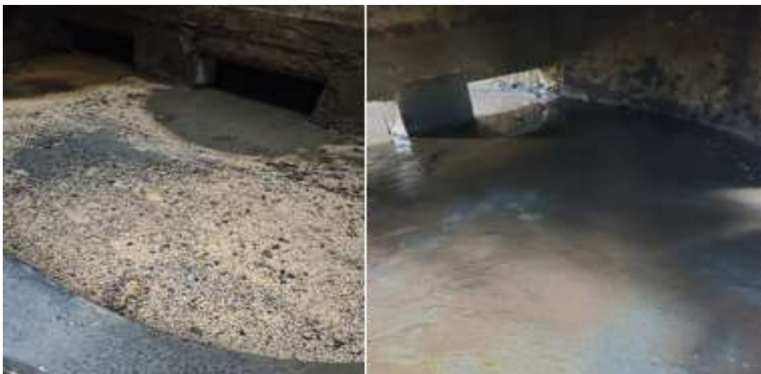
Ilustración 33 Limpieza de cajones en primera limpieza (antes y después).
