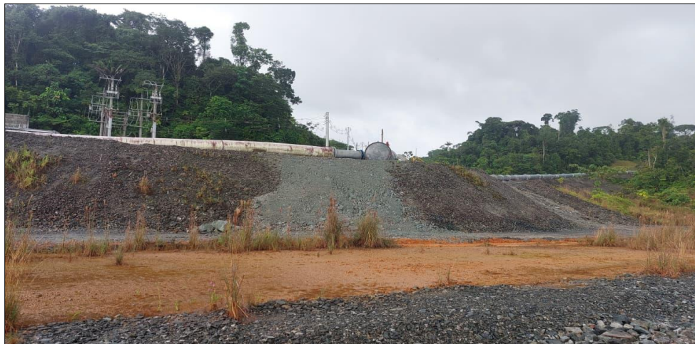
Figura 68 - Reparación de erosión en Muro Norte Cofferdam Sector 4
