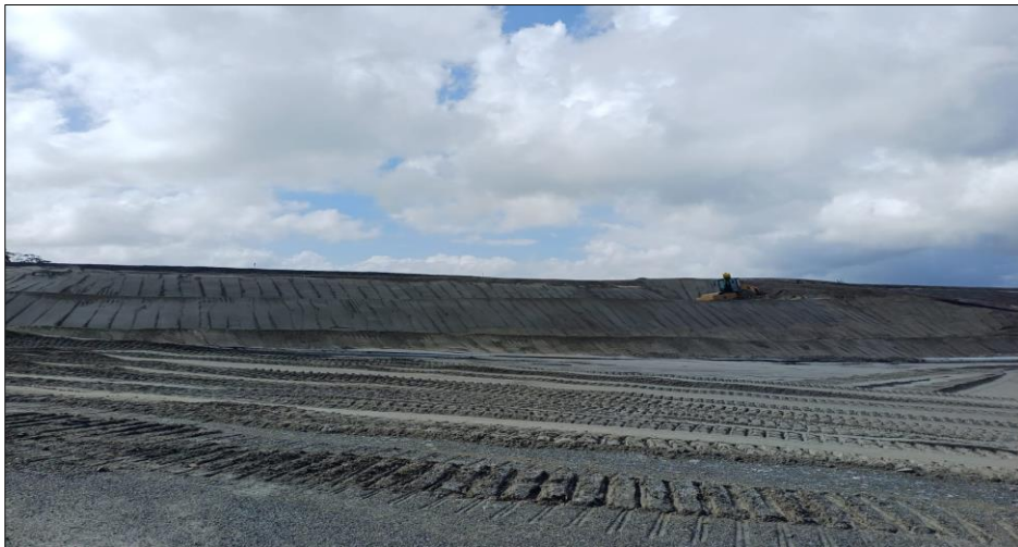
Figura 69 - Reparación de erosión en Muro Norte, Celda 03 Aguas Abajo
