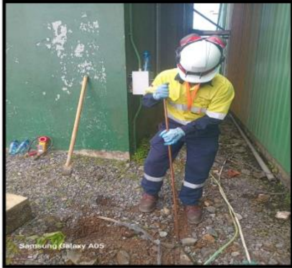
Reparacion de Puesta a tierra
