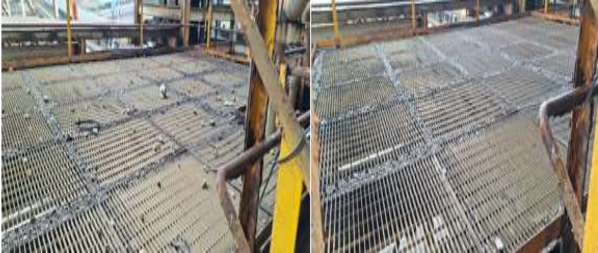
Ilustración 22 Limpieza y remoción de rocas en estructuras.
