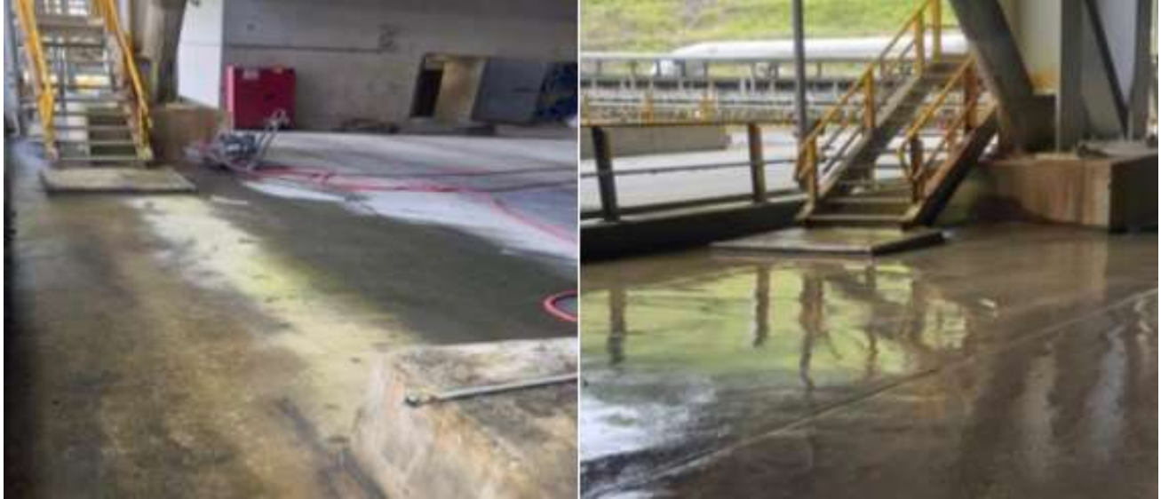
Ilustración 30 Limpieza de piso en área de bombas.
