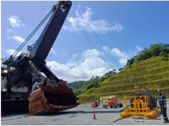
SHE05. Desmontaje e instalación de rueda idler posterior LH y Cables de Levante
