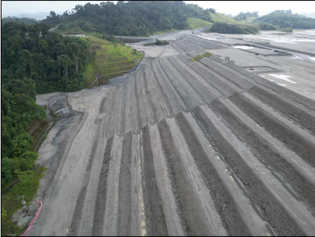
Figura 24 - Mantenimiento de banquetas en Sector 1, Muro Norte
