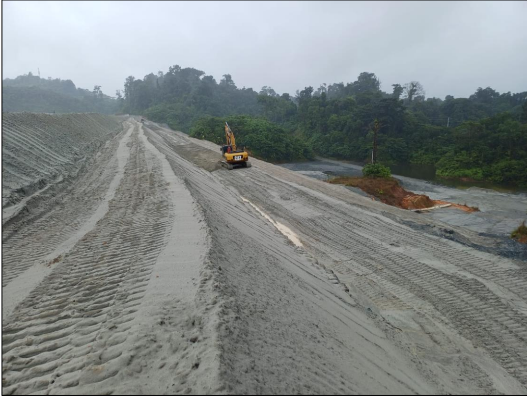
Figura 28 - Mantenimiento de banquetas en WRP01, Muro Este
