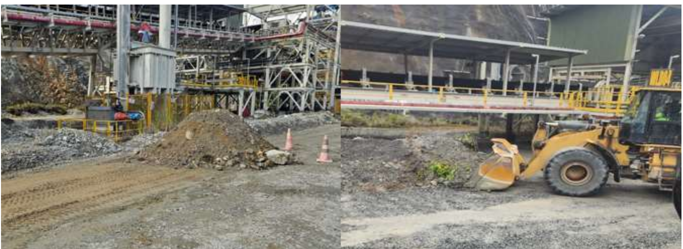
Ilustración 21 Remoción de sedimentos en parte baja de trituración.
