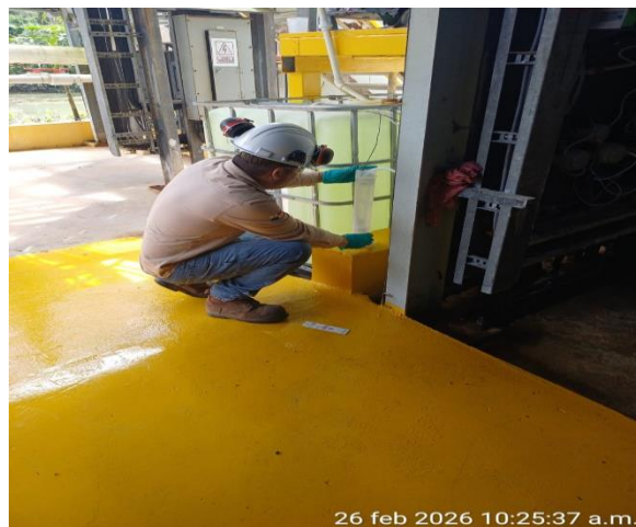
Cambio de bomba dosificadora de cloro PRISMA por deterioro
