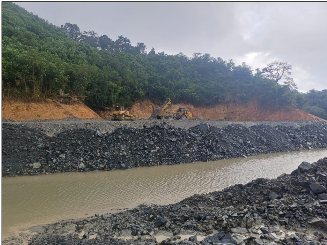
Figura 27 - Enrocado con Z7 NAG en WRP06, Muro Este
