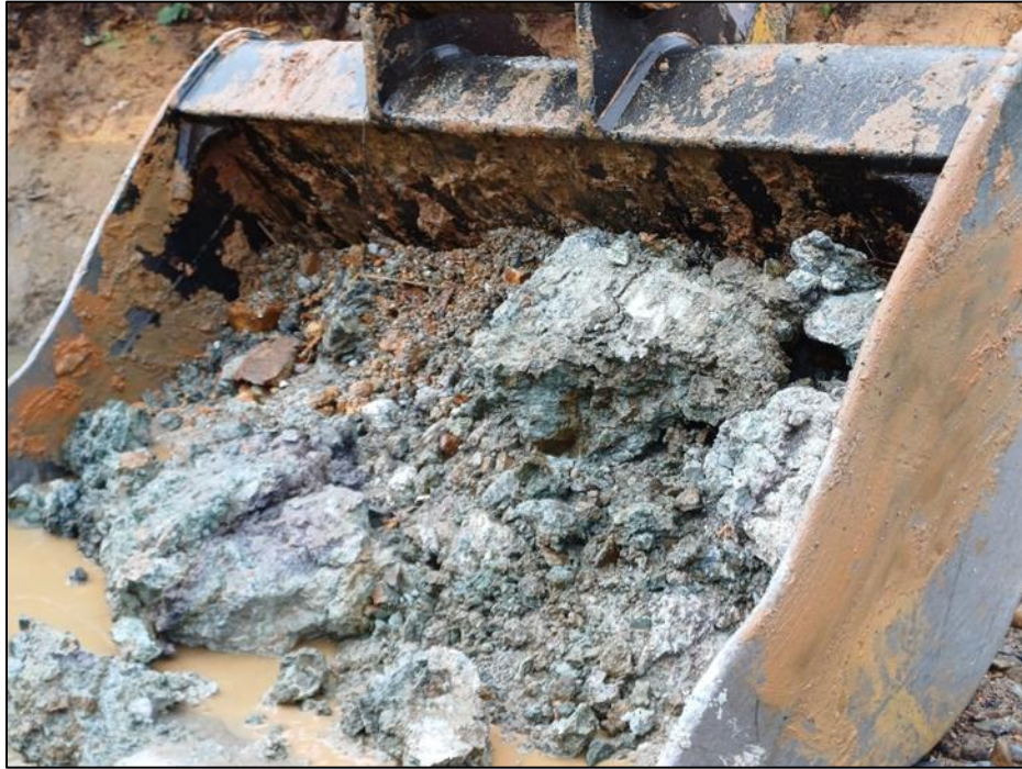
Figura 73 - Material encontrado en limpieza de fundación sumergida, aprobado por el equipo de QAQC.
