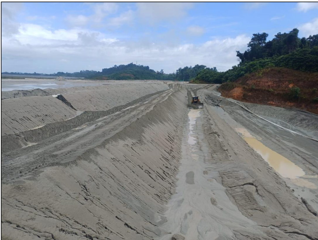
Figura 29 - Mantenimiento de banquetas en WRP02, Muro Este
