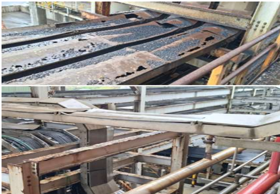
Ilustración 20 Limpieza de estructuras en edificio de trituración secundaria.
