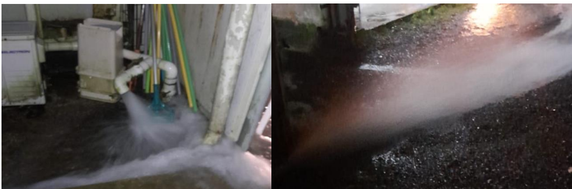
Reparación de liqueo de agua tratada en línea de salida hacia campamento, trabajo en conjunto con departamento facilidades
