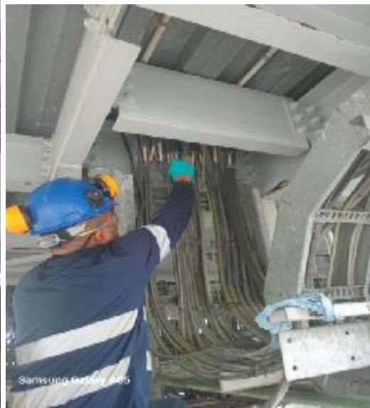
Aplicación de Pintura corta Fuego en la GIS
