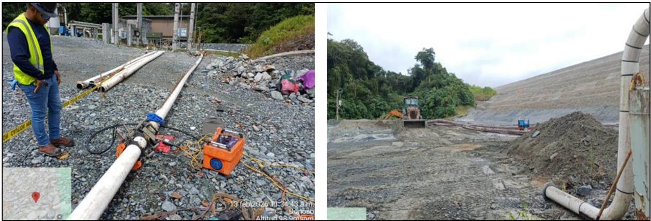
Figura 7 - Reubicación de tuberías de descarga de arena y tuberías de relaves para reparación de erosiones.
