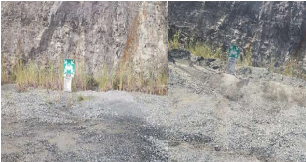
Ilustración 9 Adecuación de terreno de punto de encuentro (antes y después).
