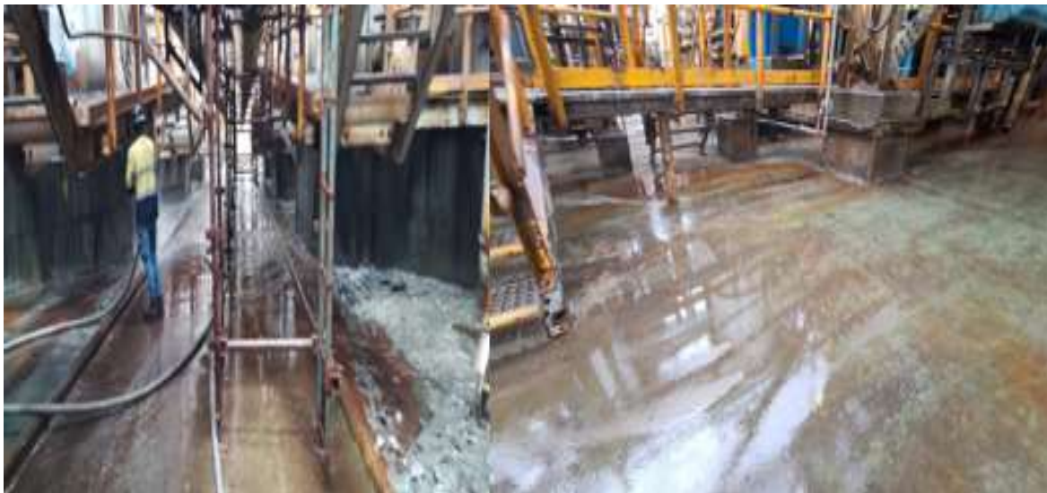
Ilustración 35 Limpieza de sedimentos en área de primera limpieza (antes y después).
