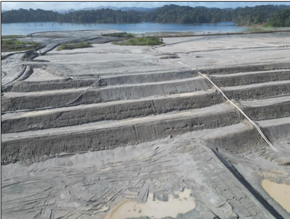
Figura 71 - Reparación de erosiones Muro Norte, Celda 24
