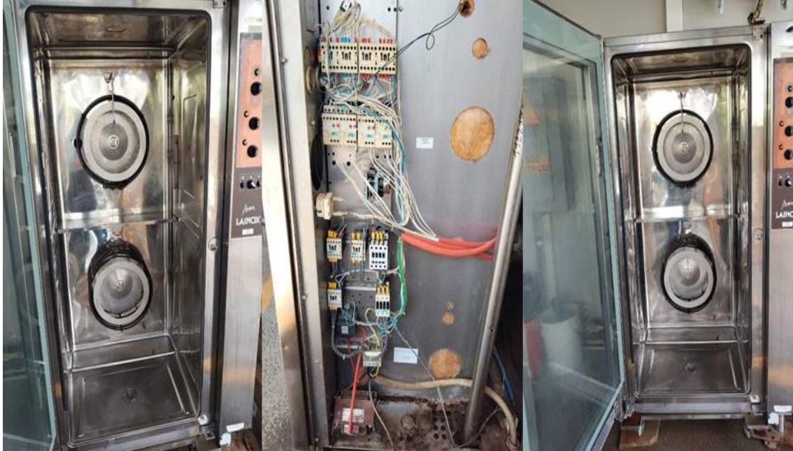
Mantenimiento a Hornos de Panadería
