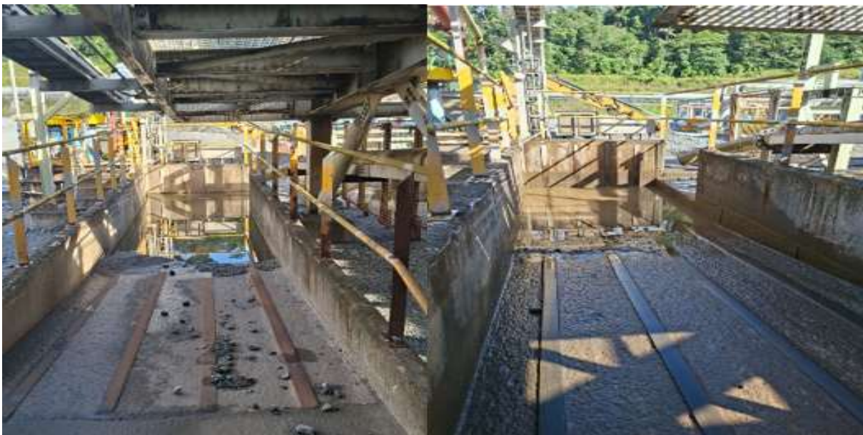
Ilustración 17 Limpieza de zona de sumidero (antes y después).
