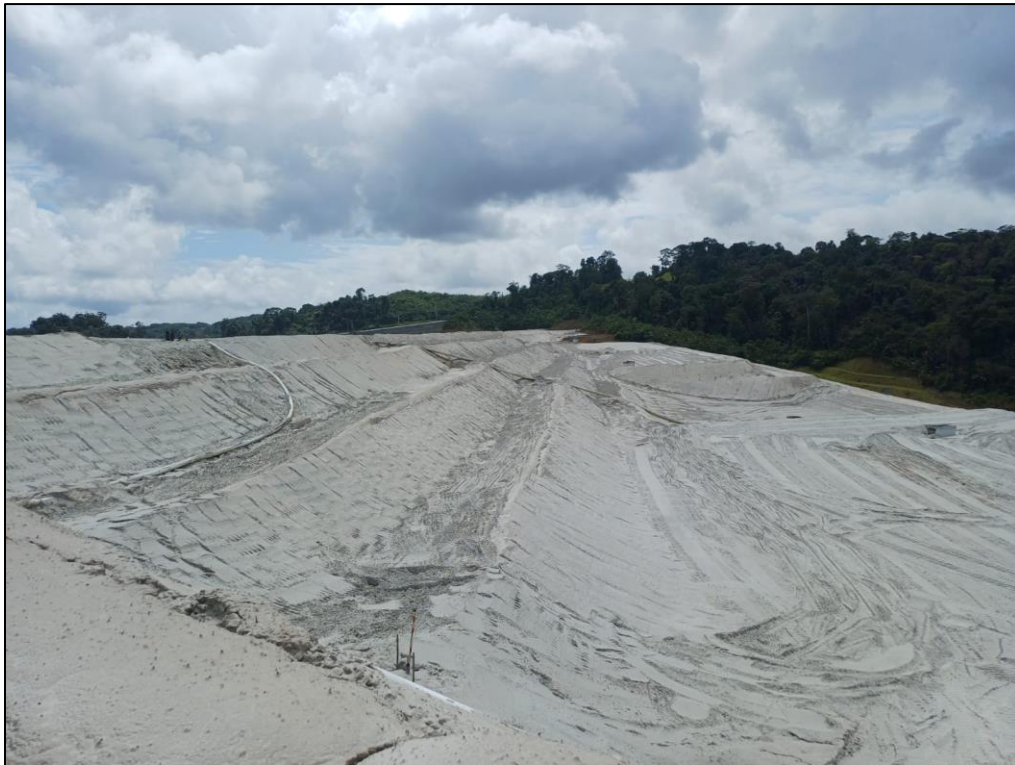
Figura 26 - Mantenimiento de banquetas NDS4, Muro Norte
