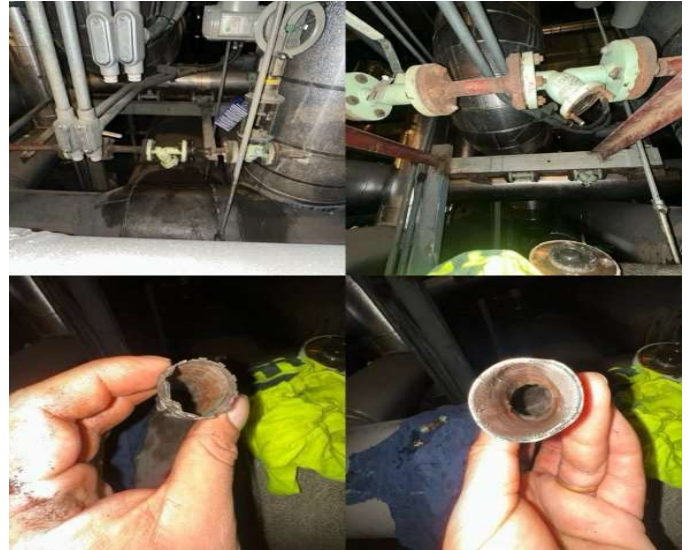
Limpeza del filtro de temperación de válvulas
