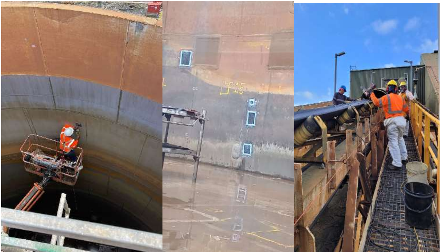
Reparación Tanque 9001 / Cambios de tornillería de bastidores de conveyor 9001
