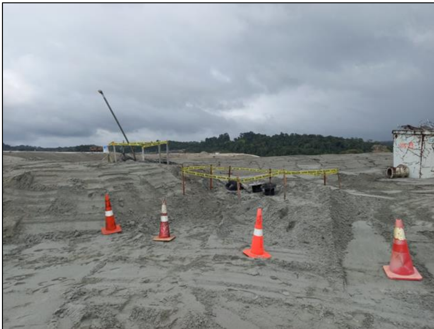
Figura 75 - Reubicación de instrumentación geotécnica - Celda 19 Muro Norte
