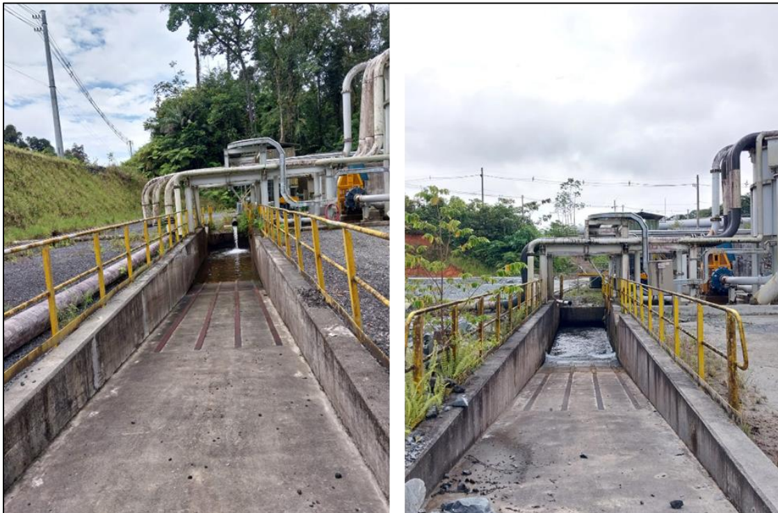
Figura 5 - Inspección de canales de Estaciones Recolectoras de Filtraciones
