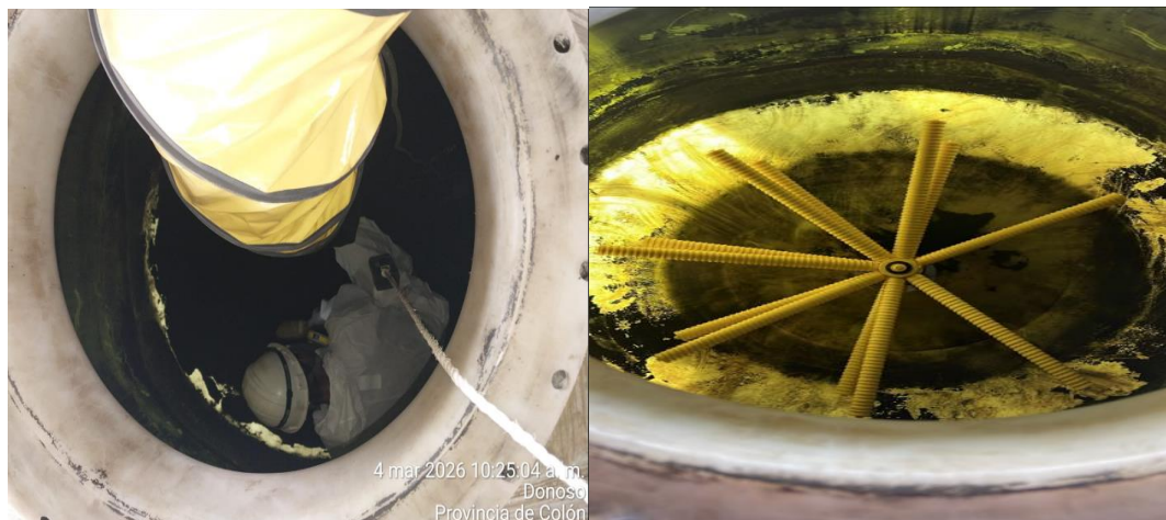
Limpieza y vaciado de filtros de carbón WTP MSA.
