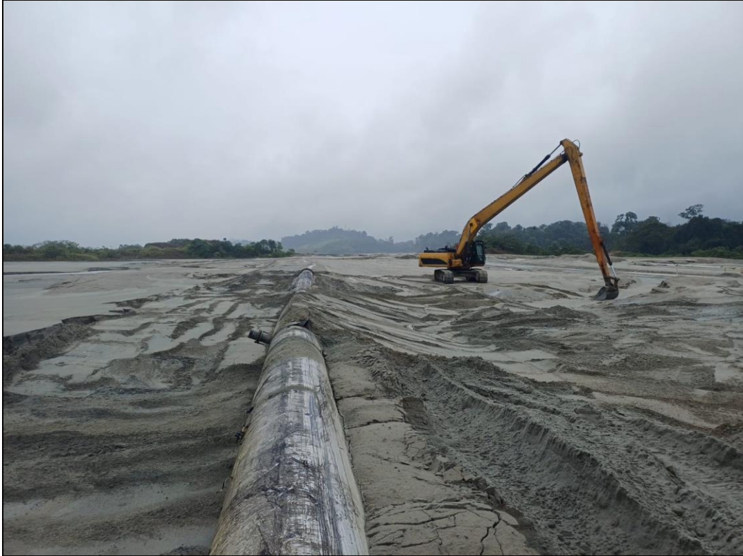
Figura 29 - Reparación de erosión en celda 30 en WRP03, Muro Este
