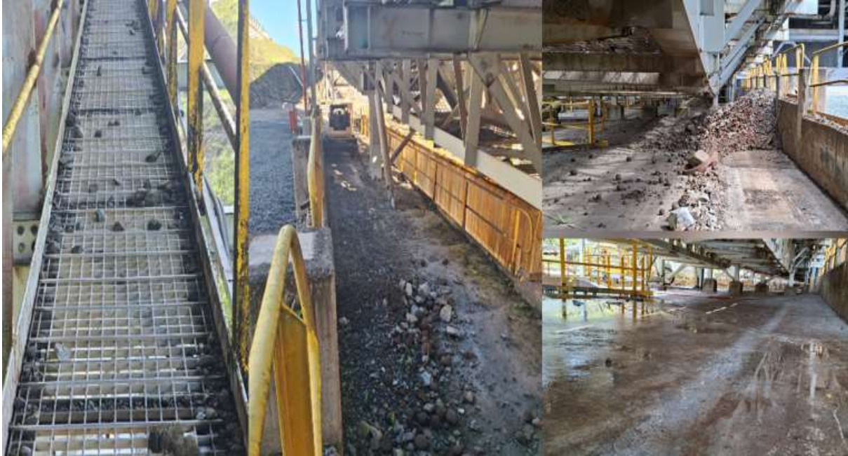
Ilustración 16 Limpieza y remoción de rocas en estructuras.
