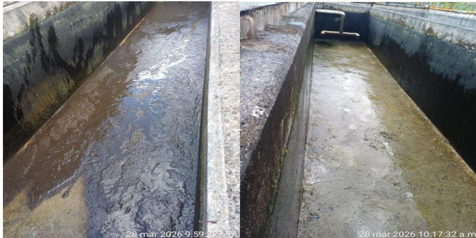
Limpieza de sedimentadores STP Cobre
