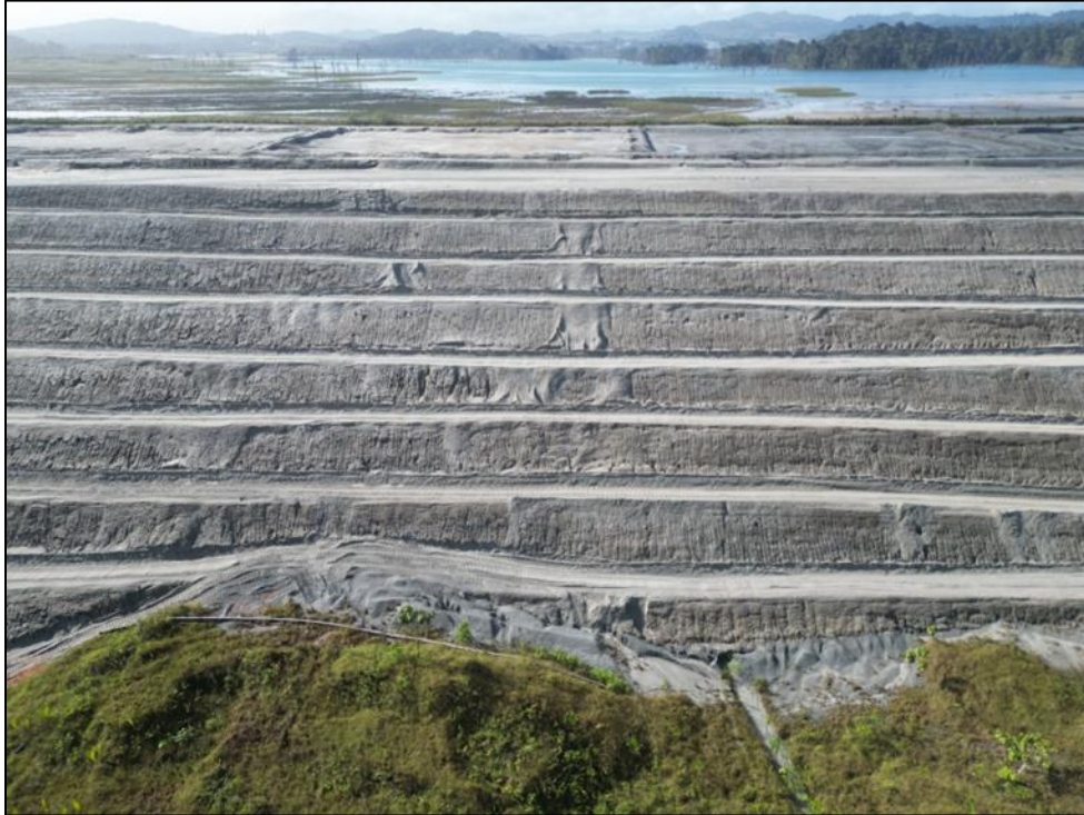
Figura 69 - Reparación de erosión en Muro Norte, Celda 16 Aguas Abajo.
