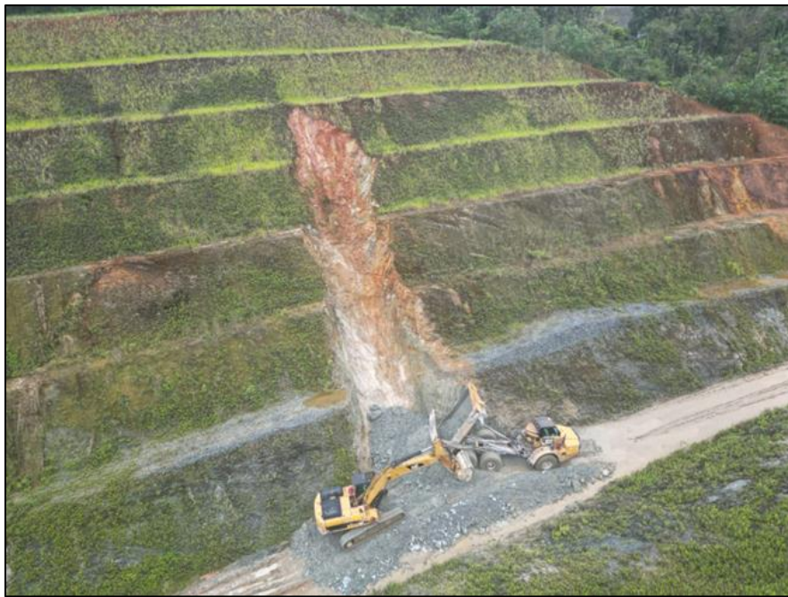
Figura 73 - Reparación de erosión en proceso, en Canal 6
