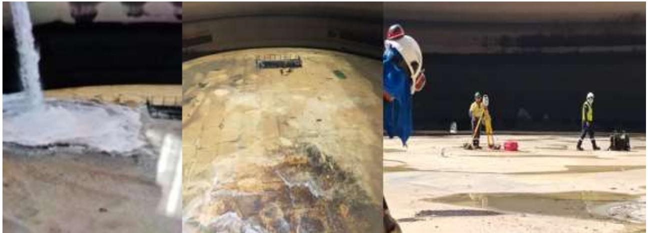
Ilustración 28 Limpieza interna de tanque de almacenamiento de agua.
