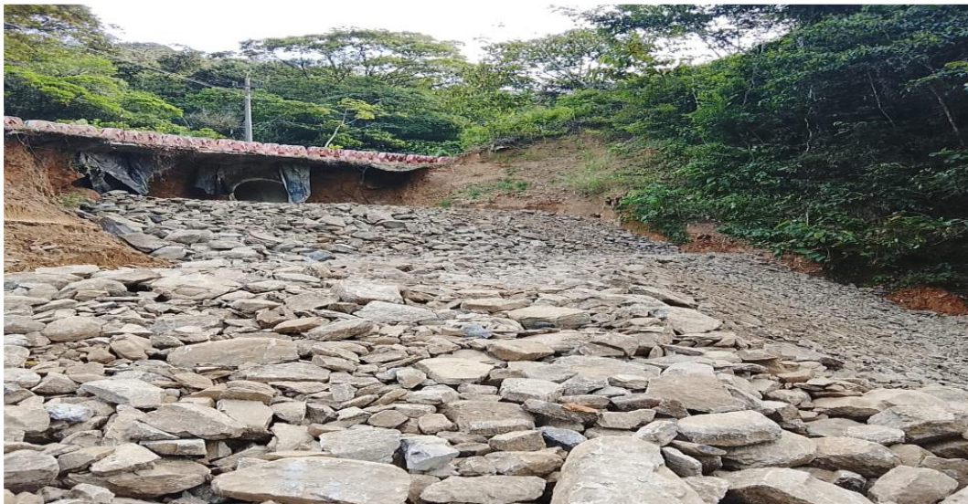
Talud estabilizado
