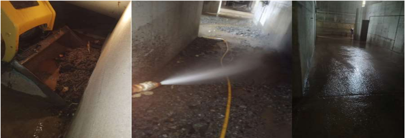
Ilustración 20 Limpieza de sedimentos en piso de bombas (antes y después).
