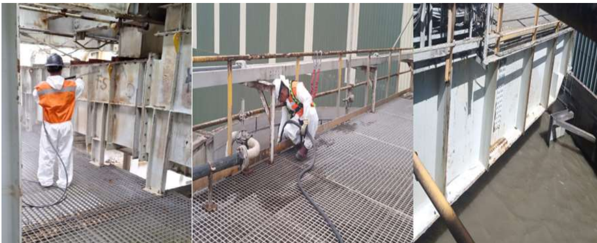
Ilustración 25 Limpieza de canaletas y estructuras del tanque de almacenamiento hacia flotación.
