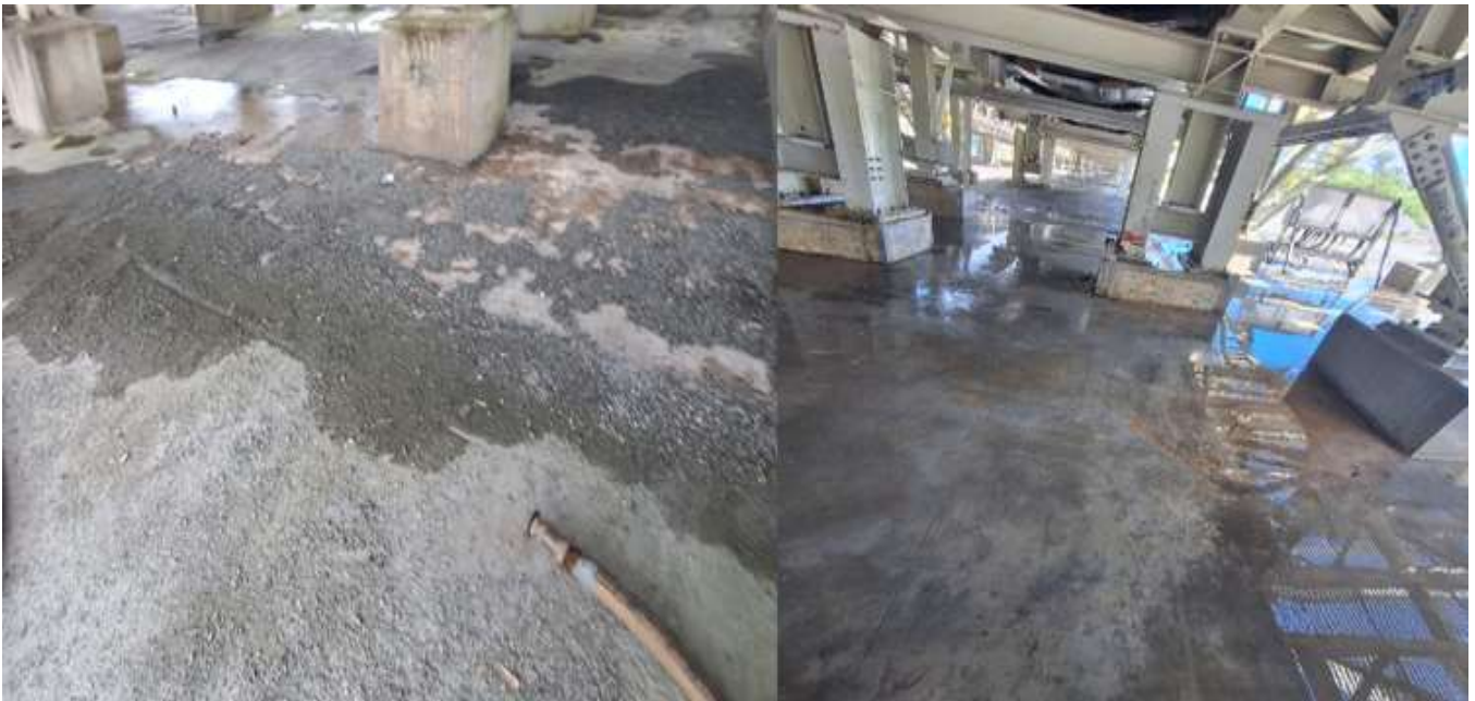
Ilustración 15 Remoción de sedimentos en parte baja de las fajas (antes y después).
