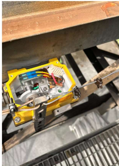
Mantenimientos de Pull Cord
