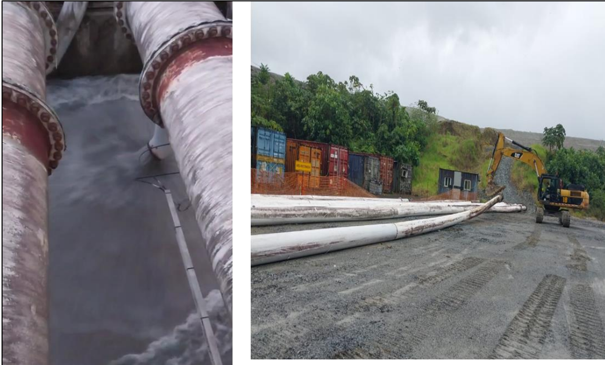
Figura 8 - Inspección de líneas de Relaves HDPE, en estaciones de válvulas, ruta costera y muros de la IMR.
