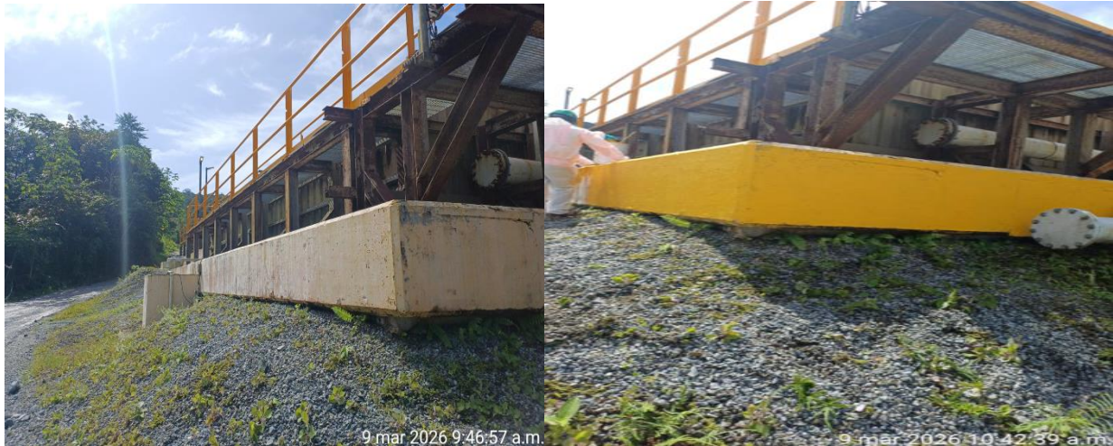
Limpiezas y mantenimiento de muros de contención STP Cobre.
