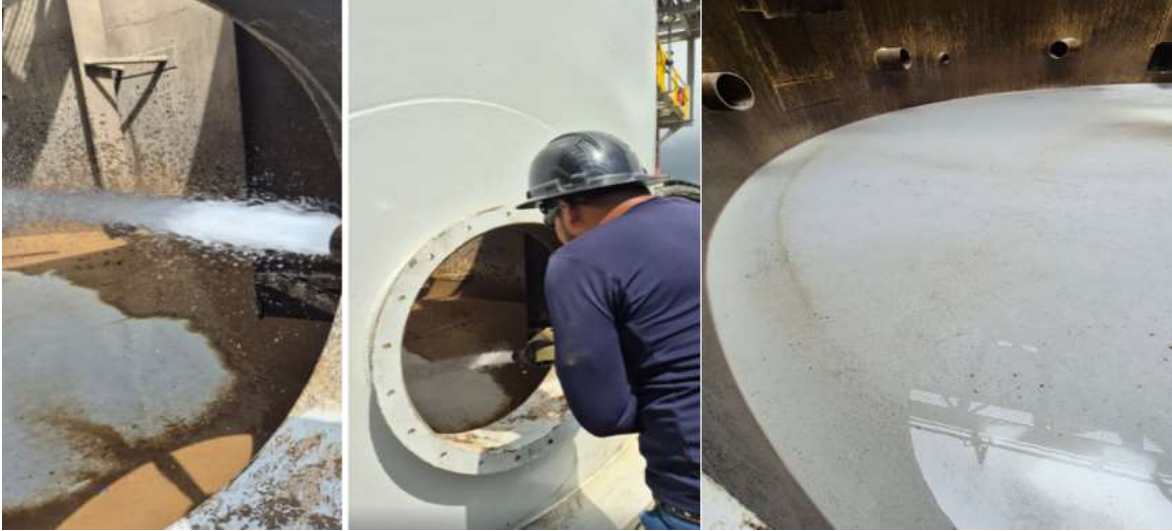
Ilustración 26 Limpieza interna de tanque de cal (antes y después).
