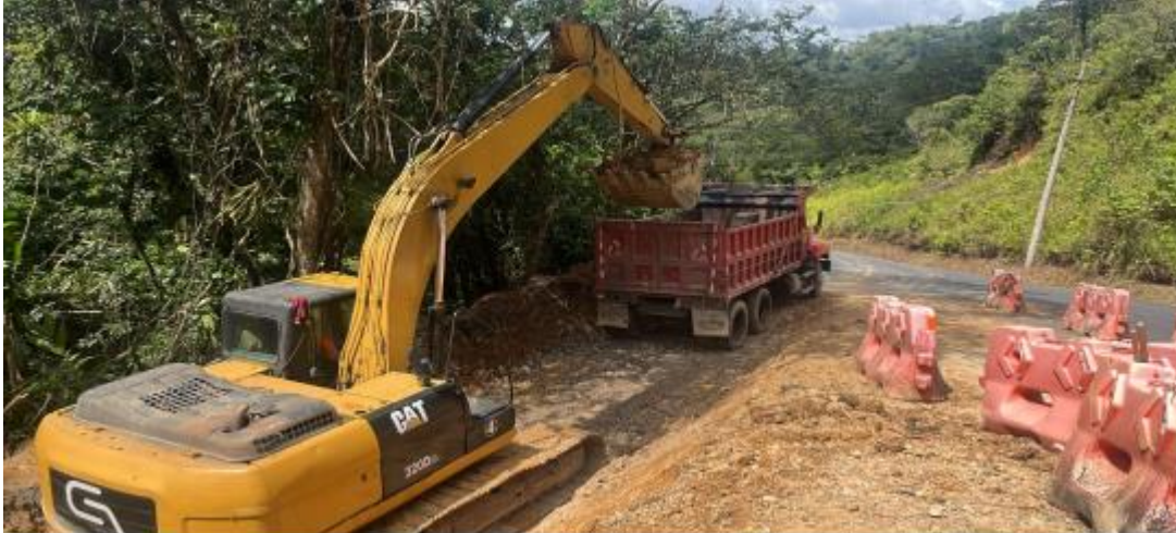
Inicio de los trabajos
