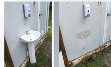
Eliminación de Lavamanos Barbería Caribe
