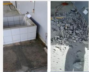
Eliminación de Tina Modulo Frente a Comedor Caribe
