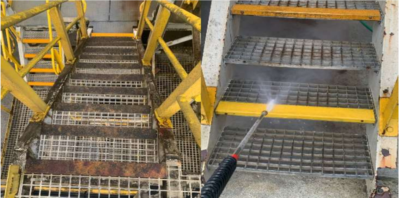
Ilustración 14 Limpieza de estructuras de escaleras.
