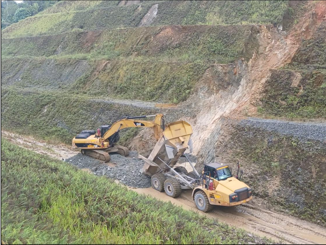
Figura 27 - Avances de reparación de erosión Canal 6 en WRP06, Muro Este
