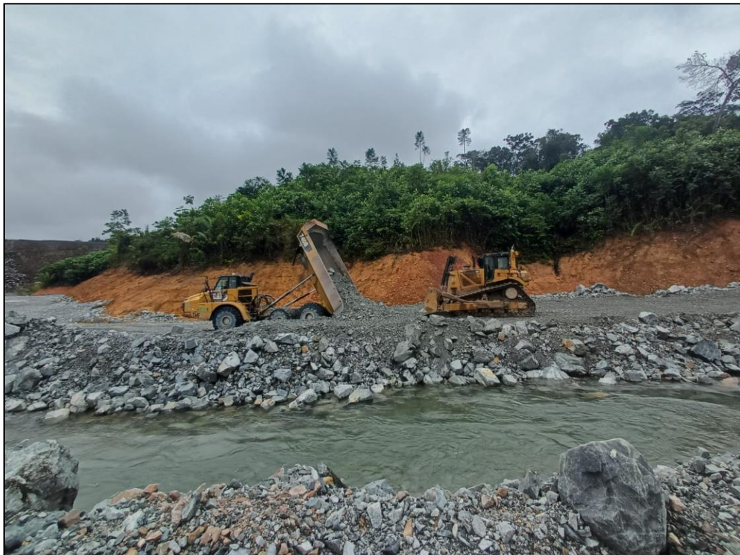
Figura 28 - Enrocado con Z7 PAG en WRP06, Muro Este
