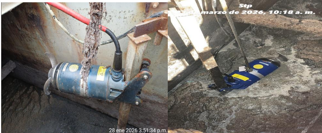
Colocación de Nuevo mixer en planta STP Caribe.
