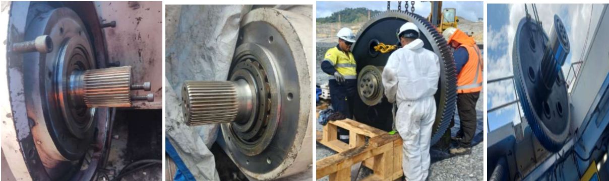
SHE01: Inicia instalación de primera y segunda reducción de Hoist frontal y trasero
