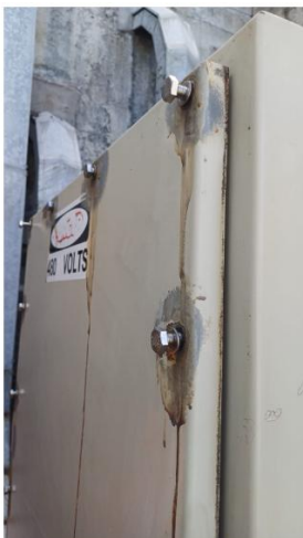
Reemplazo de tornillería corroida en 323TFR9021
