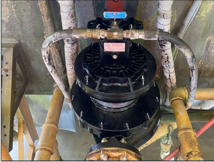
DTA153. Reemplazo de bomba de agua de tanquero
