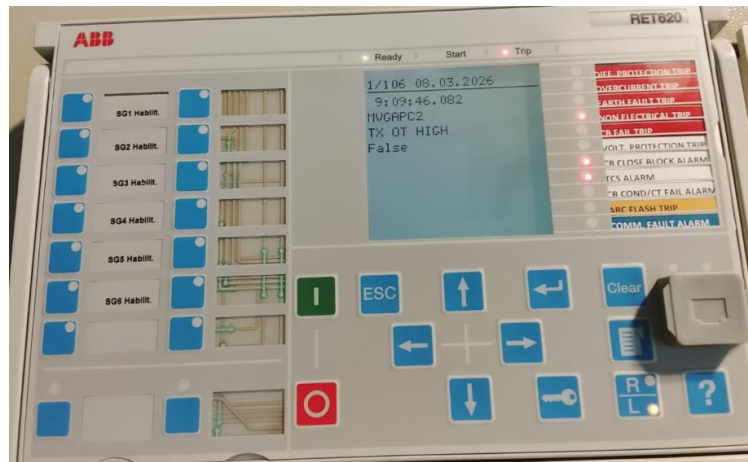
Prueba de alta temperatura de aceite 323TFR9021
