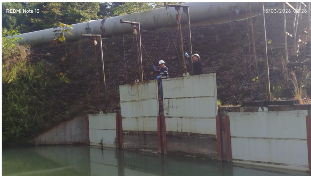
Figura 3 - Inspección de funcionalidad de Compuerta PB05/09
