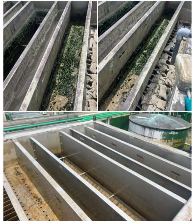
Limpeza de Clarificadores.
