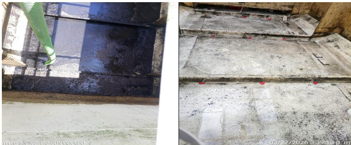
Limpeza de tanque de contacto en STP Cobre
