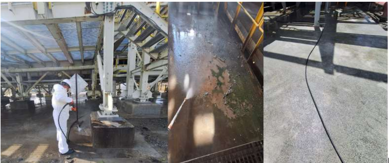
Ilustración 19 Limpieza de piso y estructuras con hidrolavadora (antes y después).
