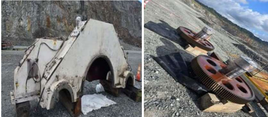
SHE01: Remoción de segunda y primera reducción de transmisión de Hoist
