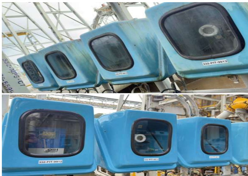
Ilustración 23 Limpieza de cajas asociadas a los instrumentos de equipos (antes y después).
