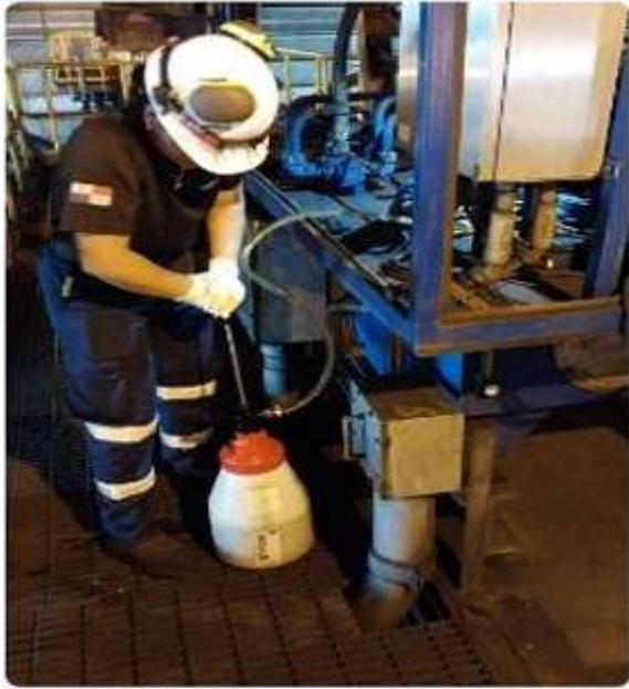
Foto N° 1 – Reposición de Aceite RE1B
