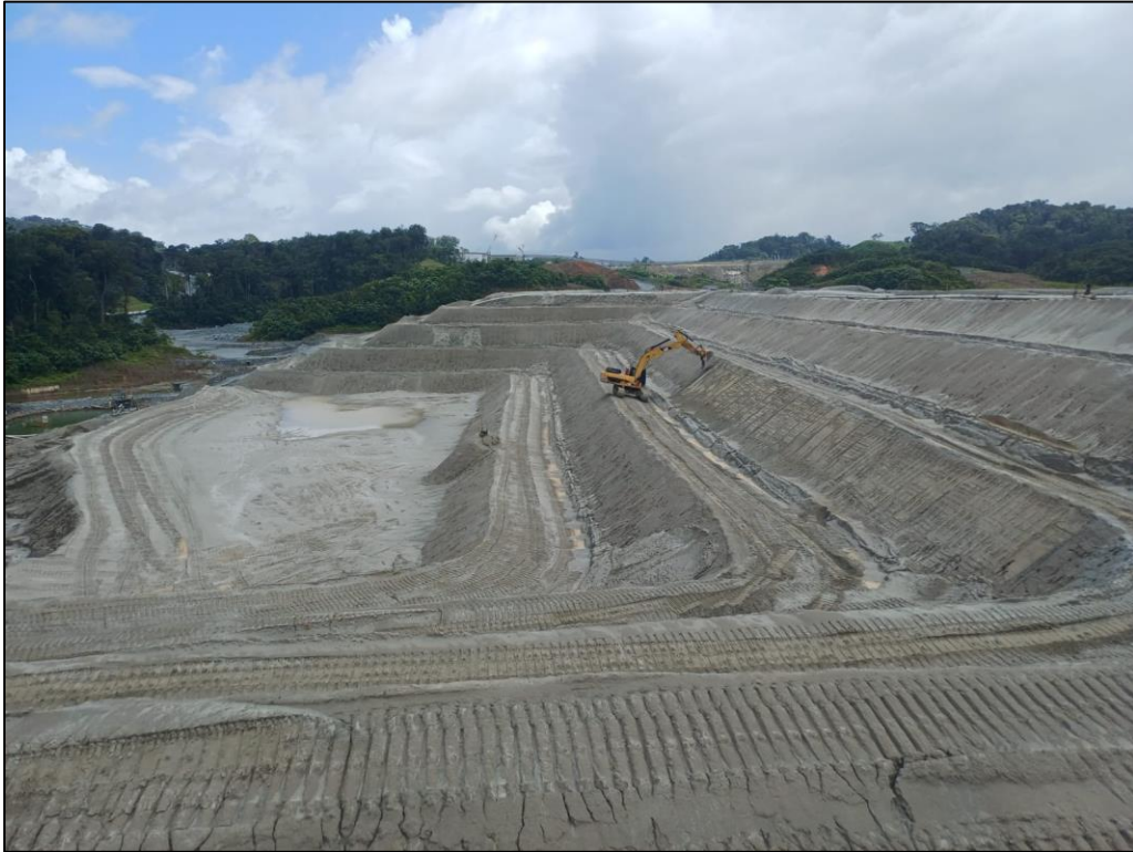
Figura 25 - Mantenimiento de banquetas en WRP05, Muro Este
