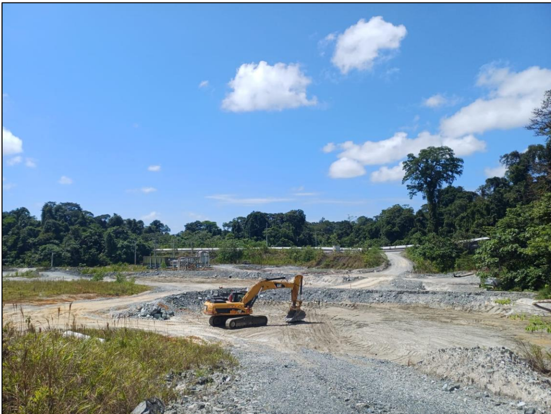
Figura 30 - Limpieza de sedimento en SCF03 NDS1, Muro Norte
