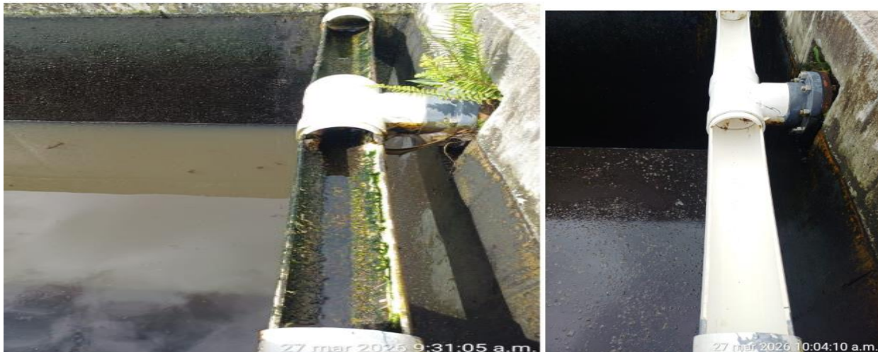
Limpieza de colectores de agua tratada STP Cobre
