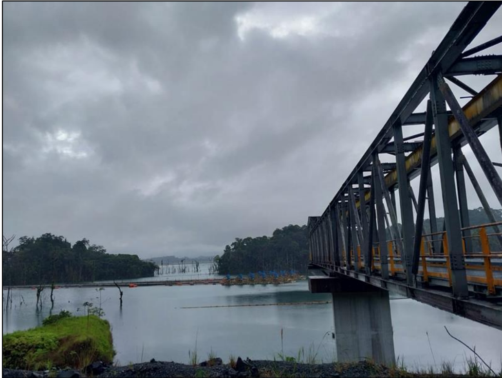
Figura 65 -Vista general. No se observan cambios en el estanco con respecto al último informe
