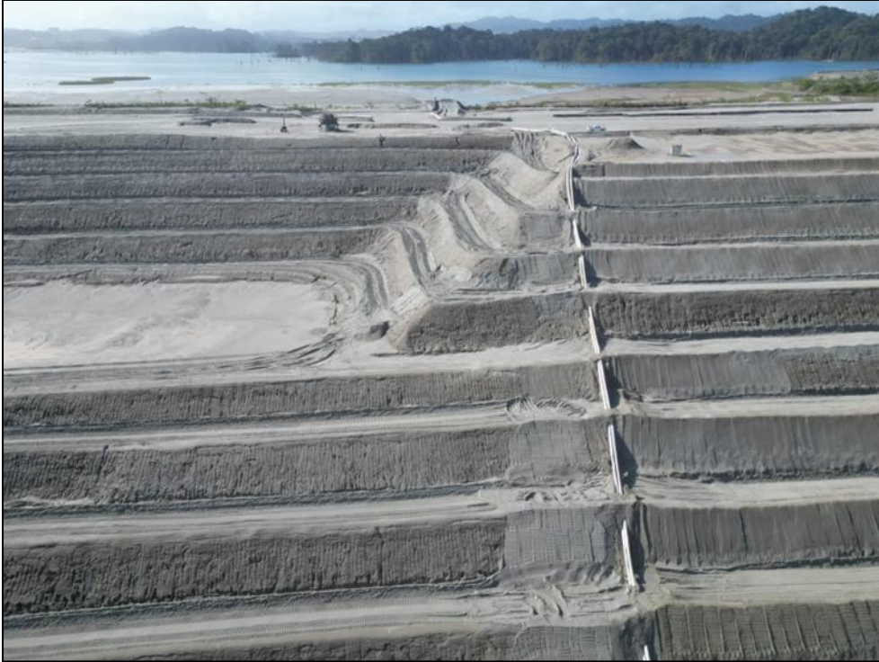
Figura 70 - Erosión reparada Muro Norte, Celda 19
