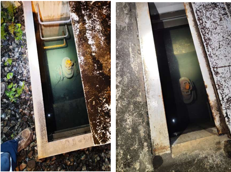
Drenado de contenciones de Transformadores.
