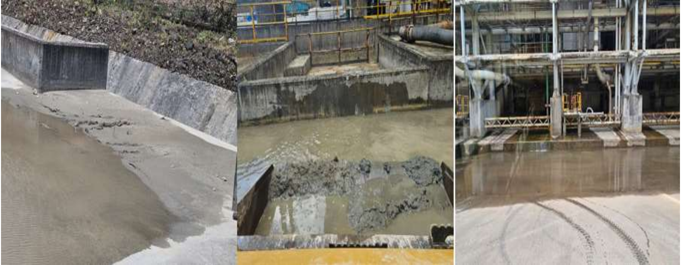
Ilustración 22 Limpieza del canal de sumideros.
