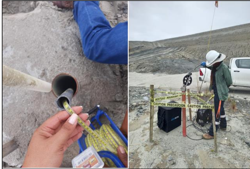
Figura 76 - Lectura de instrumentación geotécnica (Casagrande e inclinómetro)
