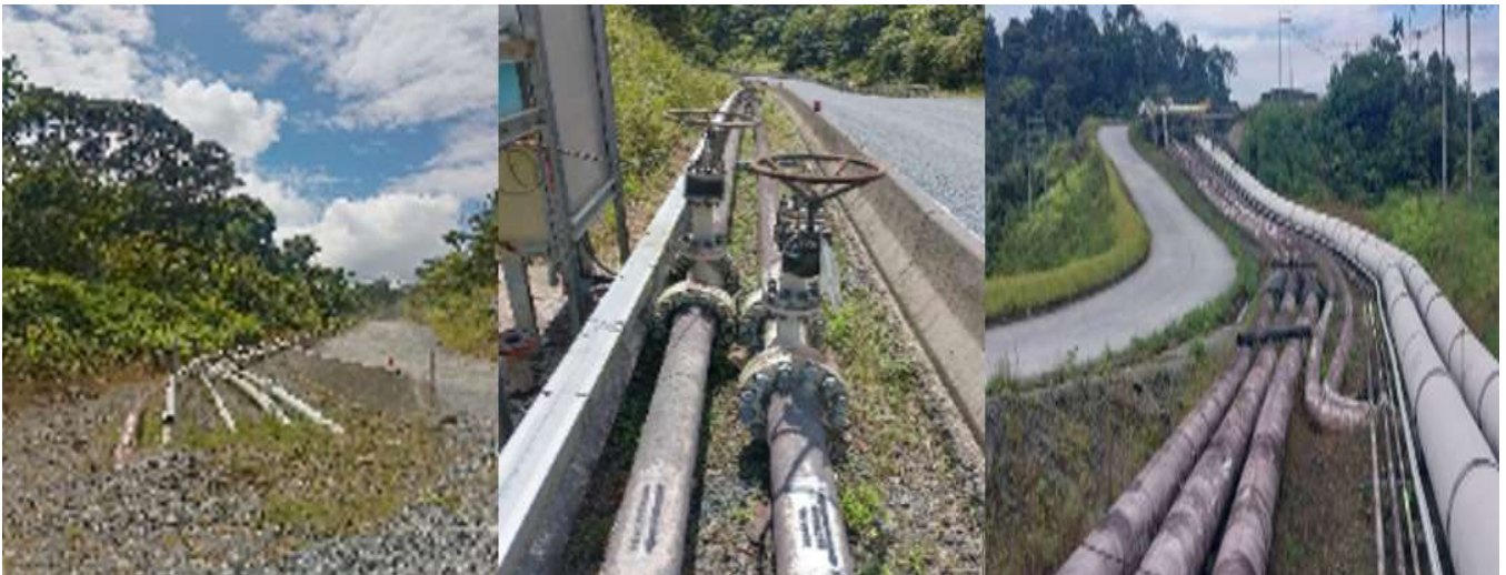
Ilustración 29 Verificación de línea de concentrado hacia puerto.
