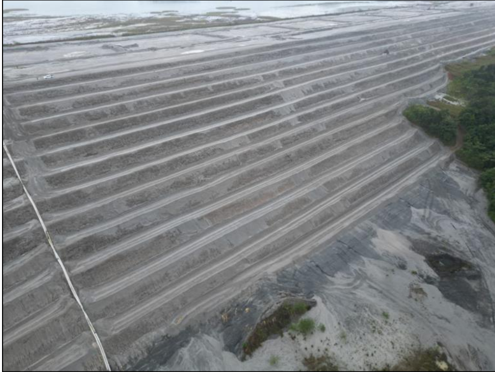
Figura 68 - Erosión Reparada en el Muro norte, Celda 12-13-14 Aguas Abajo
