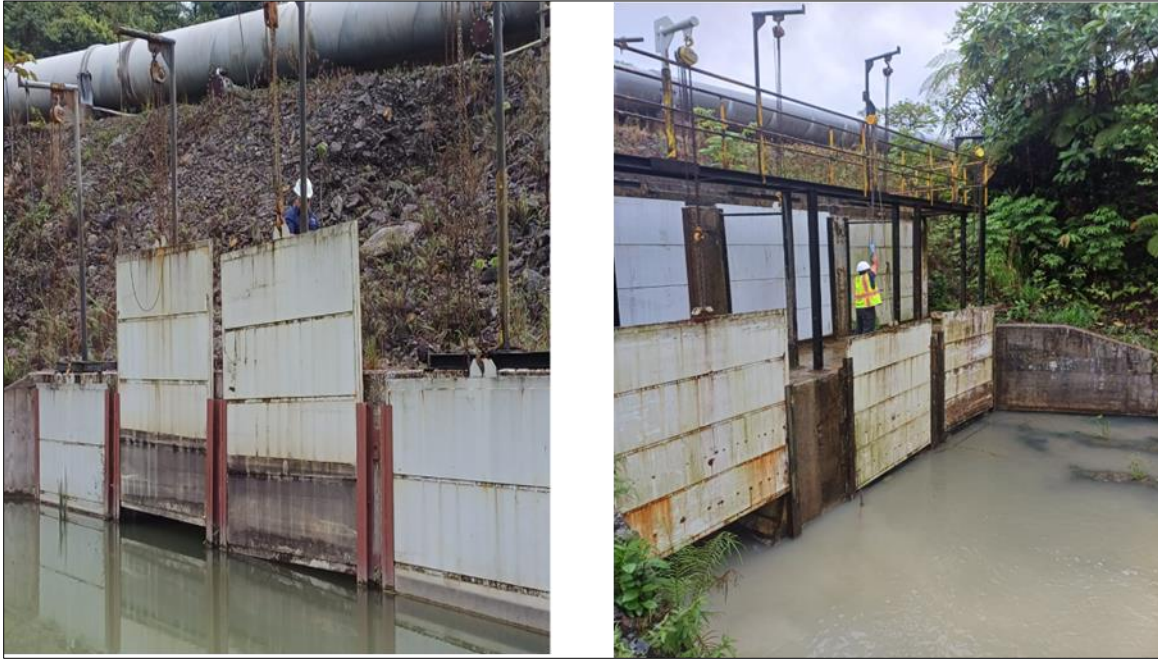
Figura 4 - Inspección de funcionalidad de Compuerta PB05/09
