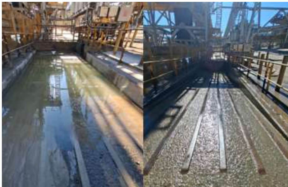
Ilustración 18 Limpieza de zona de sumidero (antes y después).
