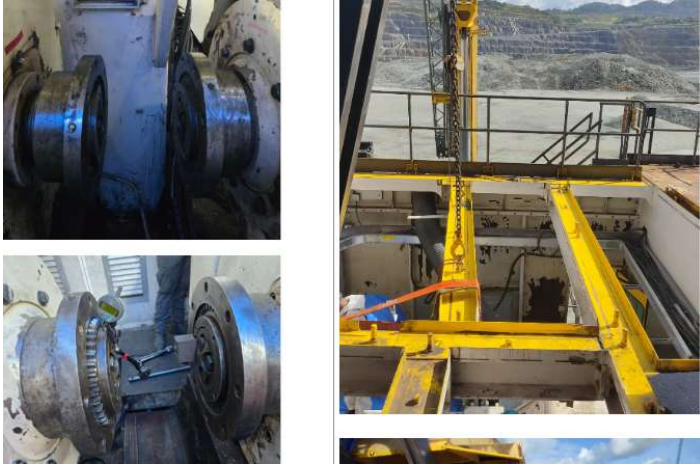
SHE01: Montaje de vigas de techo y alineamiento de motor de levante
