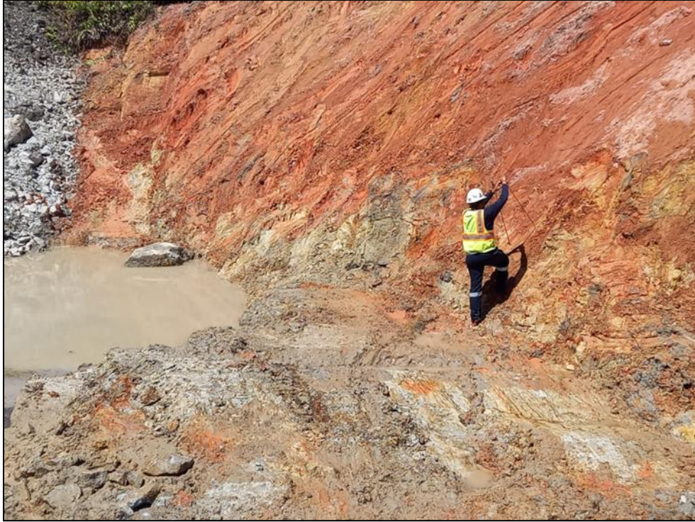
Figura 77 - Liberación de taludes en WRP6
