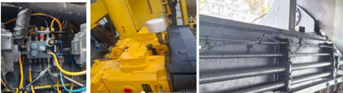
DRE106: Reemplazo de válvulas drill/propel y remplazo de bomba auxiliar LC y NLC.
