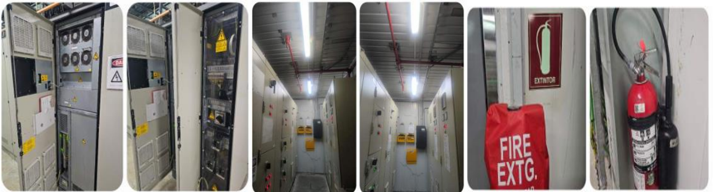
Mantenimiento en los variadores y Equipos en el reclamador de cobre.
