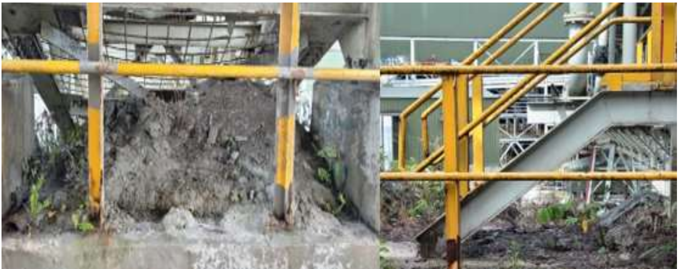
Ilustración 25 Limpieza de estructuras y escaleras de acceso.
