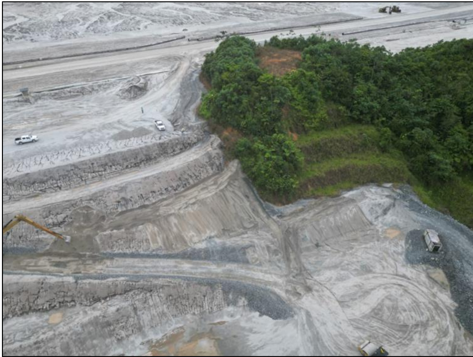
Figura 75 - Erosión Reparada en el Muro Este, Celda 20 Aguas Abajo
