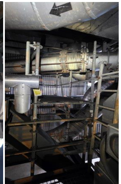
Reparación de fuga de carbón en ductos de transporte hacia caldera.
