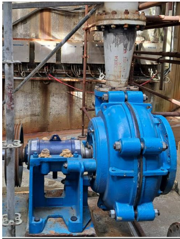
Se realiza el armado de la 332-PP-9001 Pendiente finalizar armado de motor
