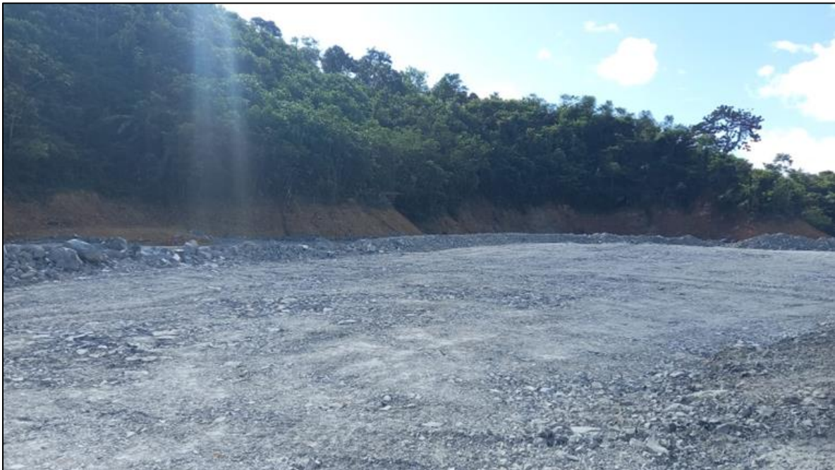
Figura 78 - Relleno de material Zona 7 en WRP6
