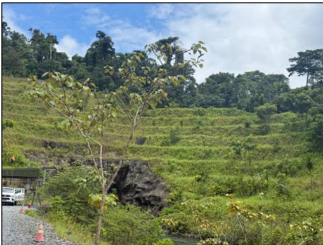
Figura 74 - Los taludes de la salida de descarga (túnel) se encuentra en buen estado
