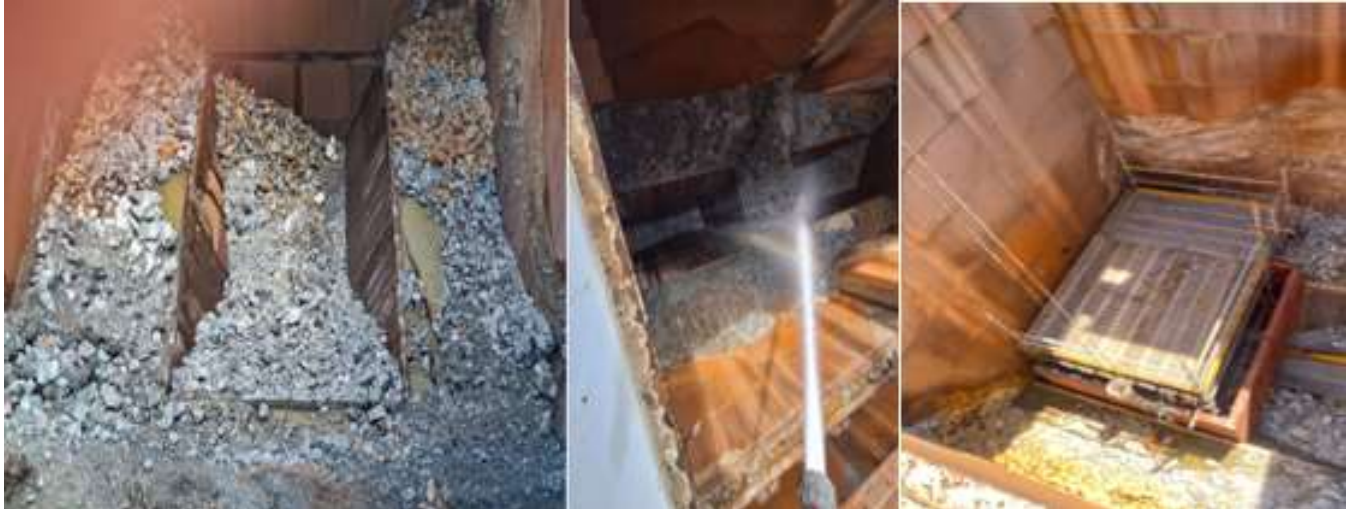
Ilustración 17 Limpieza y remoción de rocas en cajones para entregar a mantenimiento.
