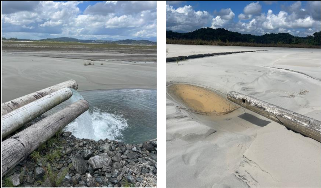
Figura 6 - Inspección de líneas de retorno de SCF02 y SCF03
