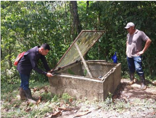
Visita técnica toma de agua – Cascajal
