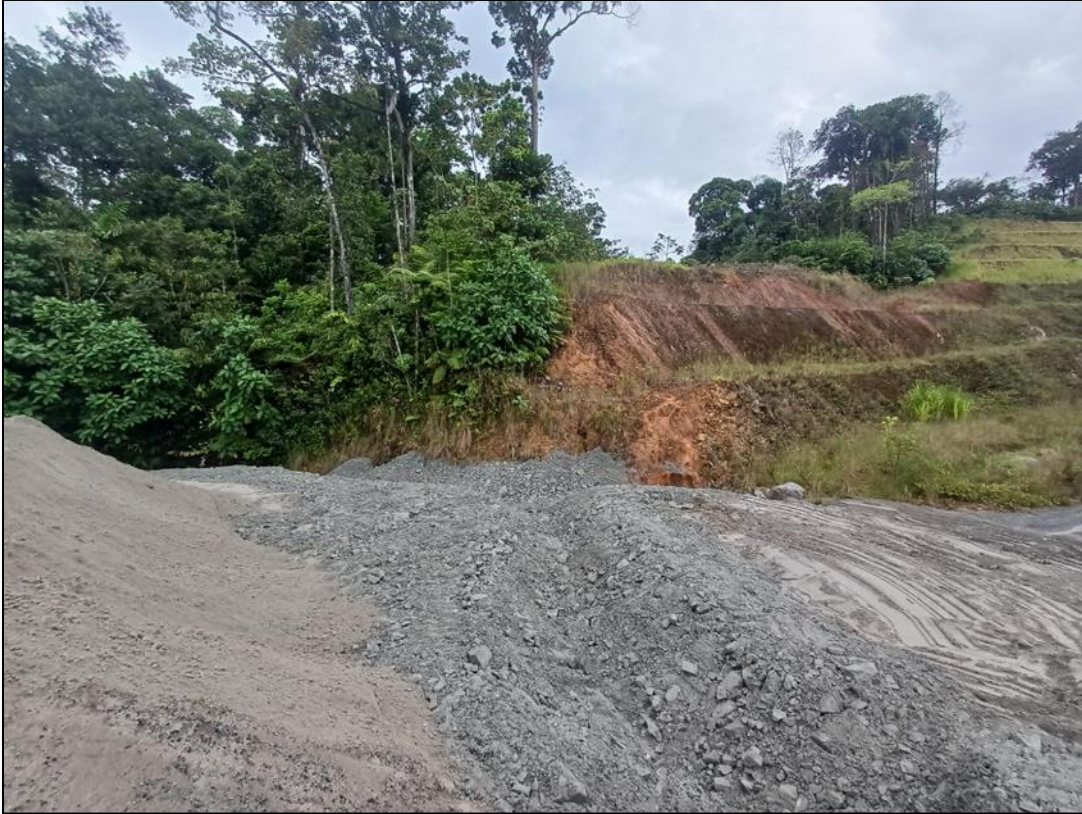
Figura 36 - Reparación de erosión contrafuerte celda 12, Muro Este
