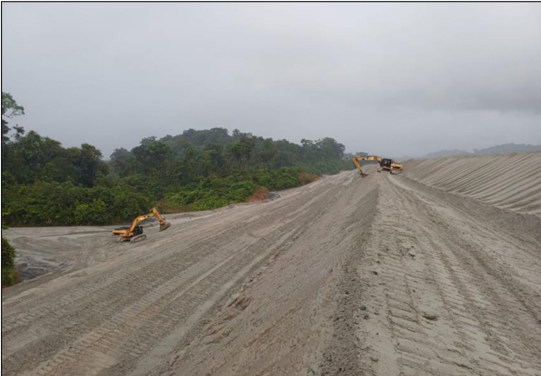
Figura 37 - Mantenimiento de banquetas WRP03, Muro Este
