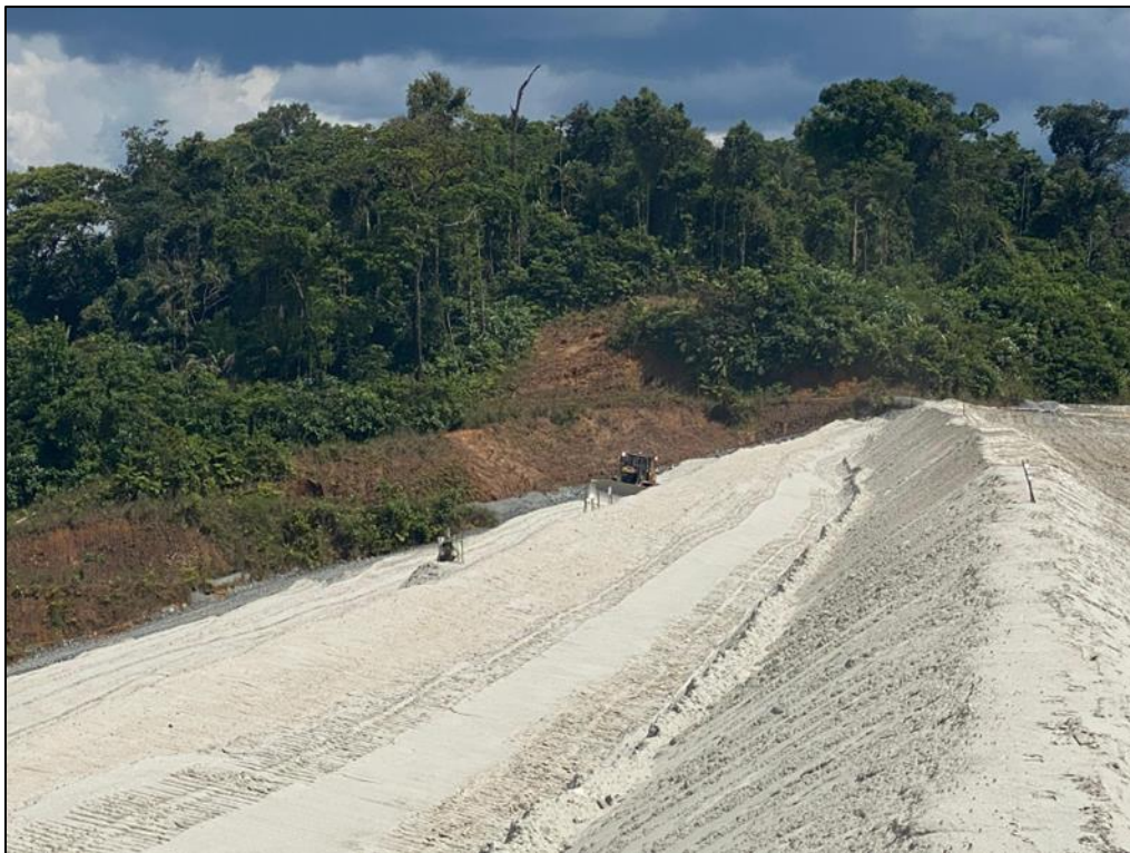
Figura 29 - Mantenimiento de banquetas WRP01, Muro Este
