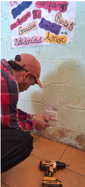
Mantenimiento del sistema eléctrico de la escuela – Nuevo Eden
