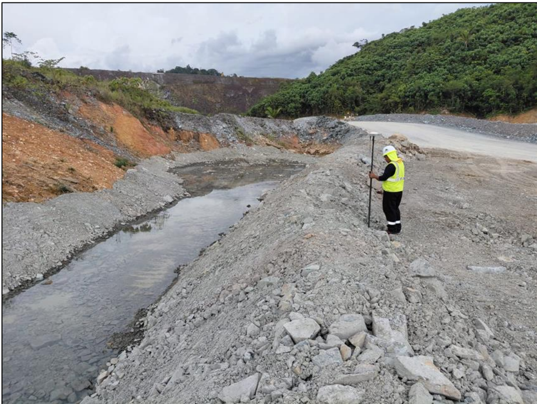
Figura 33 - Control y manejo de aguas en WRP06, Muro Este
