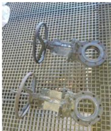
Cambio de tornillería en bridas y válvulas manuales de alimentación del filtro 712-FL-9003
