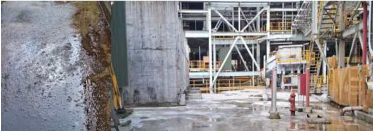
Ilustración 24 Limpieza de sedimentos (antes y después).
