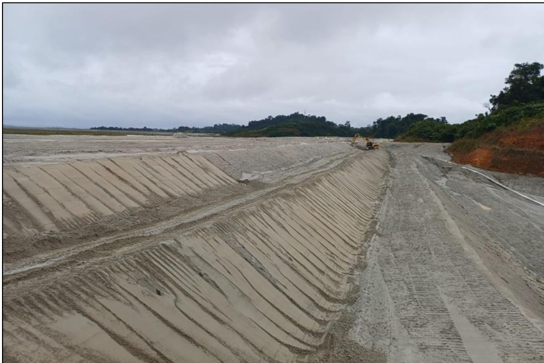
Figura 35 - Mantenimiento de banquetas WRP02, Muro Este
