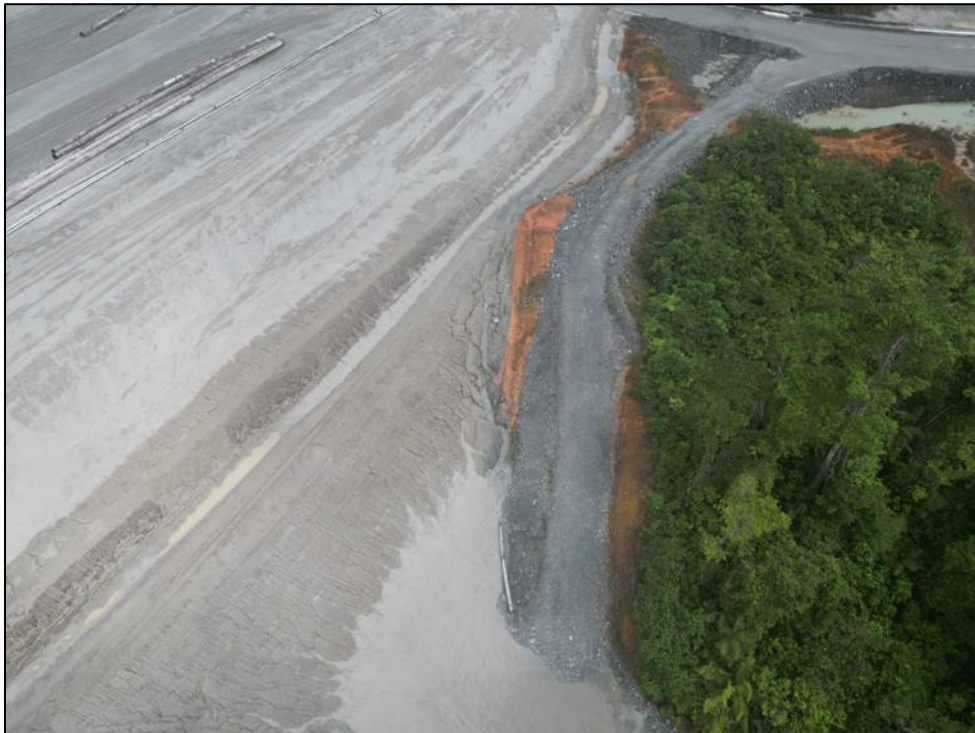
Figura 76 - Reparación de erosión en Muro Este, Celda 23 Aguas Abajo
