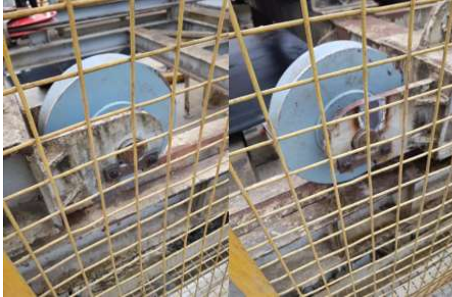
Ilustración 22 Reemplazo de ruedas en la faja hacia la pila de acopio.
