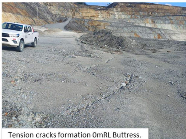
Figura 3. Aparición de grietas en la plataforma del nivel 0m RL. Zona delimitada con conos azules indicando riesgo geotécnico.
