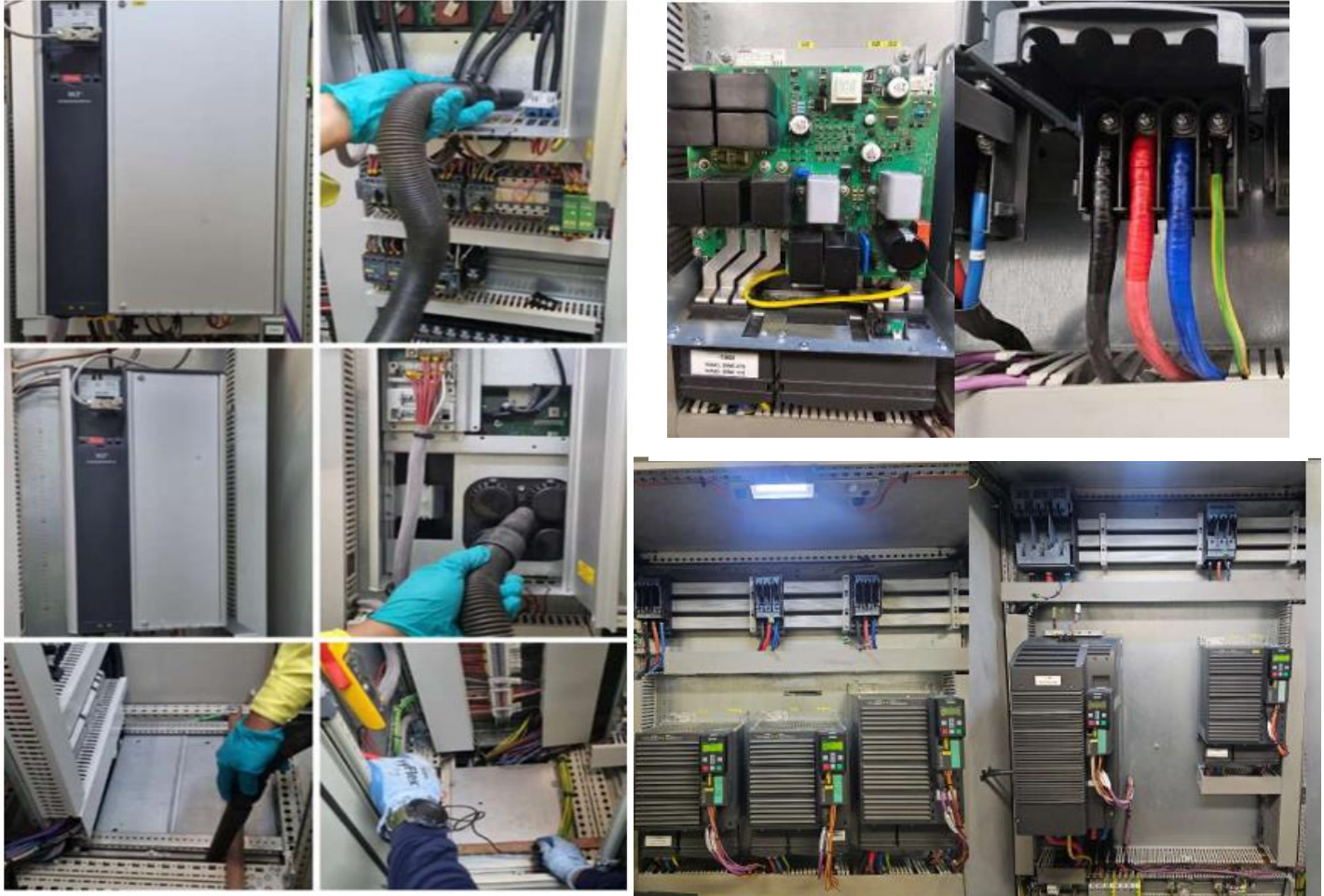
Mantenimiento en los variadores y Equipos en el reclamador de cobre.
