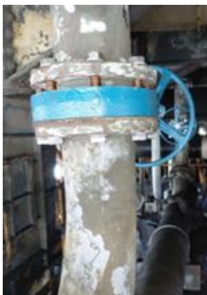
Cambio de tornillería en bridas y válvulas manuales de alimentación del filtro 712-FL-9003
