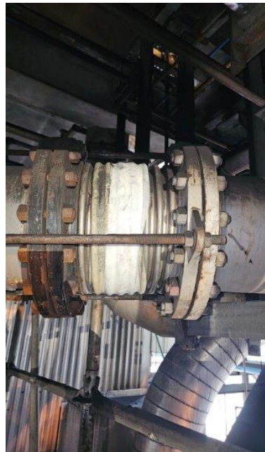
Reparación de fuga de carbón en ductos de transporte hacia caldera.
