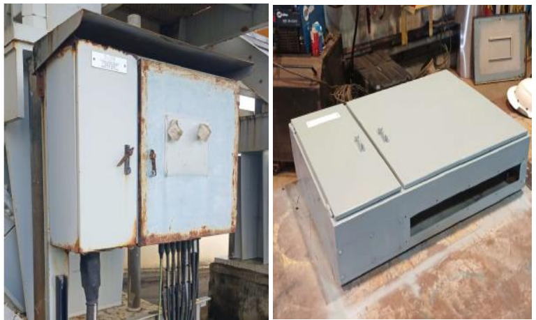
Fabricación e instalación de nuevo panel de luminaria del FGD U2
