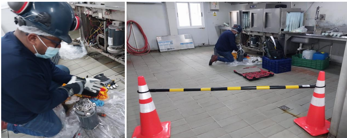
Mantenimiento de Lavaplatos Hobart
