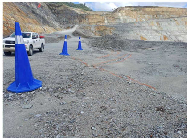
Figura 3. Aparición de grietas en la plataforma del nivel 0m RL. Zona delimitada con conos azules indicando riesgo geotécnico.
