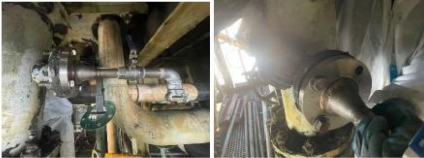
Instalación de venteos en líneas de alimentación
