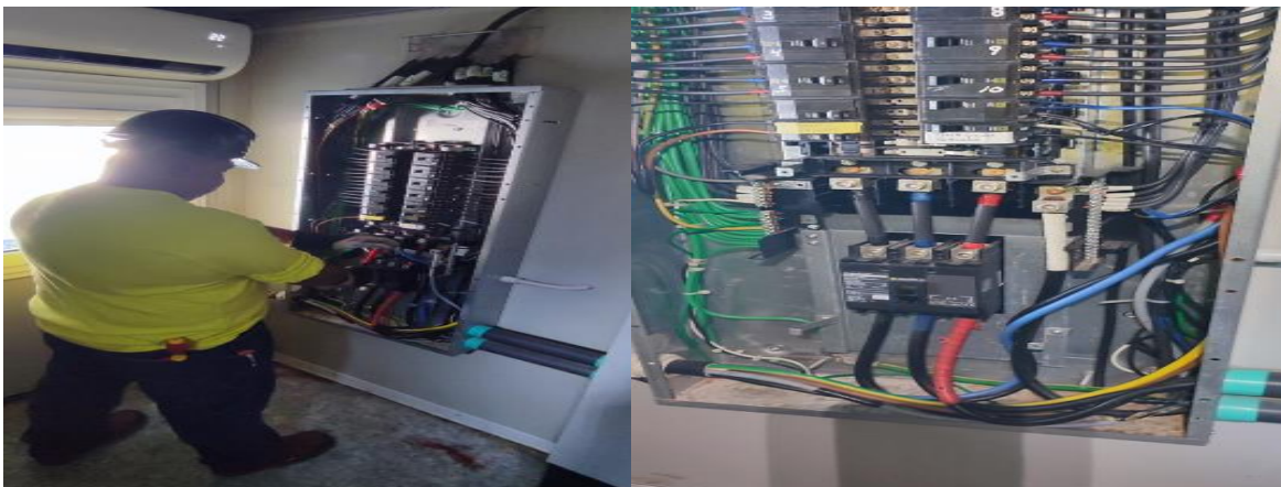
Inspección eléctrica Tablero de Distribución – Modulo T3B
