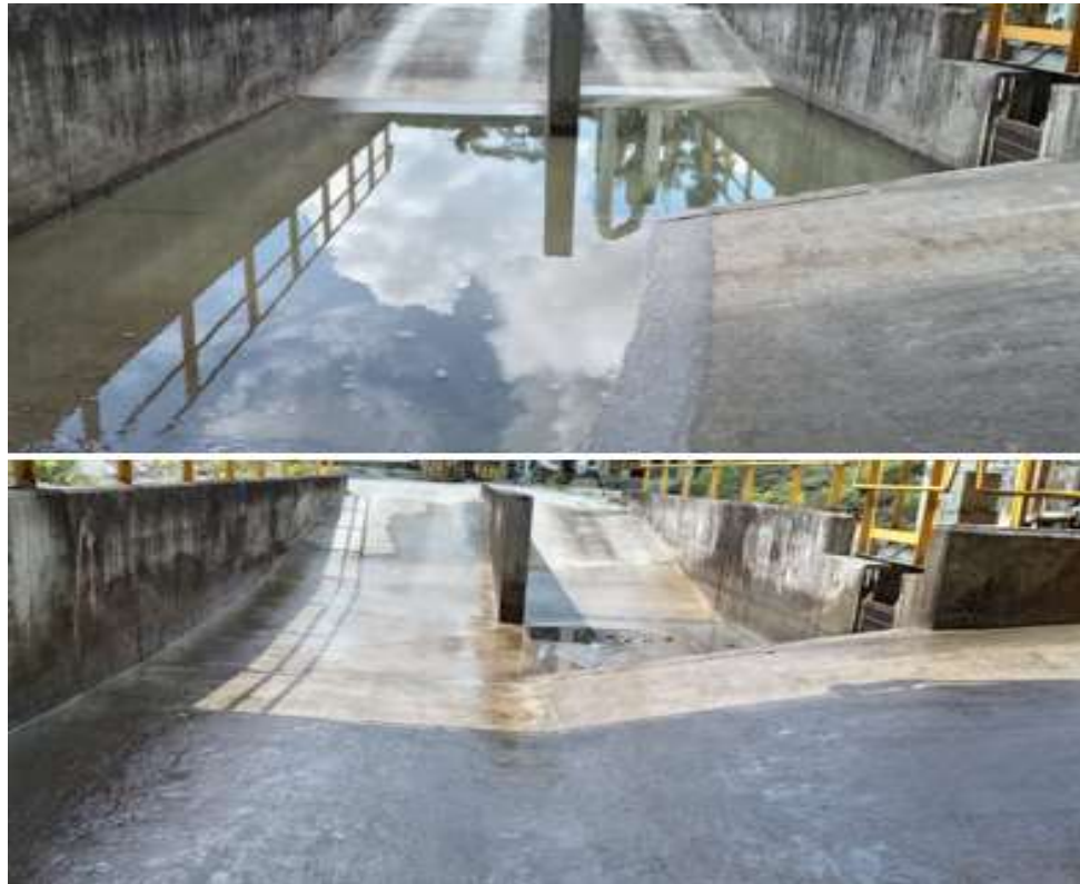
Ilustración 26 Limpieza del canal de sumideros.
