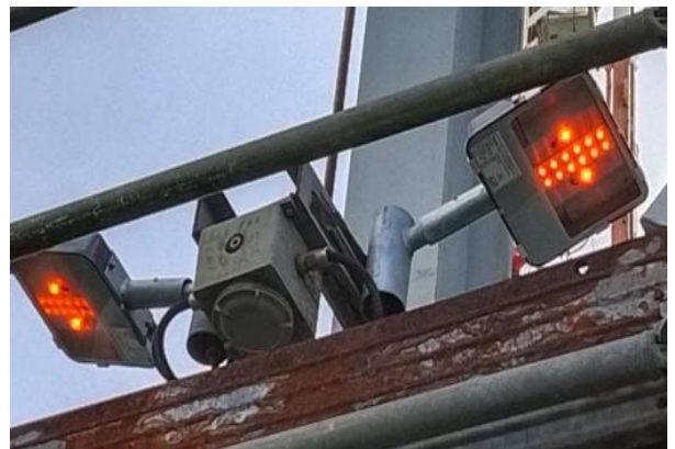
Inspección de luminarias y señalizaciones de exit.
