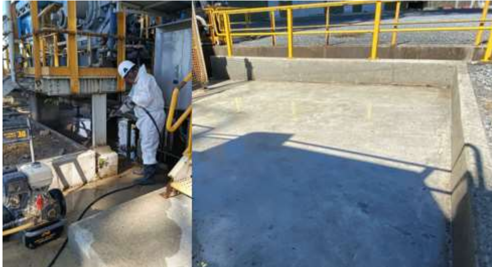
Ilustración 19 Limpieza de piso y estructuras con hidrolavadora (antes y después).
