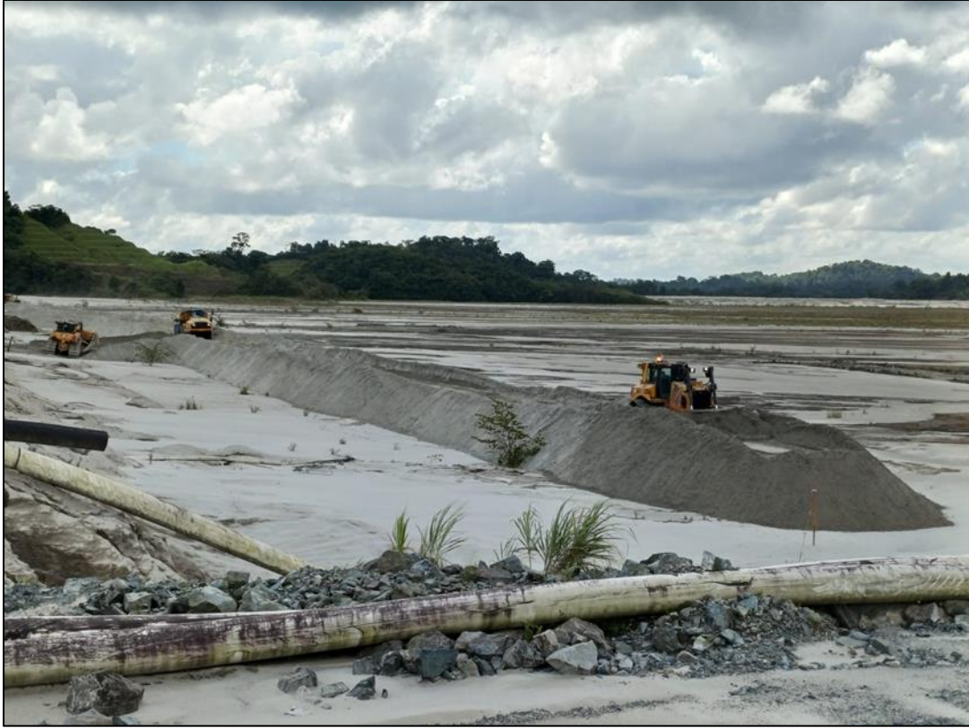
Figura 32 - Berma para soporte del sector 2-3, Muro Este
