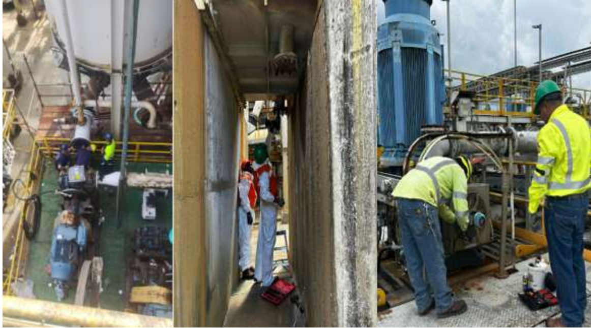
Ilustración 28 Coordinación de actividades mecánicas y eléctricas.
