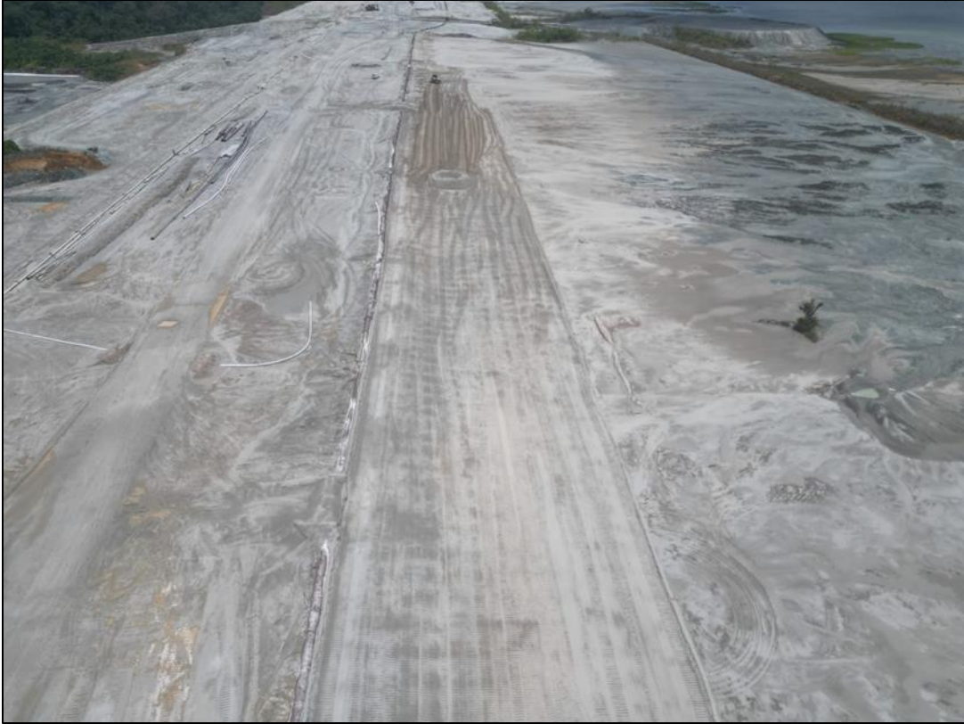
Figura 30 - Nivelación del soporte del sector 4, Muro Norte
