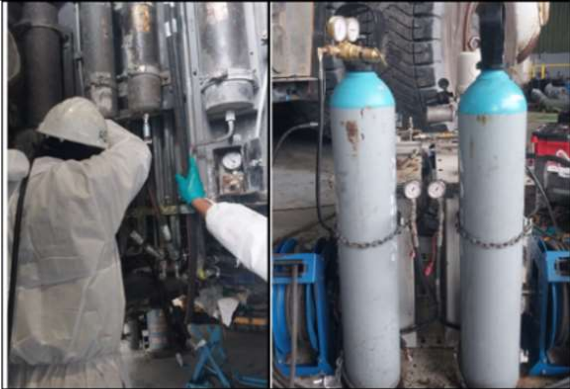
DTU008.Recarga de acumuladores
