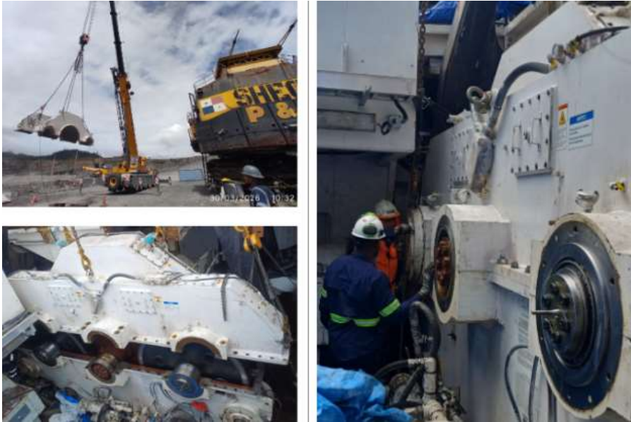
SHE01: Instalación los engranajes de la transmisión de levante y tapa de cierre.
