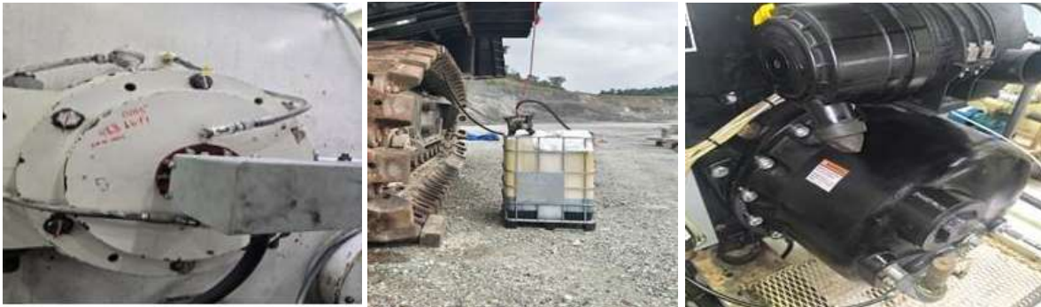
SHE01: Precarga de la transmisión de Hoist, llenado de aceite y mantenimiento del compresor.
