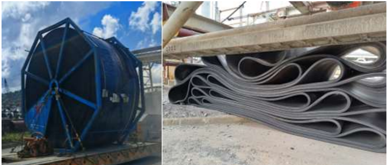
Ilustración 21 Reemplazo de faja de alimentación de la pila de acopio.
