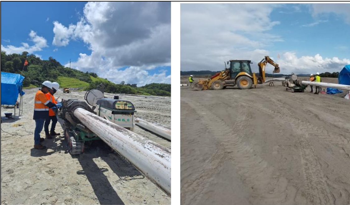
Figura 7 - Fabricación de Tuberías de Descarga en Muro Norte.
