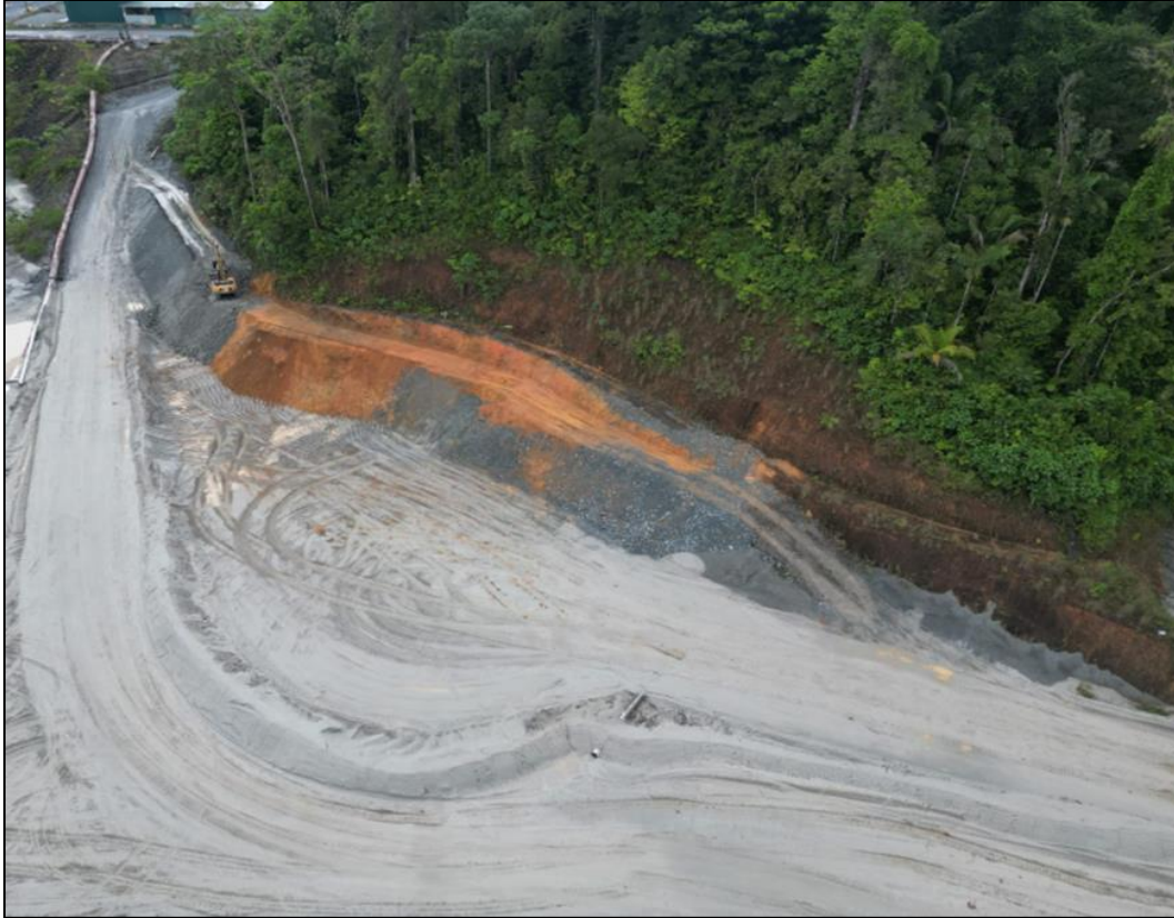
Figura 34 - Construcción de corredor para reubicación de tuberías de arena, Muro Este
