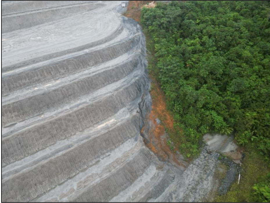
Figura 81 - Erosión en contorno de zona 3, Muro Norte, Celda 28 Aguas abajo
