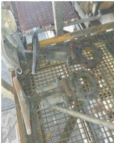
Cambio de tornillería en bridas y válvulas manuales de alimentación del filtro 712-FL-9003
