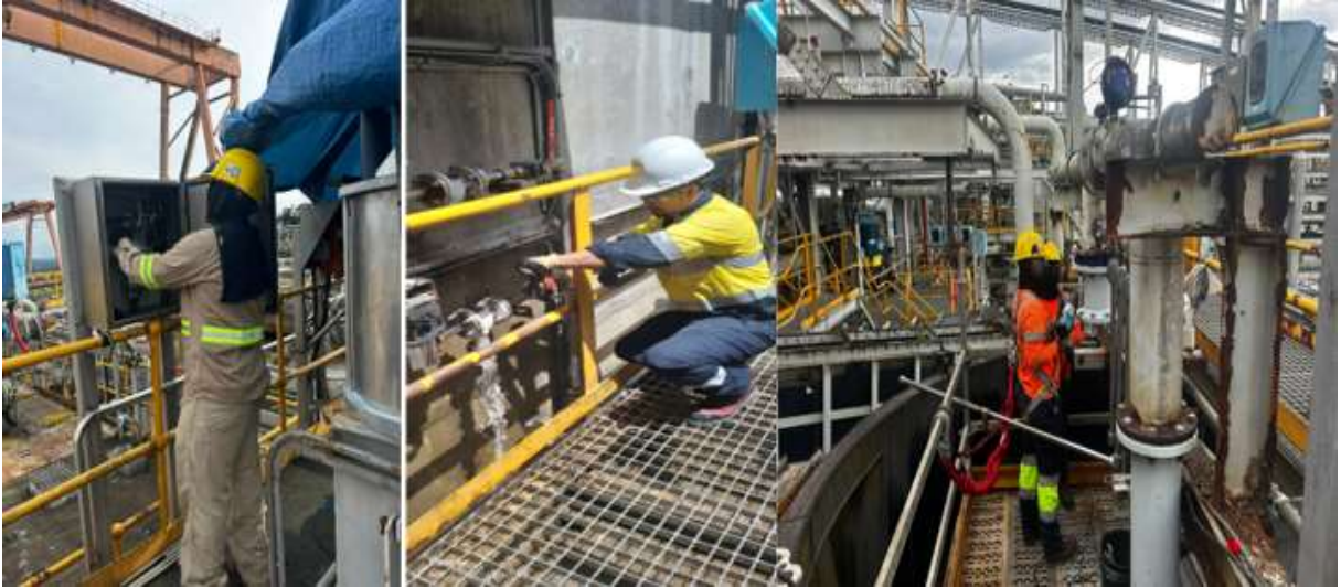
Ilustración 30 Coordinación de revisión de funcionamiento de sub sistemas luego de trabajos.
