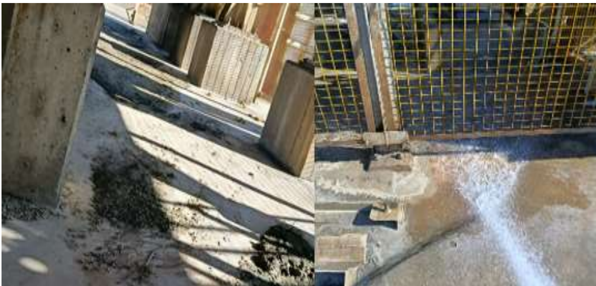
Ilustración 16 Remoción de sedimentos en parte baja de las fajas (antes y después).
