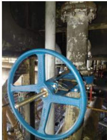
Cambio de tornillería en bridas y válvulas manuales de alimentación del filtro 712-FL-9003
