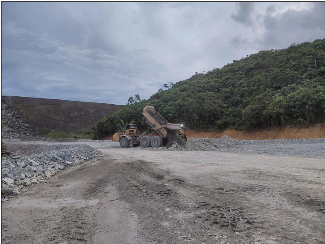
Figura 31 - Enrocado con Z7 PAG en WRP06, Muro Este
