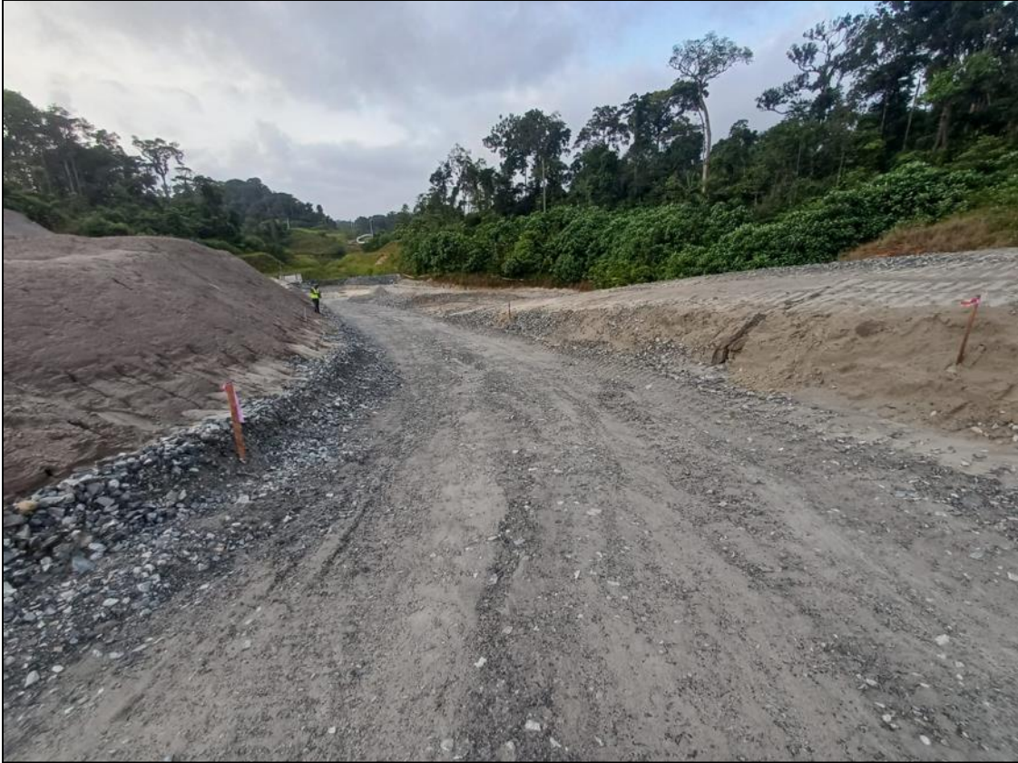
Figura 39 - Construcción de acceso para limpieza de posas y revisión de bombas, Muro Este
