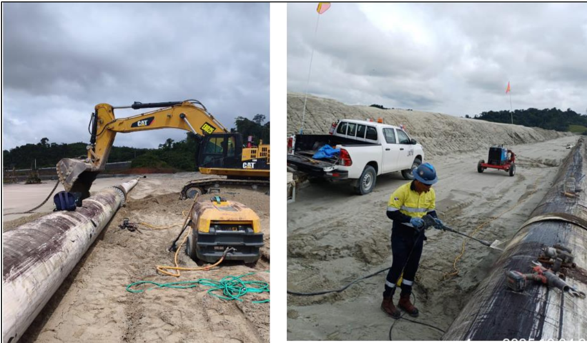
Figura 9 - Fabricación de Tuberías de Descarga en Muro Norte.
