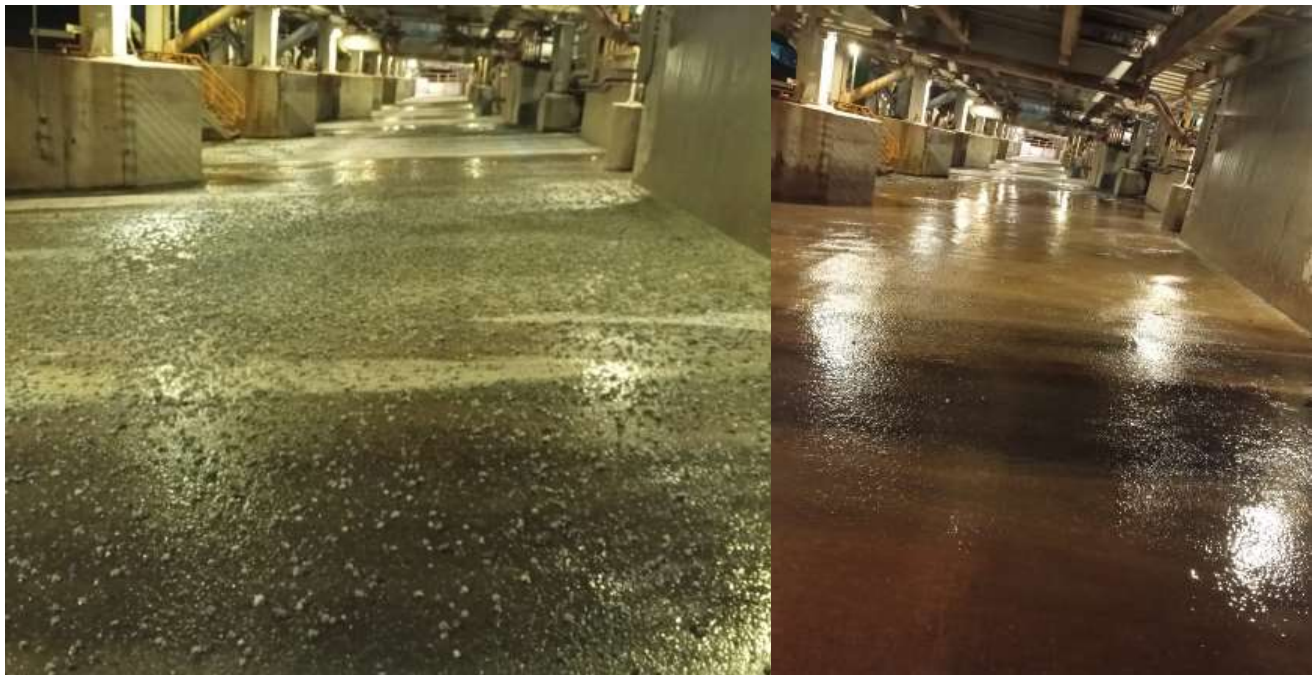
Ilustración 21 Limpieza de sedimentos.
