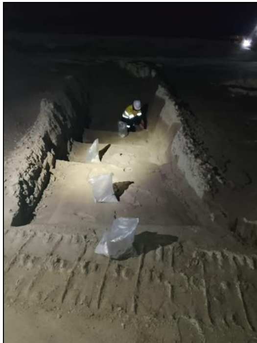
Figura 89 - Toma de muestra para monitoreo de % de finos, Muro Este, Celda 33/34 Aguas abajo.
