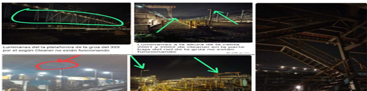
Ilustración 30 Revisión de Luminarias.
