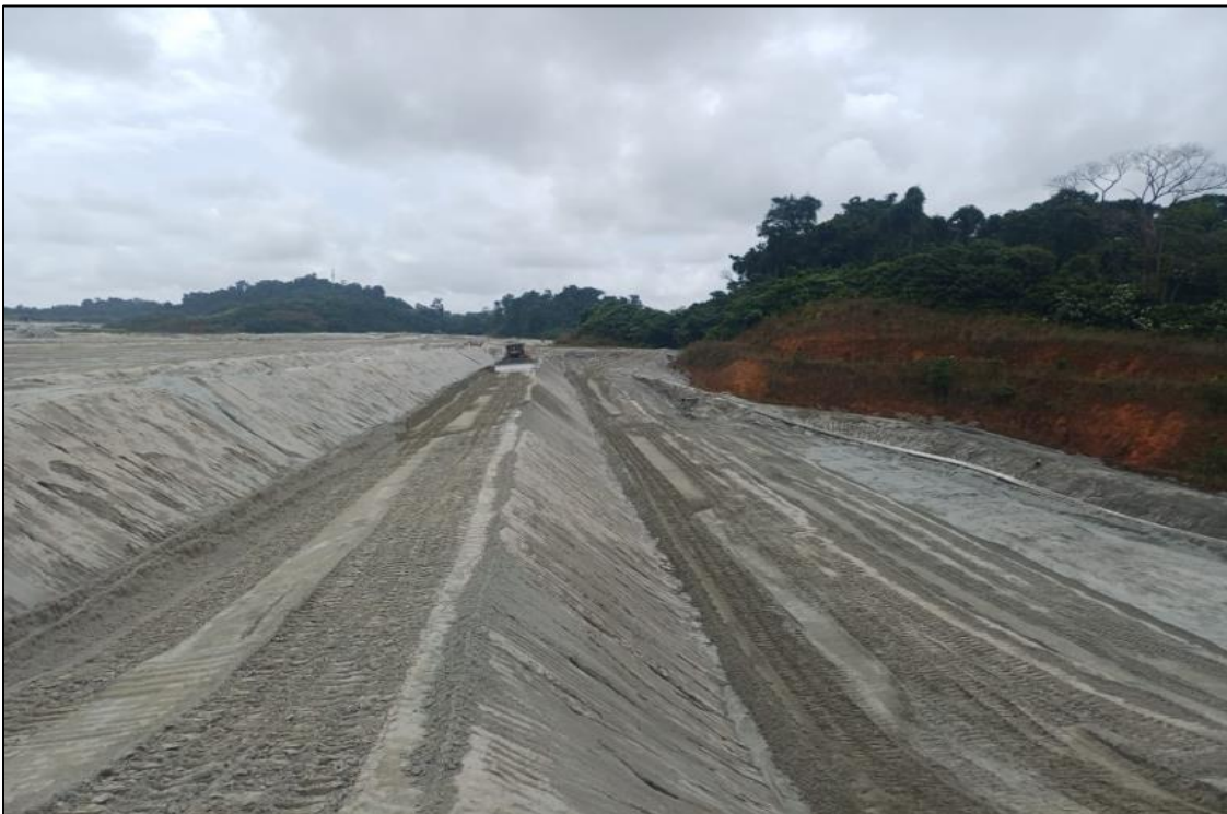
Figura 40 - Mantenimiento de banquetas WRP02, Muro Este
