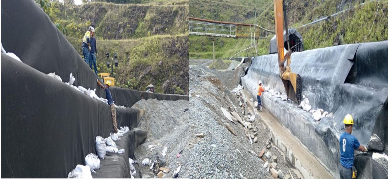
Mantenimiento Continuo en Liners de Ash Quarry
