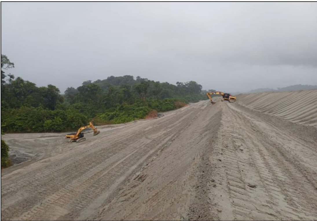
Figura 42 - Mantenimiento de banquetas WRP03, Muro Este
