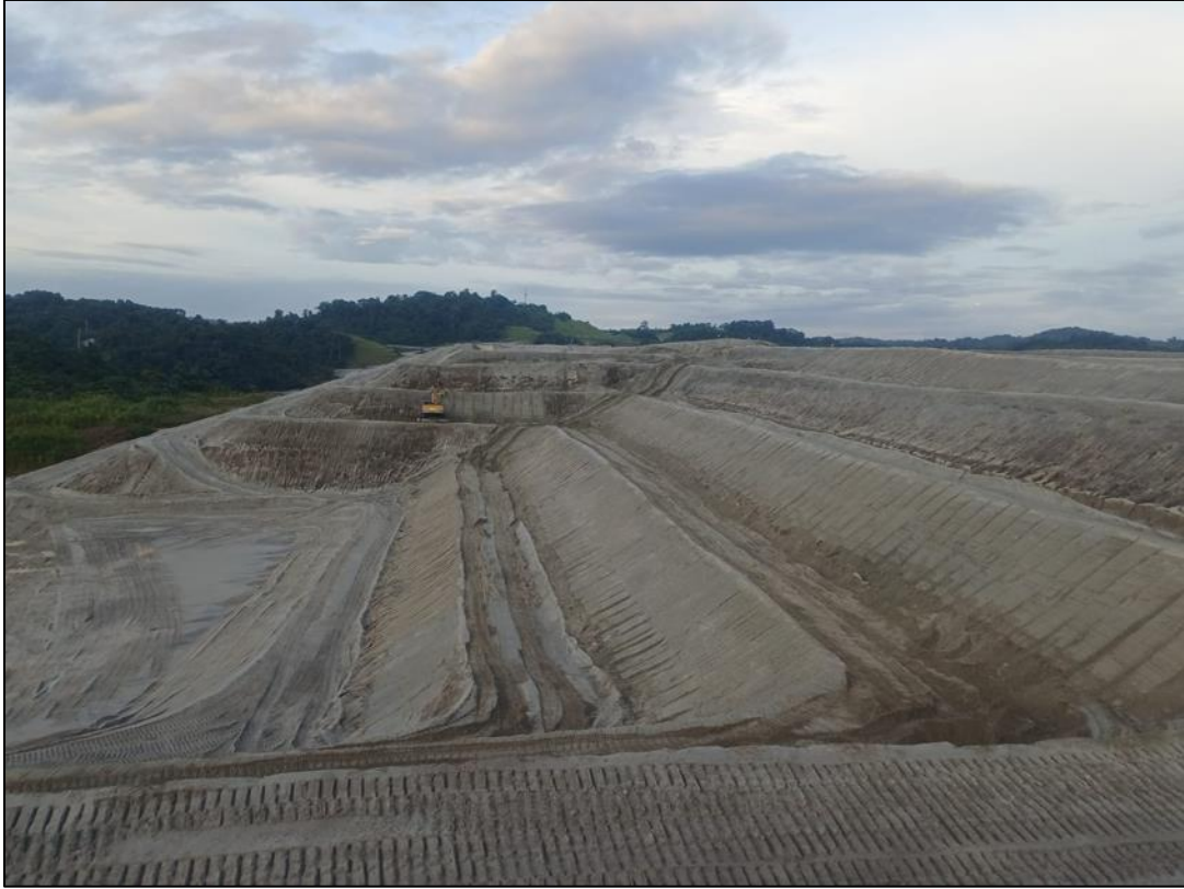
Figura 37 - Mantenimiento de banquetas Sector 2/3 en Muro Norte
