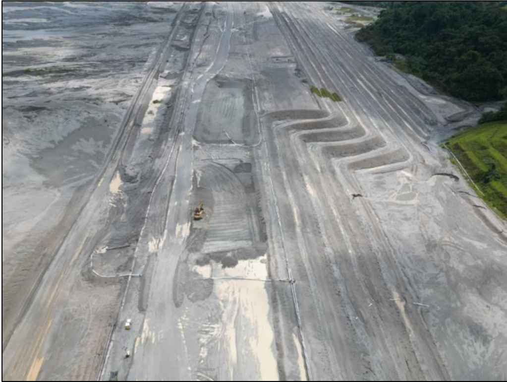
Figura 33 - Limpieza de sedimento en Celda 05, Muro Norte
