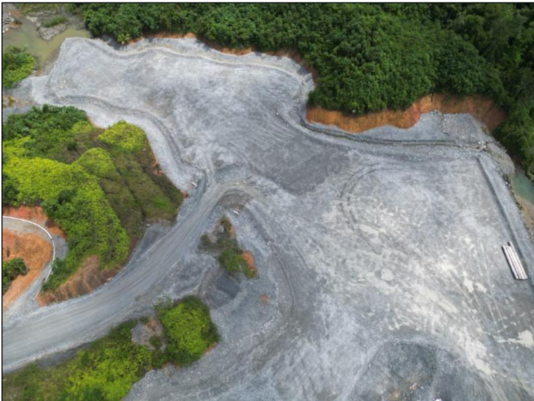
Figura 36 - Enrocado con Z7 PAG en WRP06, Muro Este
