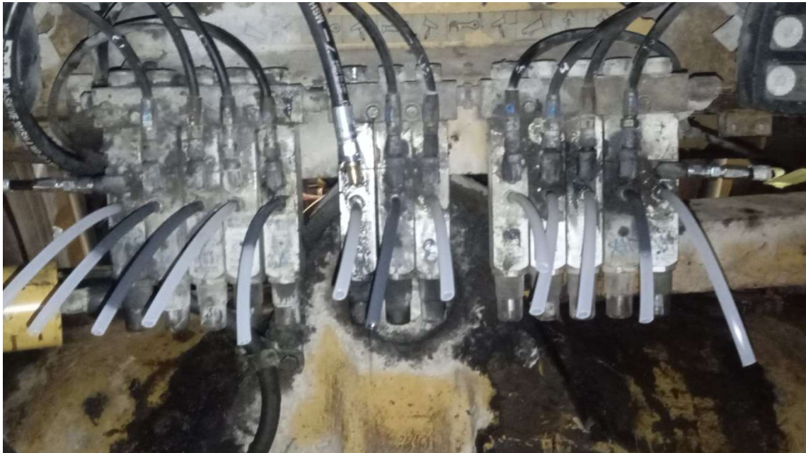
DTR003 Prueba volumétrica
