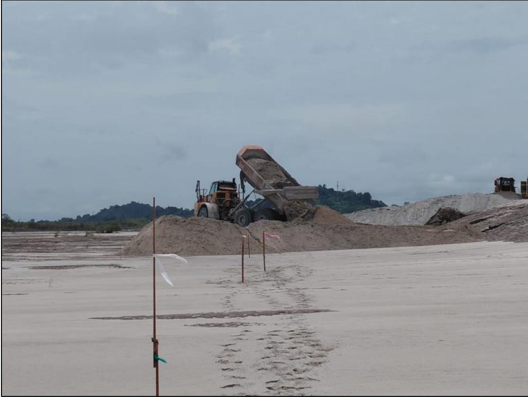
Figura 41 - Nivelación de Soporte en WRP05, Muro Este
