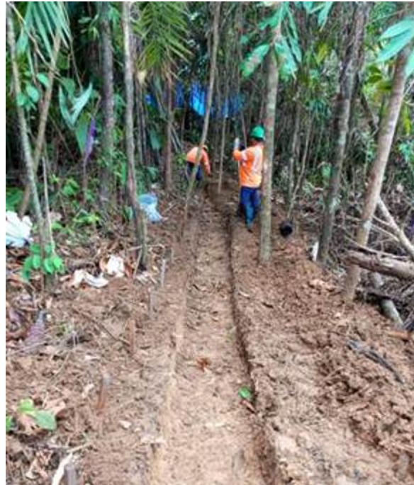
Fotografía 40. Construcción de canal para desvíos de escorrentías en talud Noroeste en Tajo Botija.
