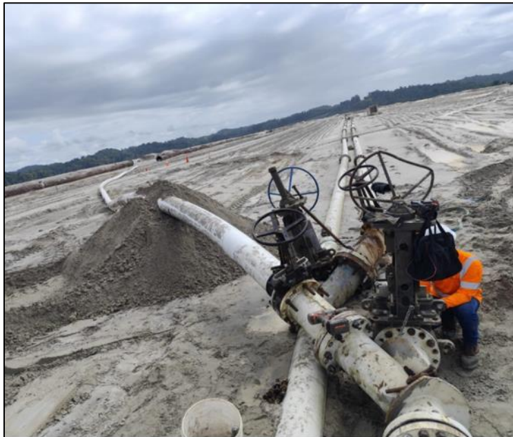
Figura 11 - Habilitación de Sistema de Descarga hacia soportes.
