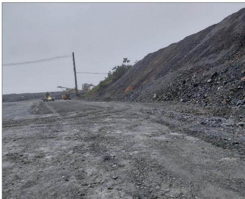
Estado vía reparada Acopio Media Ley
