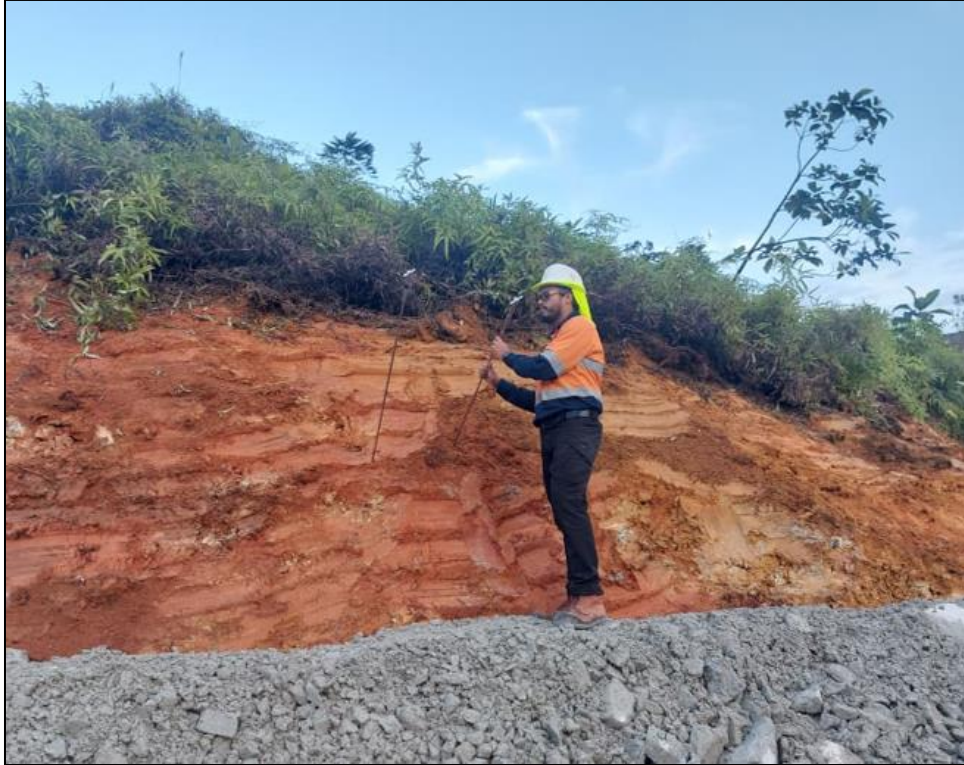
Figura 84 - Liberación de taludes en WRP6
