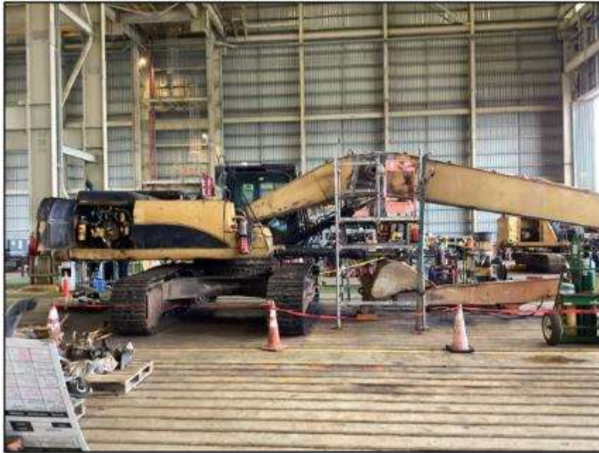
Reparación de Boom por fisuras en puntos de tensión.
