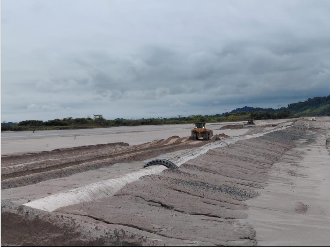
Figura 35 - Avances de relleno de soporte del WRP05, Muro Este
