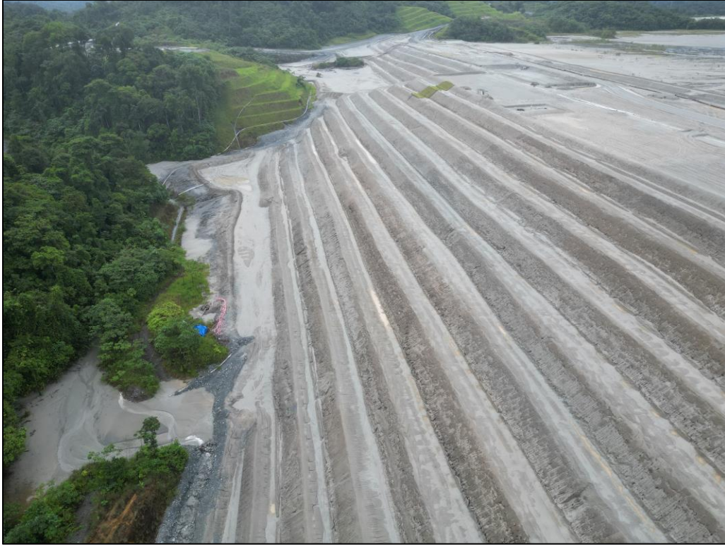
Figura 82 - Mantenimiento de Banquetas, Presa Norte Sector 01
