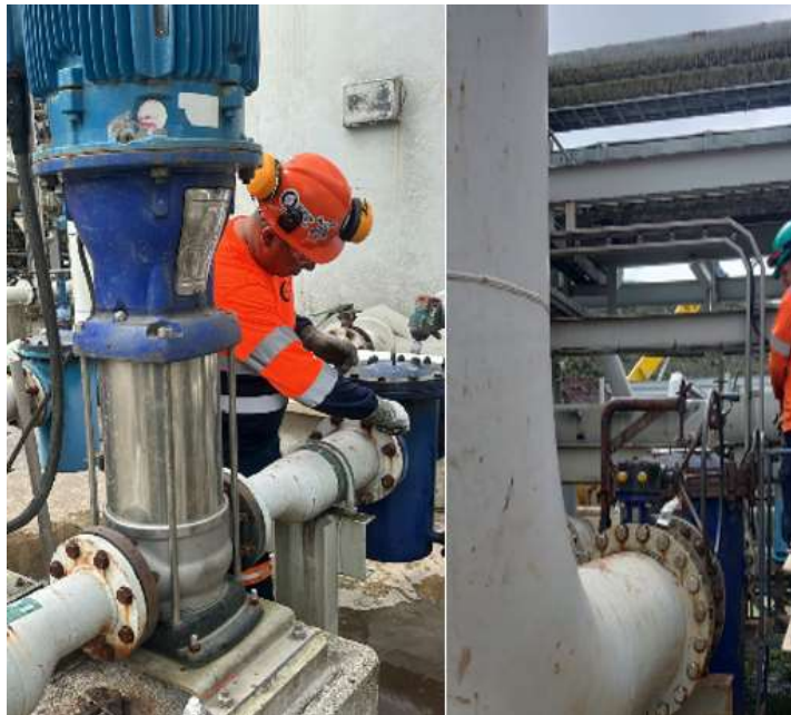
Ilustración 23 Coordinación de actividades mecánicas/limpieza de filtros.
