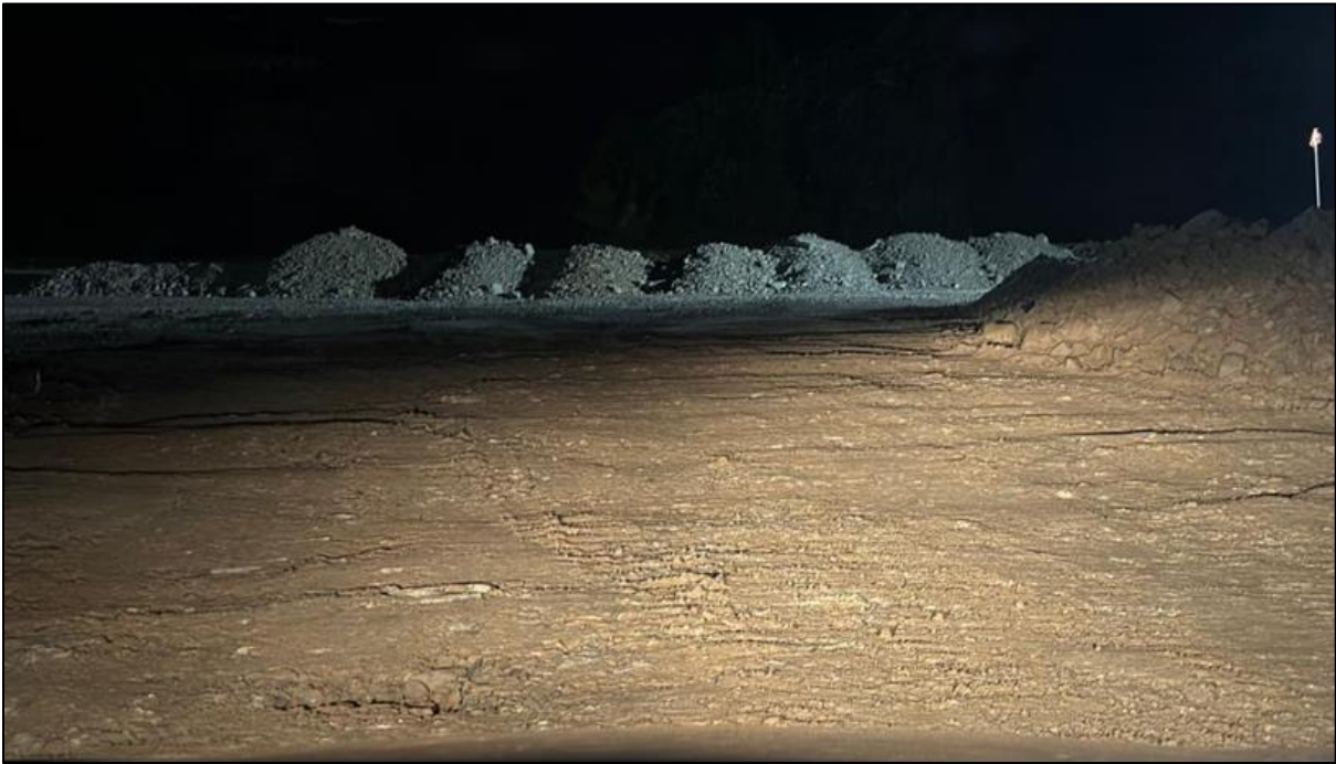
Figura 85 - Relleno de material Zona 7 en WRP6
