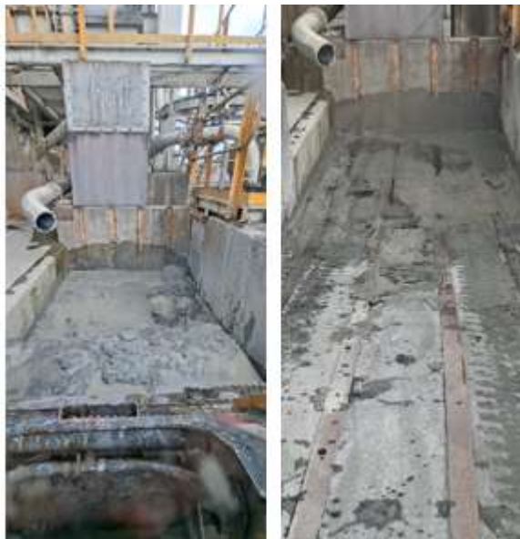
Ilustración 14 Limpieza de zona de sumidero (antes y después).
