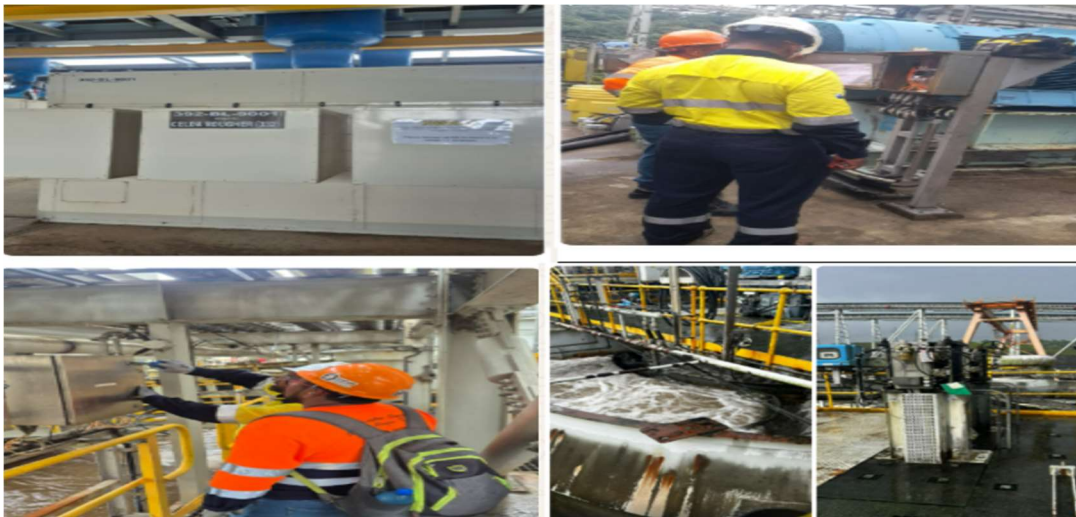
Ilustración 27 Inspección de trabajos críticos liderando el control y seguridad de los trabajos.
