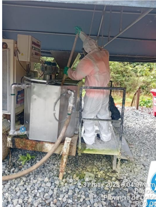
Fotografía 13. Sistema de mezclado en LDUs en RCO-04
