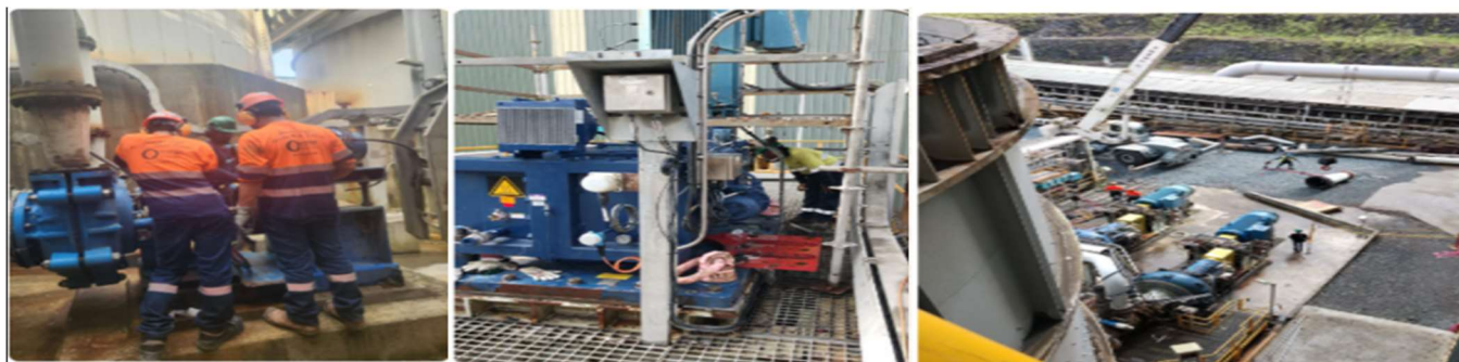
Ilustración 24 Coordinación de actividades mecánicas y eléctricas.
