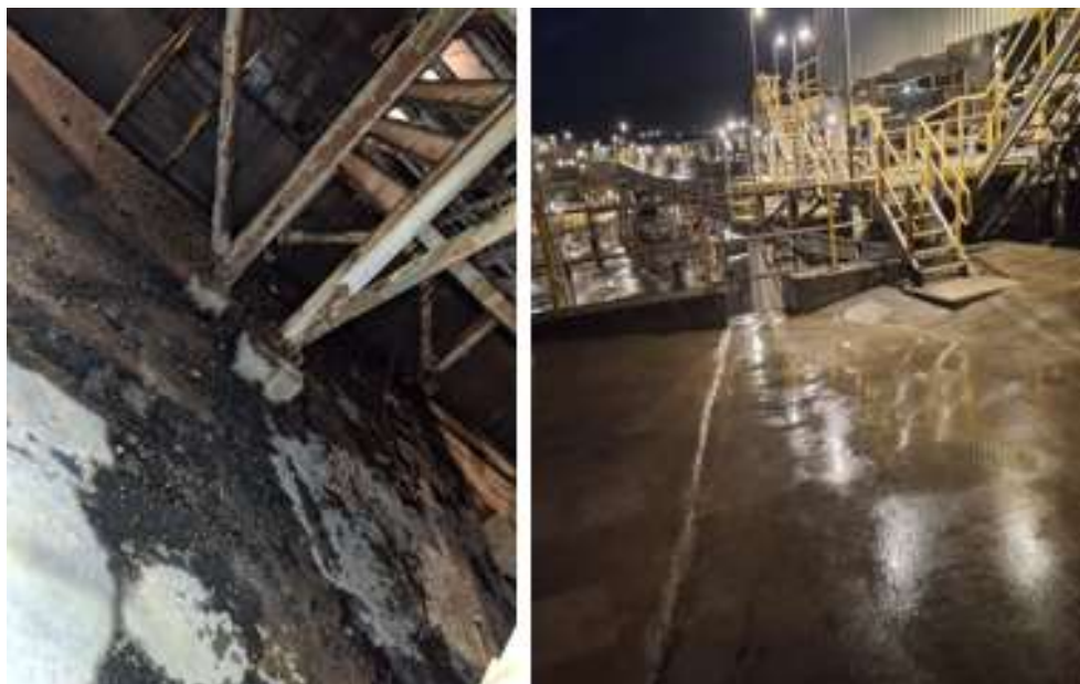
Ilustración 11 Limpieza de pisos y estructuras.
