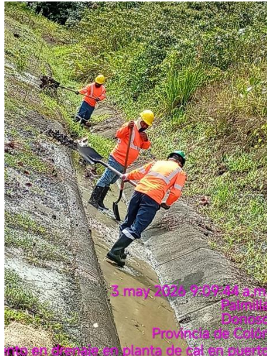
Fotografía 17. Limpieza drenaje de aguas escorrentías en la Planta de Cal.
