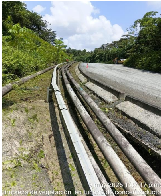
Fotografía 20. Registro después de la limpieza en el mineroducto.
