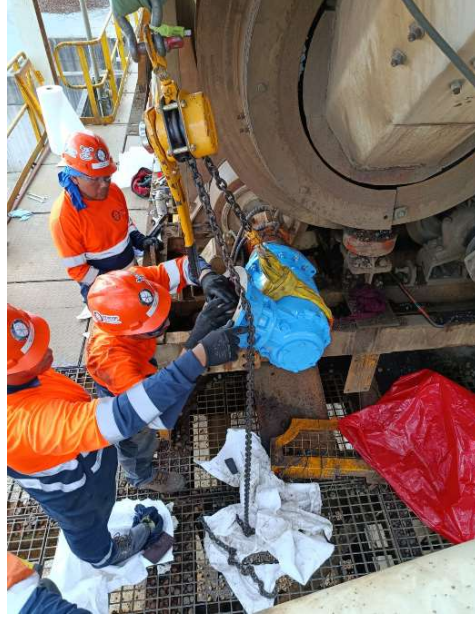
Ilustración 16 Instalación de nuevos reductor para el clasificador giratorio.
