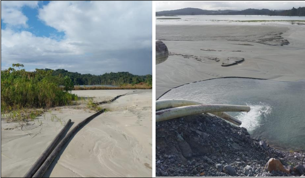
Figura 8 - Inspección de líneas de retorno de IRA02 y IRA03
