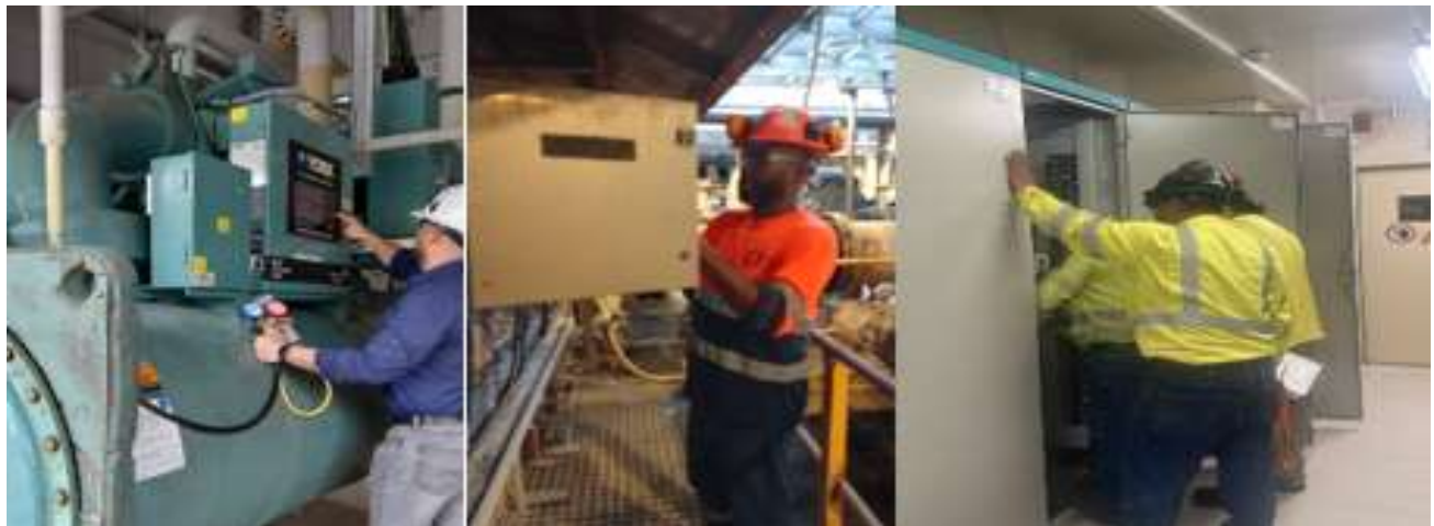
Ilustración 2 Monitoreo de equipos durante pruebas en área molinos.
