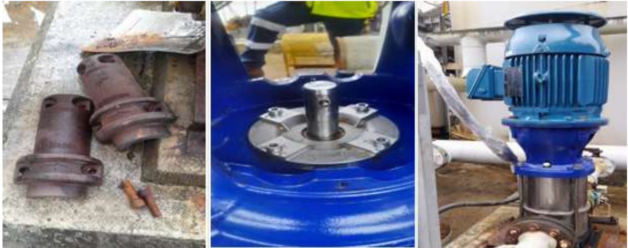
366-pp-9018 Remplazo de bomba y elementos
