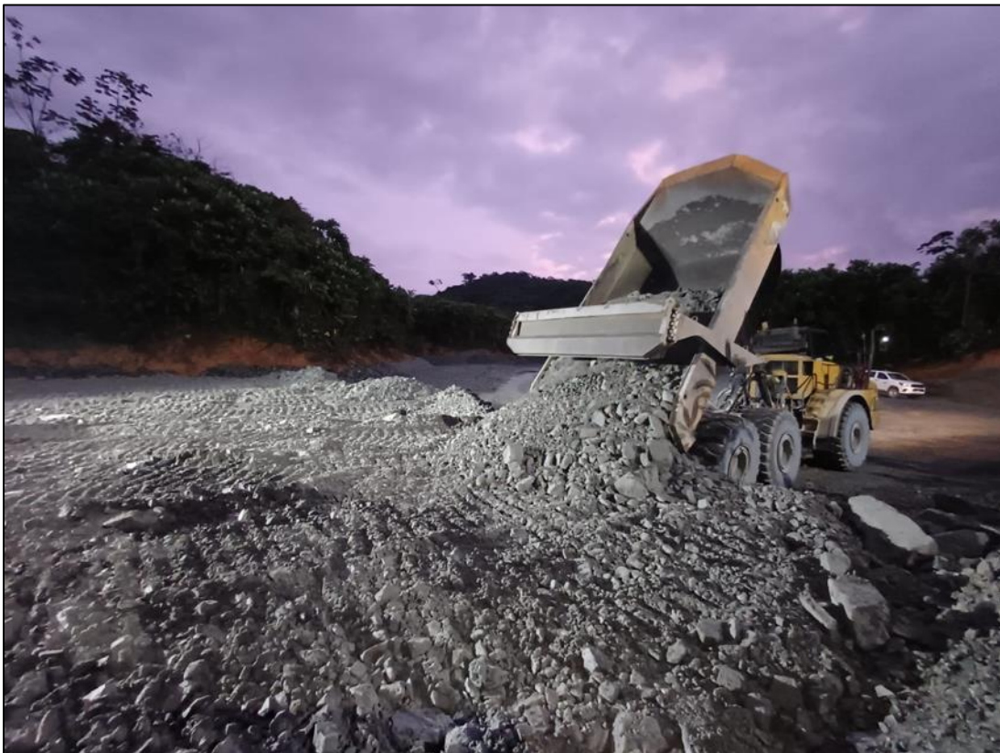
Figura 38 - Control y manejo de aguas en WRP06, Muro Este
