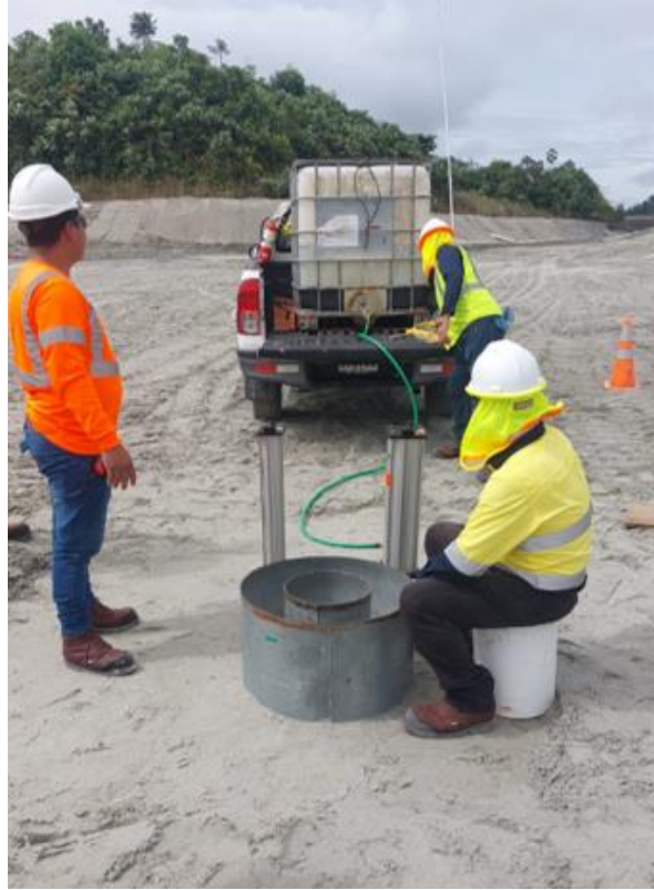
Figura 86 - Ensayo de Infiltración en Muro Este, Celda 33/34 Aguas abajo
