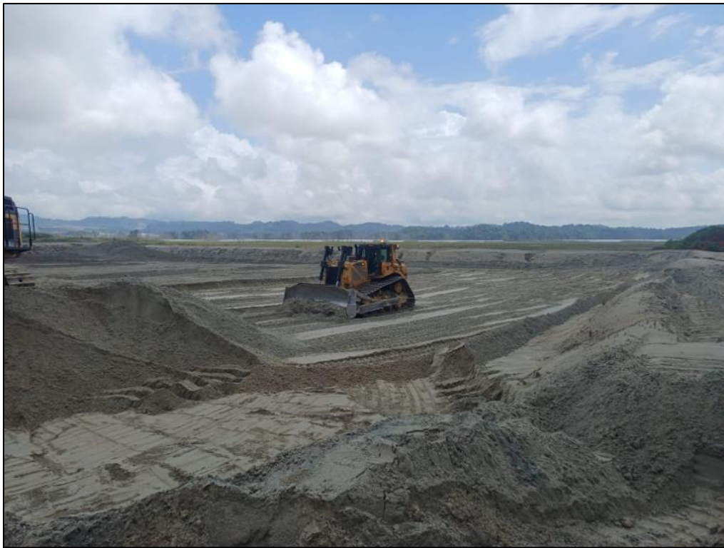
Figura 34 - Mantenimiento de banquetas WRP01, Muro Este
