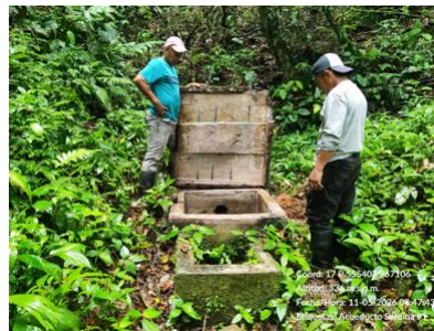
Inspección a acueducto de Miguel de la Borda
