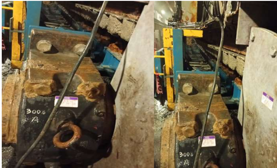
Ilustración 22 Limpieza de alimentadores para entrega a mantenimiento mecánico.
