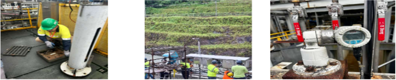
Ilustración 26 Coordinación de revisión de funcionamiento de sub sistemas luego de trabajos.
