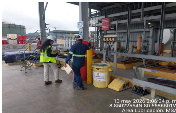
Fotografía 23. Registro en Inspección Ambiental Interna en el área de Lubricación MSA
