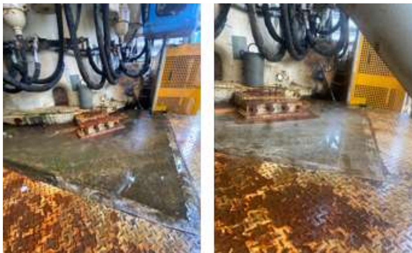
Ilustración 15 Limpieza de estructuras con hidrolavadora (antes y después).
