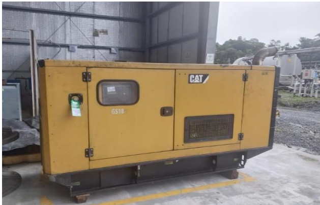
GS-189 Recuperación de Generador D110 Cambio de generador y exitatris.
