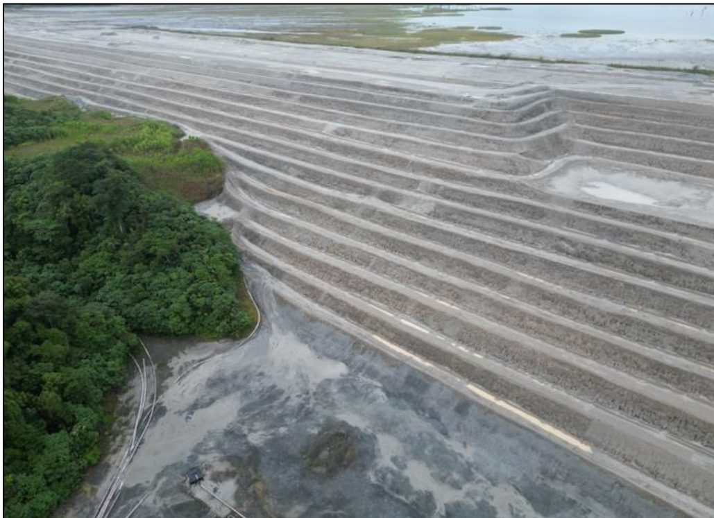
Figura 83 - Reparación de erosión en Muro Este, Celda 23 Aguas Abajo.
