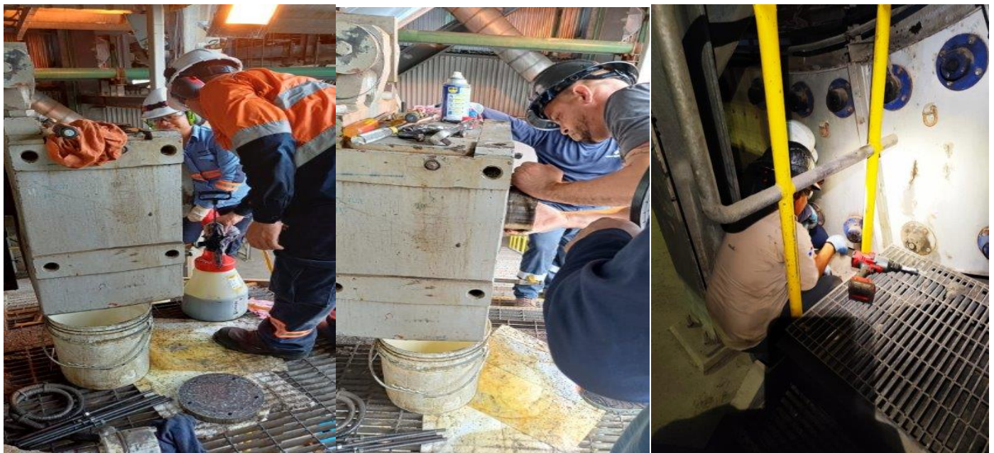
Mantenimientos Preventivos en el Reclamador de Carbon y Cajas Reductoras Drycon
