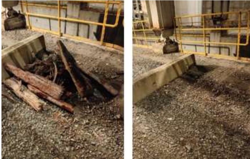
Ilustración 13 Limpieza y remoción de troncos extraídos de los alimentadores.
