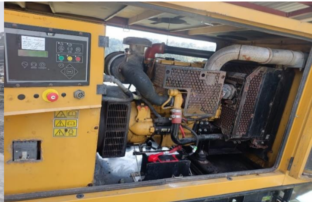
GS-189 Recuperación de Generador D110 Cambio de generador y exitatris.
