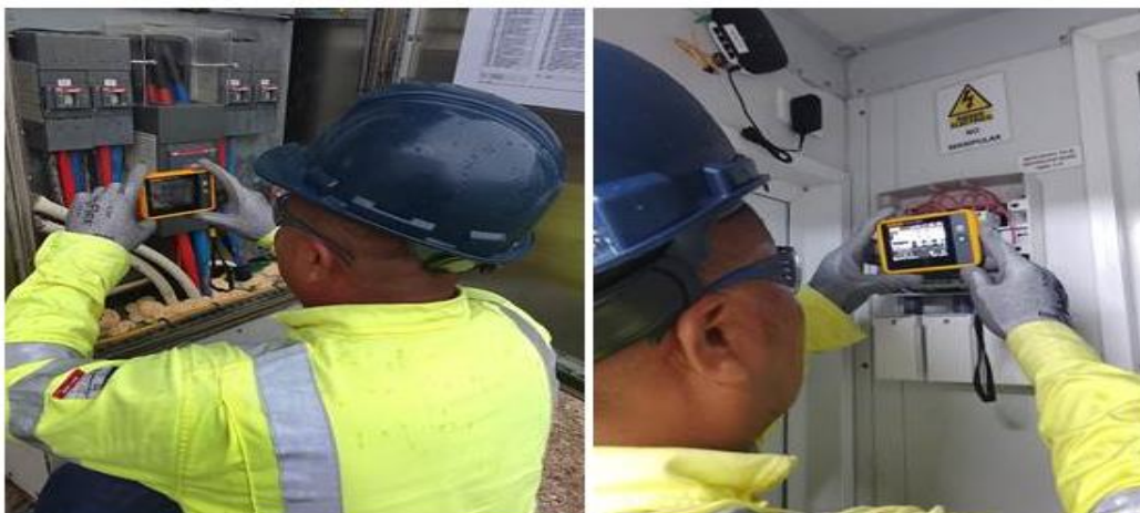
Termografía en Tableros de Distribución Cocina Cobre
