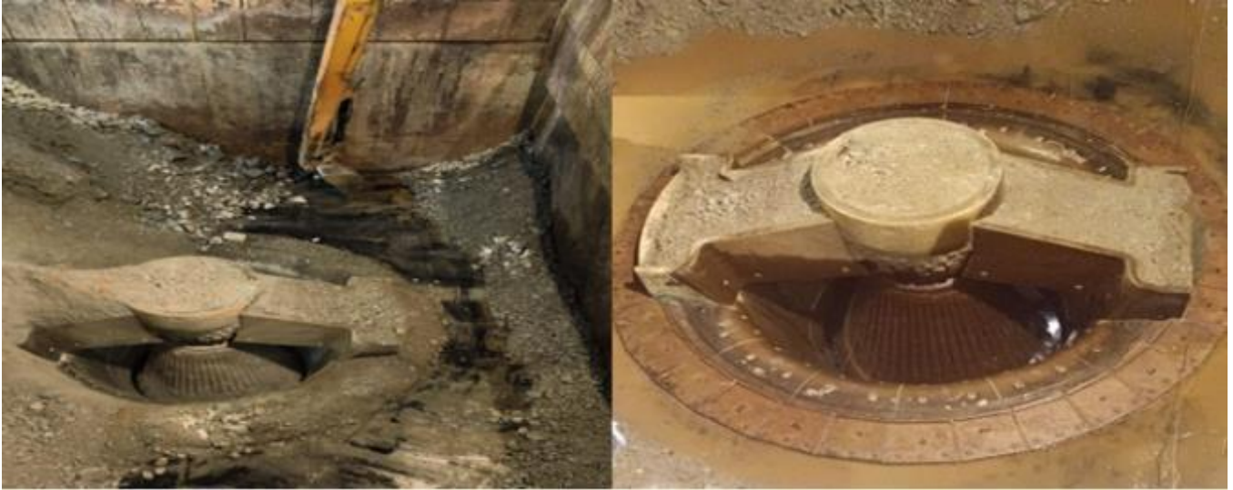
Ilustración 19 : limpieza de mineral en tolva de trituradora 3 para realizar mantenimiento de la trituradora.
