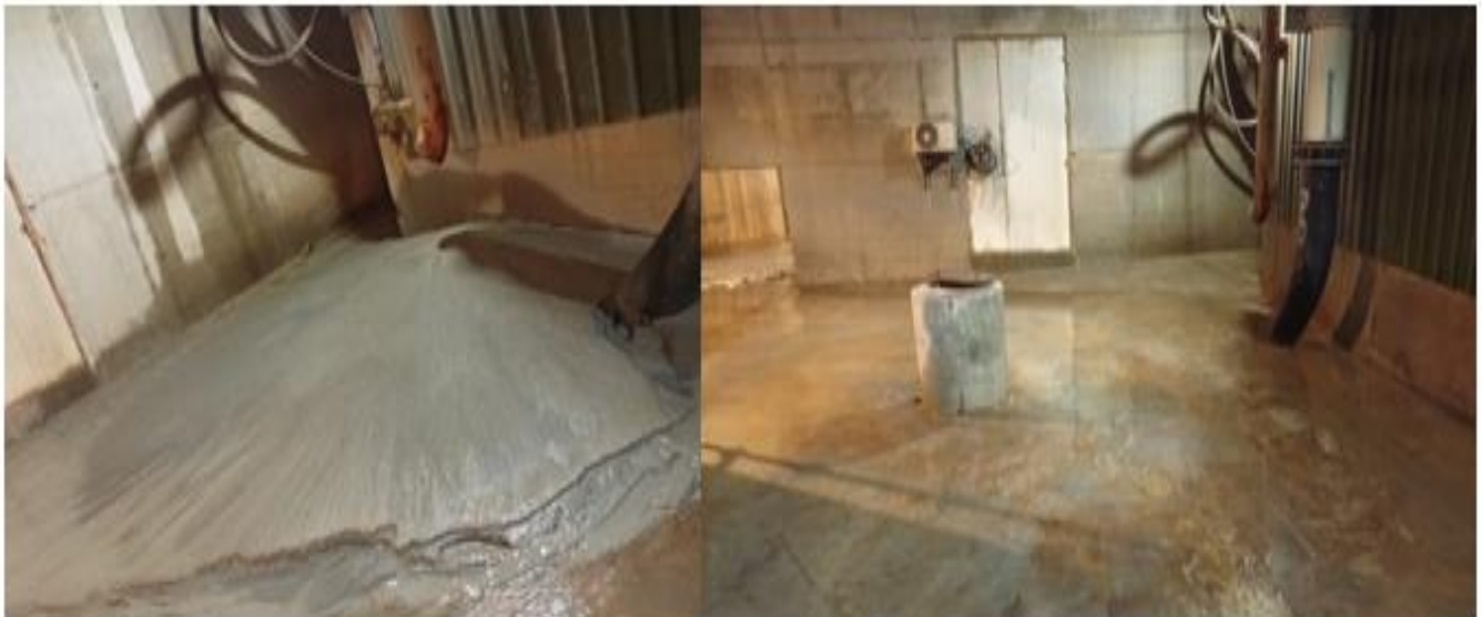
Ilustración 20 Limpieza de sedimentos (antes y después).
