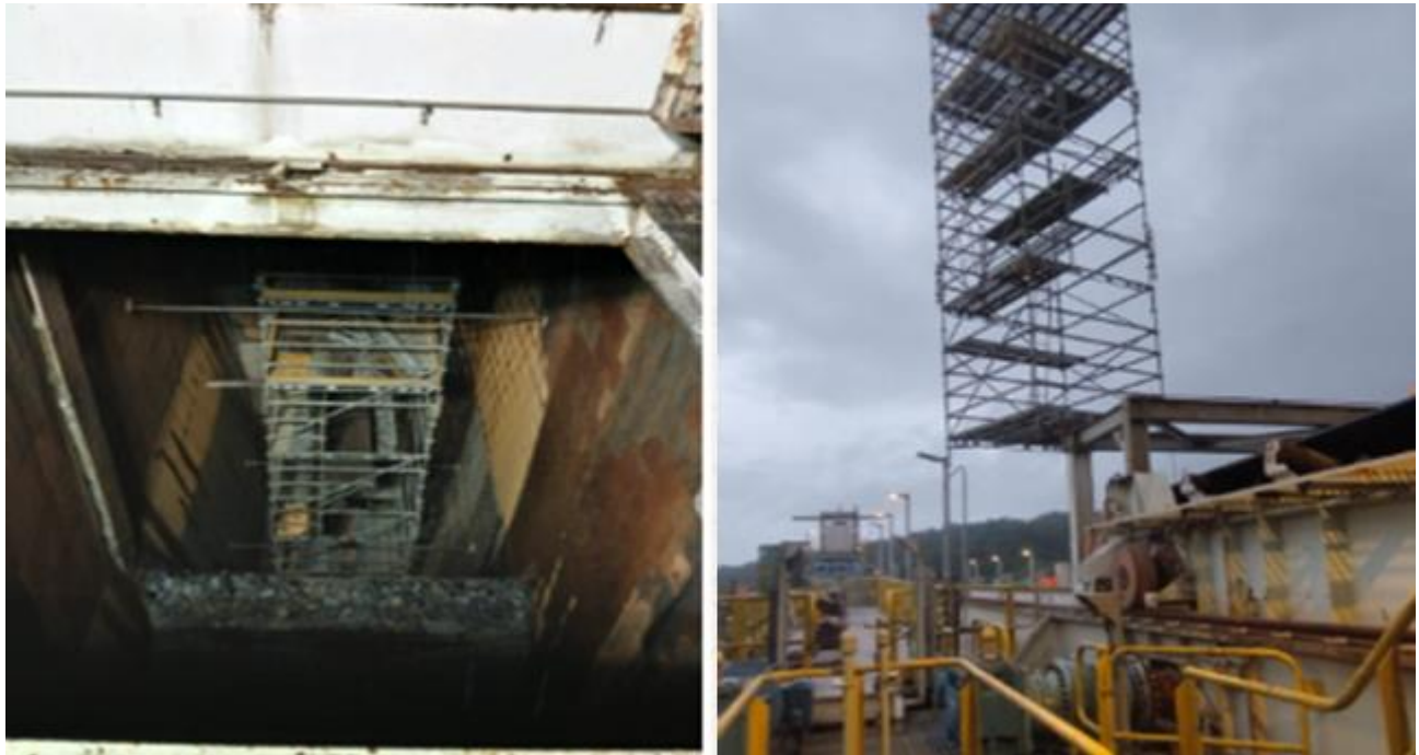
Ilustración 17 Instalación de nuevos revestimientos y mantenimiento del contenedor (BIN) 4 de secundaria para dejarlo disponible para el paso del material rocoso.
