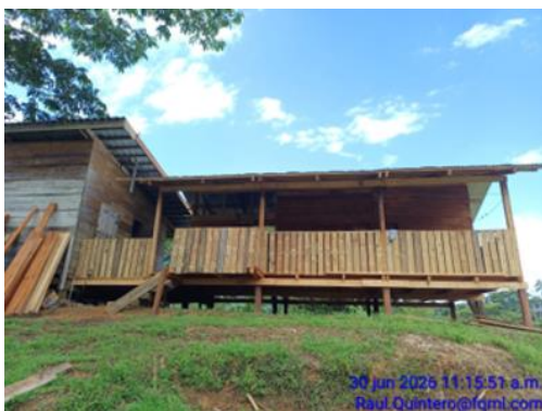
Programa de mejoras construcción de casa de docentes - Nueva Esperanza
