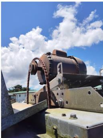
Reemplazo de Correas a Sistema de Extracción
