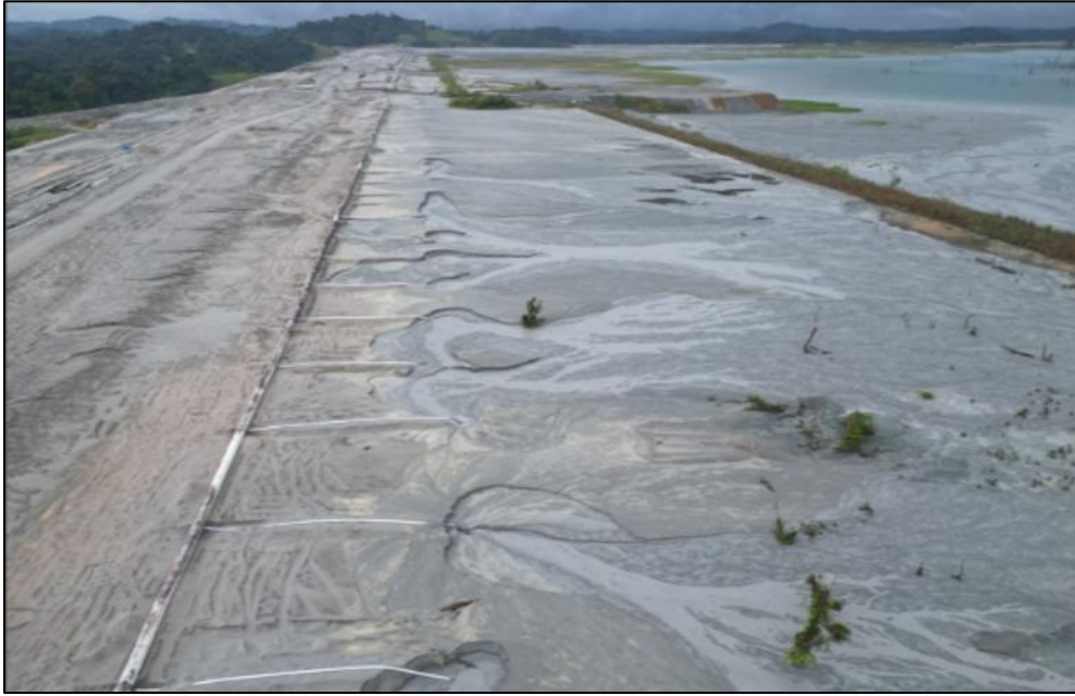
Figura 6 - Monitoreo de Descarga de Relaves, Muro Norte, Sector 4.
