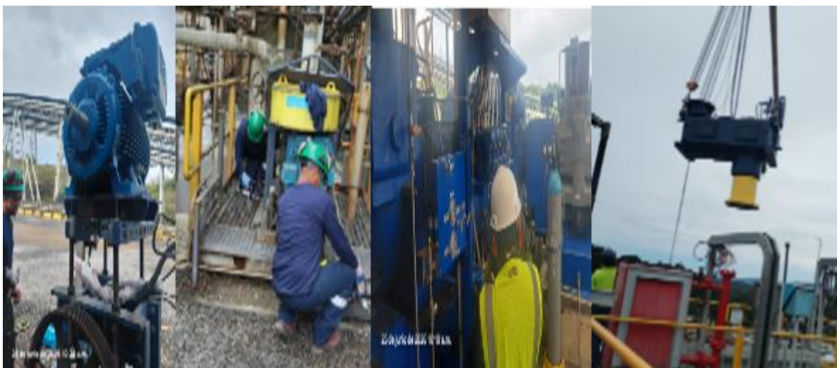
Ilustración 28 mantenimiento programado de equipos
