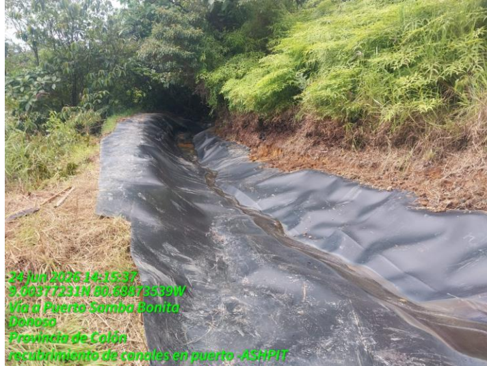
Fotografía 40. Impermeabilización de canal para desvíos de escorrentías en talud del AshPit
