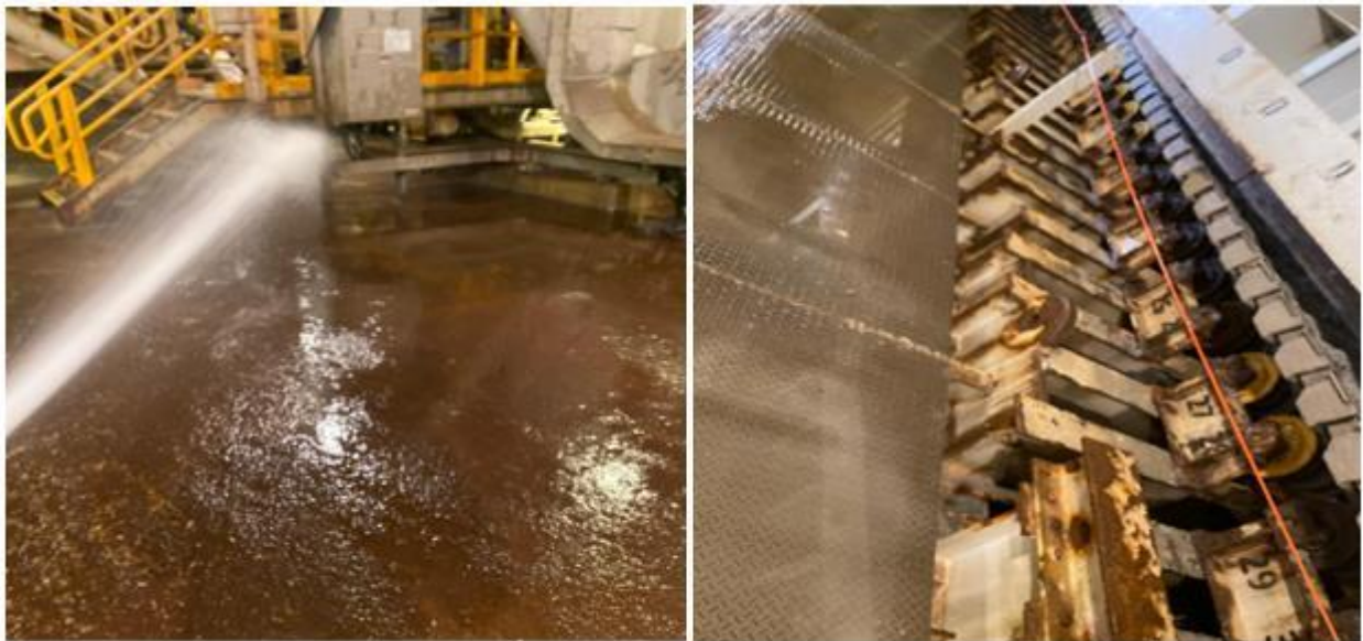
Ilustración 12 Limpieza de estructuras de escaleras y alimentador de secundaria
