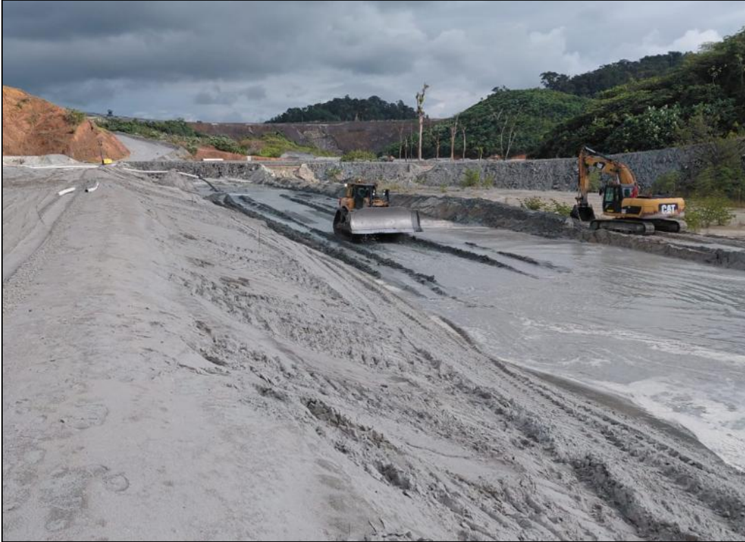
Figura 35 - Mantenimiento de banquetas WRP02, Muro Este
