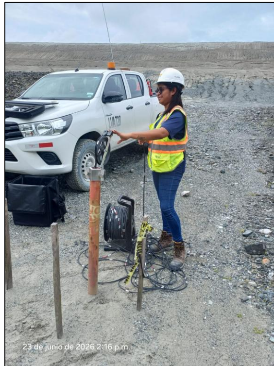
Figura 87 - Lectura de instrumentación geotécnica (Piezómetro e inclinómetro)
