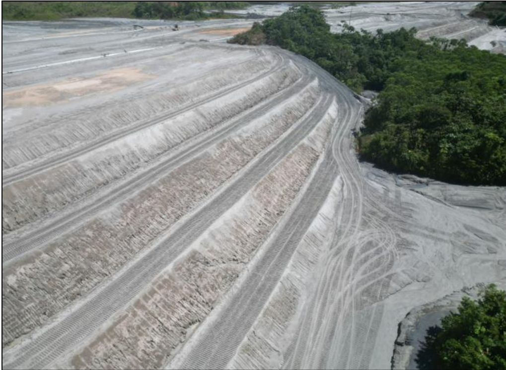
Figura 77 - Mantenimiento de Banquetas, Muro Este WRP3.
