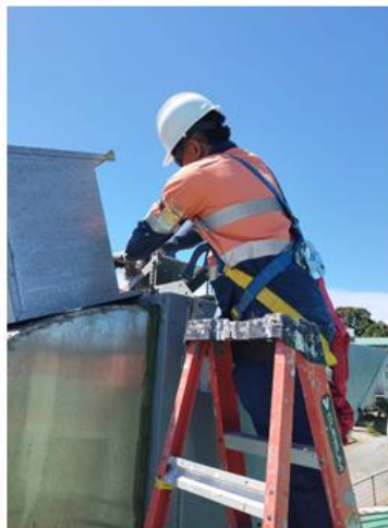
Reemplazo de Correas a Sistema de Extracción
