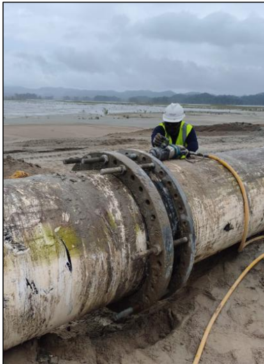
Figura 7 - Inspección de líneas de polietileno de alta densidad (HDPE) en toda el área.
