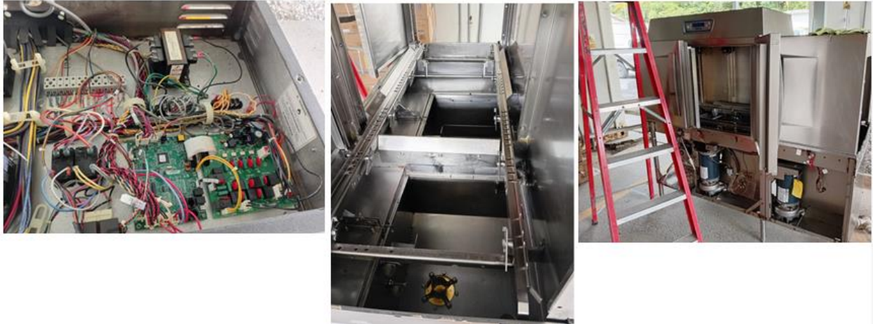
Reparación de Lavaplatos Hobart de Cobre
