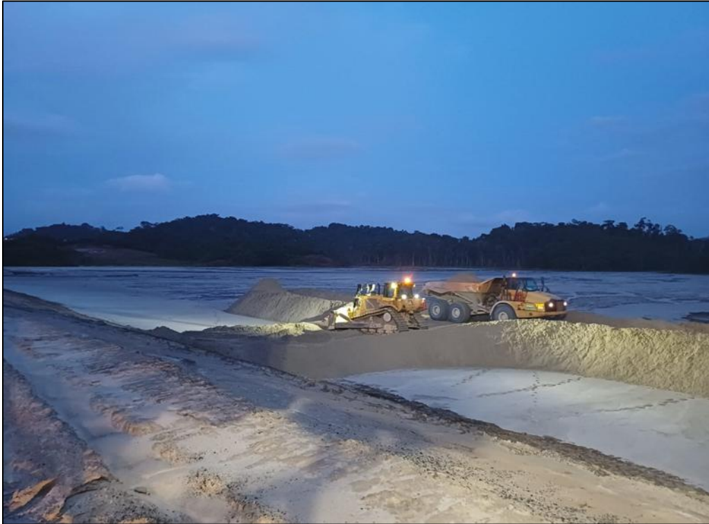
Figura 29 - Nivelación de Soporte en WRP05, Muro Este
