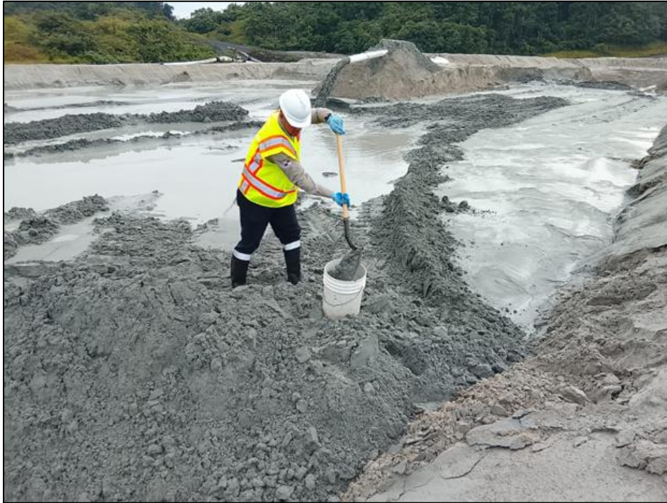
Figura 85 - Toma de muestra para monitoreo de % de finos en Granja, Muro Norte, Celda 06 Cresta
