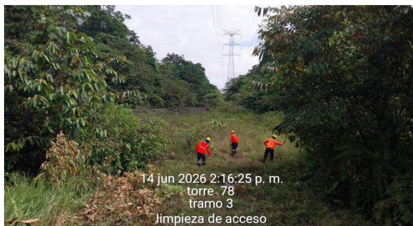
Fotografía 46. Evidencia de limpieza de vegetación en acceso de la torre 78N
