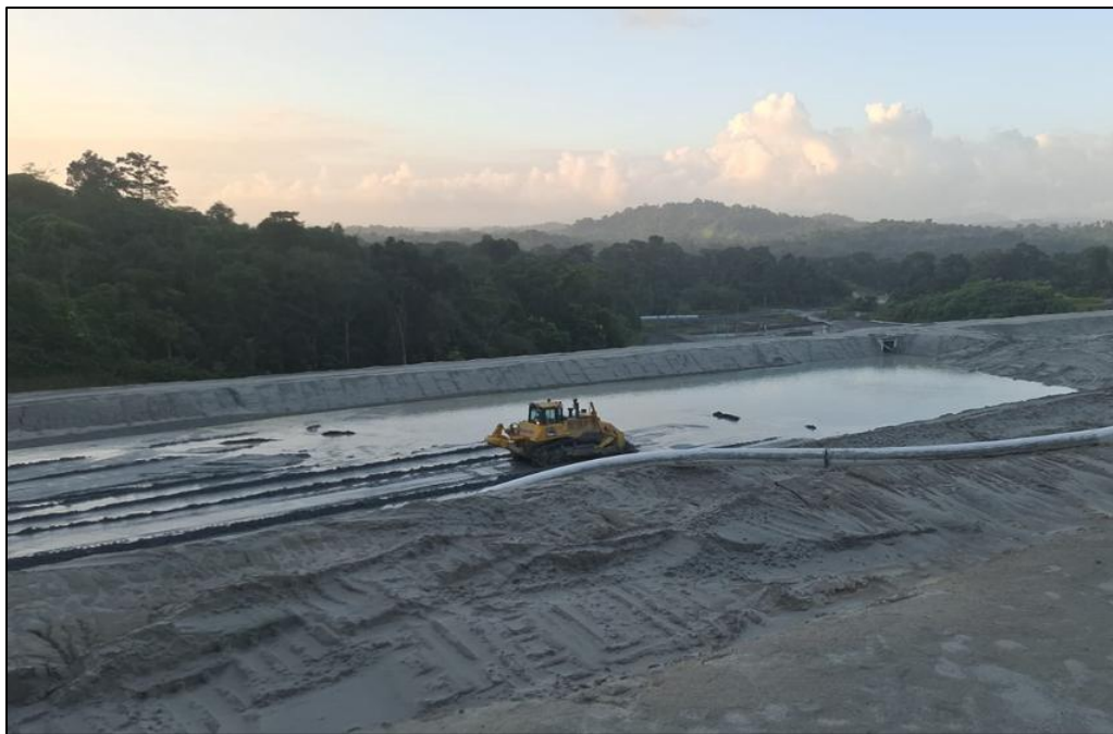
Figura 30 - Descarga hidráulica de arena cicloneada, Sector 4, Muro Norte
