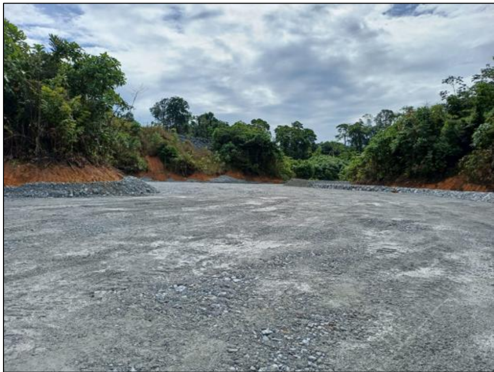
Figura 80 - Relleno de material Zona 7 en WRP6
