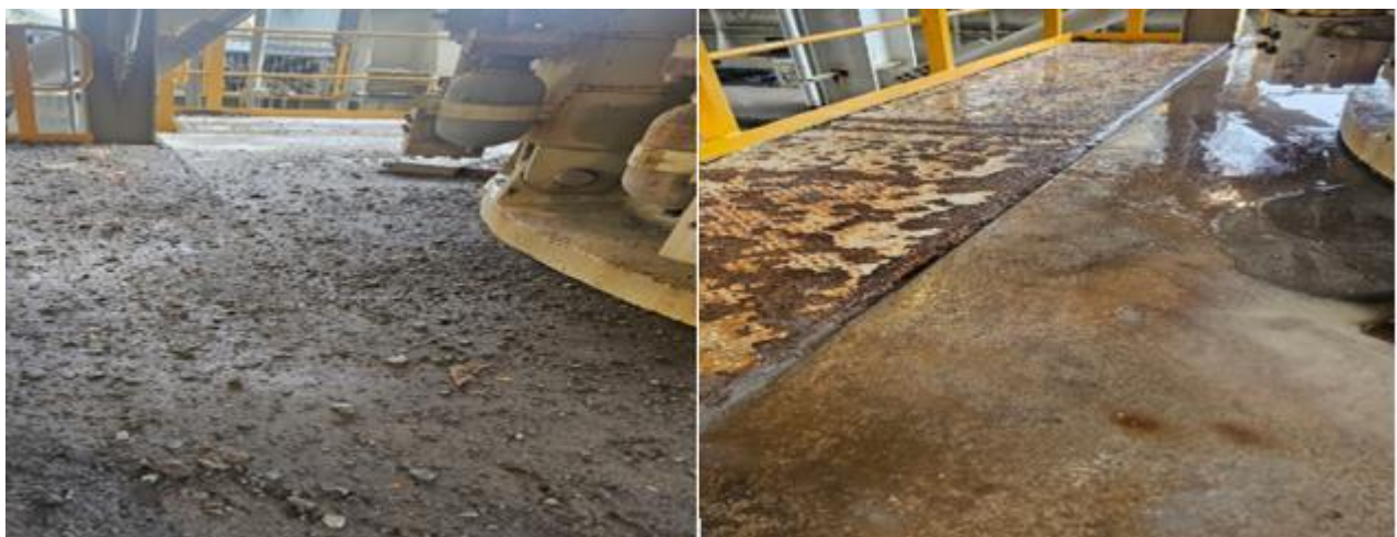
Ilustración 13 Remoción de sedimentos en el área de la trituradora secundaria 1 (antes y después).
