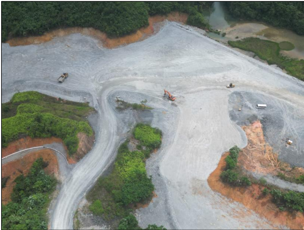
Figura 32 - Enrocado con Z7 PAG en WRP06, Muro Este
