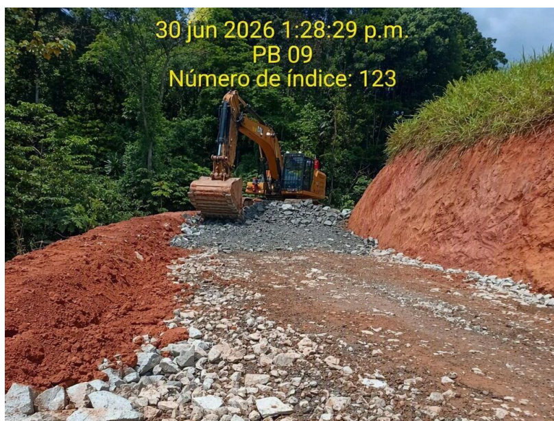
Fotografía 38. Adecuación de acceso hacia el PB-9
