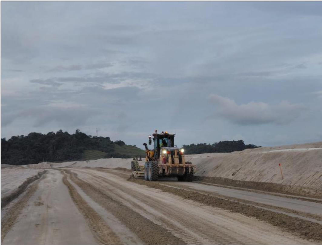
Figura 37 - Mantenimiento de vías, Muro Norte
