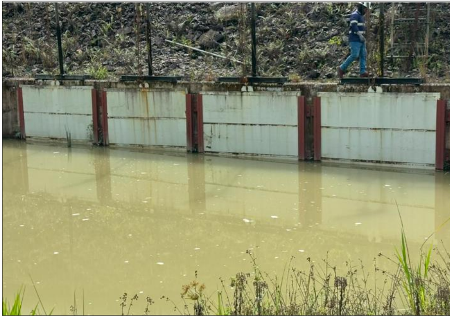
Figura 4 - Inspección de funcionalidad de Compuerta PB05/09
