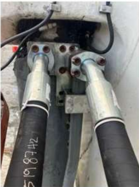
EXL-0004 Reemplazo de líneas hidráulicas
