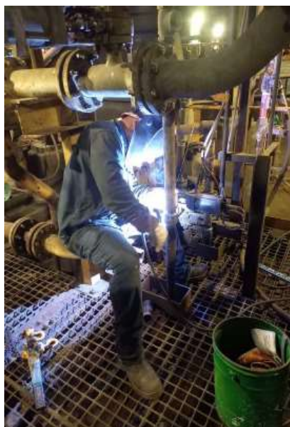
Fabricación de tubería Espesador - CUCON FILTRATION
