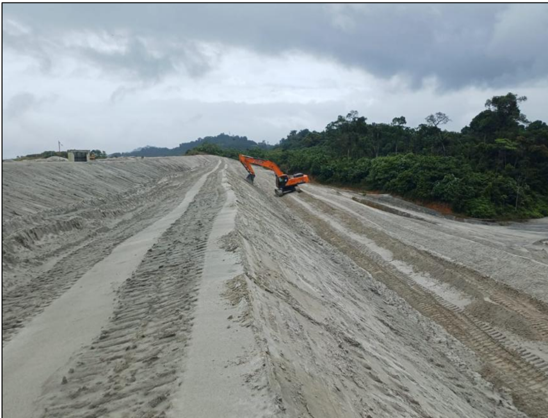
Figura 36 - Mantenimiento de banquetas en WRP03, Muro Este
