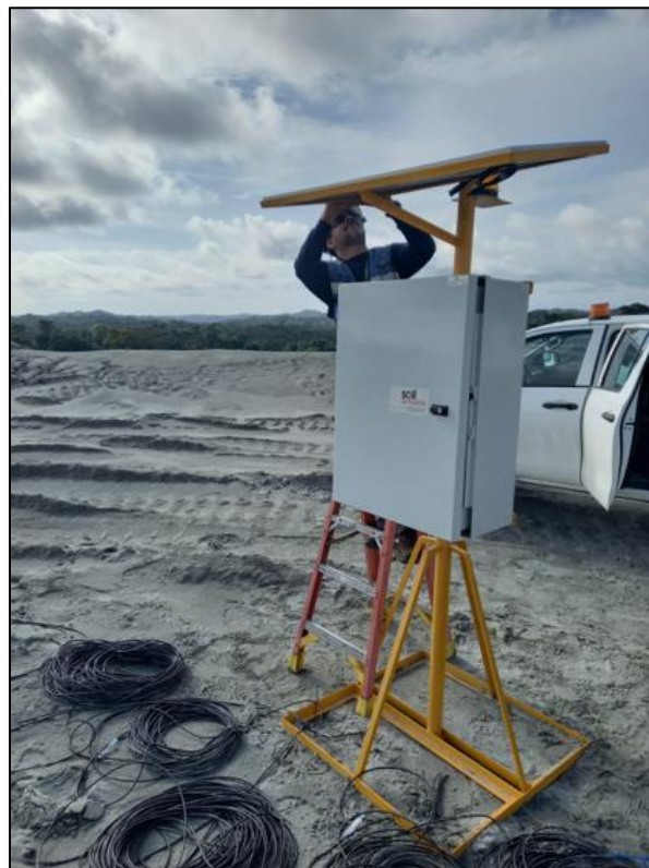
Figura 86 - Instalación de Estación Telemétrica, Muro Norte, Celda 19 Cresta
