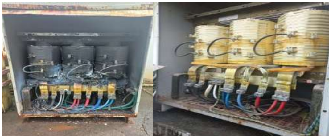
Mantenimiento y Reparación de panel eléctrico de campamento GV.
