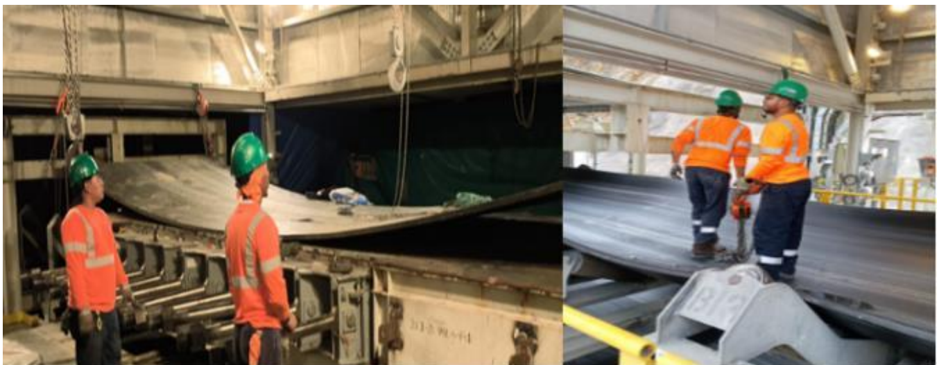
Ilustración 4 Reemplazo de faja de alimentación de la pila de acopio y faja de la descarga de la trituradora primaria 3
