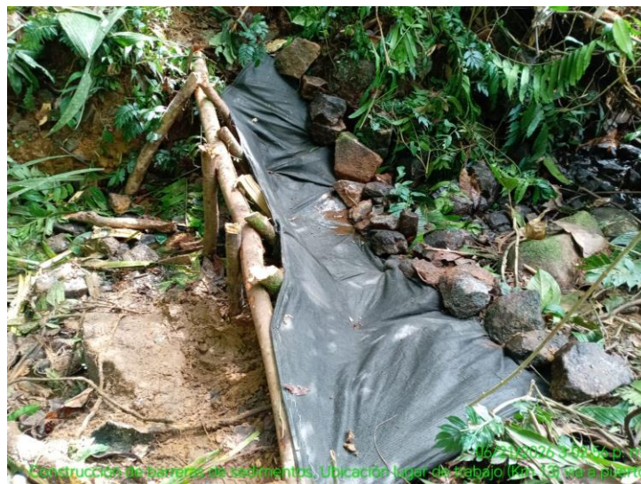
Fotografía 42. Construcción final de segunda barrera para sedimentos
