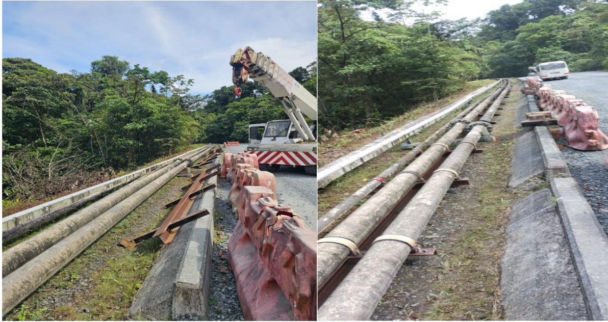
Instalaciones de soportes para tuberías KM13.
