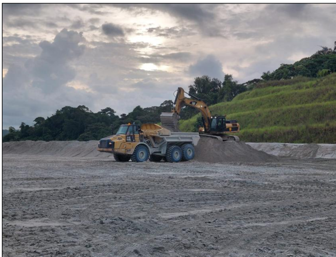
Figura 34 - Limpieza de sedimentos en Sector 1, Muro Norte.
