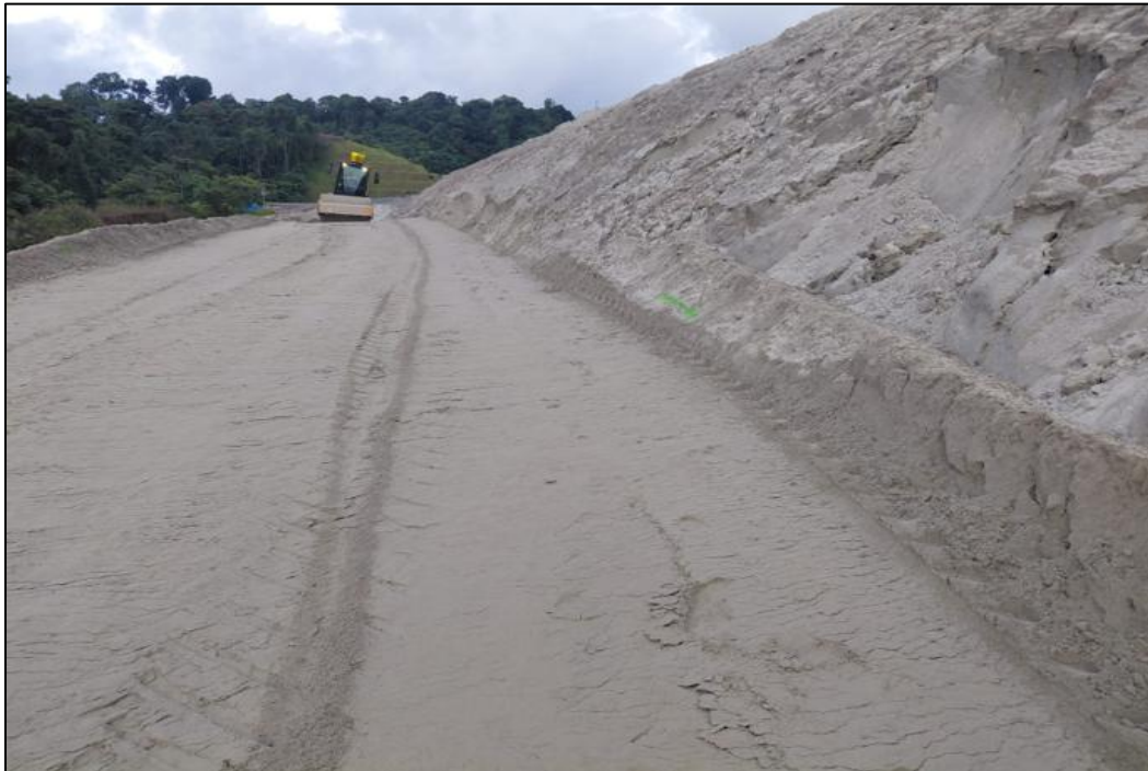
Figura 78 - Reparación de erosión en Muro Norte, Celda 10 Aguas Abajo.
