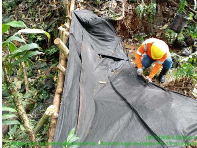
Fotografía 41. Construcción de barreras para sedimentos en km 13 + 000
