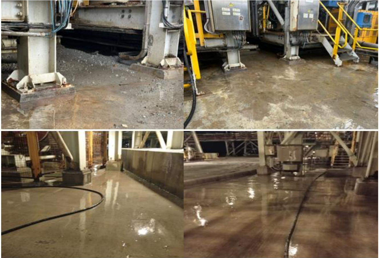
Ilustración 16 Limpieza de piso y estructuras con hidrolavadora. (antes y después).
