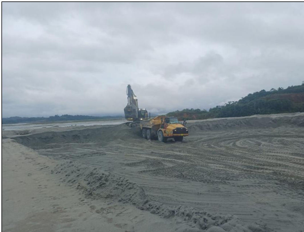
Figura 33 - Carguío de arena mecánica en Muro Este.
