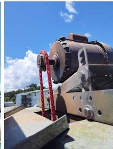
Reemplazo de Correas a Sistema de Extracción
