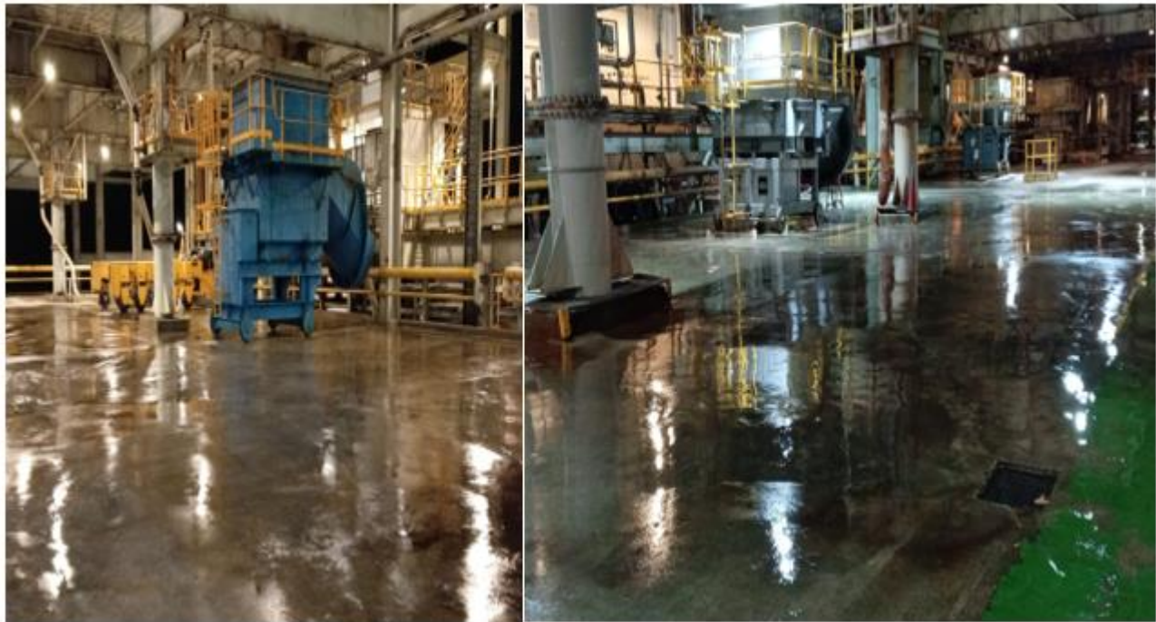
Ilustración 21 Limpieza de estructuras y pisos de molinos.
