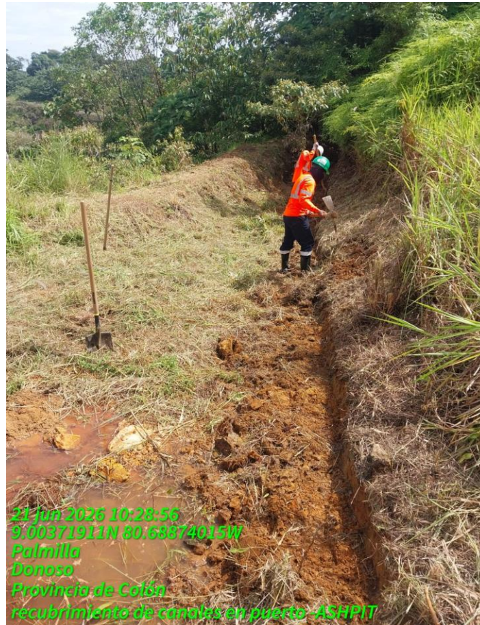
Fotografía 39. Conformación de canal para manejo superficial de agua en taludes del AshPit
