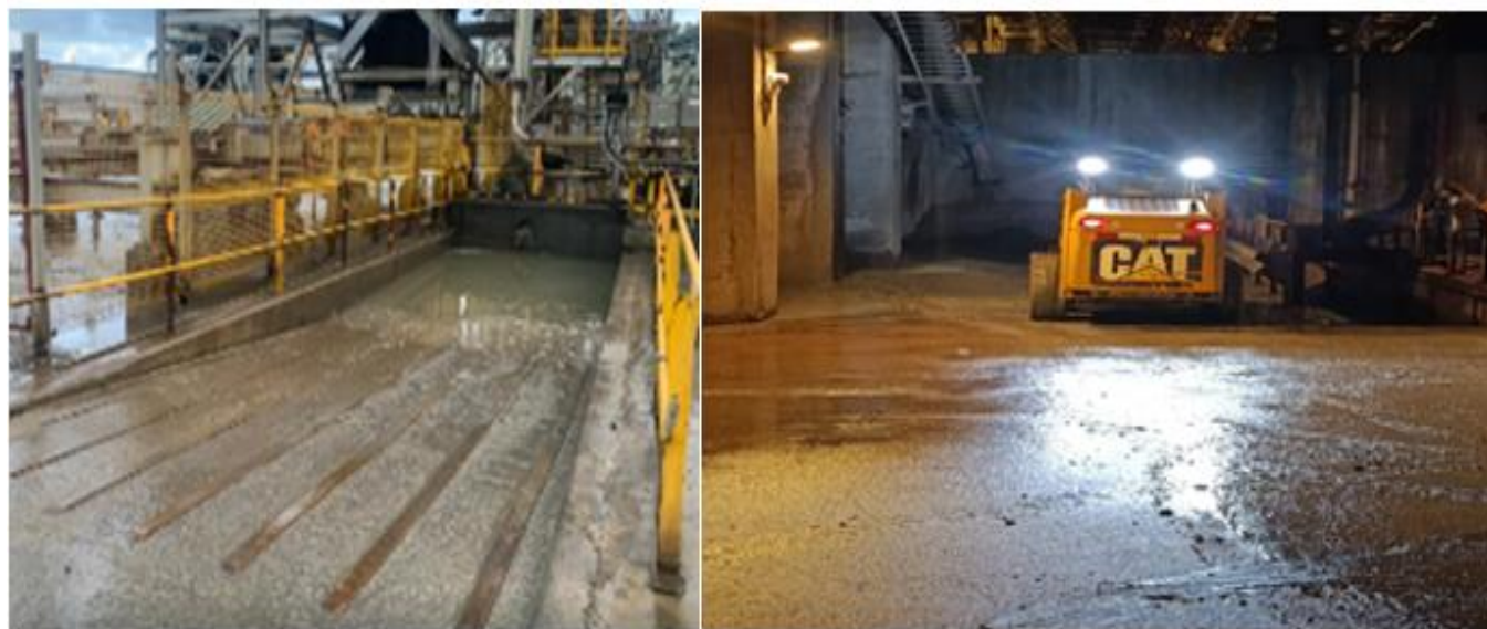
Ilustración 15 Limpieza de zona de sumidero.
