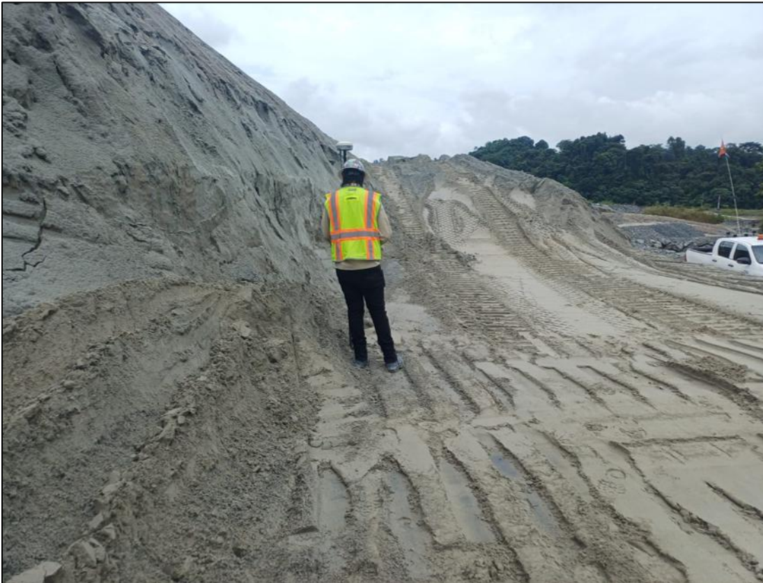
Figura 37 - Mantenimiento y reparación de erosiones en NDS1, Muro Norte
