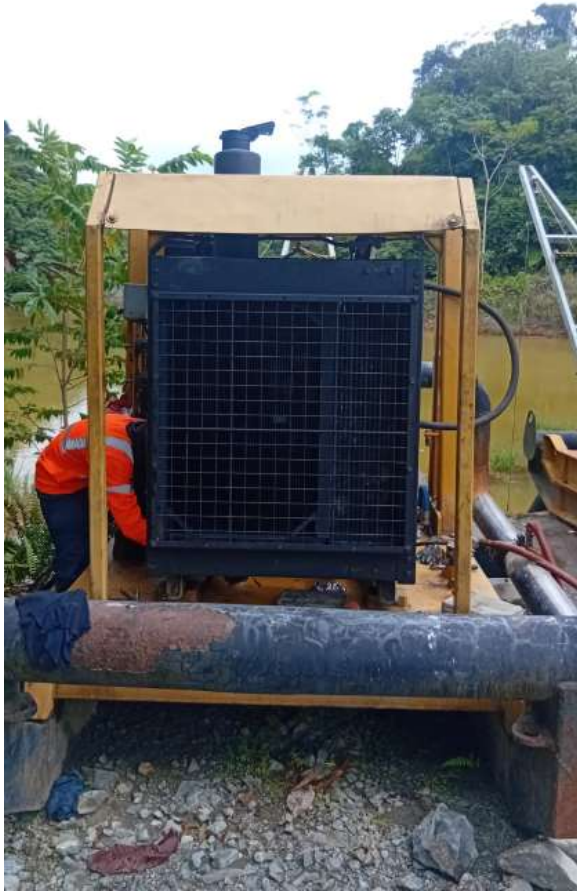
Reemplazo de radiador por fuga DWP003 2
