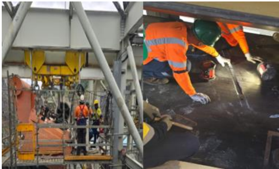
Ilustración 17 Reparaciones de fajas transportadoras y equipos.
