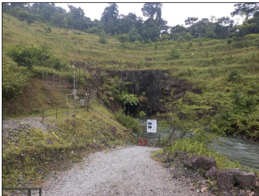
Figura 73 - Los taludes de la salida de descarga (túnel) se encuentra en buen estado
