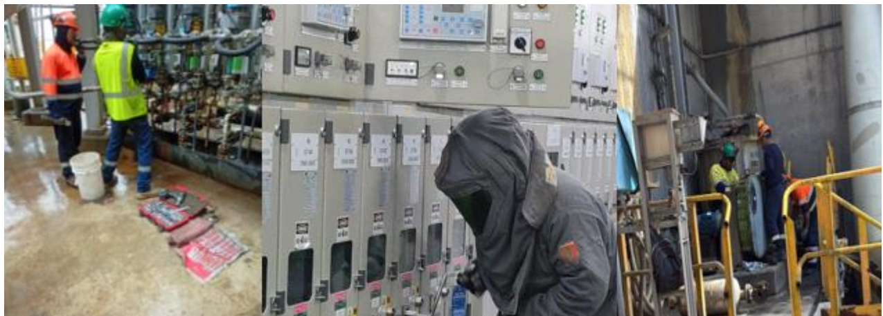
Ilustración 23 Coordinación de actividades mecánicas y eléctricas.
