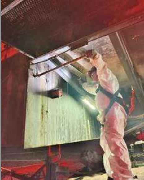
SHE-0000-002 Reemplazo de tornillería de chasis
