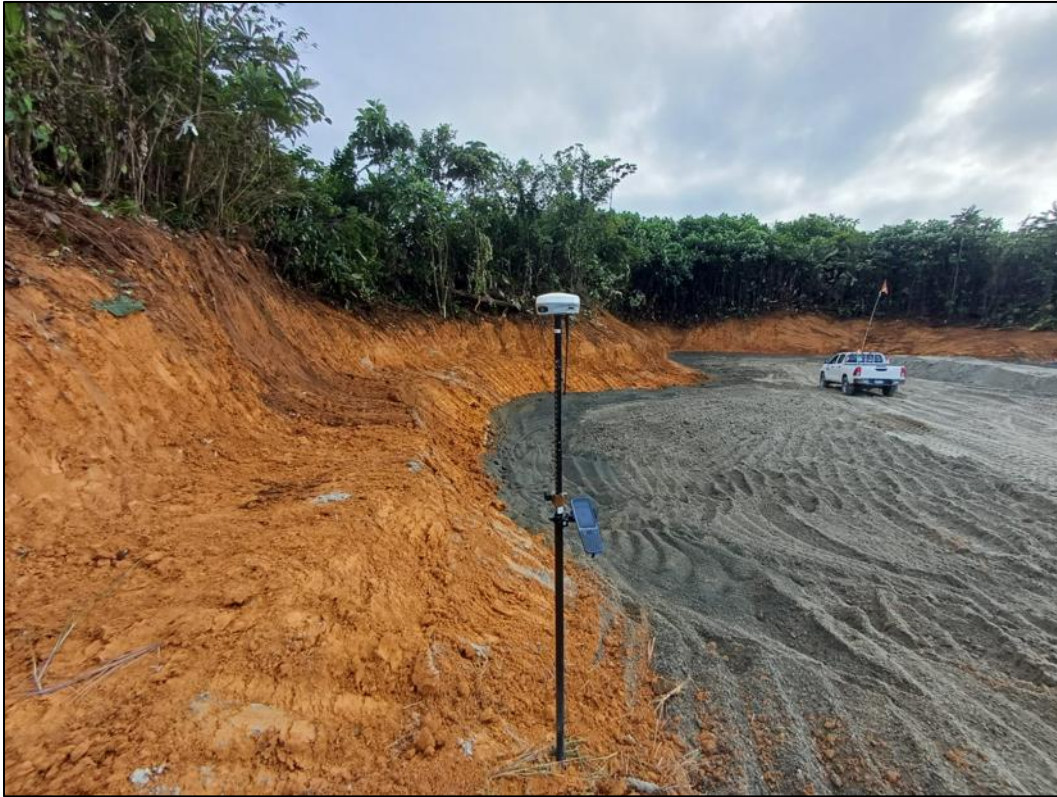
Figura 32 - Colocación de filtro y arena mecánica, Celda 14 WRP05, Muro Este
