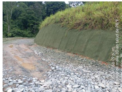
Fotografía 46. Colocación de mallas tridimensionales en el talud de acceso hacia el PB-9
