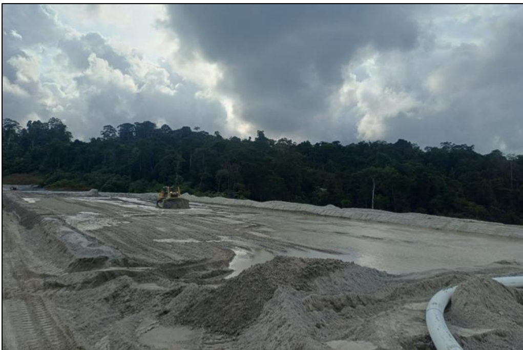
Figura 31 - Descarga hidráulica de arena cicloneada, Sector 4, Muro Norte
