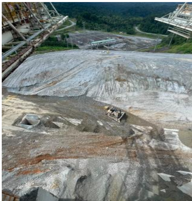
Ilustración 19 Operación con equipo para movimiento de material en pila de mineral para asegurar trabajos de mantenimiento.
