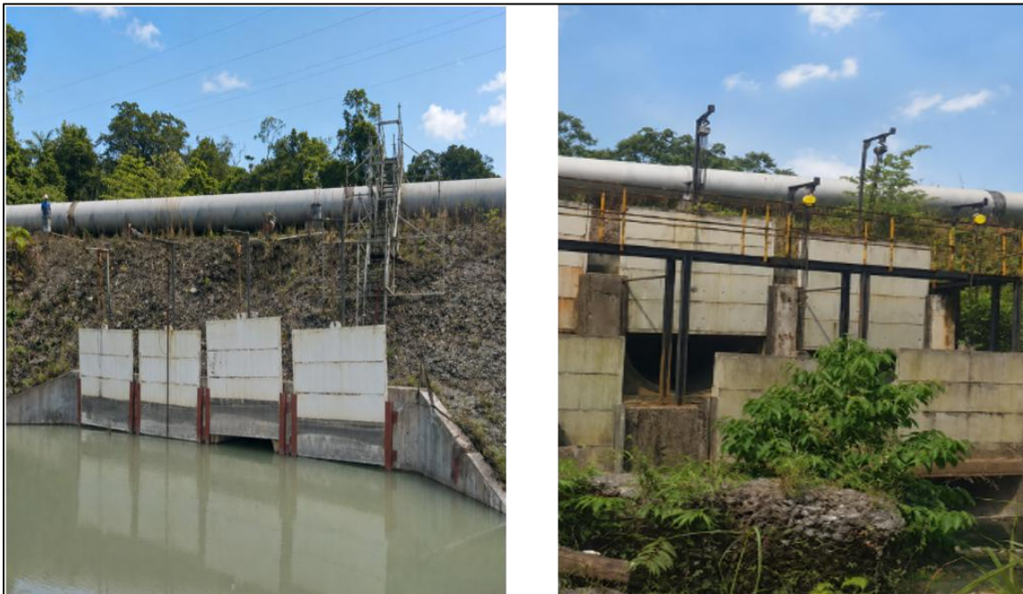
Figura 9 - Inspección de Funcionalidad de Compuertas PB05/PB09
