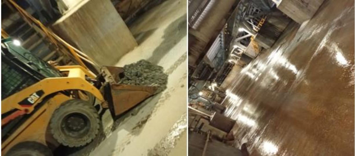
Ilustración 21 Limpieza de pisos de molinos.
