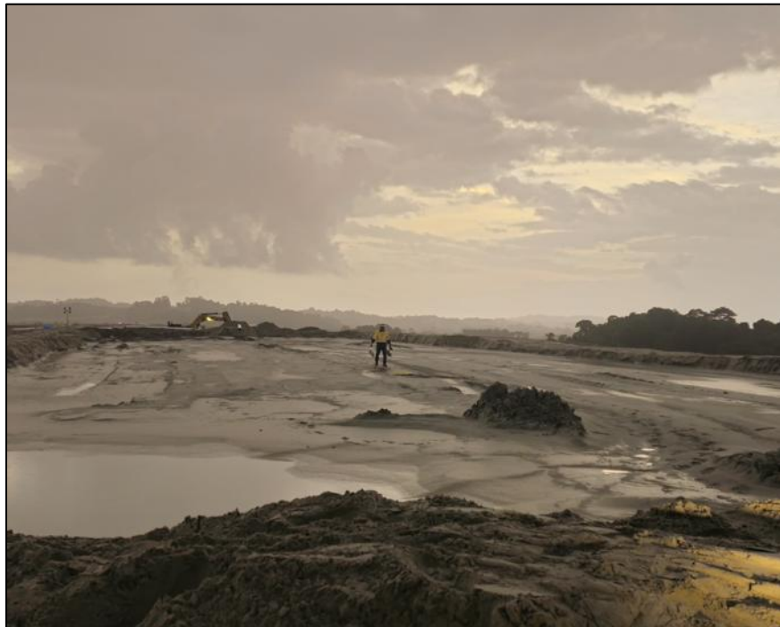
Figura 81 - Toma de muestra para monitoreo de % de finos en Granja, Muro Norte, Celda 05 Cresta
