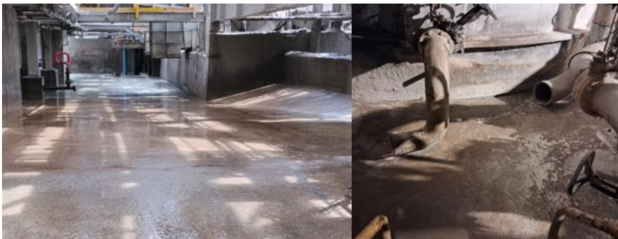
Ilustración 26 Limpieza de sumidero y válvulas.
