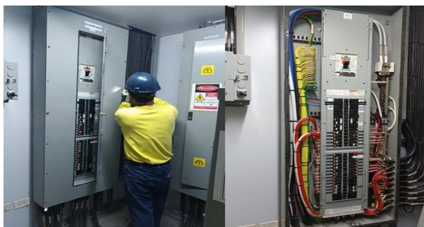
Inspección Eléctrica Edificio de Rescate Cobre
