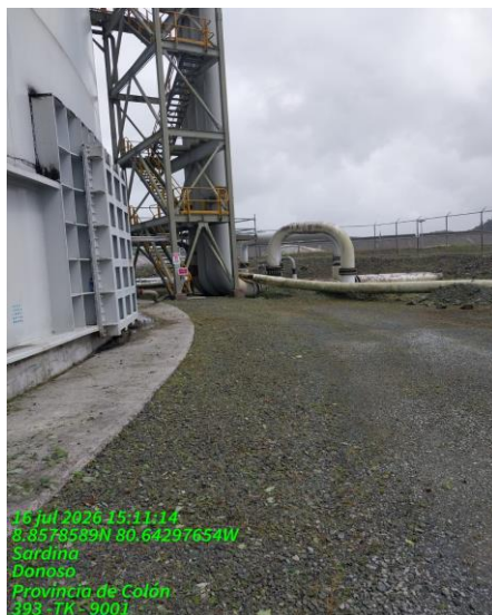
Fotografía 50. Limpieza de vegetación en perímetro de tanque 393 TK-9001
