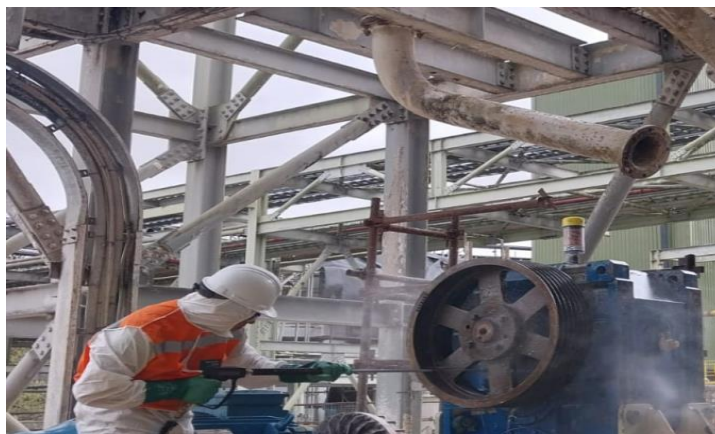
Ilustración 27 Limpieza genera de equipos para trabajos mecánicosl.
