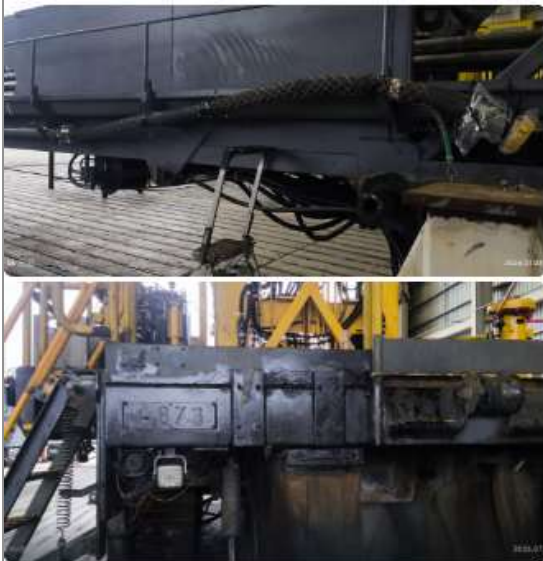
DRE-106 Reparación de superficie por corrosión uso de Rust Transformer.
