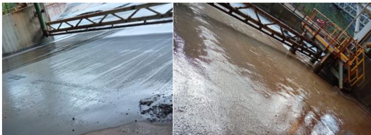
Ilustración 20 Limpieza de sedimentos (antes y después).
