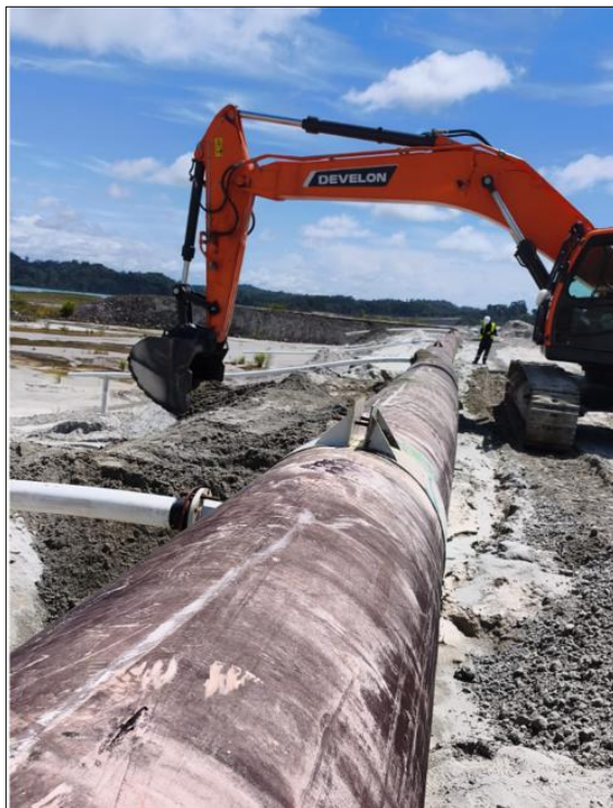
Figura 4 - Mantenimiento por Reparación de Erosión de Líneas de Descarga de Relaves
