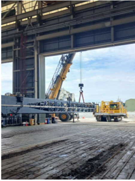
DRE-106. INSTALACION DE MASTIL.
