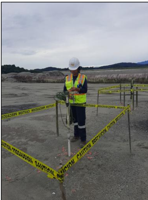
Figura 83 - Lectura de instrumentación geotécnica (Piezómetro y Casagrande)
