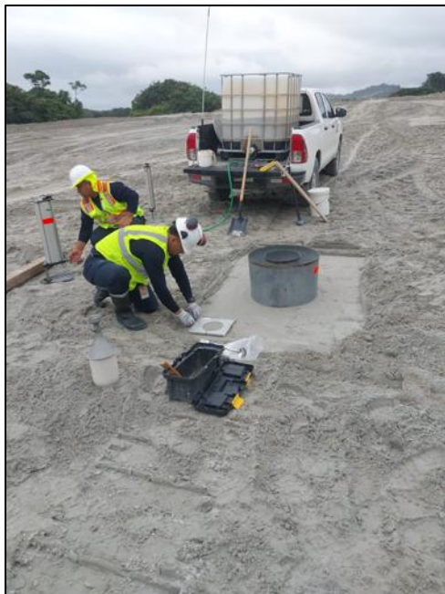
Figura 82 - Ensayo de Infiltración Celda 12/13 Muro Este
