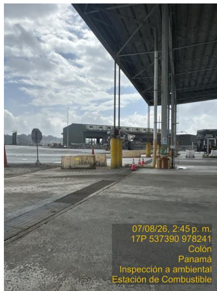
Fotografía 51. Registro en Inspección Ambiental Interna en el área de Dispensadora de Combustible MSA.
