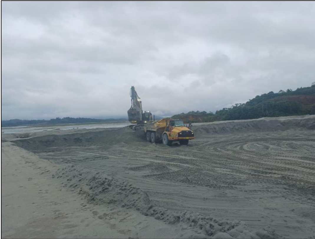
Figura 34 - Carguío de arena mecánica en Muro Este.
