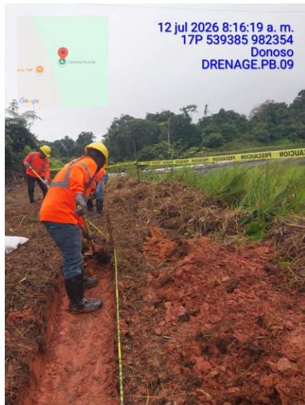
Fotografía 47. Conformación de aproximadamente 30 metros lineales de drenaje en la corona del talud de acceso hacia la estación de calidad de agua PB-9.
