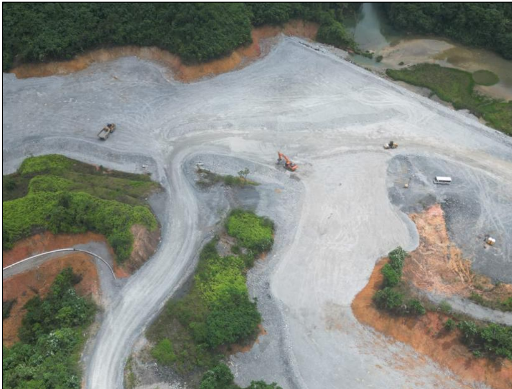
Figura 33 - Enrocado con Z7 PAG en WRP06, Muro Este
