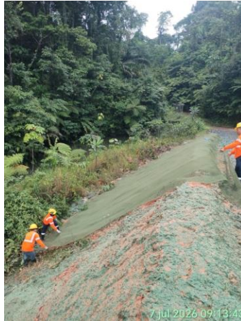
Fotografía 45. Colocación de malla tridimensional para el control de erosión en bermas
