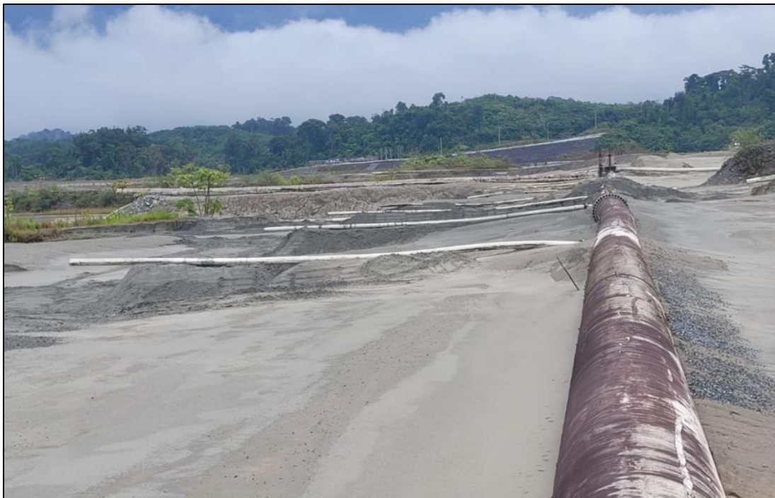
Figura 7 - Habilitación de Soportes para Spigots de Línea de Relaves R1 en el muro Norte Sector 2/3
