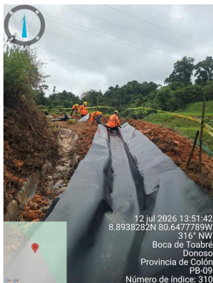
Fotografía 48. Revestimiento del drenaje con geomembrana para el control de la escorrentía superficial en el acceso al PB-9
