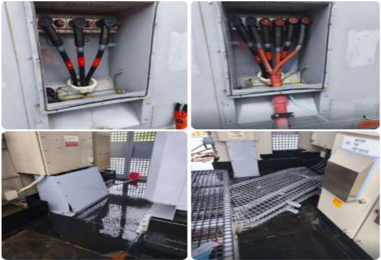
269-Sub-0005 mantenimiento exterior/interior
