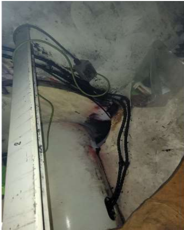
WLL003, soldadura del bastidor del calgador
