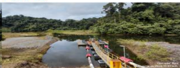
Ilustración 30 Pozas de sedimentación.
