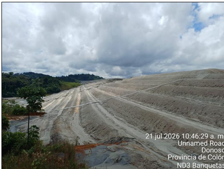
Figura 75 - Mantenimiento de Banquetas, Muro Norte Sector 3.
