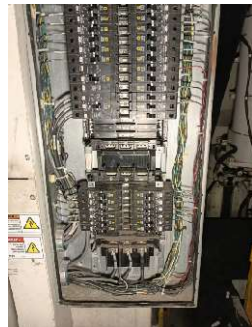
SHE-03 Verificación y aprietes de conexiones eléctricas.
