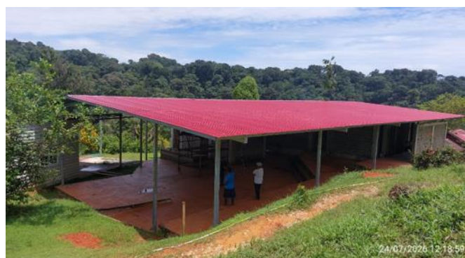
Inspección final de proyecto de Instalación de techo en Casa Local. - Nuevo Edén
