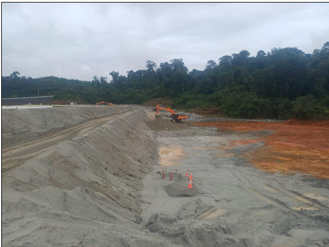
Figura 35 - Limpieza de sedimentos en Sector 4, Muro Norte.
