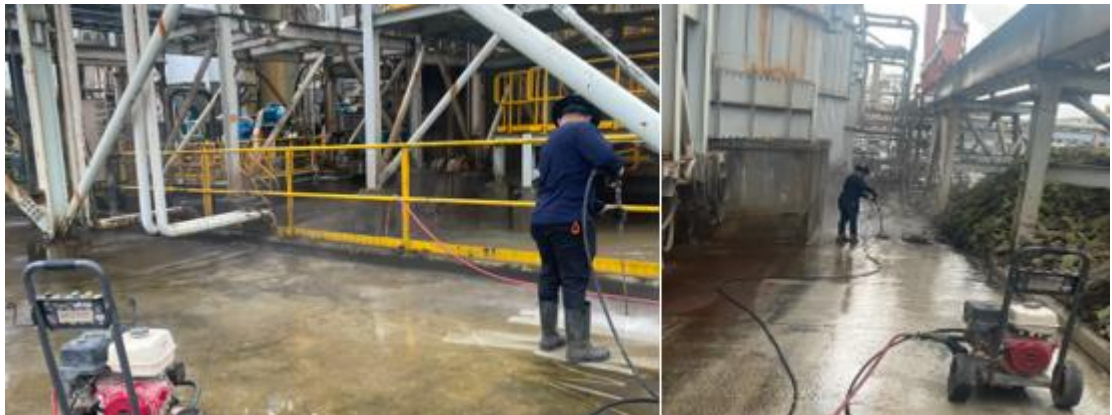
Ilustración 25 Proceso de limpieza de piso con hidrolavadora.
