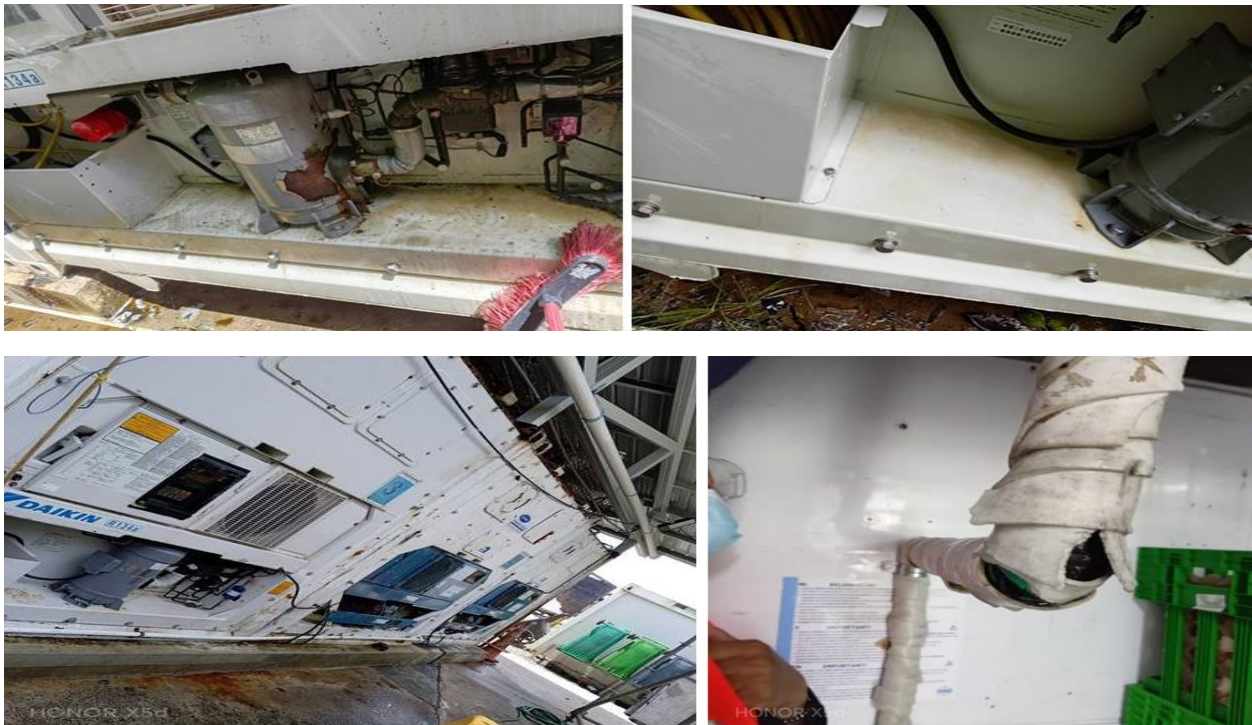
Mantenimientos de Contenedores refrigerados
