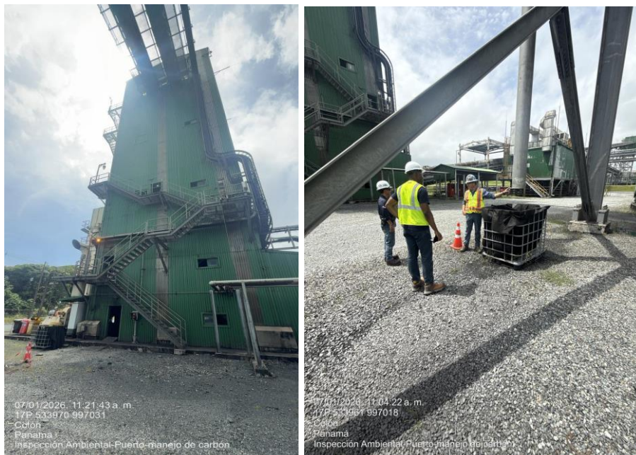
Fotografía 53. Registro en Inspección Ambiental Interna en la Galera de Carbón
