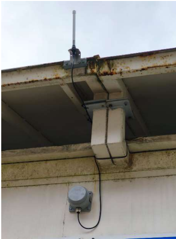
Instalación de antena LTE,comucacion
