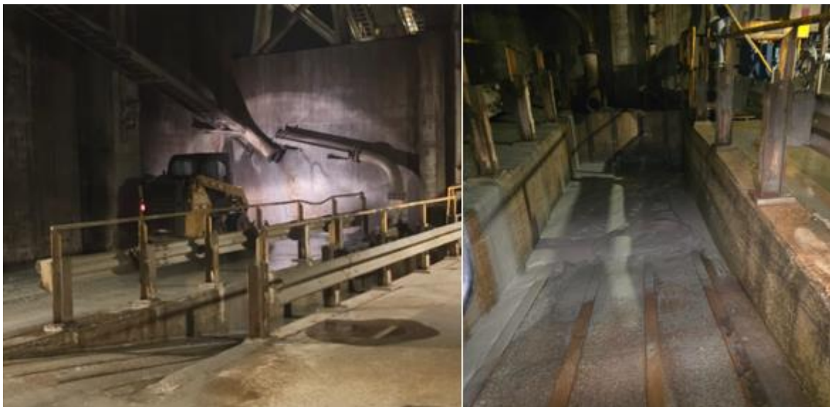
Ilustración 15 Limpieza de zona de sumidero.
