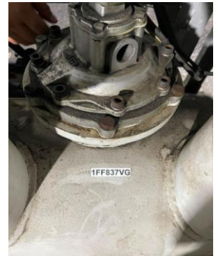
Remplazo de sellos en Válvulas del Baghouse
