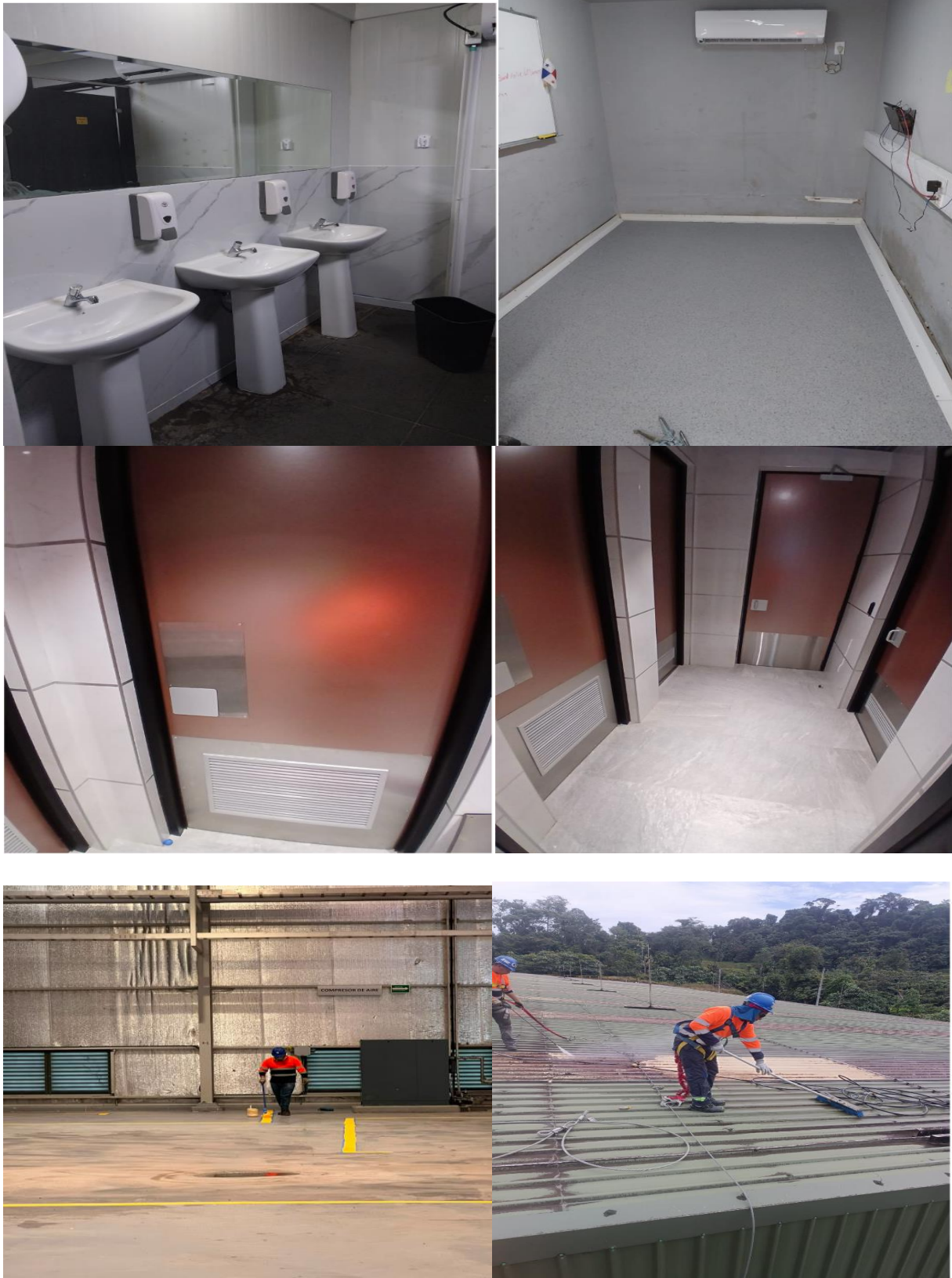
Limpieza de techos, infraestructura, pintura de piso y trafico emulsión y Lab. Plant.
