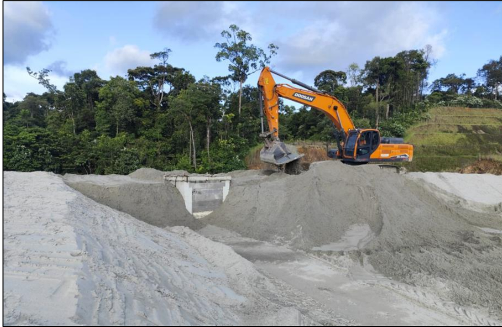
Figura 6 - Habilitación de Celdas para Descarga Hidráulica - Muro Este
