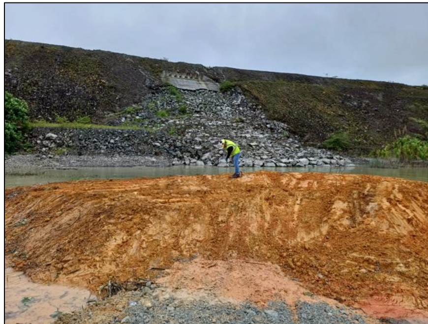
Figura 77 - Liberación de taludes en WRP6
