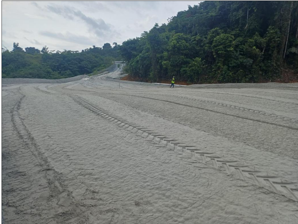
Figura 30 - Construcción de corredor de tuberías y acceso Celda 3, Muro Norte
