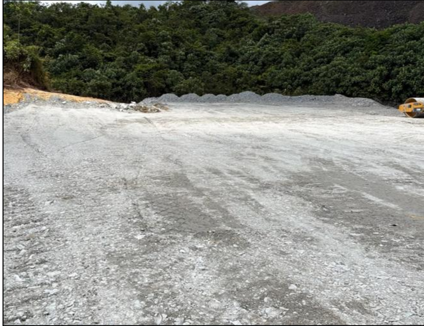
Figura 78 - Relleno de material Zona 7 en WRP6
