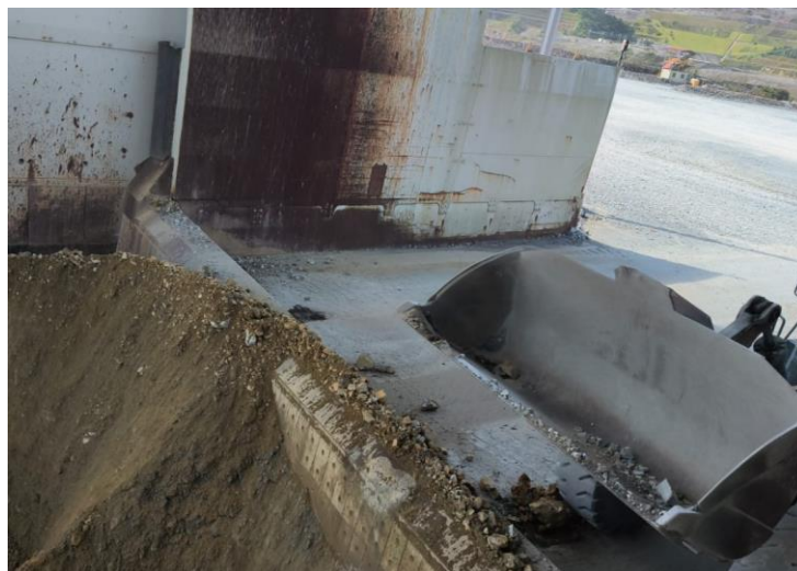
Ilustración 13 Remoción de sedimentos en el área de la trituradora (antes y después).
