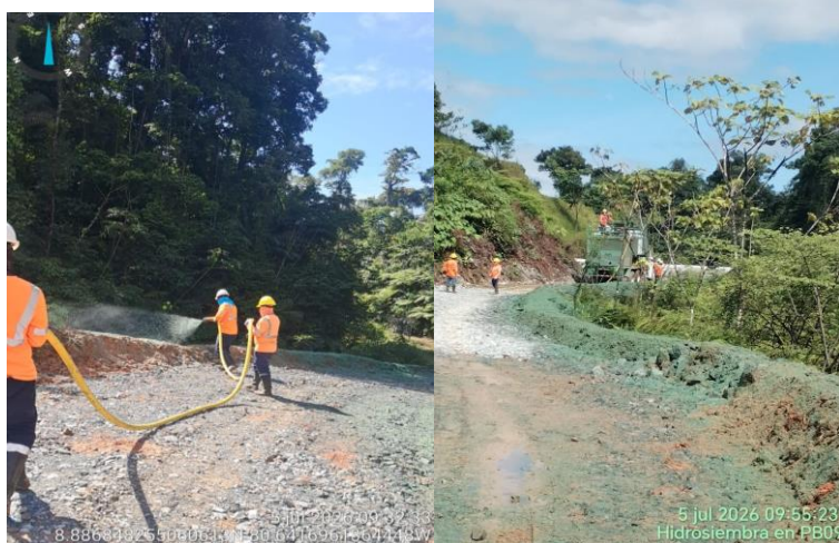
Fotografía 43 y 44. Aplicación de hidrosiembra en acceso hacia el PB-9
