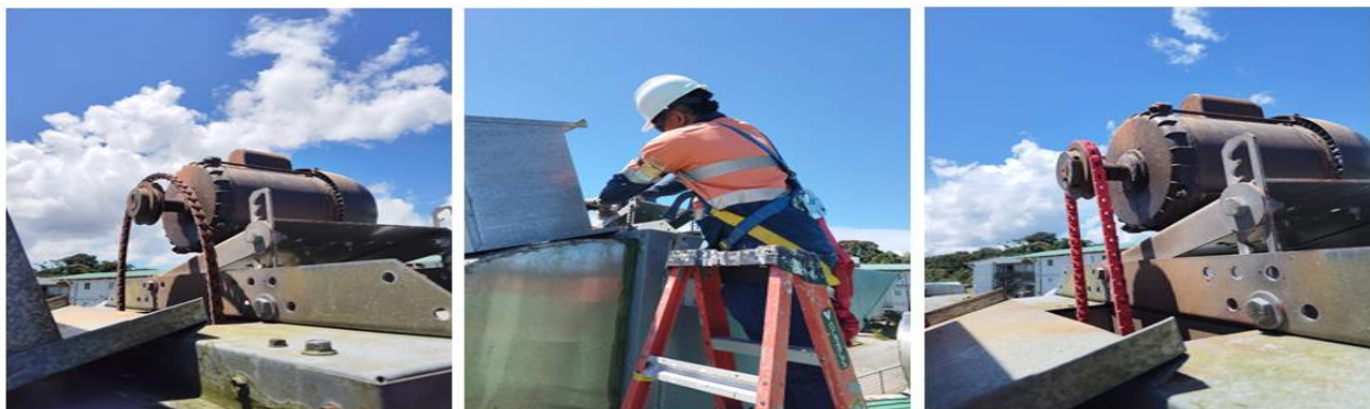
Reemplazo de Correas a Sistema de Extracción
