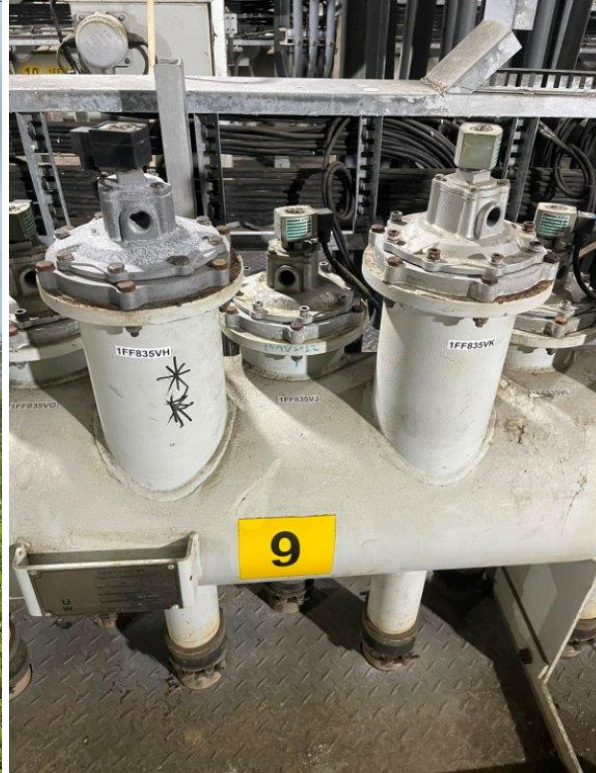
Remplazo de sellos en Válvulas del Baghouse
