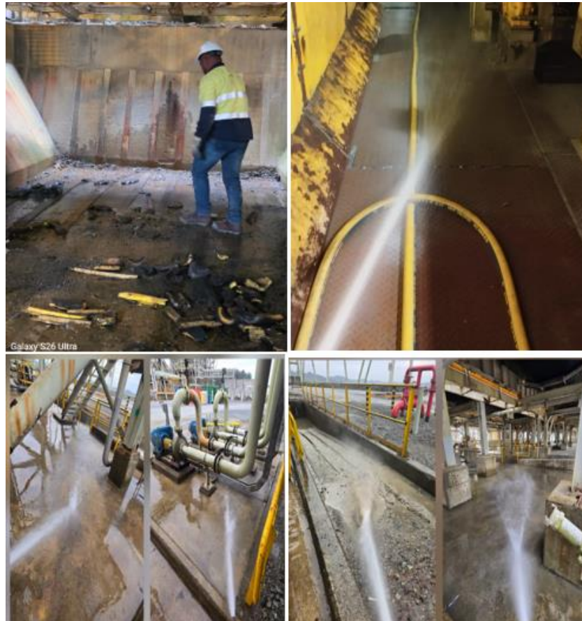
Ilustración 16 Limpieza de piso y estructuras con hidrolavadora. (antes y después).
