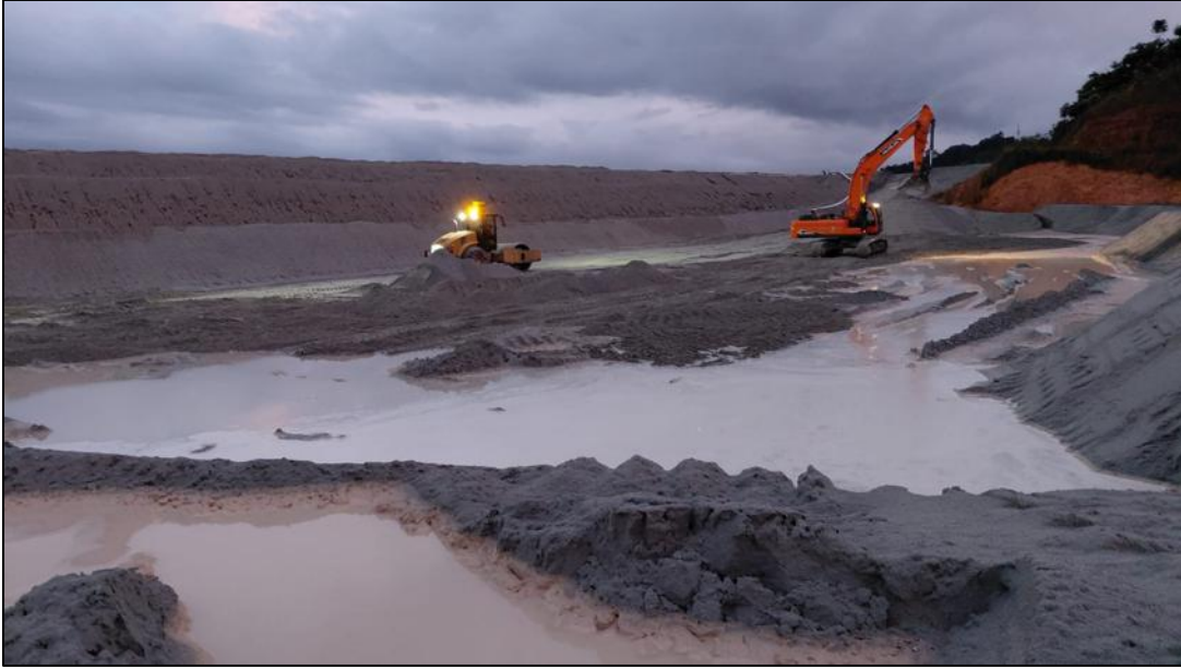
Figura 36 - Preparación de bermas para descarga hidráulica Celda 36 WRP02, Muro Este
