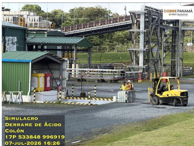
Fotografía 55. Ejecución del Simulacro en la Planta de Energía.
