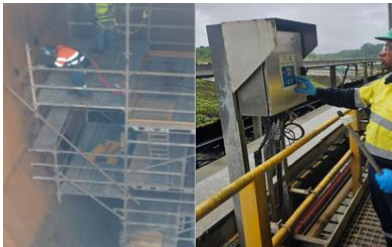
Ilustración 4 Mantenimiento de los contenedores de distribución de mineral.
