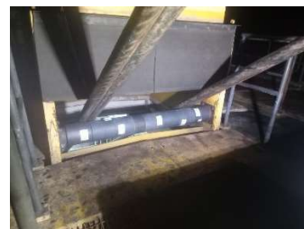
SHE-01 Cambio de rodillos de casa de maquinas.
