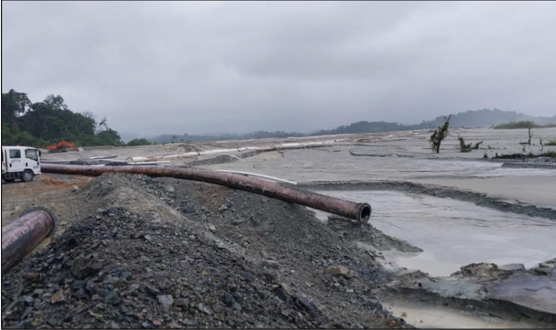
Figura 8 - Reubicación de Open End de Línea de Relaves R4 en el Muro Norte, Sector 4, para desarrollo de playa
