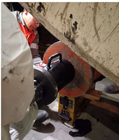
WLL001 Desmontaje del cilindro de volteo por cambio de bearing
