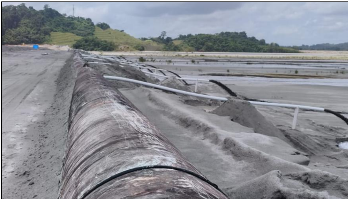
Figura 5 - Habilitación de Línea de Relaves R2 en el Muro Norte, Sector 1
