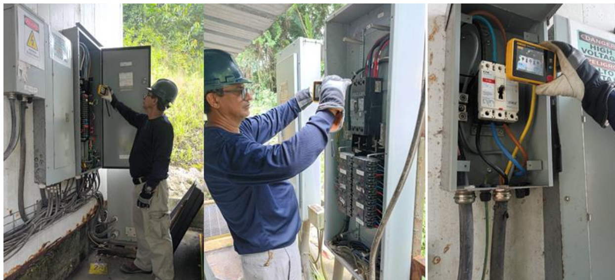
Termografía Bodega de Cobre
